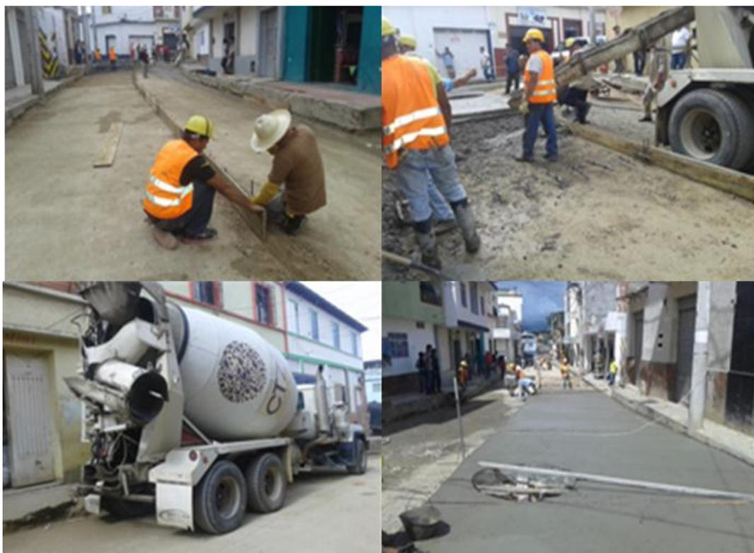
**Figura 46. Ejecución de la fundición de losas.**
