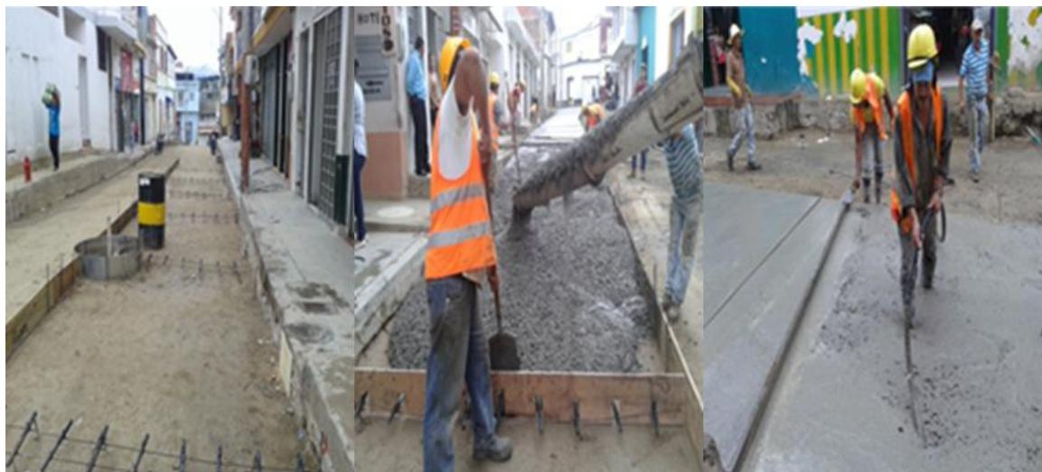
**Figura 47. Instalación del acero de refuerzo y vibrado del concreto.**
