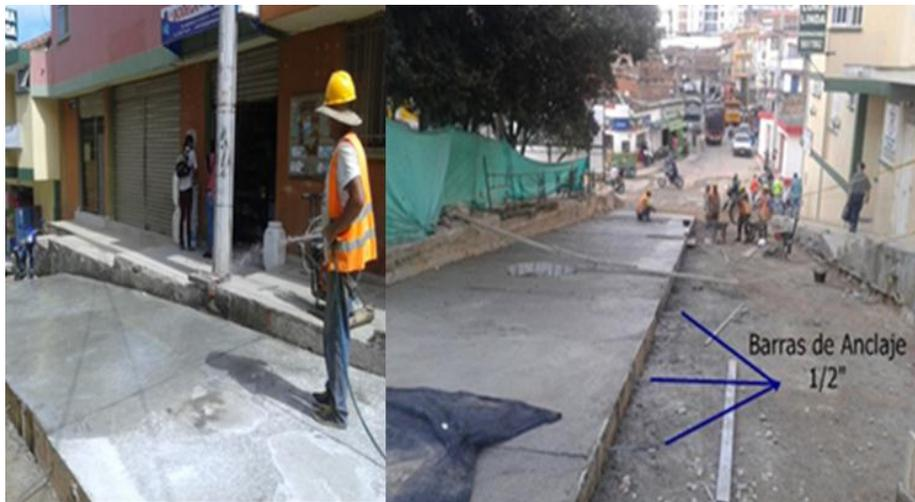
**Figura 54. Curado del concreto y colocación de barras de anclaje.**
