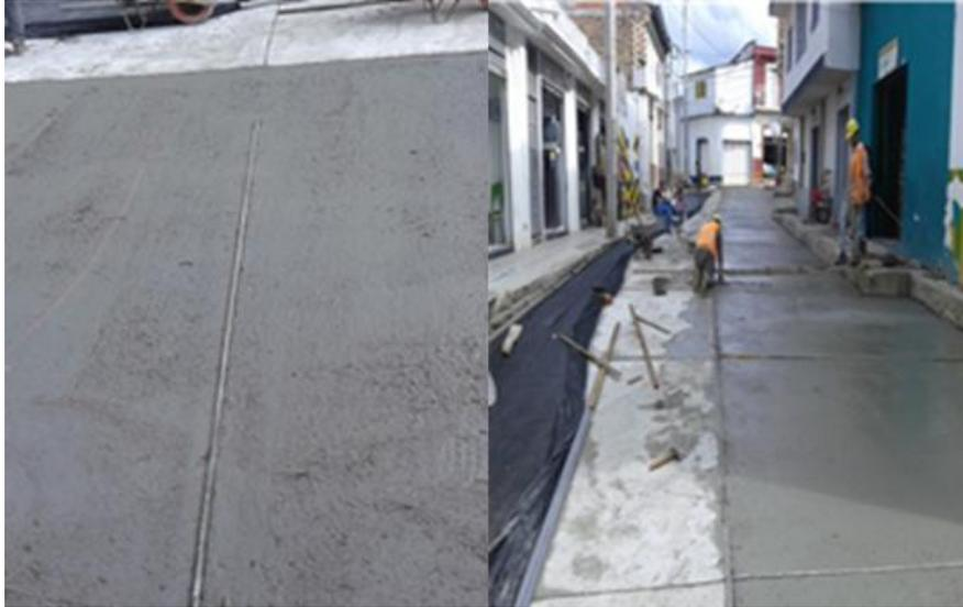
**Figura 53. Colocación de dilataciones.**
