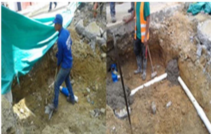
**Figura 33. Conexión de tubería con válvula de 3".**
