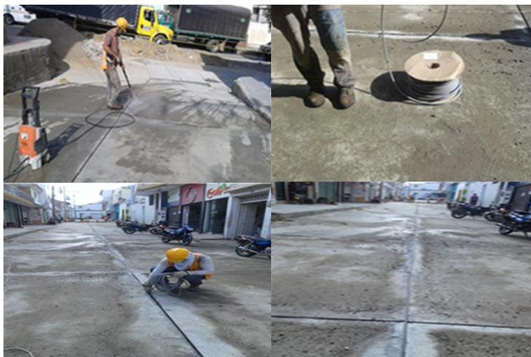
**Figura 55. Instalación del Cordón de Respaldo.**
