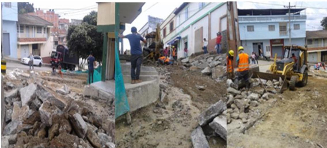
**Figura 22. Demolición de pavimento existente.**
