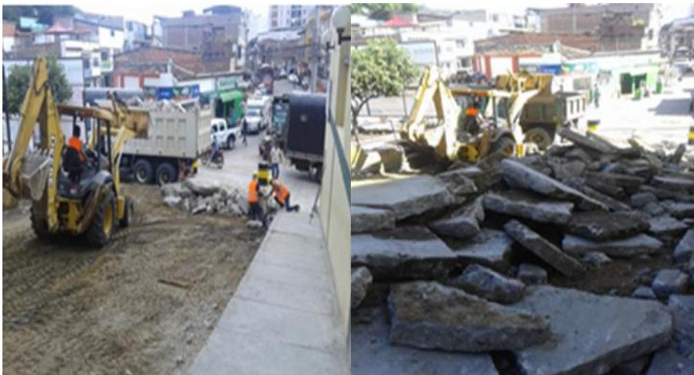
**Figura 9. Recolección y carga de fragmentos de concreto.**
