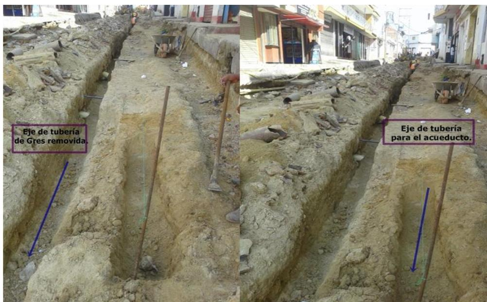
**Figura 31. Excavación para tubería de agua potable y remoción de tubería de gres.**
