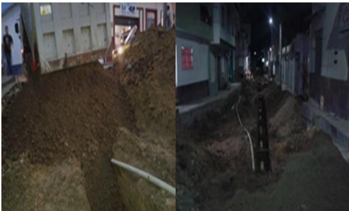
**Figura 57. Suministro de receba para relleno de tuberías.**
