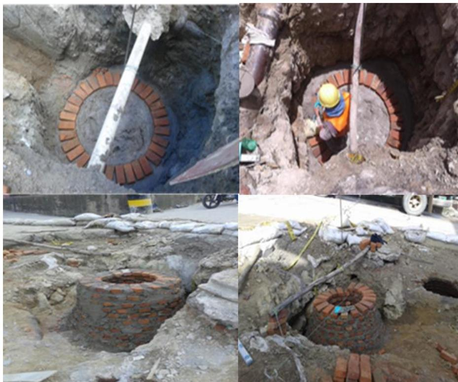
**Figura 16. Construcción y avances de los pozos.**
