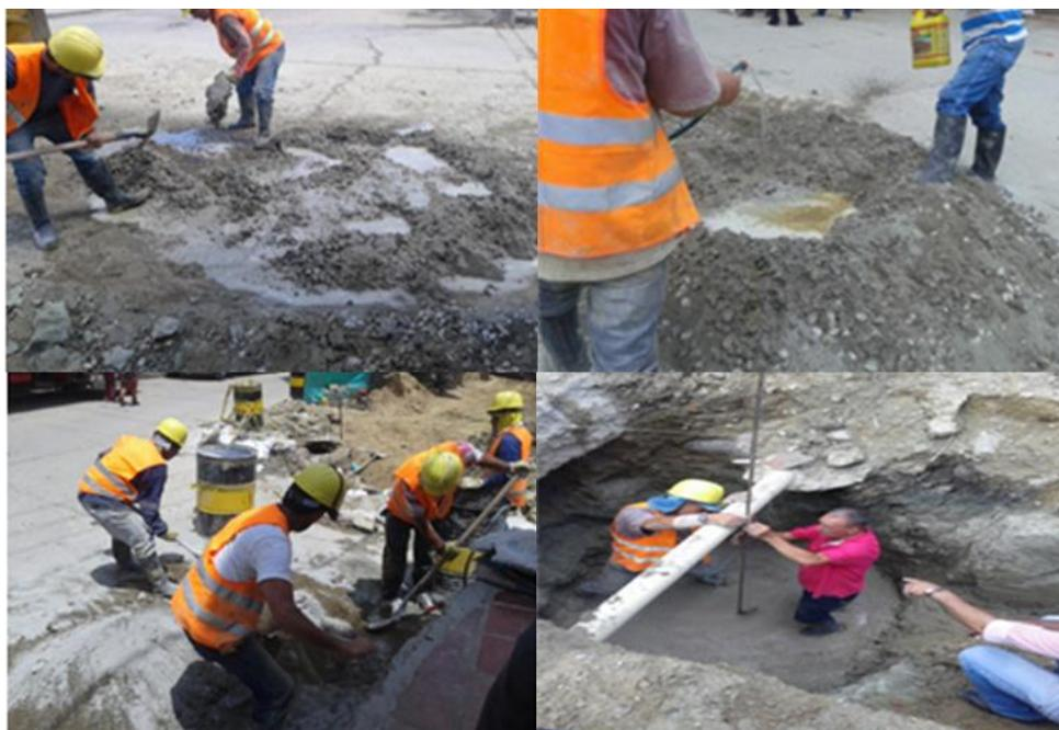
**Figura 14. Elaboración del concreto para el mejoramiento del suelo.**
