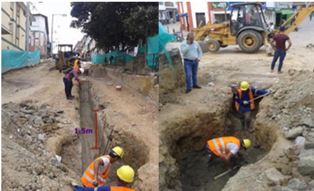
**Figura 17. Trabajos de excavación para el alcantarillado pluvial.**
