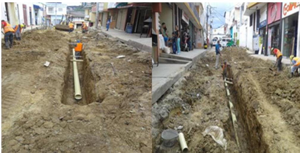
**Figura 24. Instalación de tubería de 8''.**
