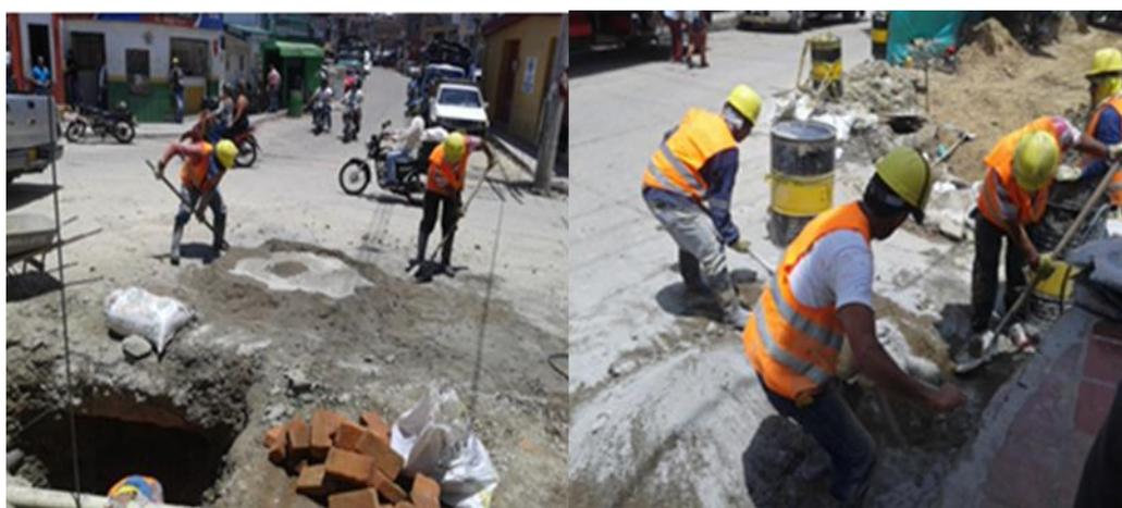
**Figura 15. Preparación de mortero de pega.**
