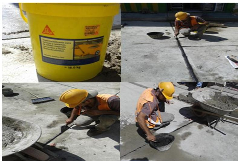
**Figura 56. Sellado de Juntas con Emulsión Asfáltica.**
