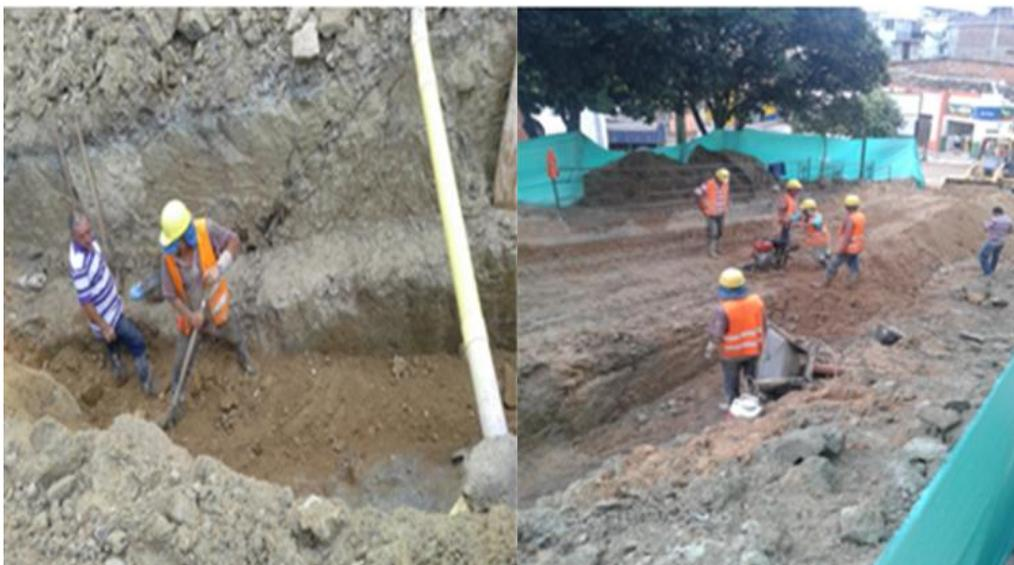
**Figura 13. Relleno y compactación del material de receba.**
