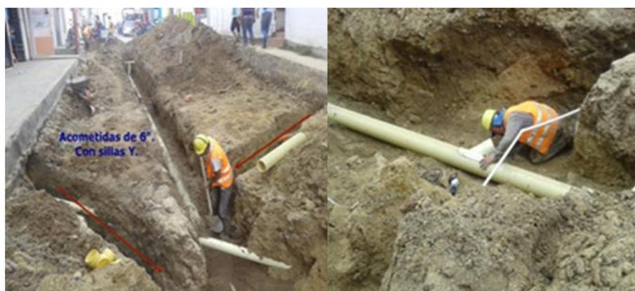
**Figura 25. Excavación e instalación de acometidas de 6'' incluidas Silla Y.**
