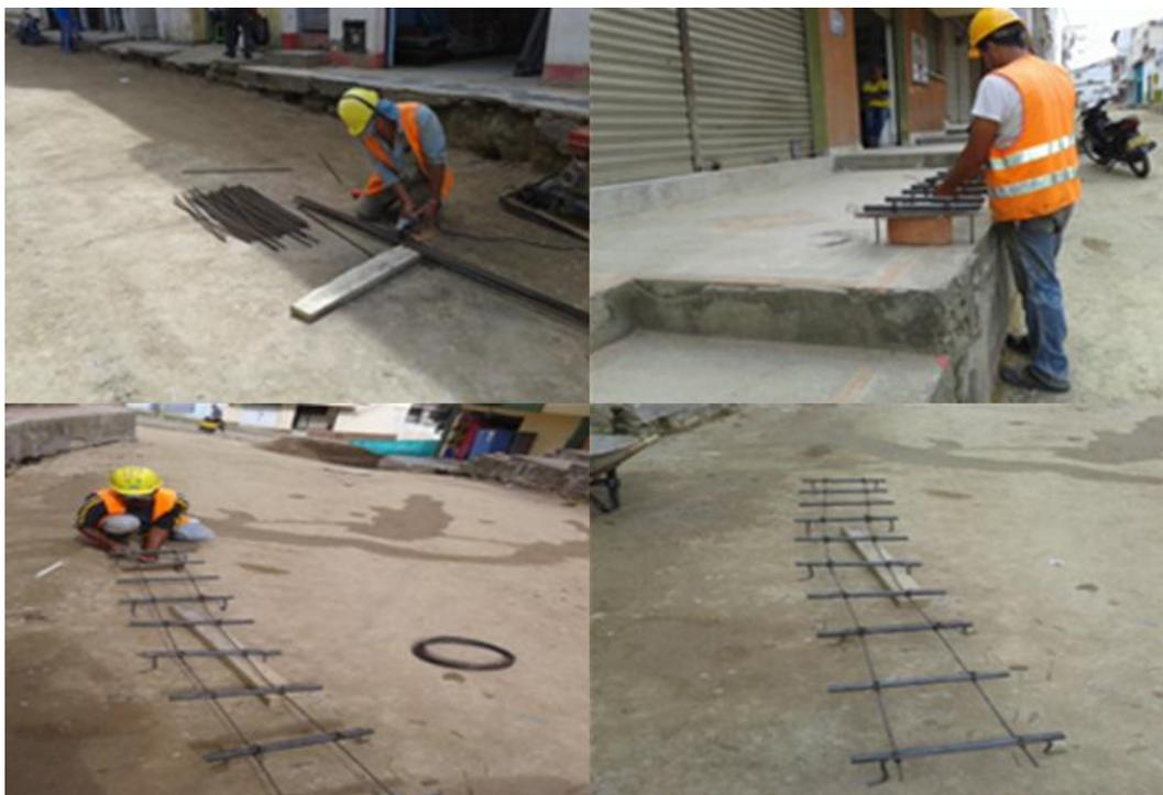
**Figura 45. Armado y figurado de soporte para las canastillas y dovelas.**
