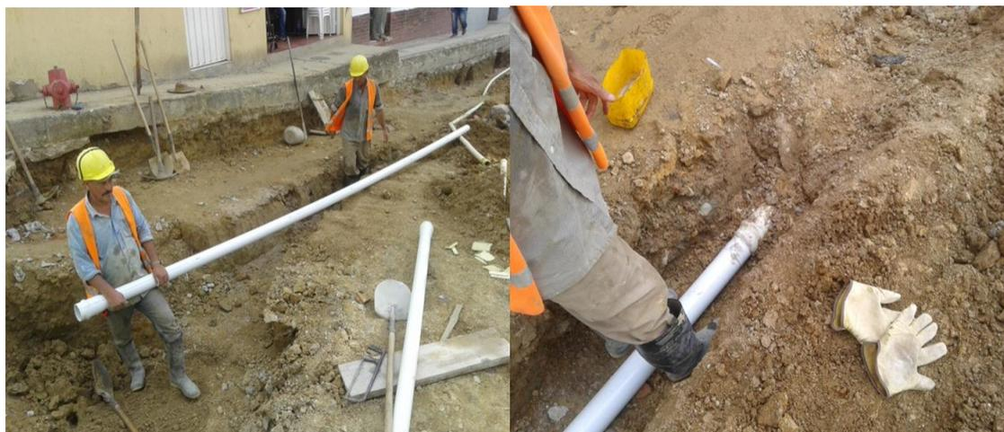
**Figura 32. Instalación de tubería 3''.**
