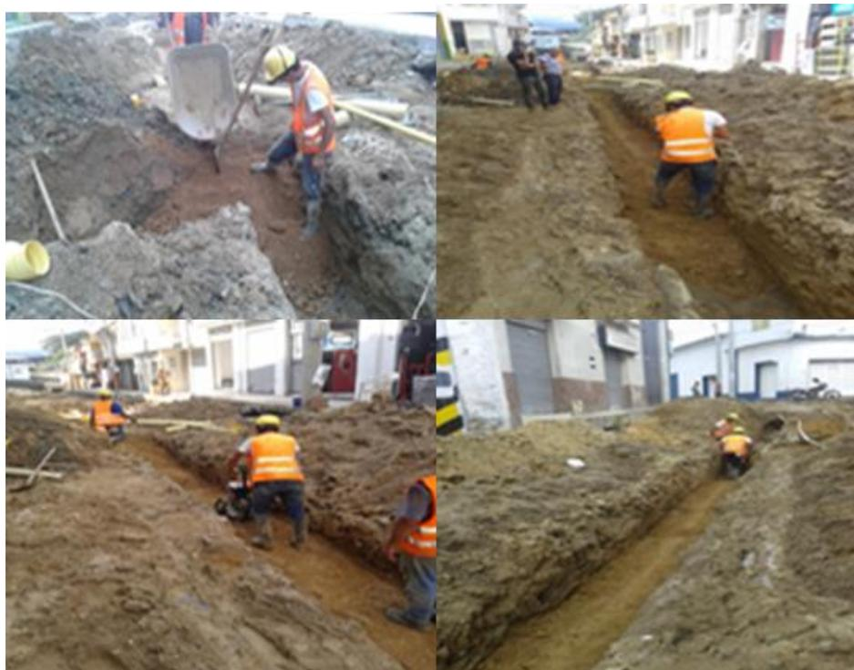
**Figura 29. Trabajos de relleno y compactación.**
