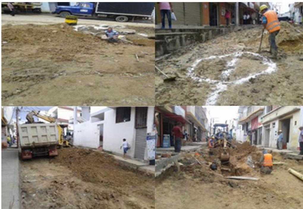
**Figura 23. Excavación para tubería de alcantarillado sanitario.**
