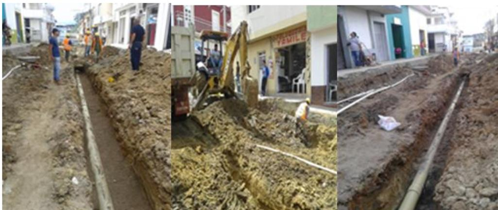
**Figura 28. Excavación e instalación de tubería.**
