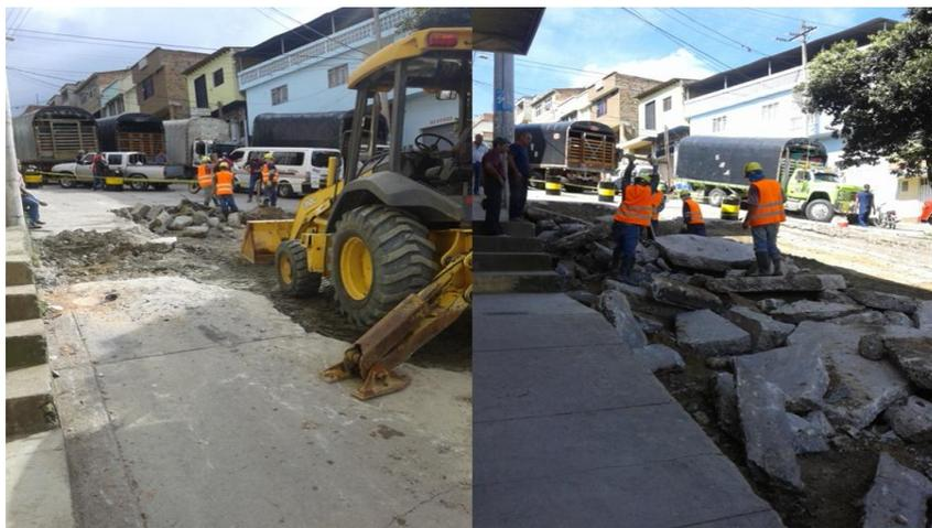
**Figura 8. Demolición y fracturación de losas.**
