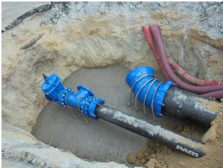
*Figura 8.* Acometidas domiciliarias. Grupocobra.com, 2021. Obtenido en: <https://www.grupocobra.com/proyecto/ejecucion-renovacion-acometidas-agua-vallecas/>
