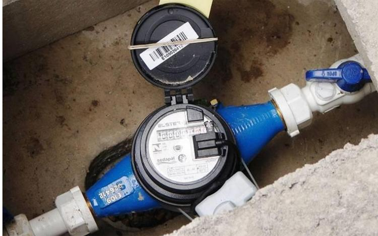
*Figura 9.* Micromedidor de agua potable. Agua.org.mx, 2021. Obtenido en: <https://agua.org.mx/frio-en-nogales-congela-el-agua-de-las-tuberias-sdp/>
