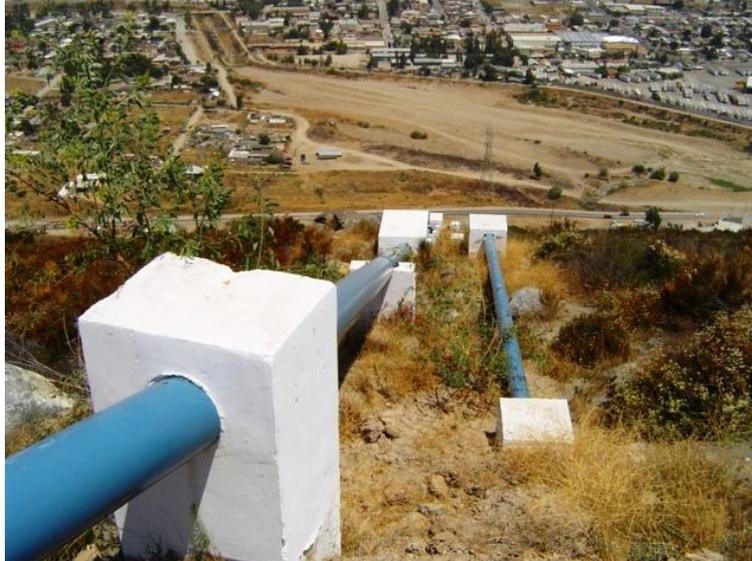
*Figura 6.* Línea de conducción del agua potable. Semanariopuntoyaparte.com, 2021. Obtenido en: <http://semanariopuntoyaparte.com/suministro-parcial-de-agua-potable-en-nueva-colonia-hindu/>
