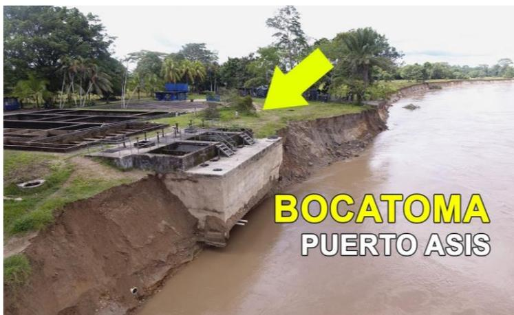
*Figura 18.* Movimientos en masa en la bocatoma del municipio de Puerto Asis, Putumayo. Diarioutopia, 2021. Obtenido en: <http://www.diarioutopia.com/los-antiguos-bocatoma-destruida-por-la-creciente-del-rio-los-antiguos/>.
