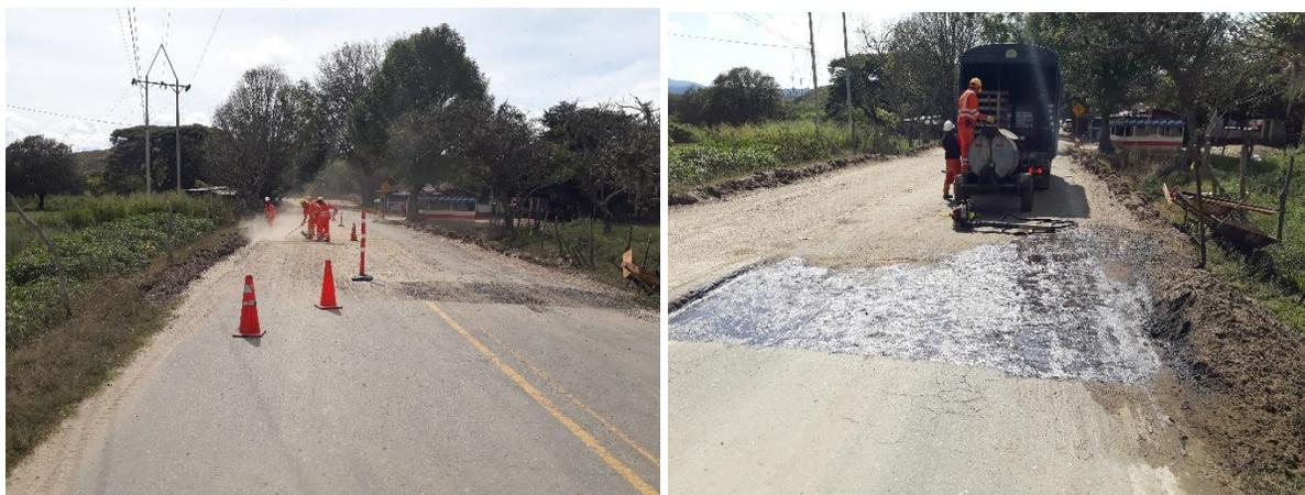
Figura 196. Aplicación de ligante o Riego de Imprimación de la calzada PR 13+700 Ruta 7008
