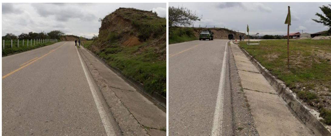
Figura 136. Cuneta existente PR 14+0290 lado Derecho Ruta 7008.
