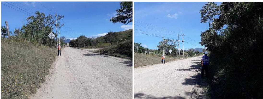
Figura 185. Nivelación de ejes en calzada escarificada PR 13+860 Ruta 7008
