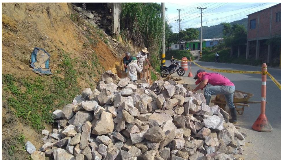
Figura 25. Piedra utilizada para la construcción de muro de contención en gaviones PR 52+597 Ruta 7008.
