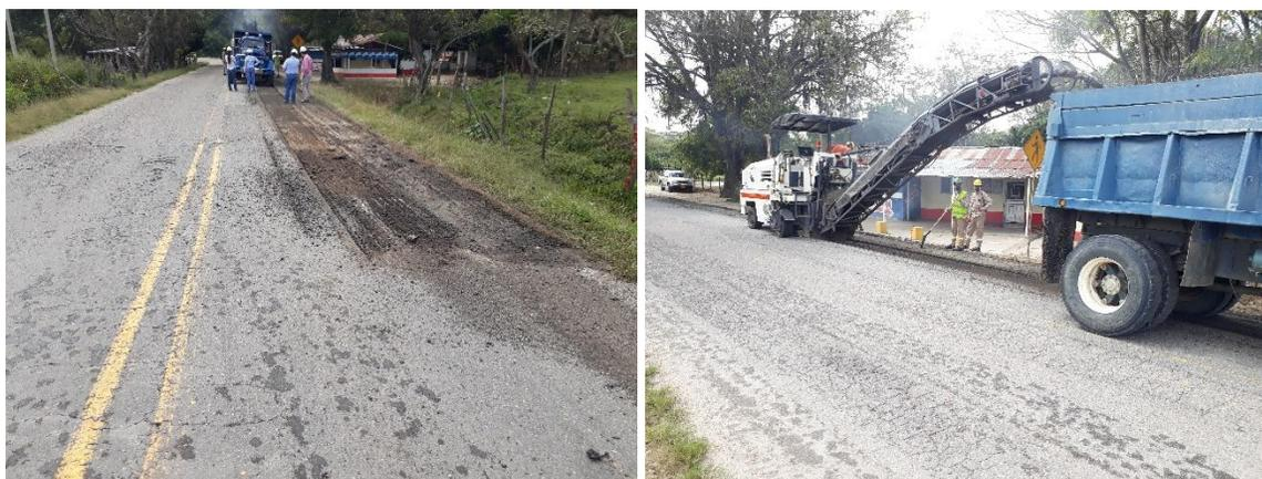
Figura 173. Fresado de pavimento flexible existente carril derecho en el PR 13+700 Ruta 7008
