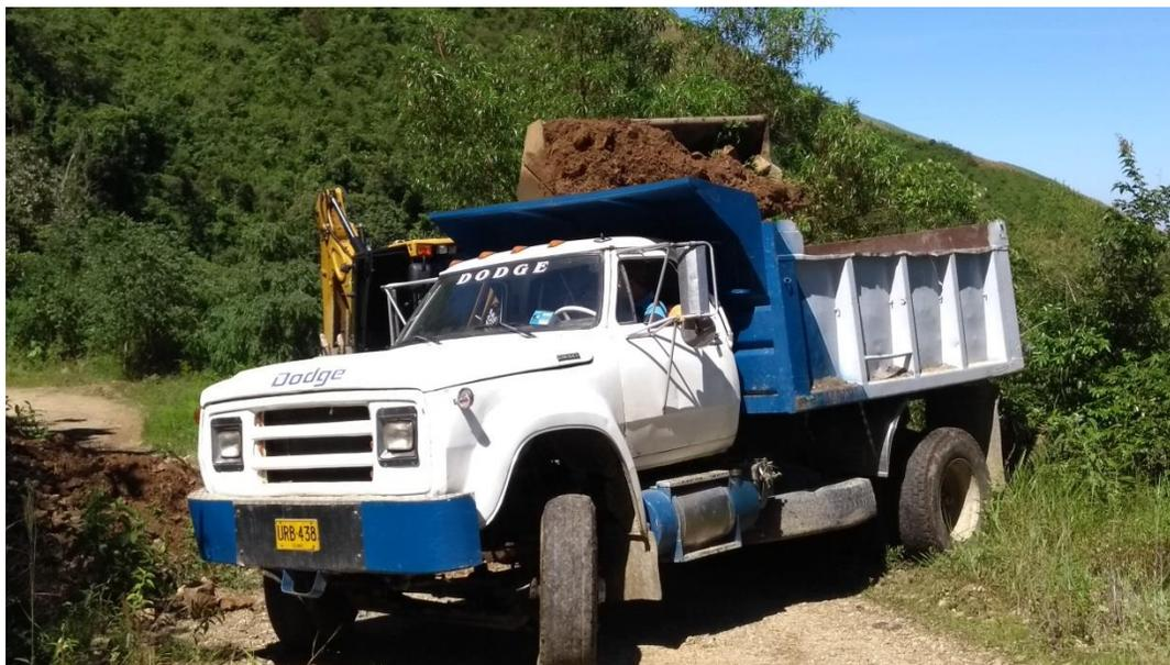
Figura 48. Transporte de materiales provenientes de derrumbes en el PR 19+0980 Ocaña- Límites-Morrinson
