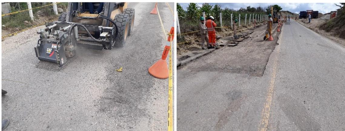
Figura 178. Bacheo de carpeta de rodadura con minicargador PR 14+330 Ruta 7008
