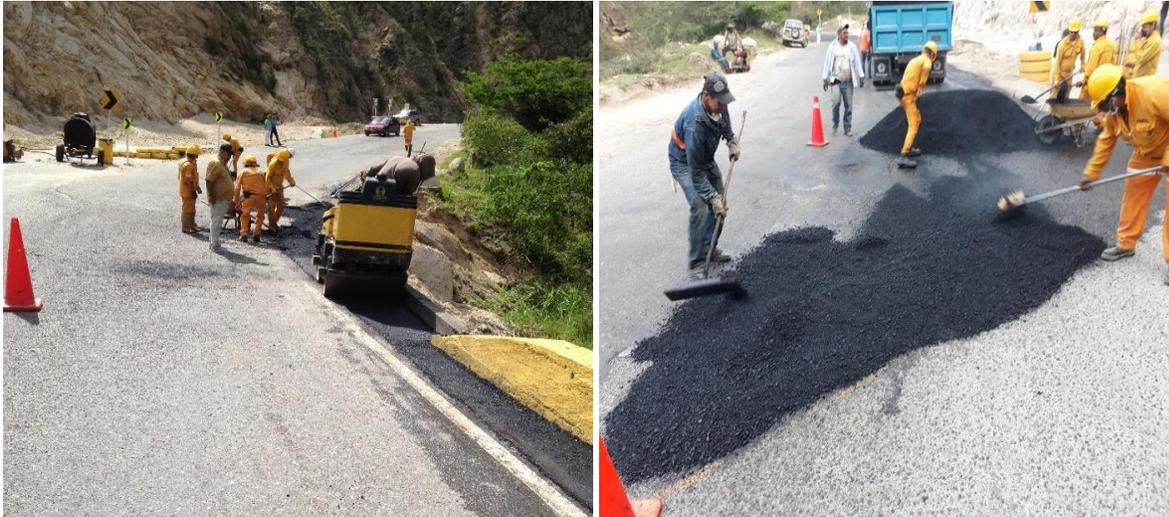
Figura 82. Vibro-compactación y extensión de mezcla asfáltica PR 11+0600 vía Ocaña-Alto del Pozo
