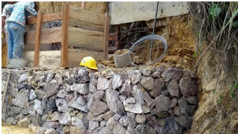
Figura 30. Amarre con alambre de acero entrelazo en gaviones rellenos de piedra
