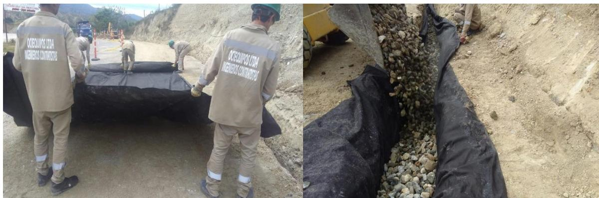
Figura 193. Instalación de Geotextil y filtros Lado Izquierdo en el PR 14+440
