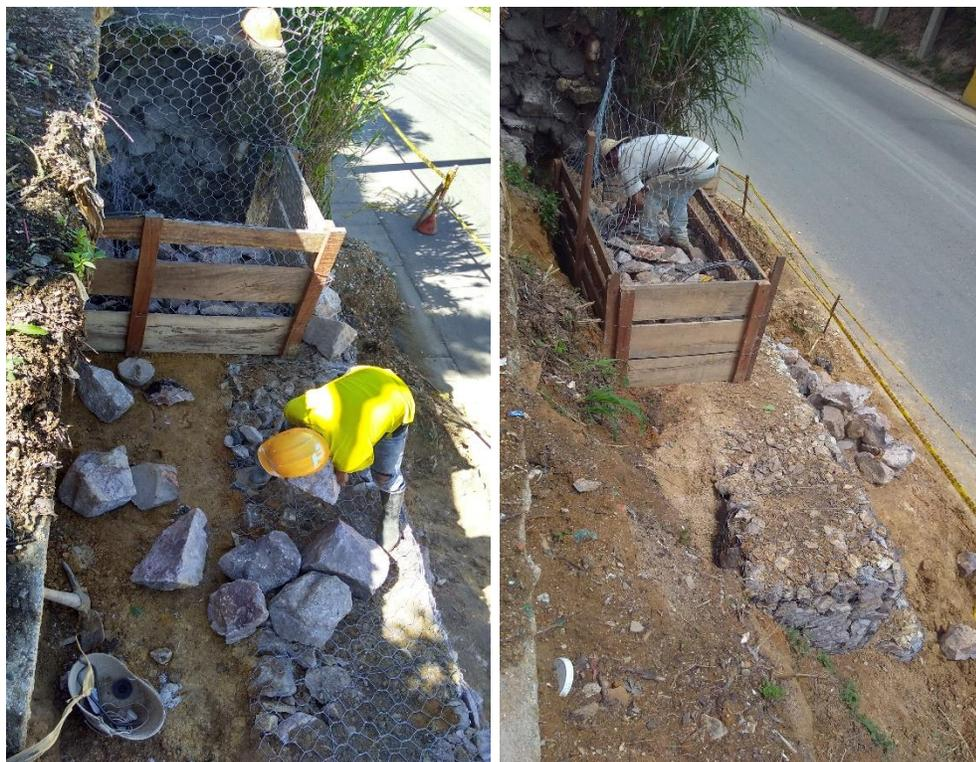
Figura 29. Formaleteado en casetones de madera con dimensiones 2,0m x 1,0m
