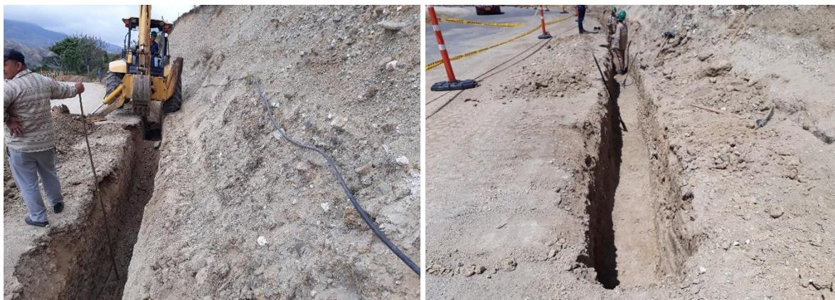
Figura 189. Excavación mecánica para instalación de filtros Lazo Izquierdo PR 14+440
