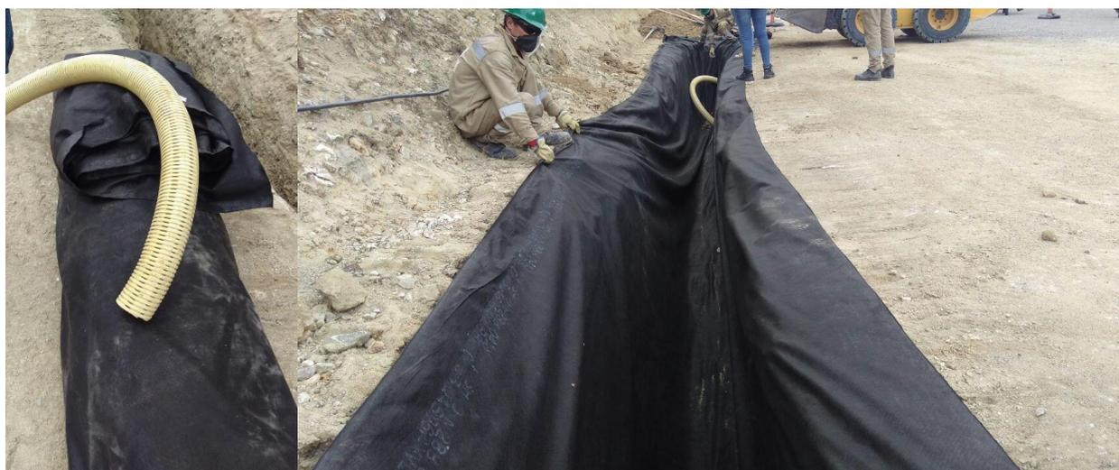
Figura 192. Instalación de Geotextil y filtros Lado Izquierdo en el PR 14+440
