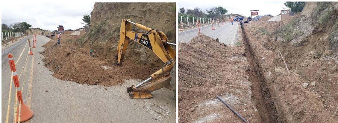
Figura 191. Excavación mecánica para instalación de filtros Lado Derecho PR 14+340
