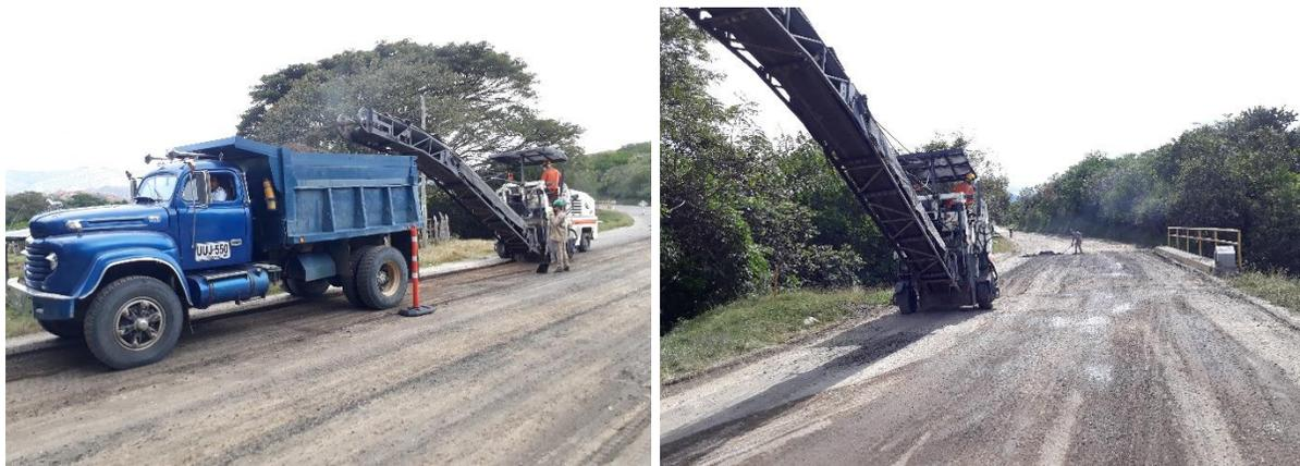
Figura 175. Fresado carpeta de rodadura calzada completa en el PR 13+820 Ruta 7008
