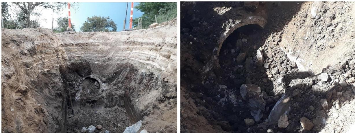
Figura 172. Excavaciones y retiro de alcantarilla existente en el PR 13+980
