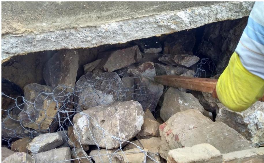
Figura 27. Refuerzo mecánico de alambre de amarre para resistencia de la malla en el gavión.
