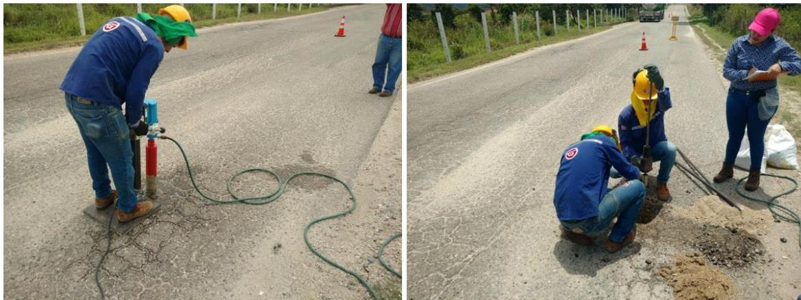
Figura 188. Extracción de Núcleos pavimento existente carril derecho en el PR 14+250 Ruta 7008
