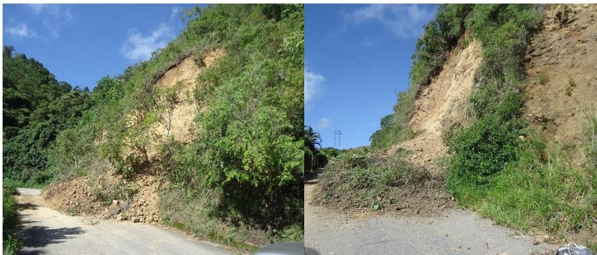
Figura 41. Inspección de Derrumbes vía Santuario Agua de la Virgen, Ocaña N.S.
