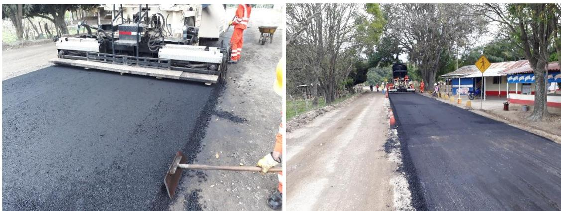
Figura 201. Extensión de Mezcla Asfáltica carril derecho PR 13+740- PR 13+800 Ruta 7008
