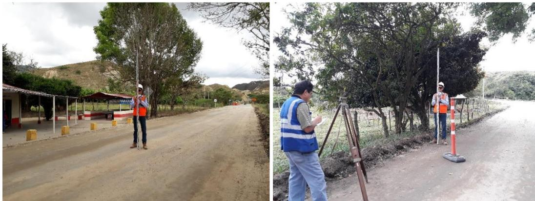
Figura 183. Nivelación de ejes en calzada escarificada PR 13+730 Ruta 7008
