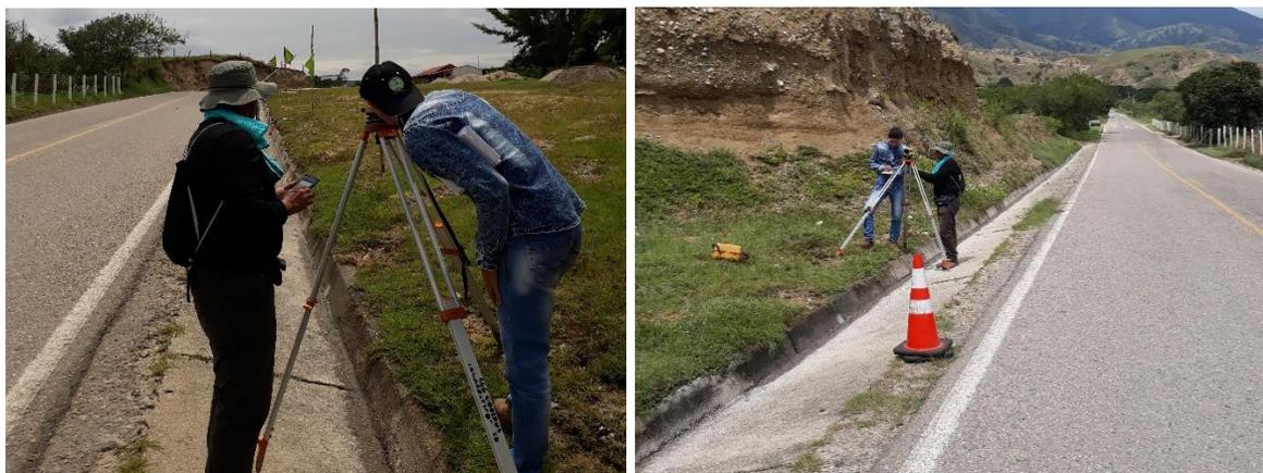
Figura 162. Nivelación de secciones existentes con nivel de precisión PR 14+380 Ruta 7008
