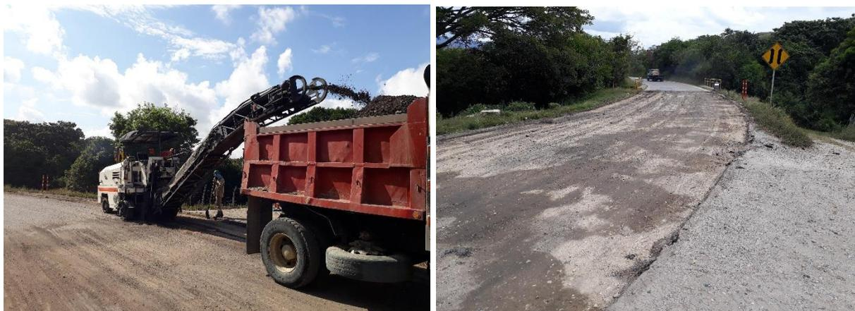
Figura 176. Fresado carpeta de rodadura calzada completa en el PR 13+830 Ruta 7008
