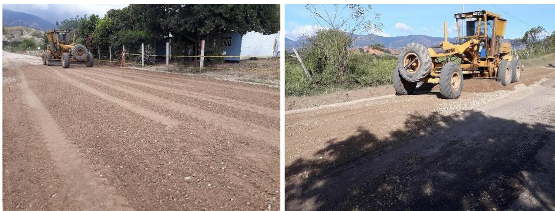
Figura 180. Extensión y conformación de calzada con afirmado para base granular en el PR 14+230
