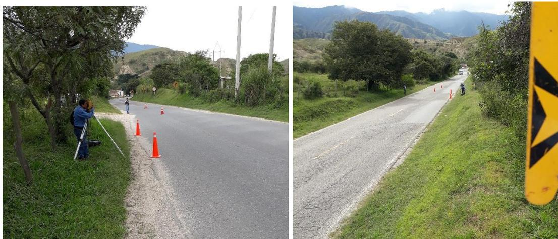
Figura 157. Levantamiento topográfico con estación total PR 14+0000 Ruta 7008
