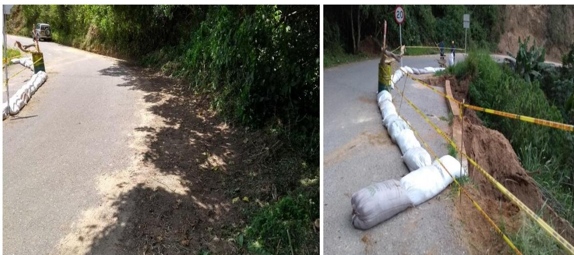
Figura 57. Remoción de material vegetal y colocación de Sacos de Tierra.
