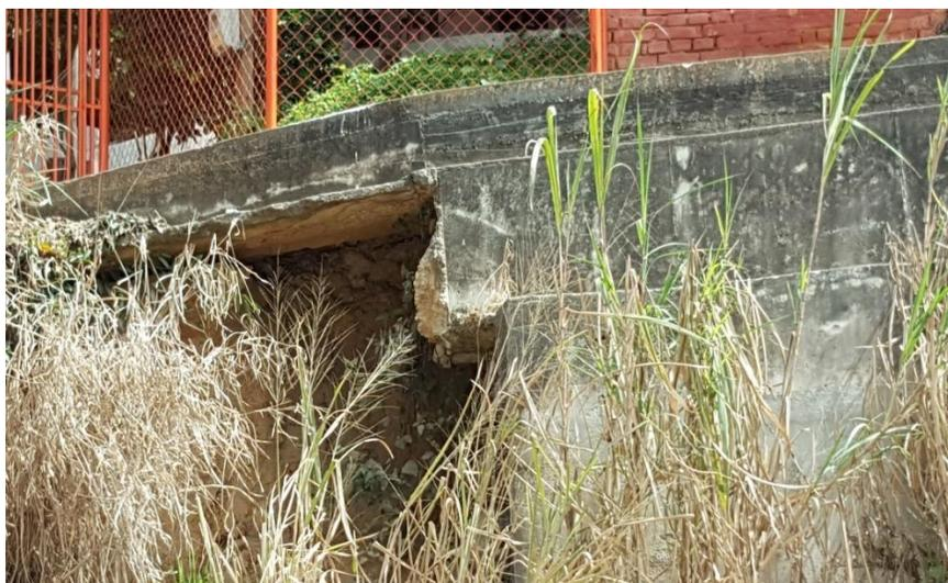
Figura 19. Colapso del Muro en Gaviones existente PR 52+597 Ruta 7008
