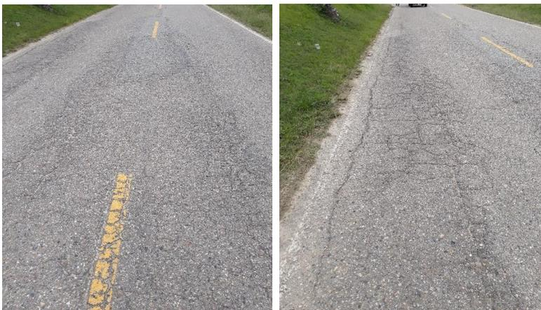
Figura 149. Piel de cocodrilo y Fisuras Longitudinales PR 14+120 Ruta 7008
