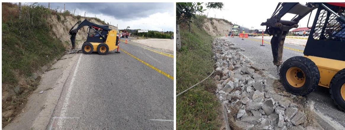
Figura 168. Demolición de cunetas de concreto con Minicargador PR 14+400 Lado Izquierdo
