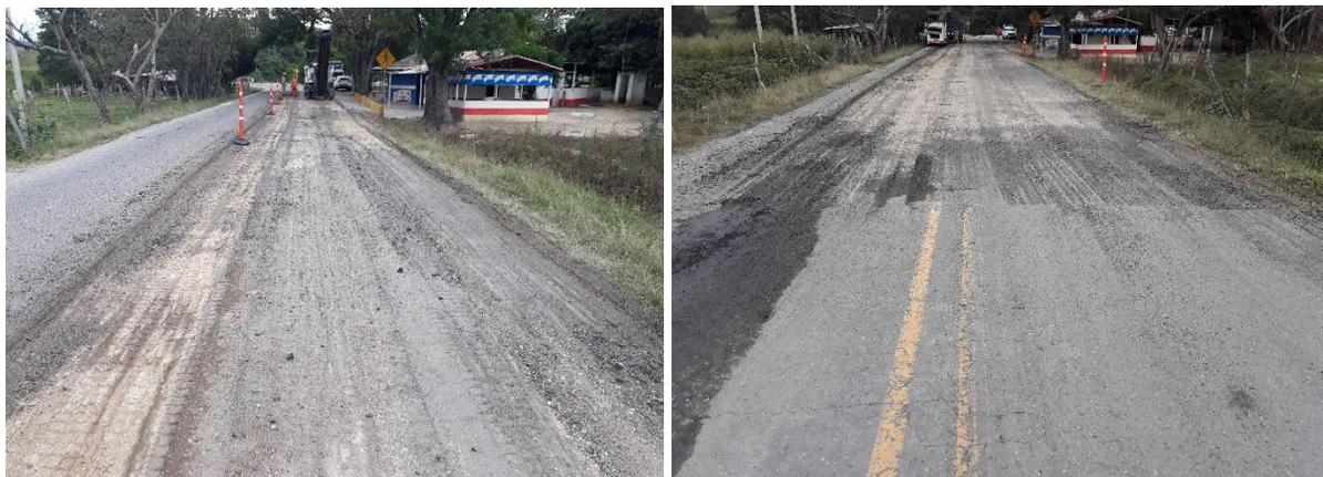
Figura 174. Fresado carpeta de rodadura calzada completa en el PR 13+700 Ruta 7008
