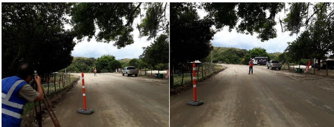
Figura 184. Nivelación de ejes en calzada escarificada PR 13+770 Ruta 7008
