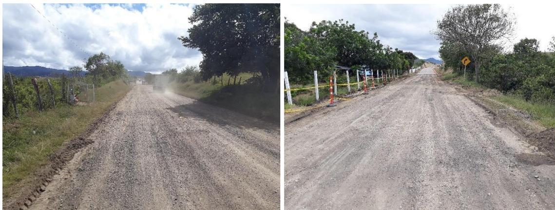
Figura 177. Fresado carpeta de rodadura calzada completa en el PR 14+110-PR 14+300 Ruta 7008
