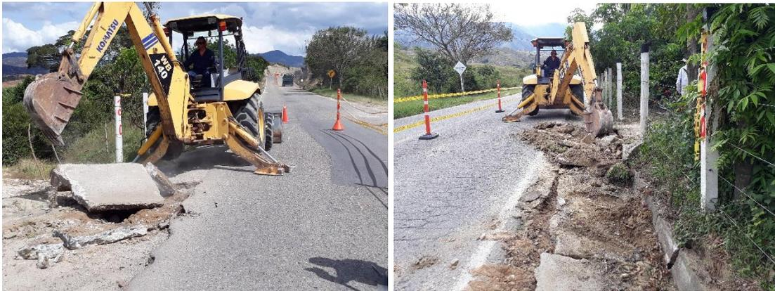
Figura 166. Demolición de cunetas de concreto con Retrocargador PR 14+300 Lado Derecho
