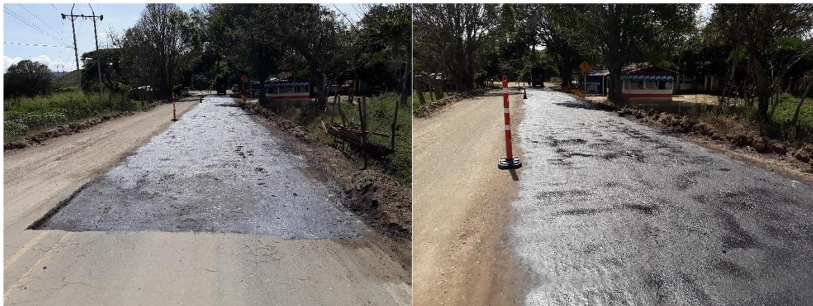
Figura 197. Riego de Imprimación carril derecho PR 13+700 Ruta 7008
