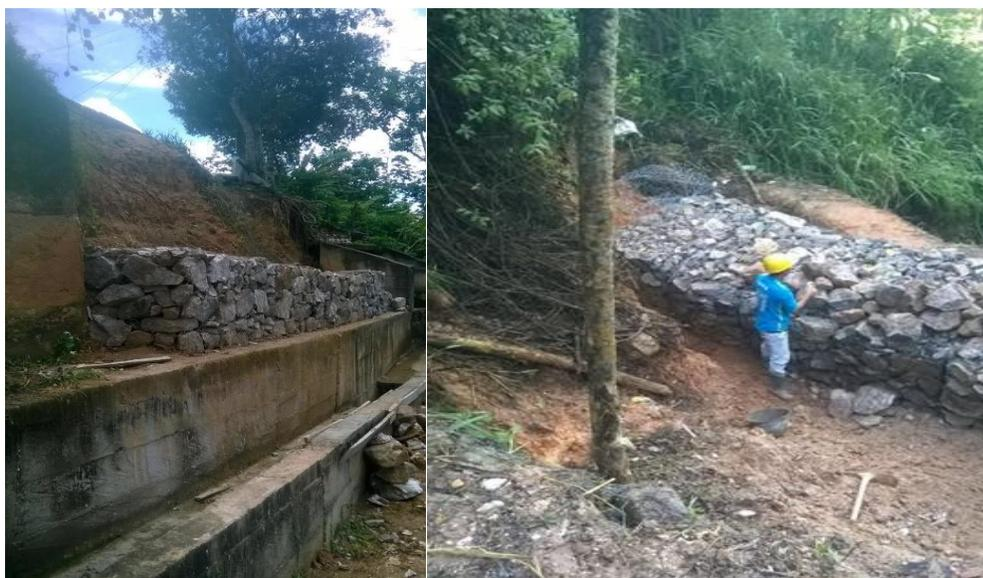
Figura 63. Instalación de Muros de contención en Gaviones arriba y abajo de la obra de drenaje
