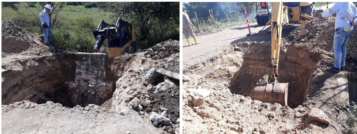
Figura 171. Excavación y demolición de cabezote alcantarilla en el PR 13+980
