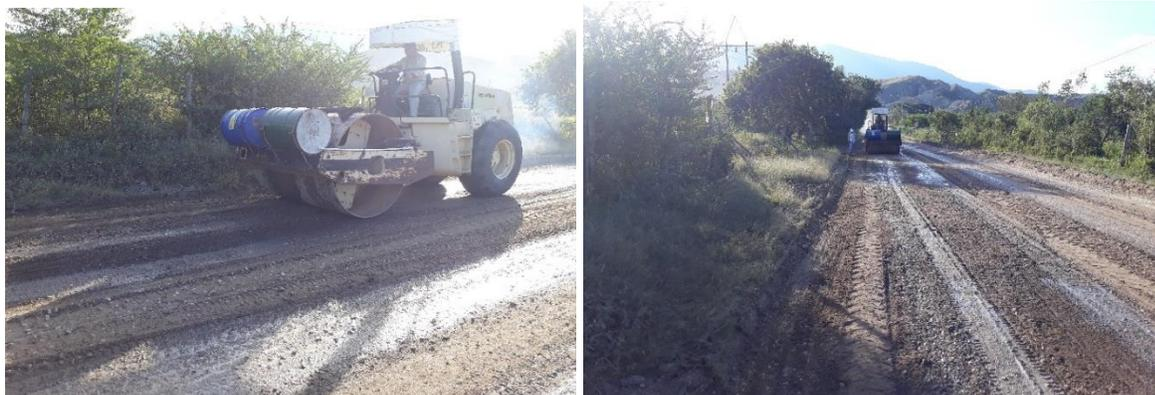
Figura 181. Compactación de material para base granular en el PR 14+110
