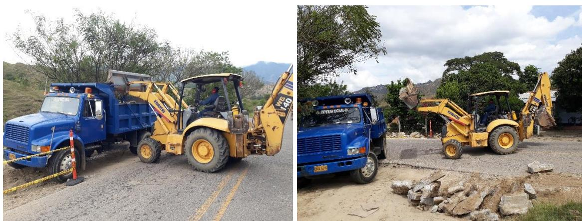
Figura 169. Remoción y transporte de material procedente de la demolición de cunetas.
