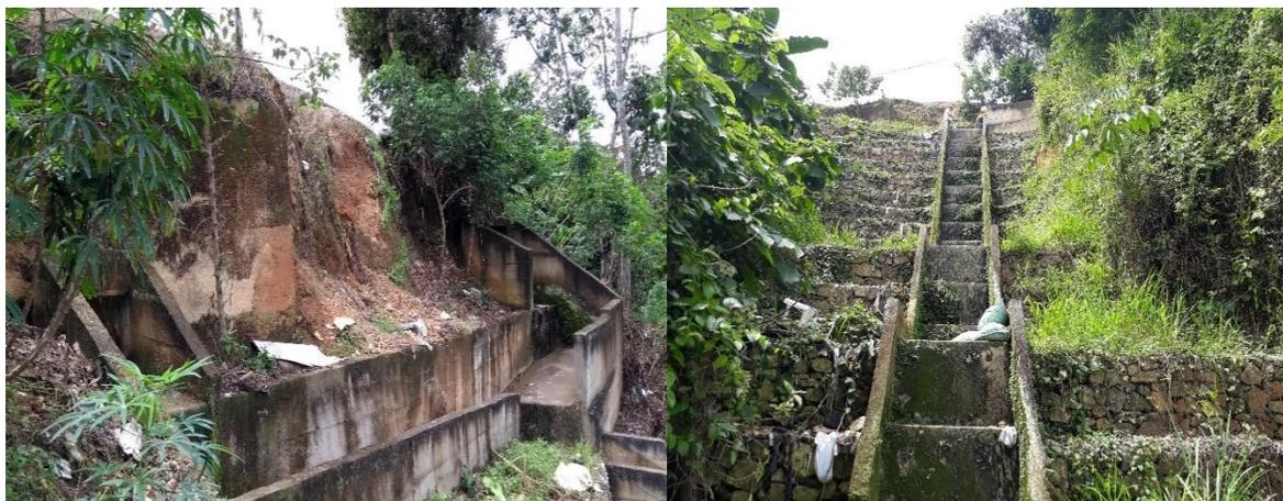
Figura 60. Estado inicial del Disipador de Energía y Canal de Descarga
