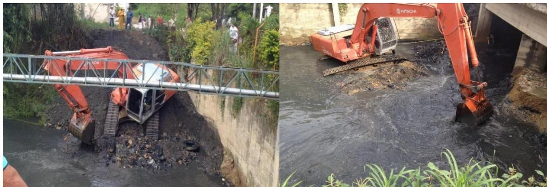
Figura 36. Excavaciones en material común y remoción de sedimentos Puesto la Gloria PR 49+000.
