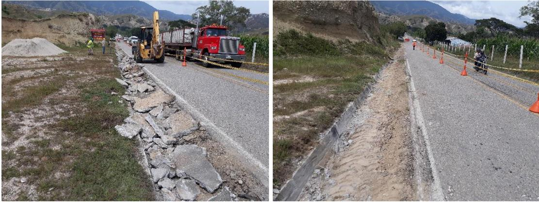
Figura 165. Demolición de cunetas de concreto con Retrocargador PR 14+300 Lado Derecho
