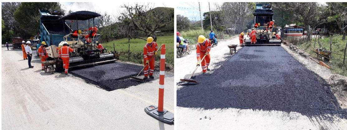
Figura 199. Extensión de Mezcla Asfáltica carril derecho PR 13+700 Ruta 7008
