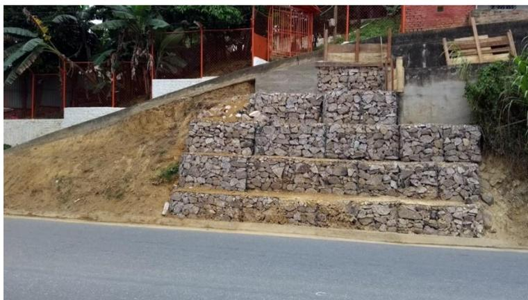
Figura 32. Mejoramiento mediante Submuración de muro de contención en gaviones PR 52+597
