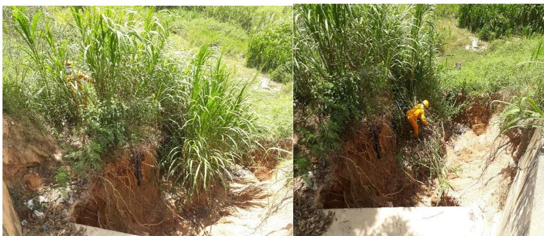
Figura 67. Remoción de material vegetal en canal de descarga de Alcantarilla PR 14+0497 Ruta 70NS01
