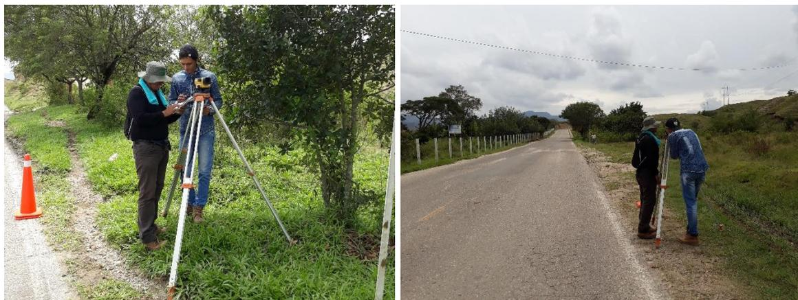
Figura 161. Nivelación de secciones existentes con nivel de precisión PR 14+300 Ruta 7008
