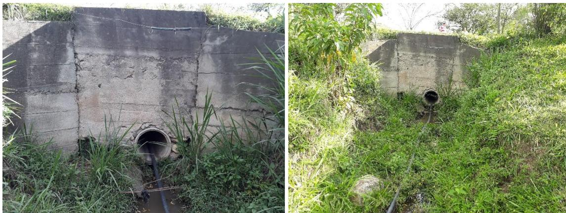
Figura 134. Alcantarilla PR 13+980 Descole tubería  $\varnothing=24''$  lado Izquierdo
