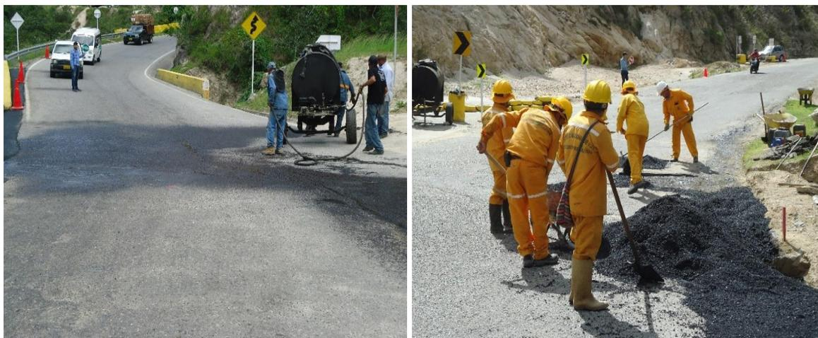
Figura 81. Aplicación Riego de liga y extensión de mezcla en el PR 11+0600 Ruta 7008
