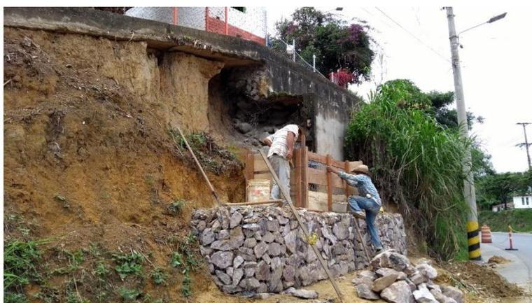
Figura 31. Seguimiento al proceso constructivo Muro de contención en Gaviones PR 52+597 Ruta 7008
