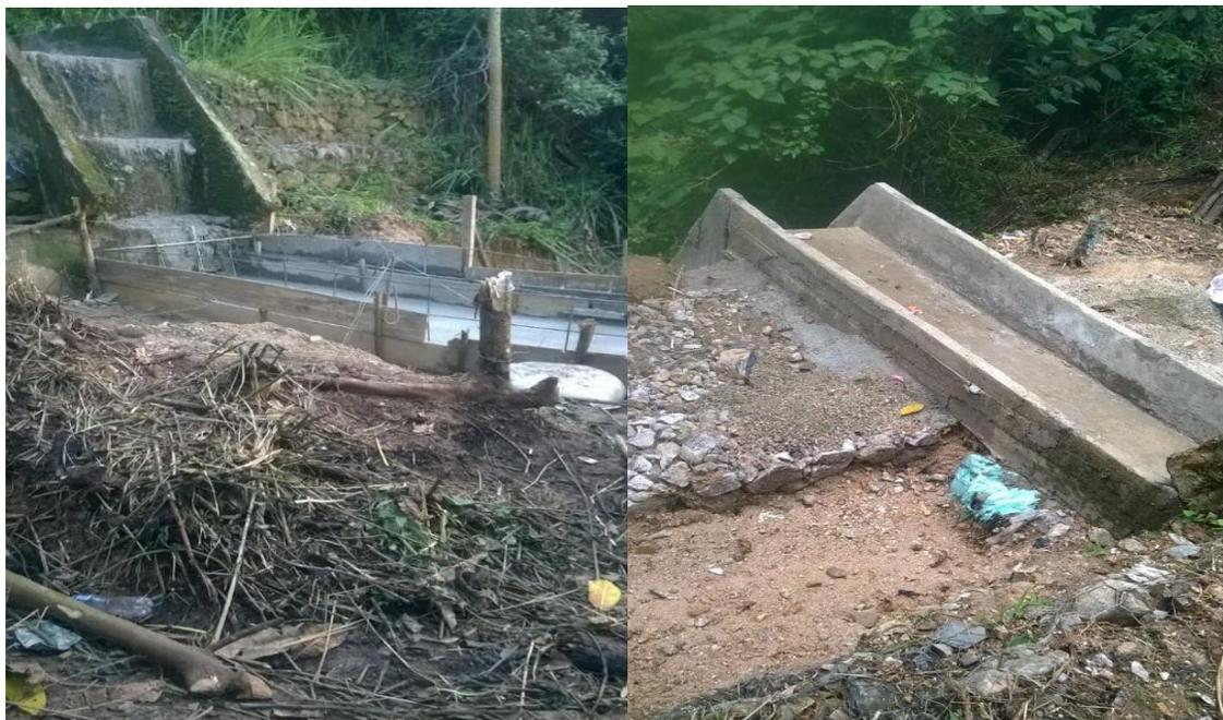
Figura 64. Proceso Constructivo Disipador de Energía Obra de Drenaje PR 30+0767 Ruta 70NS01
