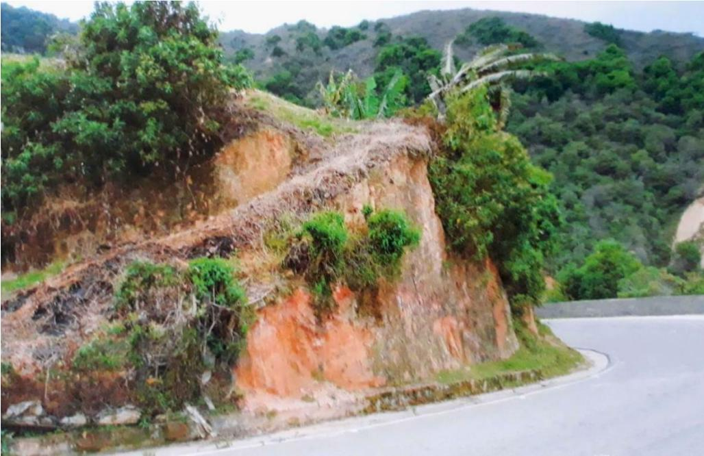
Figura 6. Talud Superior de la vía compuesto por suelos residuales en el PR 66+0117 Ruta 7008.
