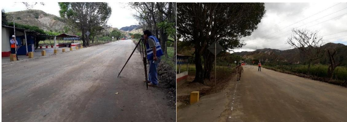
Figura 182. Nivelación de ejes en calzada escarificada PR 13+700 Ruta 7008
