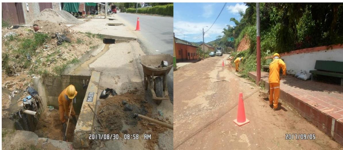
Figura 75. Limpieza de Obras en el PR 00+0276 y limpieza de cunetas revestidas en tierra en el PR 31+0550 Ruta 70NS08, ejecutado por Cooperativa de trabajo asociado LAS MERCEDEZ.
