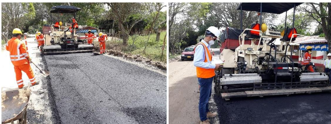
Figura 200. Extensión de Mezcla Asfáltica carril derecho PR 13+740 Ruta 7008
