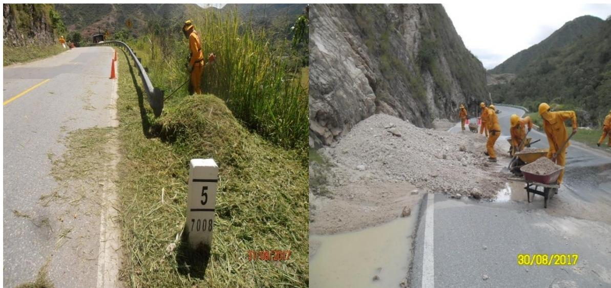
Figura 74. Rocería y Desmote manual en el PR 05+0000 y Despeje de Derrumbes en el PR 09+0700 Ruta 7008, ejecutado por Cooperativa de trabajo asociado CALISERVICIOS Y OPLAMAR.
