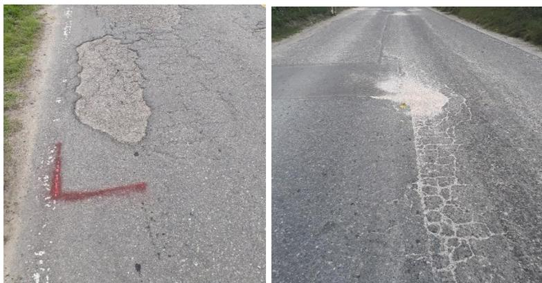
Figura 151. Descascaramiento y desgaste superficial de carpeta PR 14+100 Ruta 7008
