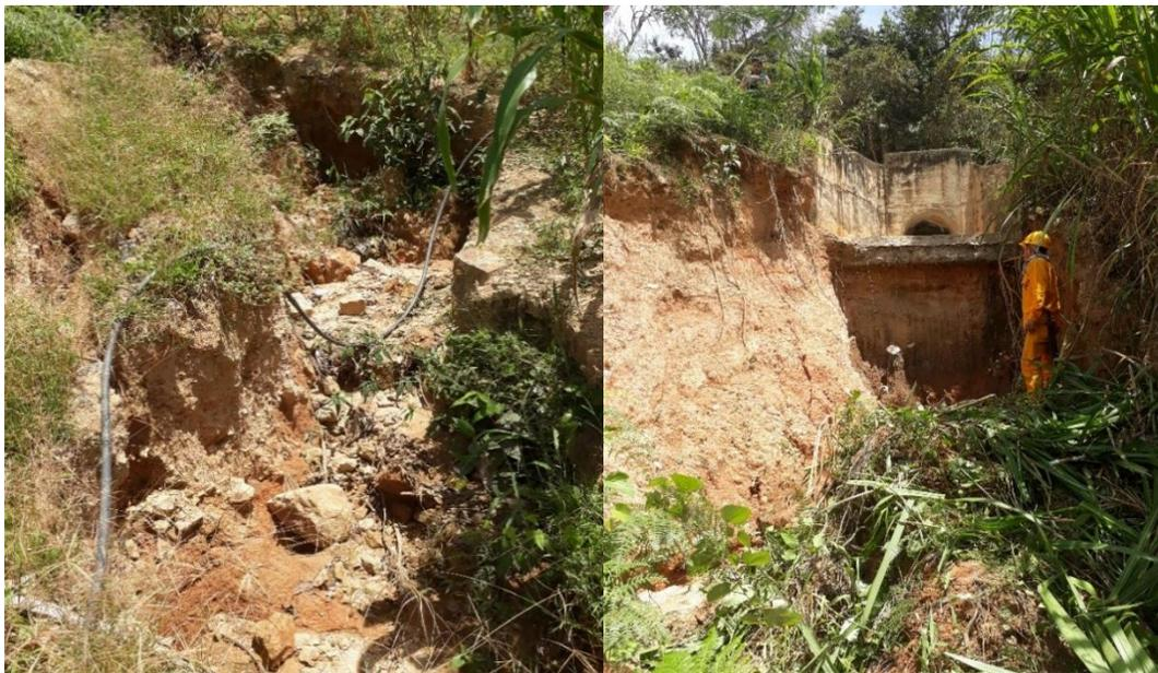
Figura 68. Inspección canal del cauce de descarga y limpieza de vegetación de descole PR 14+0497
