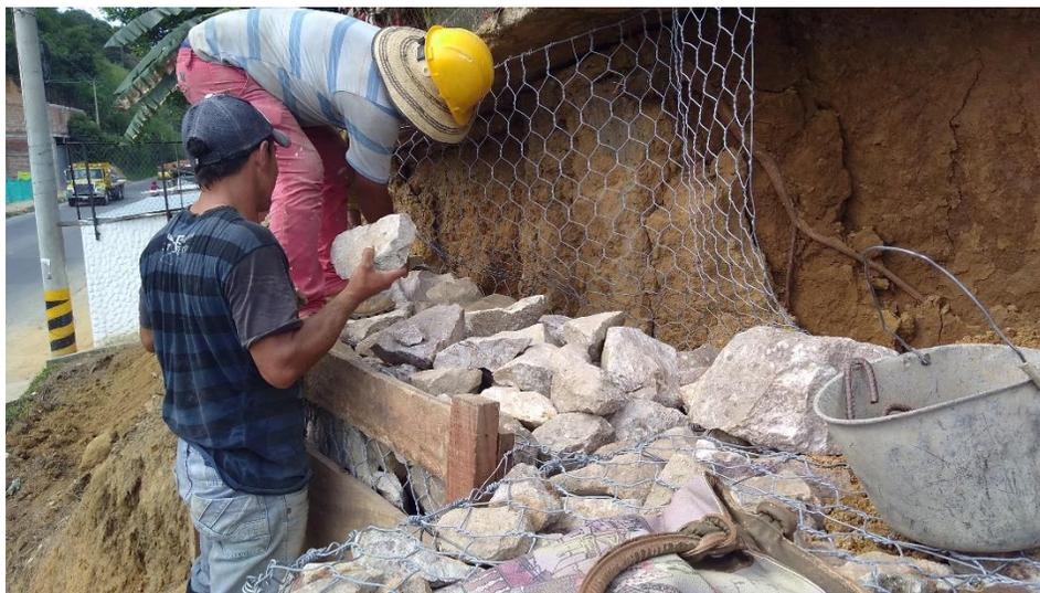
Figura 26. Mallas de alambre de acero entrelazado con recubrimiento de Zinc galvanizado
