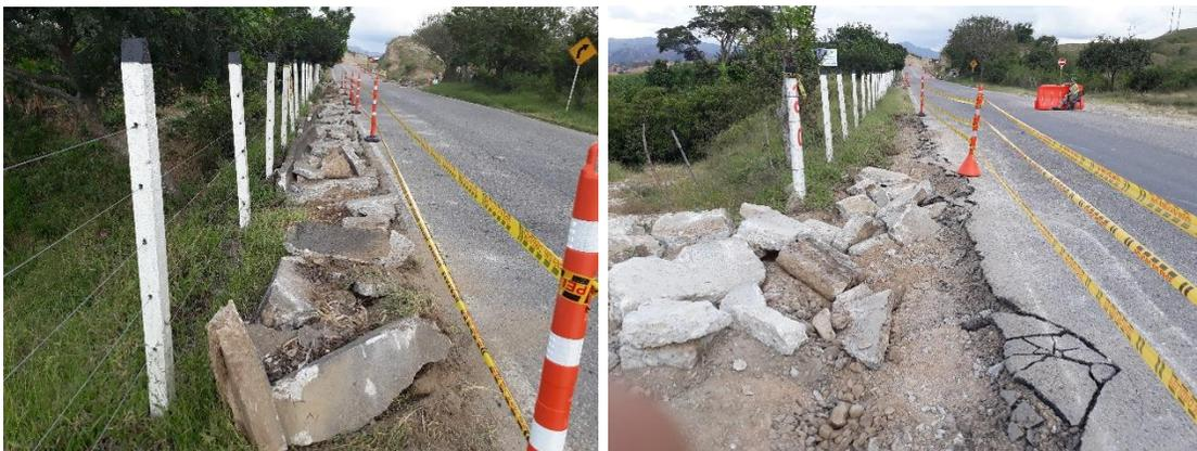
Figura 167. Demolición de cunetas de concreto con Retrocargador PR 14+300 Lado Derecho
