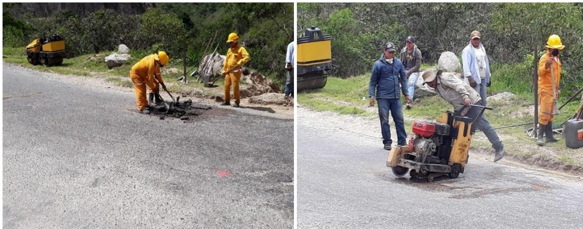
Figura 80. Demolición de áreas de carpeta de rodadura con uso de Herramienta menor y cortadora de Piso.
