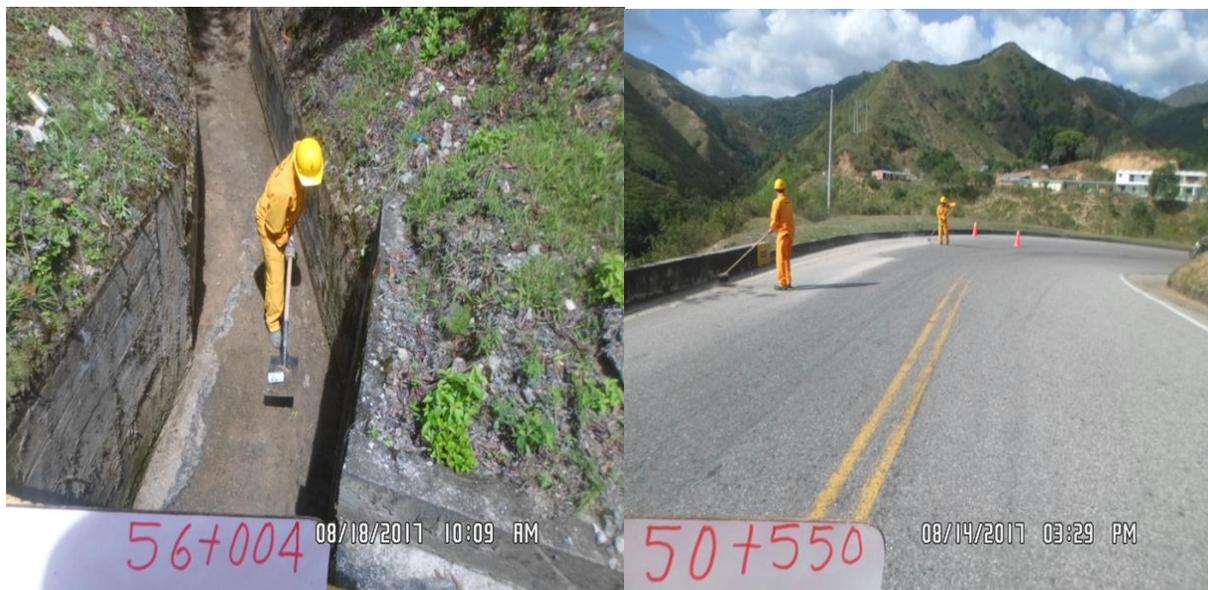
Figura 72. Limpieza de encoles y descoles en el PR 56+0004 y Limpieza de Calzada en el PR 50+0550 Ruta 7008, ejecutado por Cooperativa de Trabajo asociado EL TARRA
