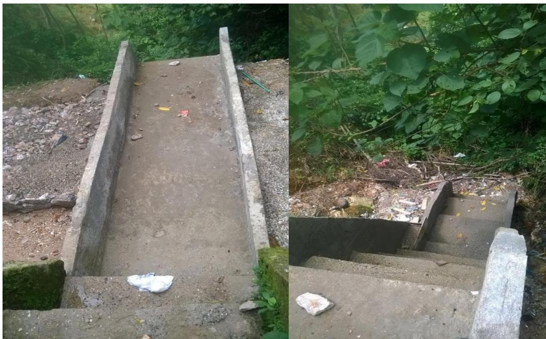
Figura 65. Reconstrucción paredes del Canal de descarga y Construcción de Disipador de Energía
