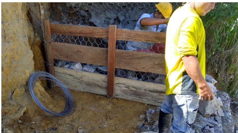
Figura 28. Encofrado en malla galvanizada muro de contención en gaviones.
