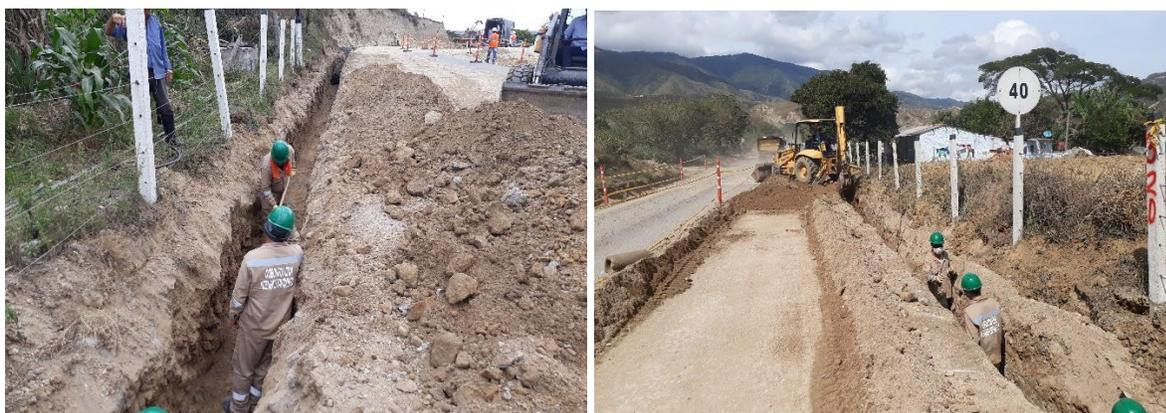
Figura 190. Excavación mecánica para instalación de filtros Lado Izquierdo PR 14+340
