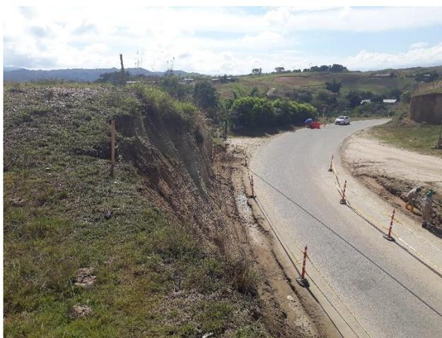
Figura 144. Talud Inestable vista superior PR 14+400 Ruta 7008
