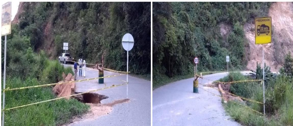
Figura 56. Instalación de señales verticales y demarcación con cinta reflectiva
