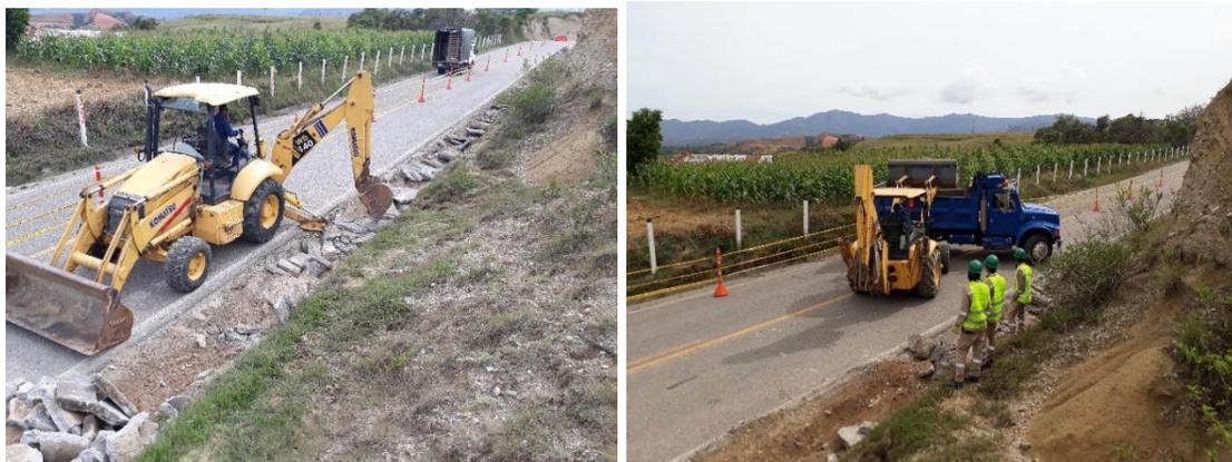
Figura 164. Demolición de cunetas de concreto con Retrocargador PR 14+300 Lado Derecho
