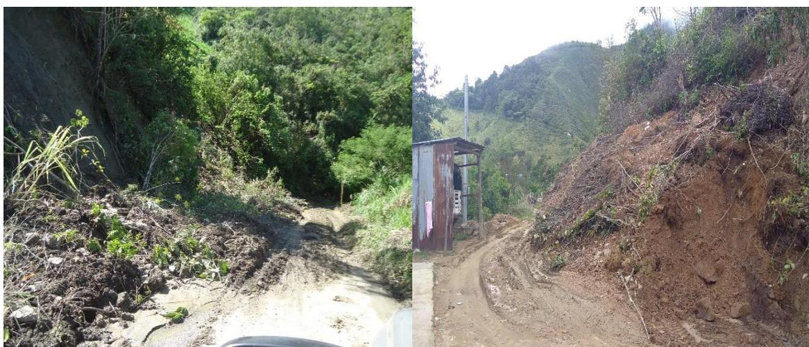
Figura 42. Inspección de Derrumbes vía Vereda La Samaritana, Ocaña N.S.
