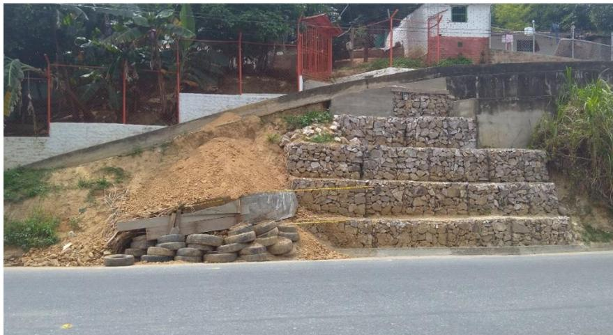
Figura 33. Estabilización de talud mediante instalación de muros en gaviones del PR 52+597 Ruta 7008.
