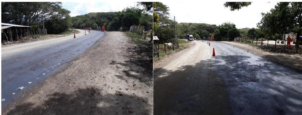
Figura 198. Riego de Imprimación carril derecho PR 13+800 Ruta 7008
