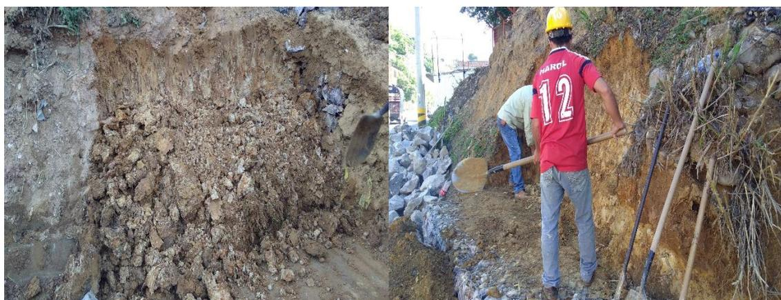
Figura 24. Excavaciones manuales de material común para instalación de muros en gaviones.
