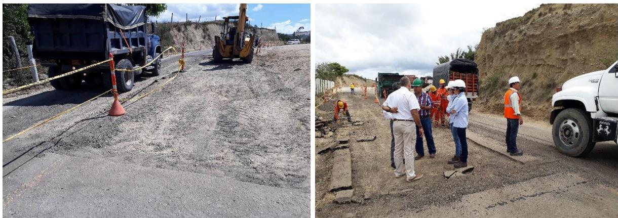
Figura 179. Bacheo de carpeta de rodadura con minicargador PR 14+330 Ruta 7008
