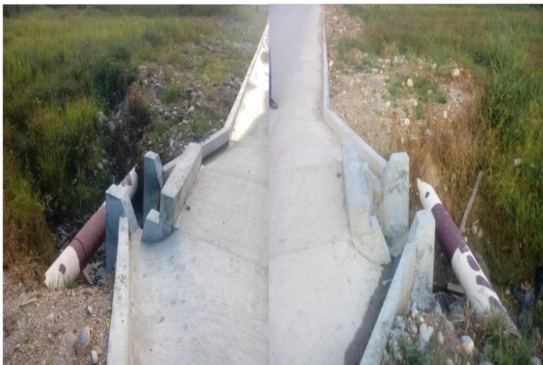
Figura 53. Alcantarilla tipo Cajón descole K1+330. (Fuente: Pasante).
