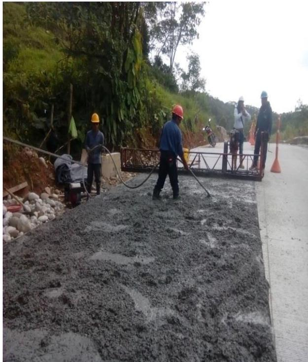
Figura 19. Proceso de vibrado de mezcla. (Fuente: Pasante)
