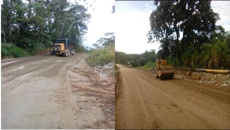
Figura 8. Riego, nivelación y compactación de material de Subbase. (Fuente: Pasante)
