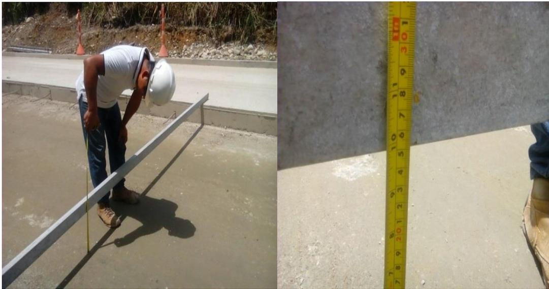
Figura 14. Inspección de espesor de losa de pavimento. (Fuente: pasante)
