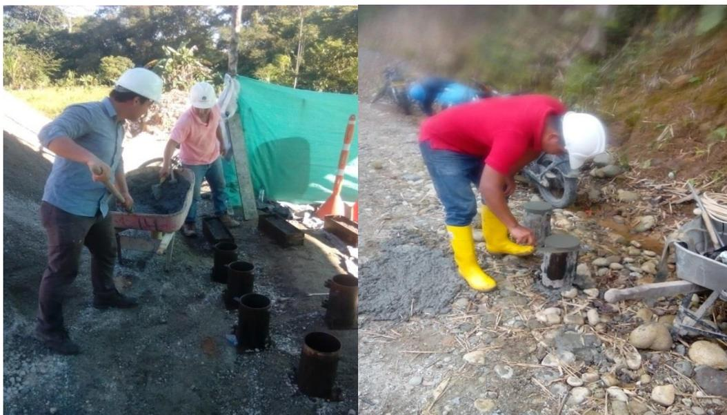
Figura 28. Elaboración de muestras de concreto. (Fuente: Pasante).
