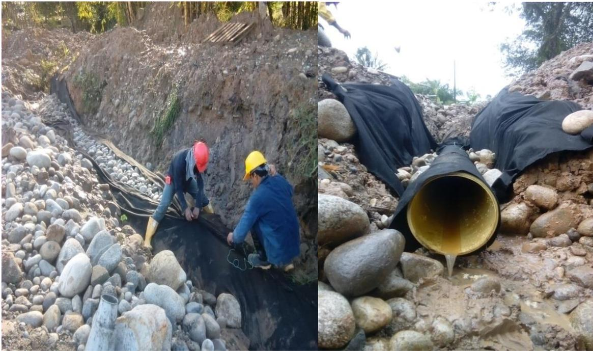
Figura 43. Costura de filtro y chequeo de funcionamiento de filtro. (Fuente: Pasante)
