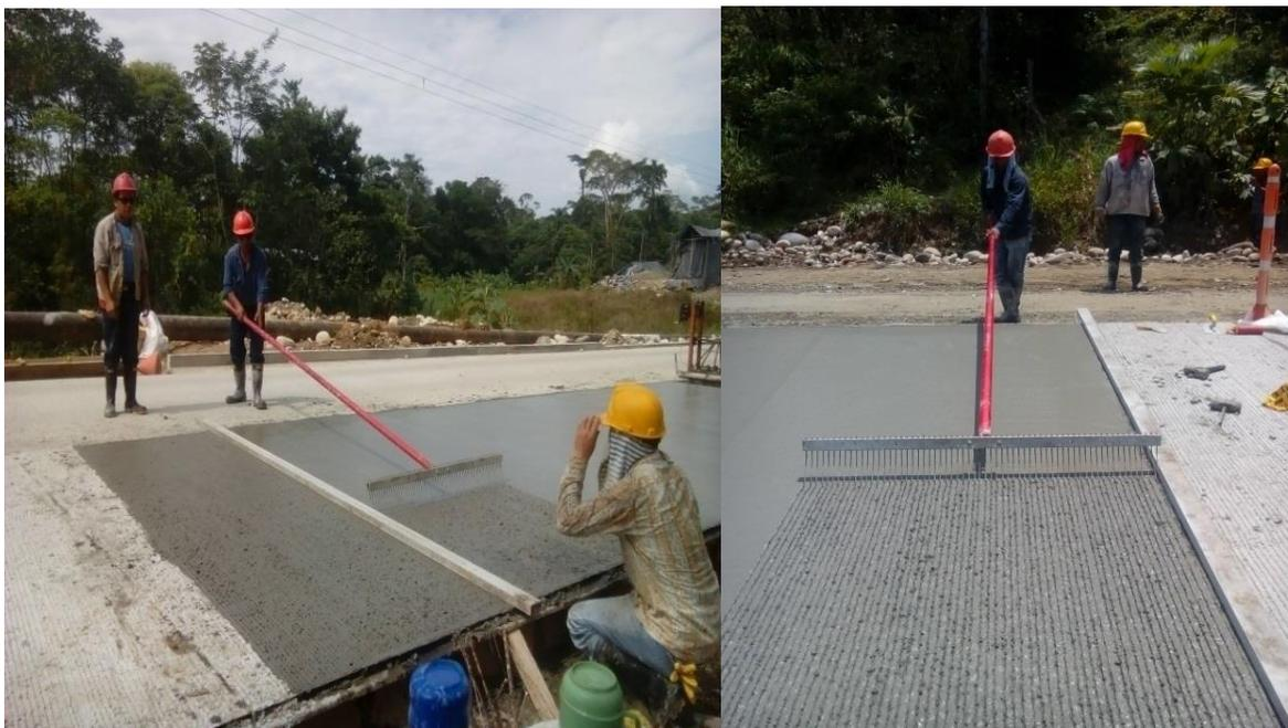
Figura 23. Rallado o Macrotexturizado de losa de pavimento. (Fuente: Pasante).
