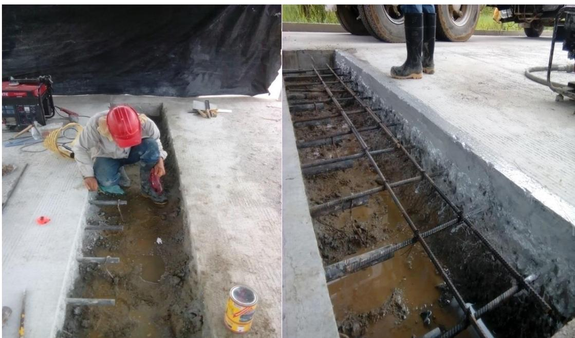
Figura 56. Reparación de losa agrietada. (Fuente: Pasante)
