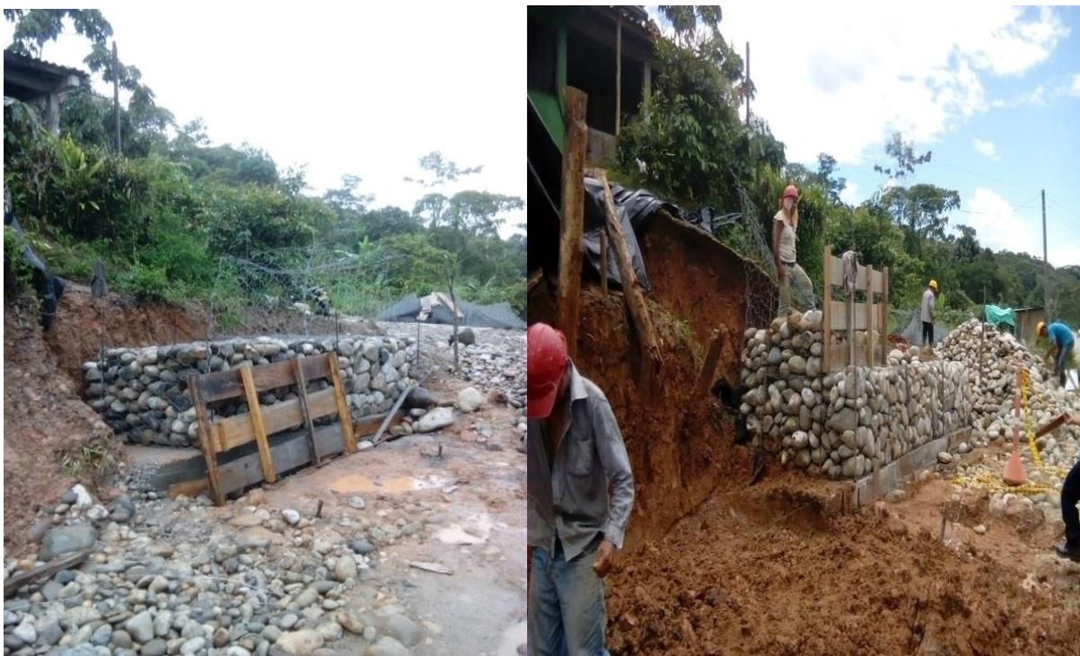
Figura 37. Llenado de secciones de gavión. (Fuente: Pasante)
