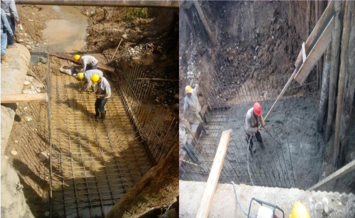
Figura 46. Acero de refuerzo y concreto de 3000 Psi para piso de Box culvert. (Fuente: Pasante)
