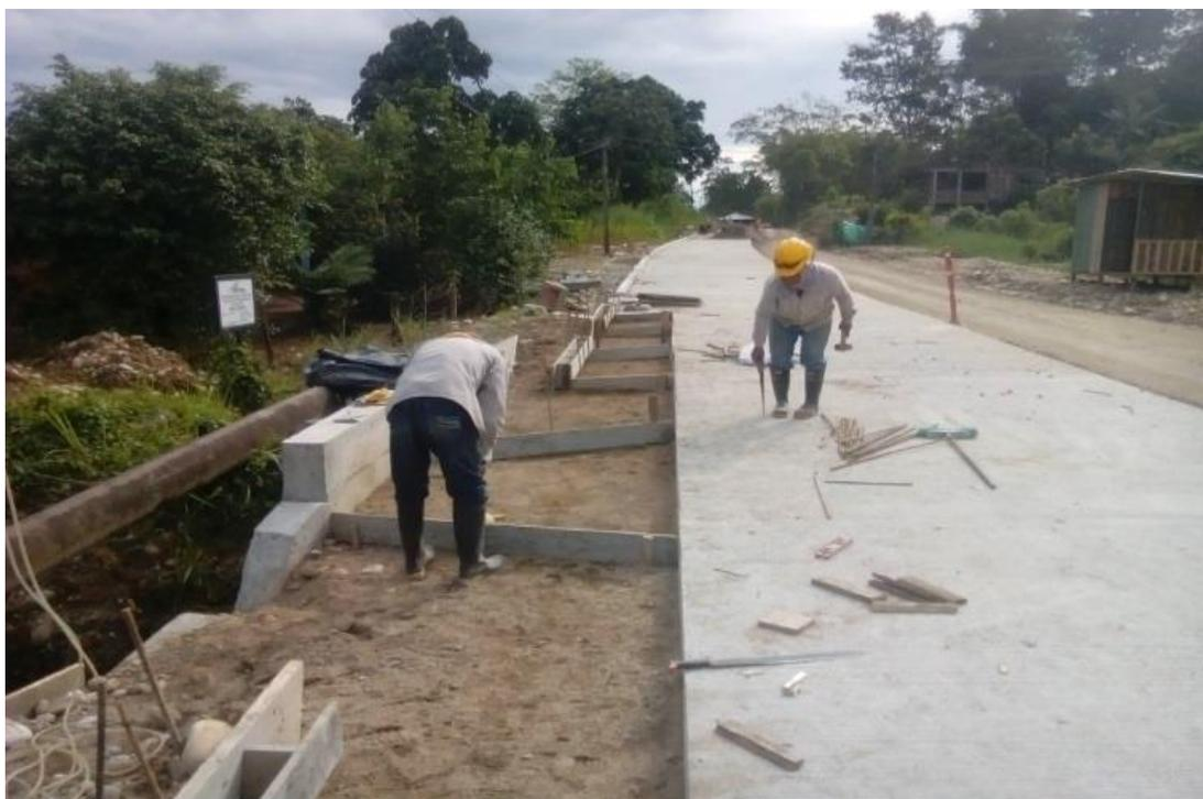
Figura 31. Instalación de formaleta en madera para secciones de cuneta. (Fuente: Pasante)
