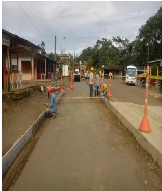
Figura 16. Instalación de Formaleta metálica (Fuente: Pasante)
