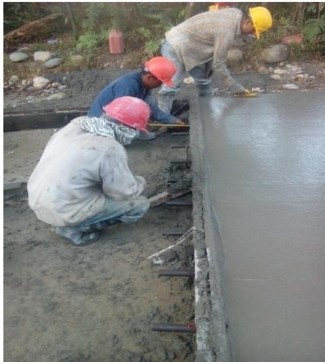
Figura 25. Instalación de pasadores o barras transmisoras de carga. (Fuente: Pasante).
