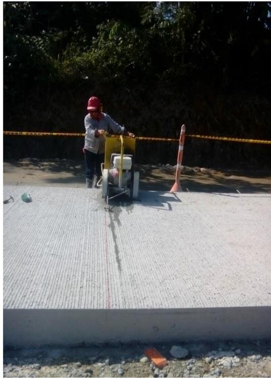
Figura 26. Corte o dilatación de losa de pavimento. (Fuente: Pasante).
