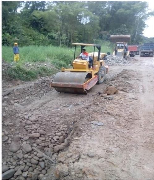
Figura 7. Compactación mecánica de material de Subrasante (Fuente: Pasante)
