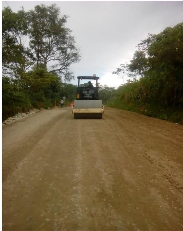
Figura 12. Compactación mecánica capa de Base (Fuente: Pasante)
