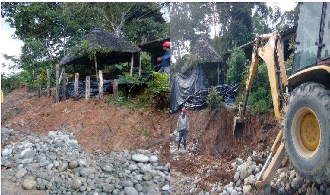
Figura 34. Localización y excavación para construcción de gavión. (Fuente: Pasante)
