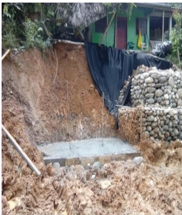
Figura 36. Instalación de varillas de 1 pulgada de diámetro para atraque de gavión. (Fuente: Pasante)
