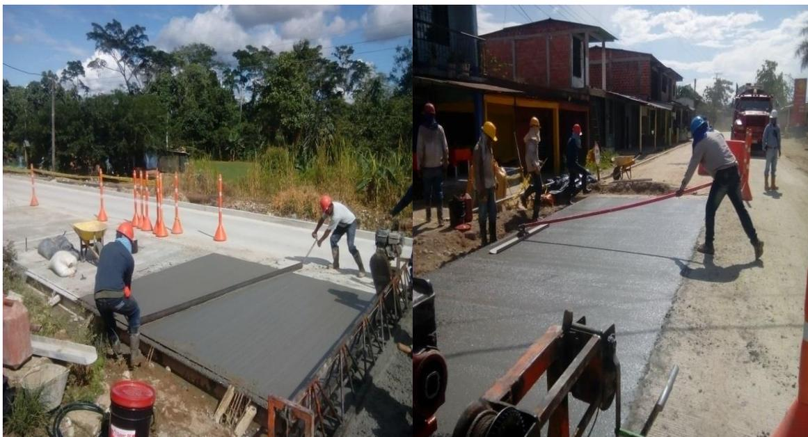
Figura 22. Riego de mezcla con rodillo liso y alisado con flotador. (Fuente: Pasante).
