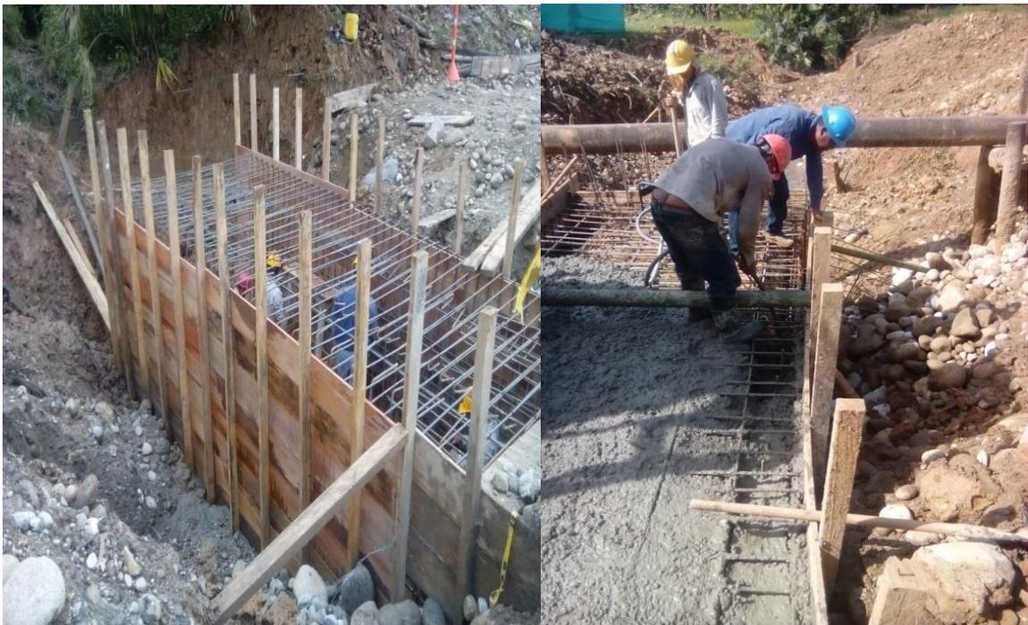
Figura 47. Formaleta y fundición de cuerpo del Box culvert. (Fuente: Pasante).
