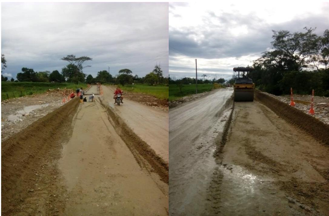
Figura 55. Reparación de capa de Base. (Fuente: Pasante)
