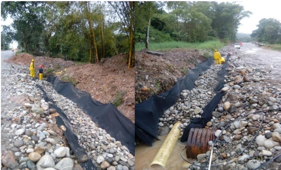
Figura 42. Llenado de filtro e instalación de tubería NovaFor de 10 pulgadas de diámetro. (Fuente: Pasante).
