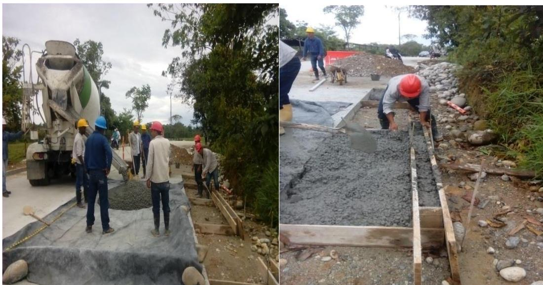
Figura 32. Transporte de concreto y riego de mezcla para cunetas. (Fuente: Pasante).
