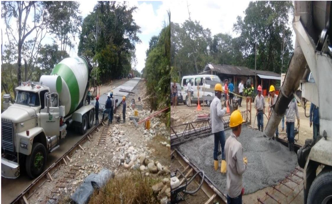
Figura 17. Transporte y vertimiento de mezcla de concreto. (Fuente: Pasante)
