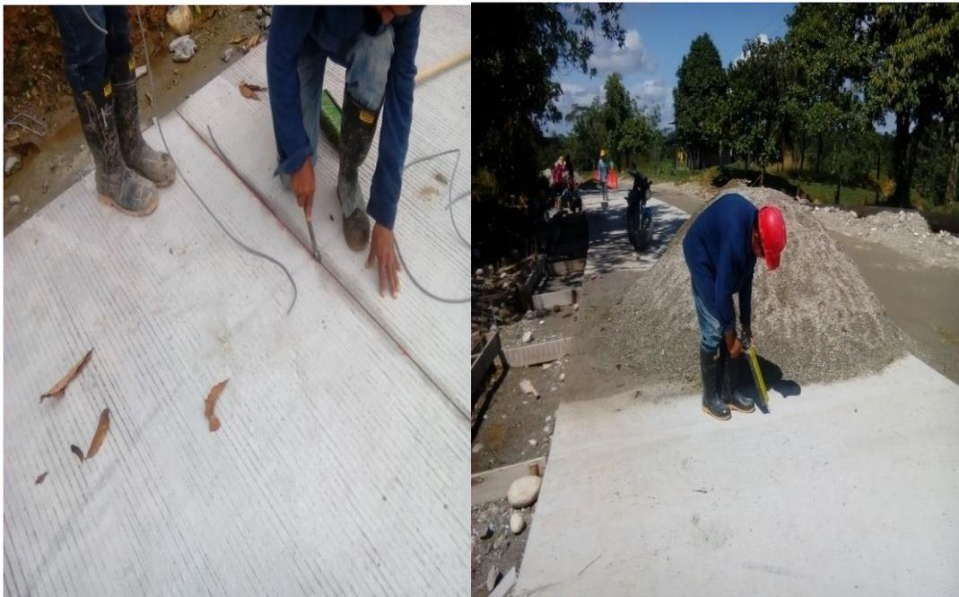
Figura 27. Instalación de Backer Rod y sellado con Vulkem 45 SSL para junta. (Fuente: Pasante)
