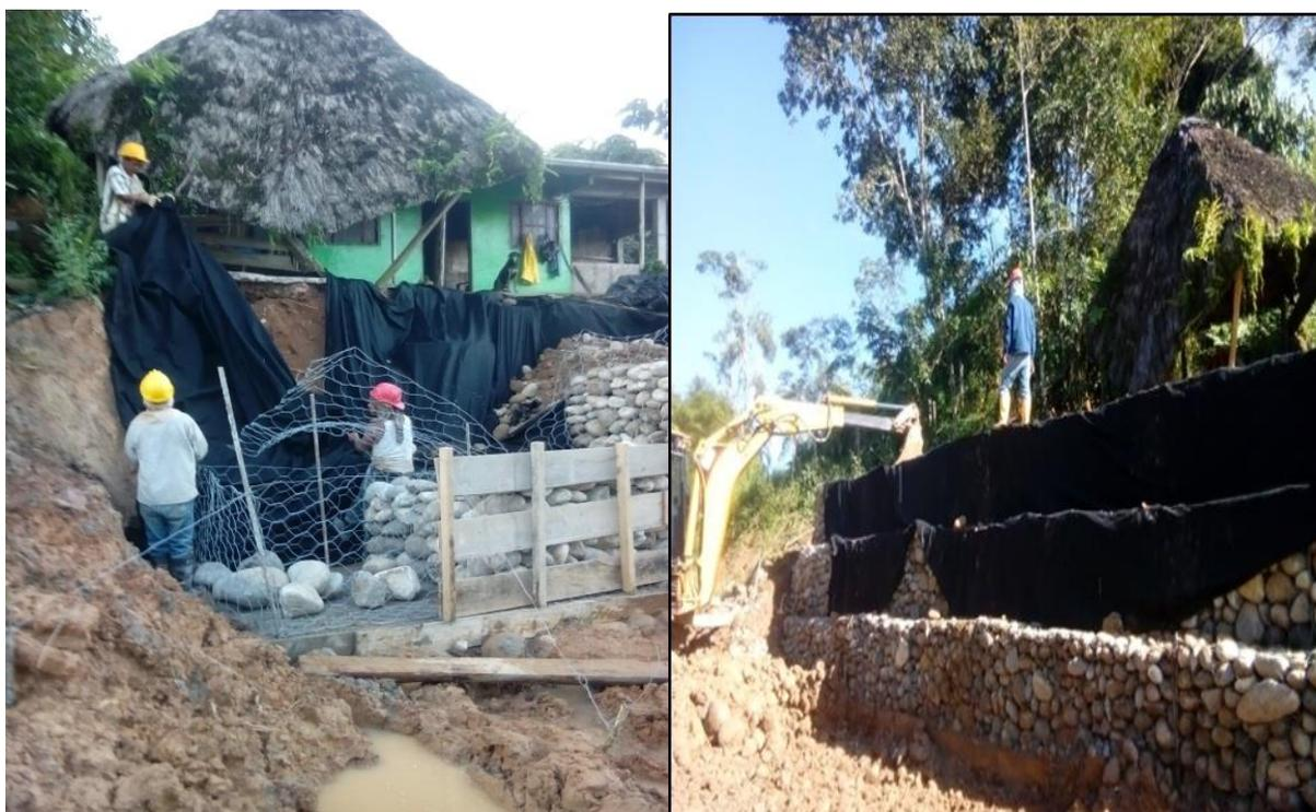
Figura 38. Instalación de geotextil y llenado al respaldo del gavión. (Fuente: Pasante).
