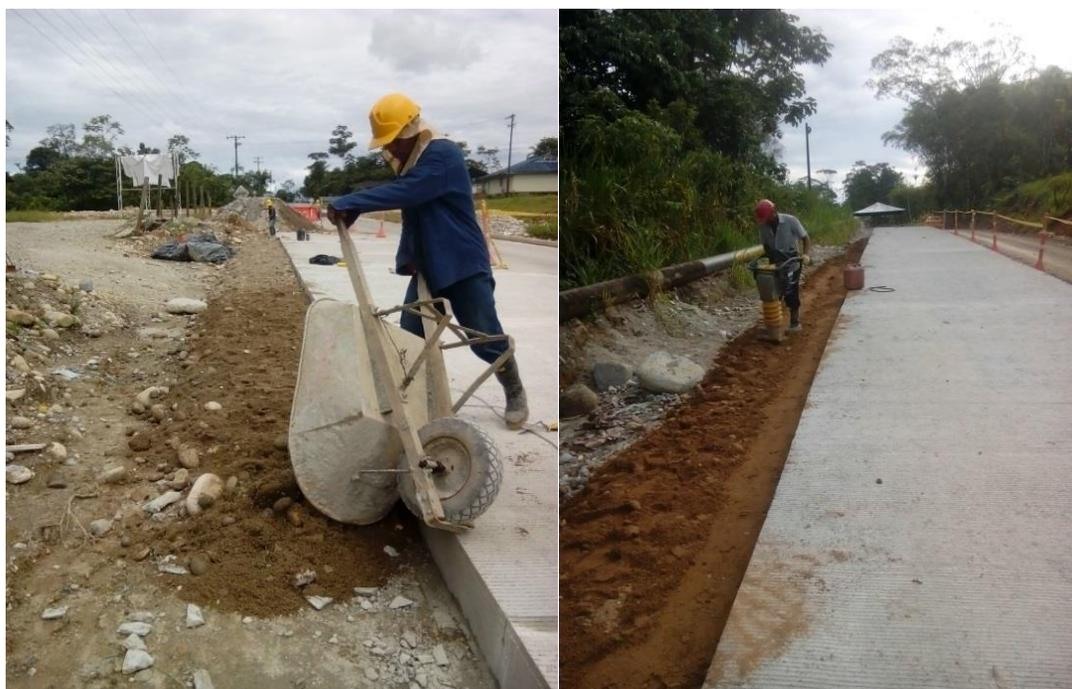
Figura 30. Riego, nivelación y compactación de material de apoyo de cuneta. (Fuente: Pasante)
