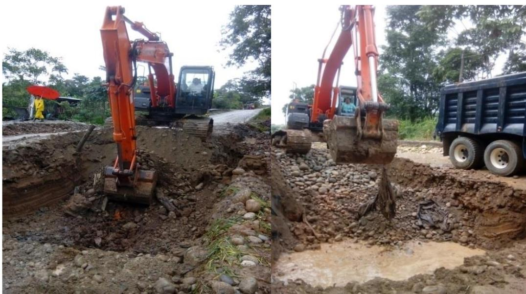
Figura 4. Excavación mecánica para capa de mejoramiento Subrasante (Fuente: Pasante)
