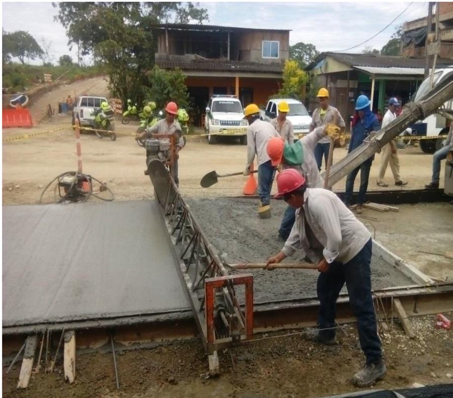
Figura 21. Riego de mezcla de Concreto con regla vibratoria. (Fuente: Pasante)
