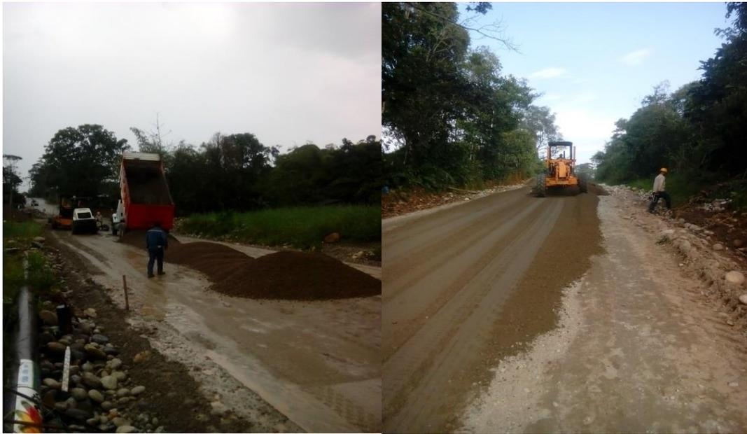
Figura 10. Riego y nivelación de material para Base (Fuente: Pasante)
