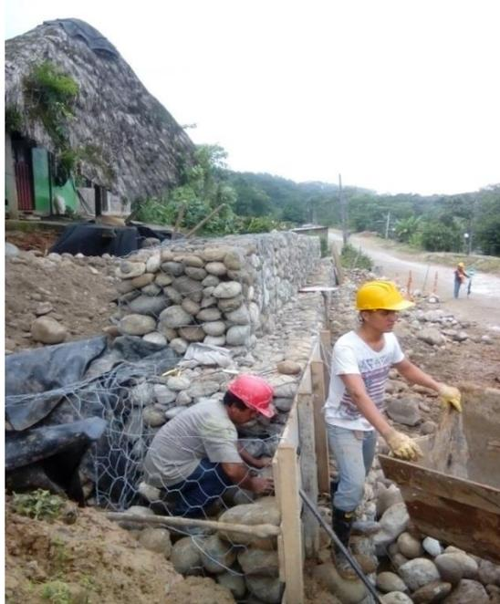
Figura 54. Selección e instalación de piedras en malla para el gavión. (Fuente: Pasante).
