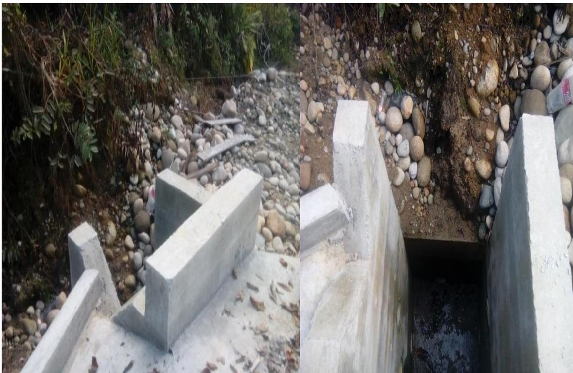
Figura 49. Alcantarilla tipo cajón margen izquierdo K0+525. (Fuente: Pasante).
