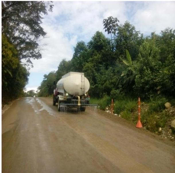
Figura 11. Riego de agua a capa de Base. (Fuente: Pasante)
