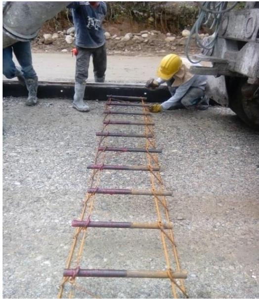
Figura 20. Instalación de Dovelas o parrillas. (Fuente: Pasante)
