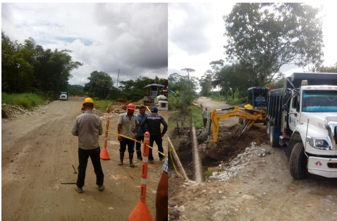
Figura 45. Localización y excavación de Box culvert
