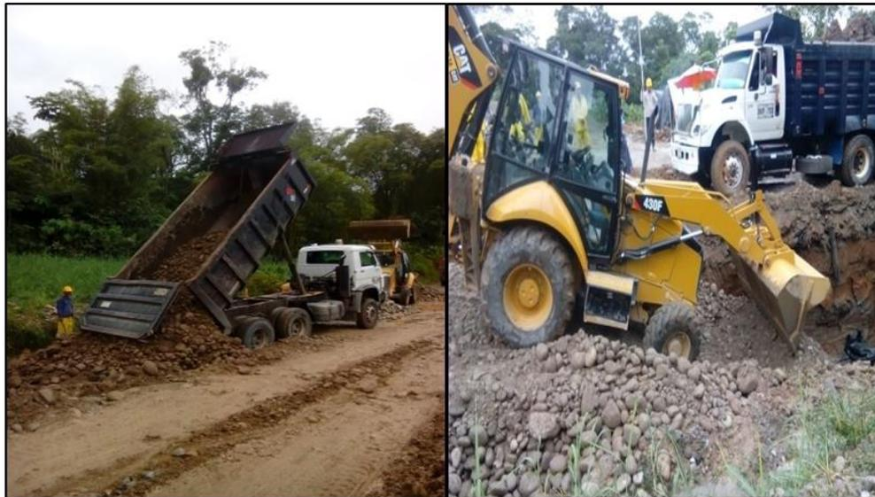
Figura 6. Relleno y riego de material de Subrasante (Fuente: Pasante).
