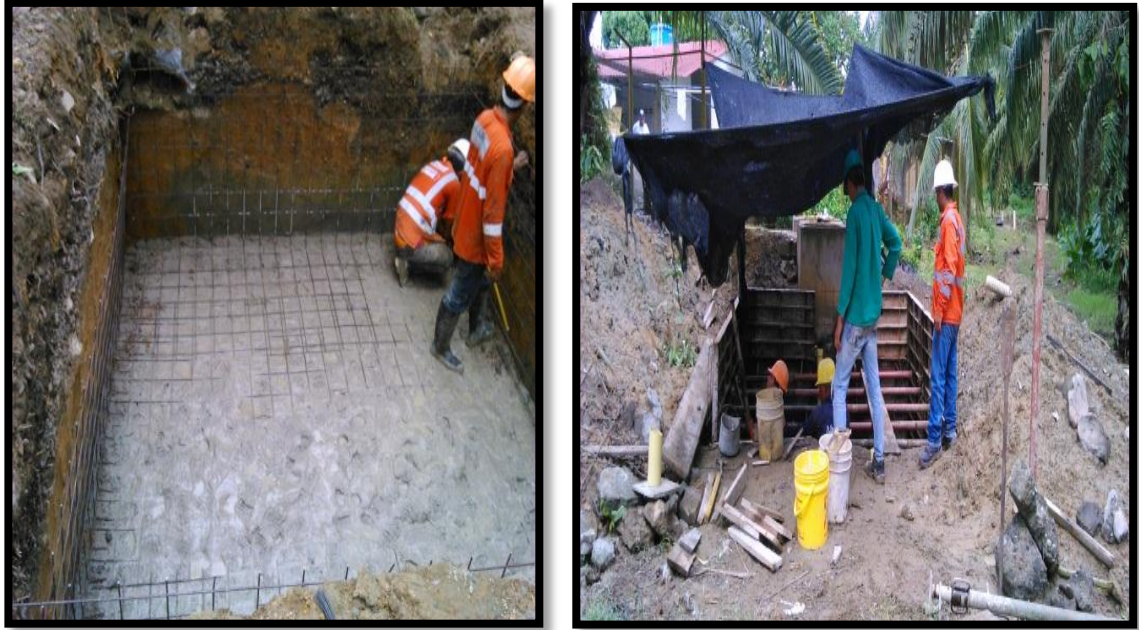
Fuente. Pasante Construcción de placa perforada para dividir el filtro Fito pedológico
