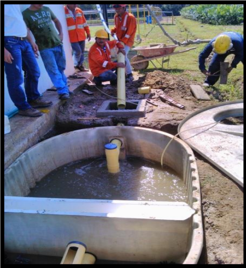
Foto 6. Llenado tanque séptico Vivero.
