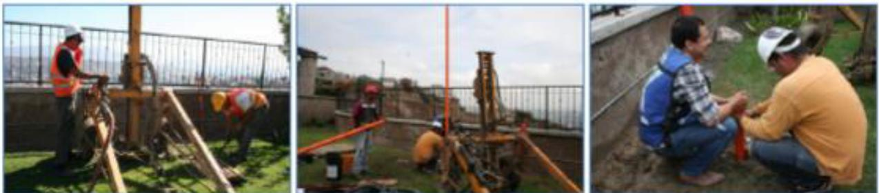
*Ilustración 27. Colocación de tubería inclinométrica*
