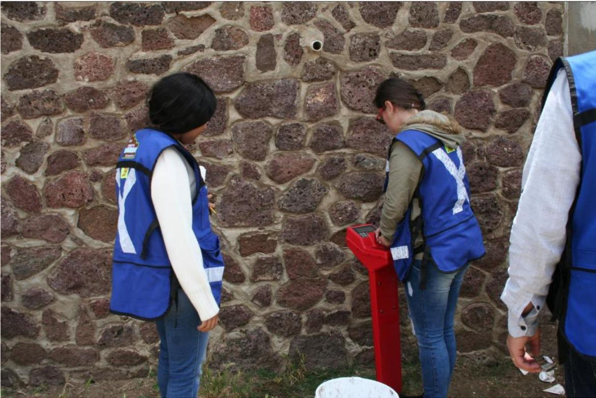
*Ilustración 46 Detección de tuberías con Depth Reading line tracer*
