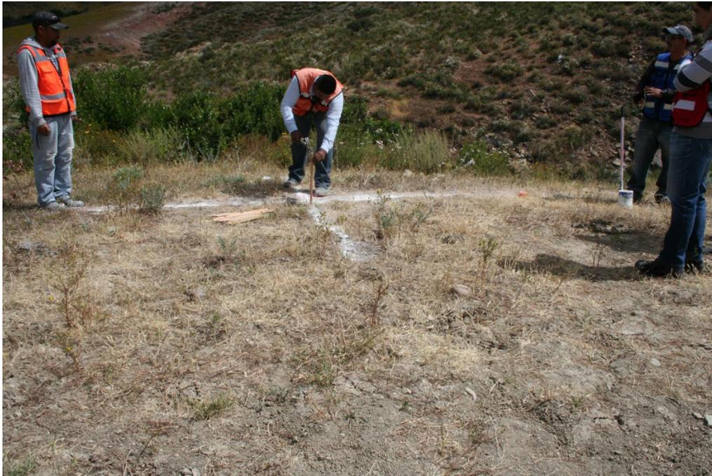
*Ilustración 43. Levantamiento topográfico marcación de puntos*
