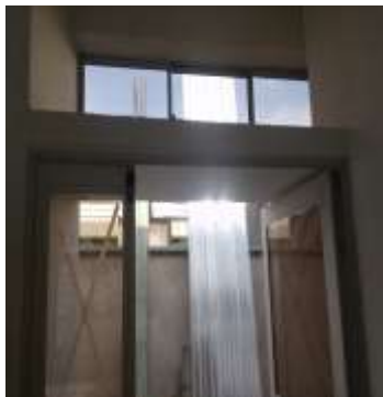
Fotografía 46. Dintel en concreto 21Mpa
