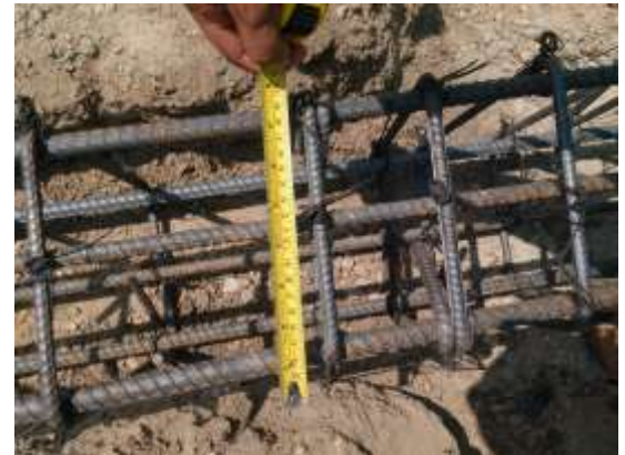
Fotografía 101. Distribución de varillas.
