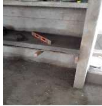
Fotografía 45. Placas en concreto 3000 Psi
