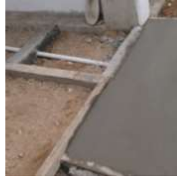
Fotografía 51. Bordillo en concreto
