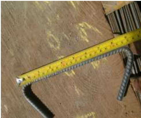
Fotografía 100. Ganchos para columnas.
