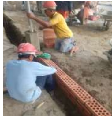
Fotografía 81. Muro en ladrillo a la vista
