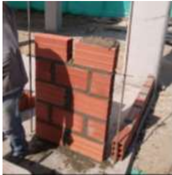
Fotografía 44. Anclaje \phi 3/8 con resina
