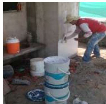
Fotografía 66. Estuco acrílico para humedad
