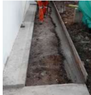
Fotografía 87. Andenes en concreto
