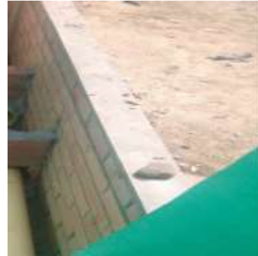
Fotografía 79. Alfagia en concreto 3000 psi
