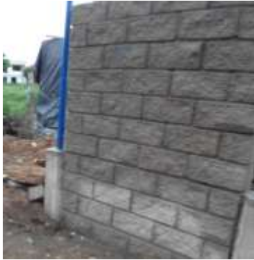
Fotografía 84. Muro en bloque abujardado.
