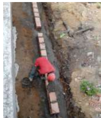
Fotografía 83. Muros en bloque hueco No.5
