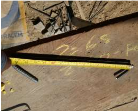
Fotografía 98. Ganchos para columnas.
