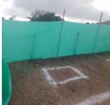
Fotografía 7. Localización y replanteo.
