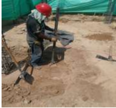
Fotografía 11. Relleno en base granular B-400 Fotografía 12. Relleno con material Seleccionado
