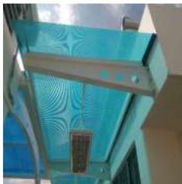
Fotografía 65. Cubierta en policarbonato.
