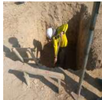
Fotografía 10. Excavación manual material.
