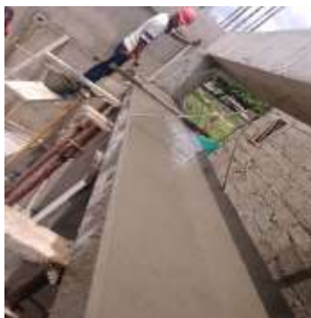
Fotografía 48. Placas en concreto 3000 Psi
