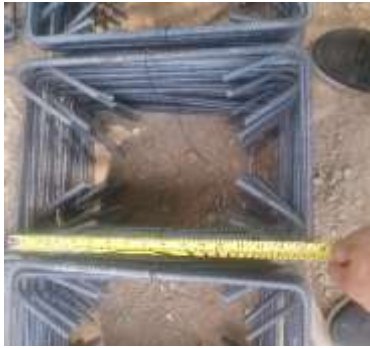
Fotografía 17. Acero para cimentación.
