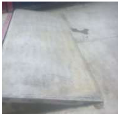
Fotografía 88. Rampa en concreto.
