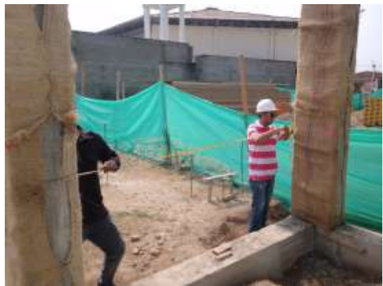
Fotografía 103. Luz entre columnas
