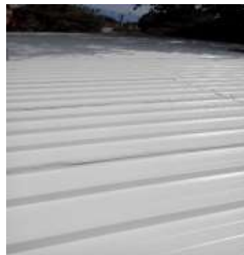
Fotografía 64. Cubierta metálica Sandwich Deck
