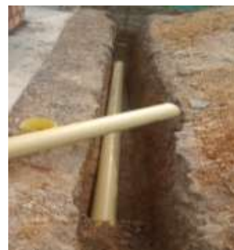
Fotografía 54. Ceramica piso antique Fotografía 55. Tubería PVC para aguas lluvias \phi:4
