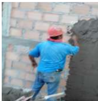
Fotografía 42. Pañete sobre muros liso
