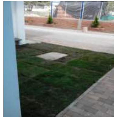
Fotografía 89. Suministro de prados.
