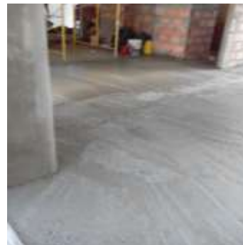
Fotografía 43. Alistado de piso en mortero
