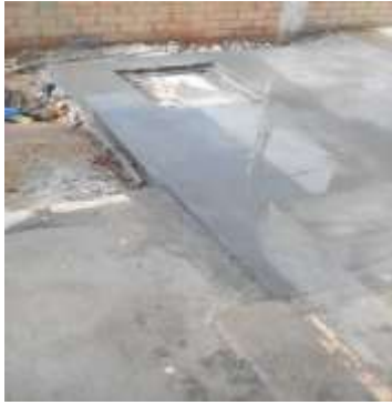
Fotografía 80. Vigas de cimentación.
