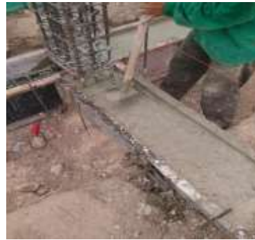
Fotografía 16. Vigas de cimentación 24.5 Mpa
