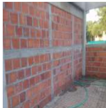
Fotografía 49. Elementos de confinamiento
