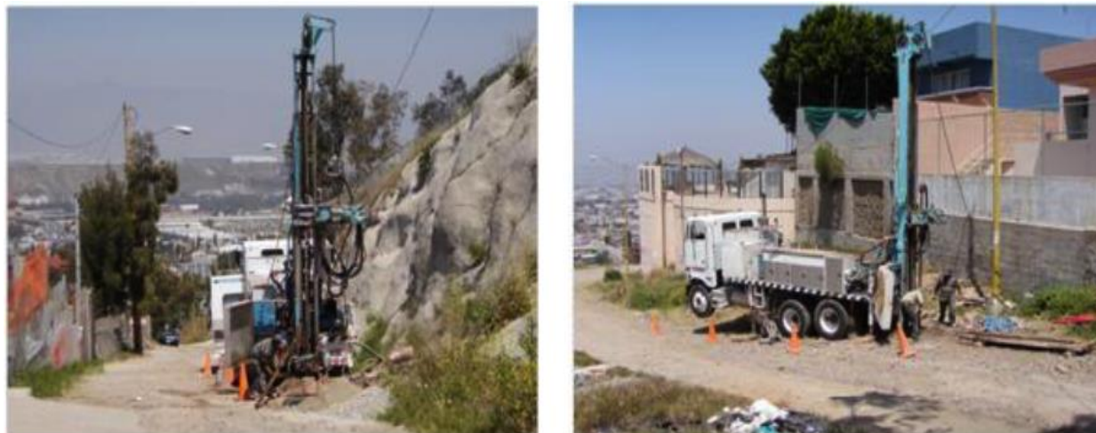
Figura 22. Ejecución de los sondeos en el Fraccionamiento Lomas Conjunto Residencial.
