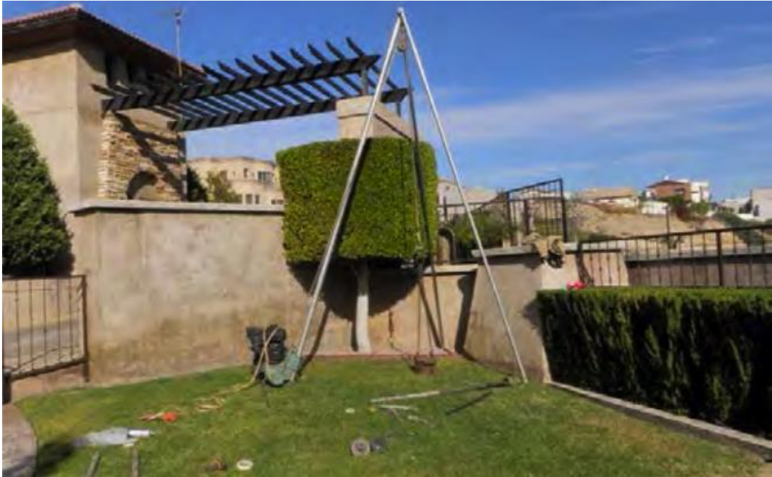
Figura 18. Ejecución del ensayo SPT en el proyecto N°1.
