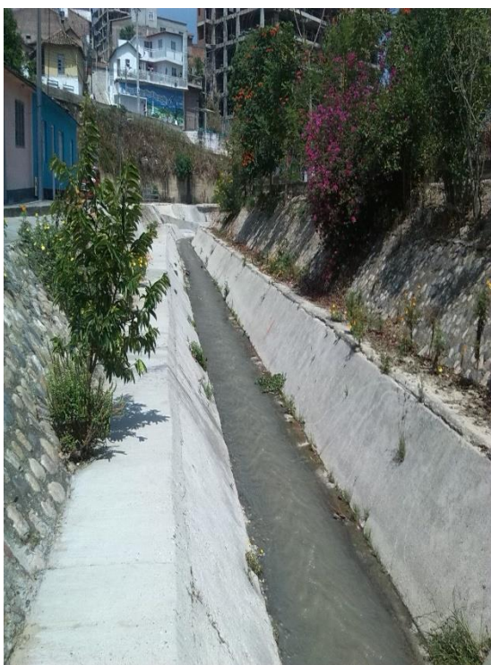
Figura 72. Buen estado de revestimiento del margen izquierdo
