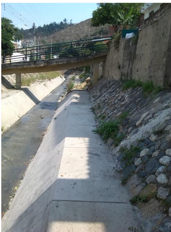
Figura 43. Revestimiento en buen estado del margen derecho.
