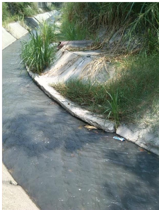
Figura 94. Separación en juntas.
