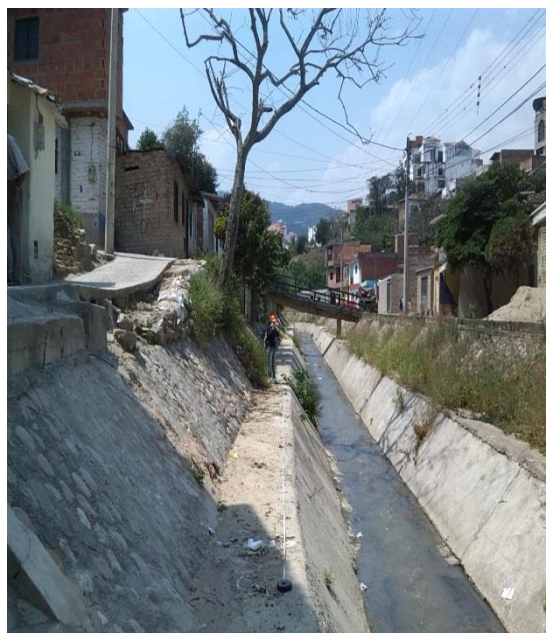
Figura 47. En este tramo se encuentran Viviendas aledañas al canal
