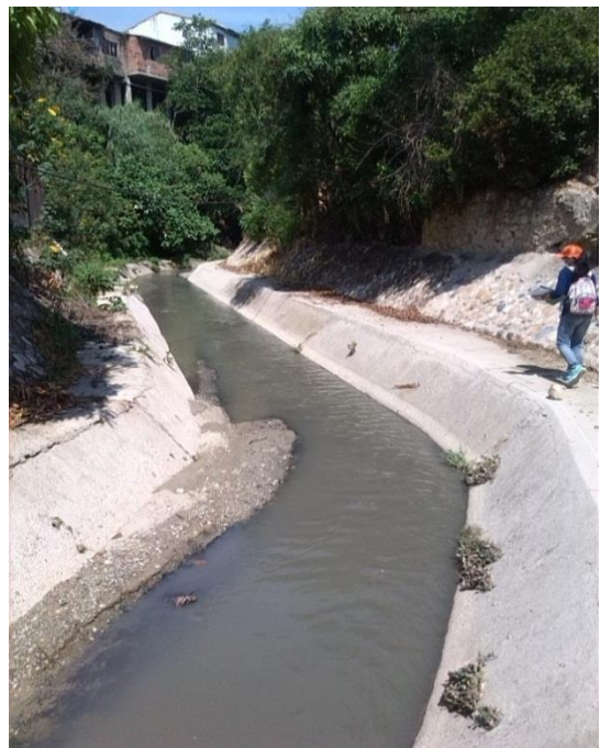
Figura 6. Sedimentación.
