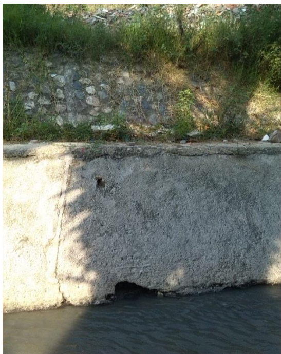
Figura 22. Socavación entre B y T1, desgaste de revestimiento, vegetación.
