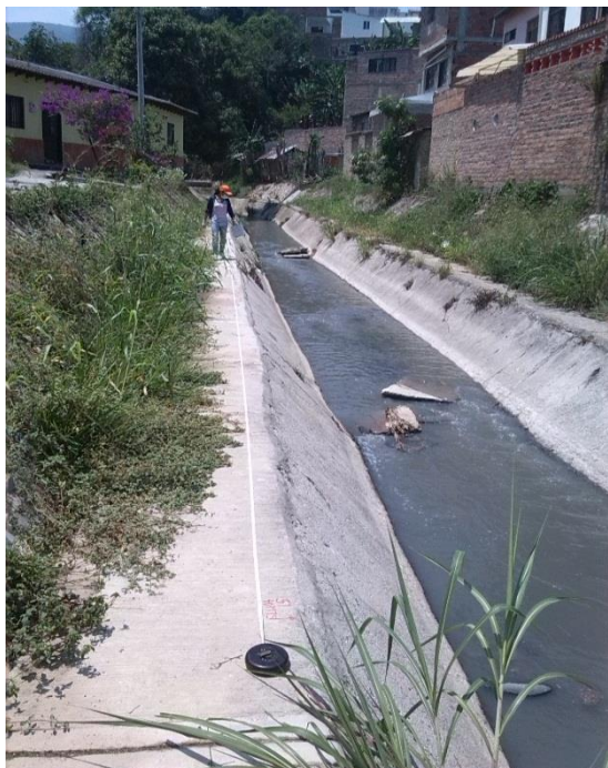
Figura 18. Vegetación, obstrucción en el canal.
