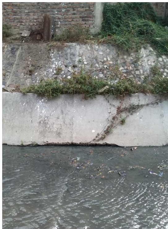
Figura 110. Socavación.
