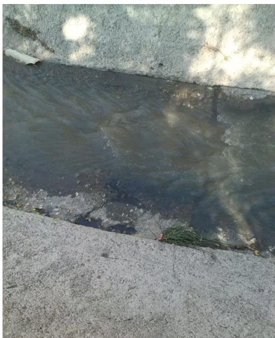
Figura 28. Desgaste de revestimiento de la base.
