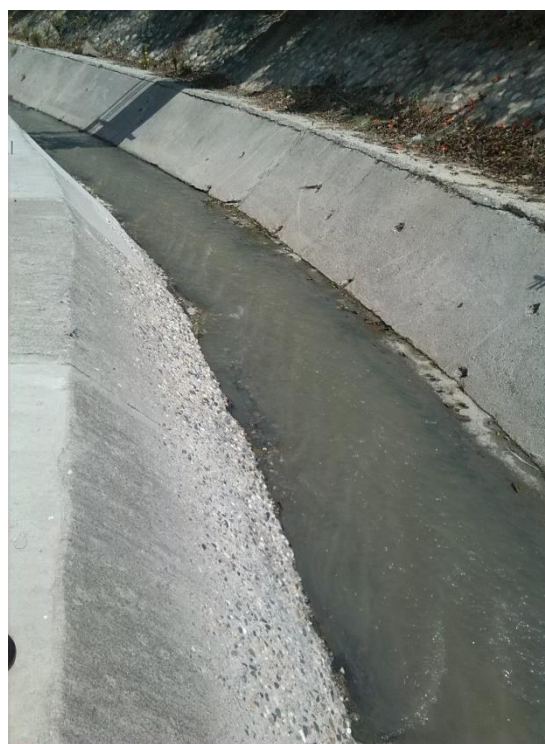
Figura 73. Desgaste en curva perteneciente al margen izquierdo.
