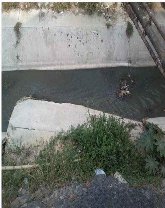
Figura 84.Desprendimiento de losa.
