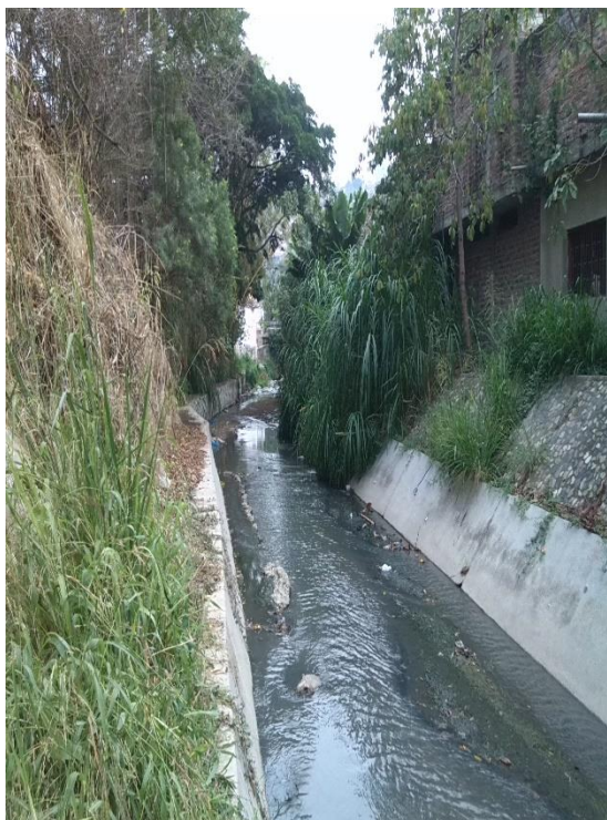
Figura 113. Sedimentación y vegetación.
