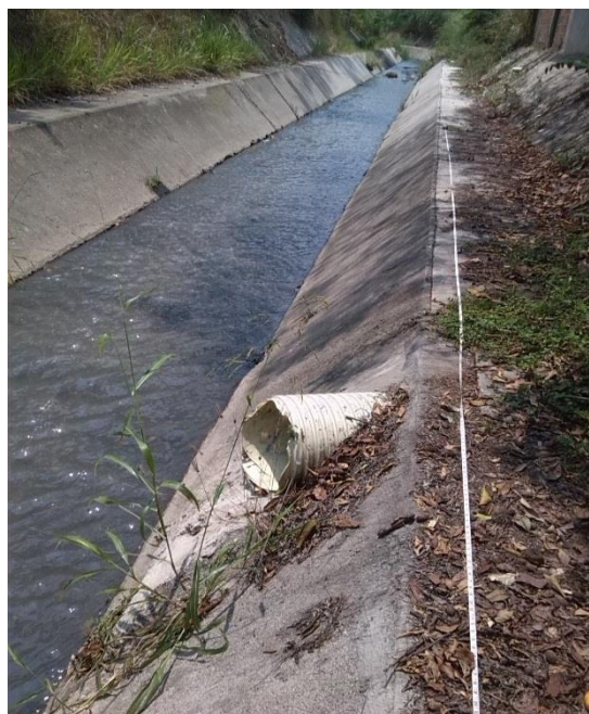
Figura 100. Conexión de tubería en PVC en T1 del margen izquierdo.
