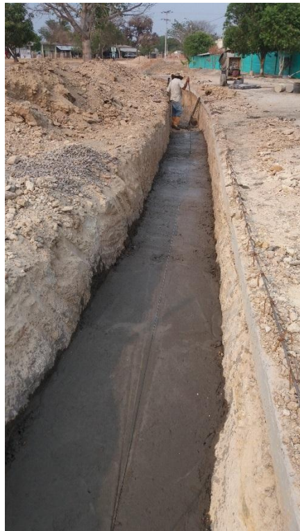
Foto 3. Solado de limpieza para losa inferior. Fuente: Autor
