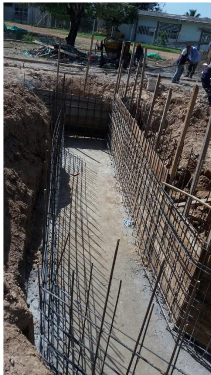
Foto 9. Fundida losa inferior y encofrado para losas laterales. Fuente: Autor
