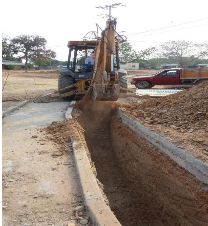
Foto 1. Excavación con maquinaria. Fuente: Autor
