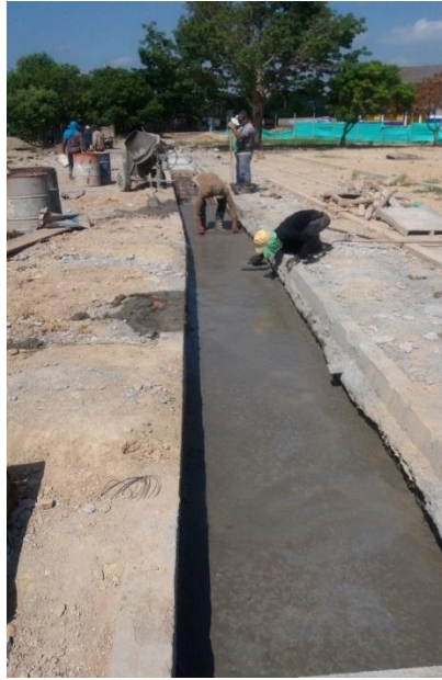
Foto 8. Fundida de losa superior. Fuente: Autor
