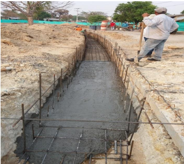
Foto 5. Fundida de losa inferior y superior. Fuente: Autor
