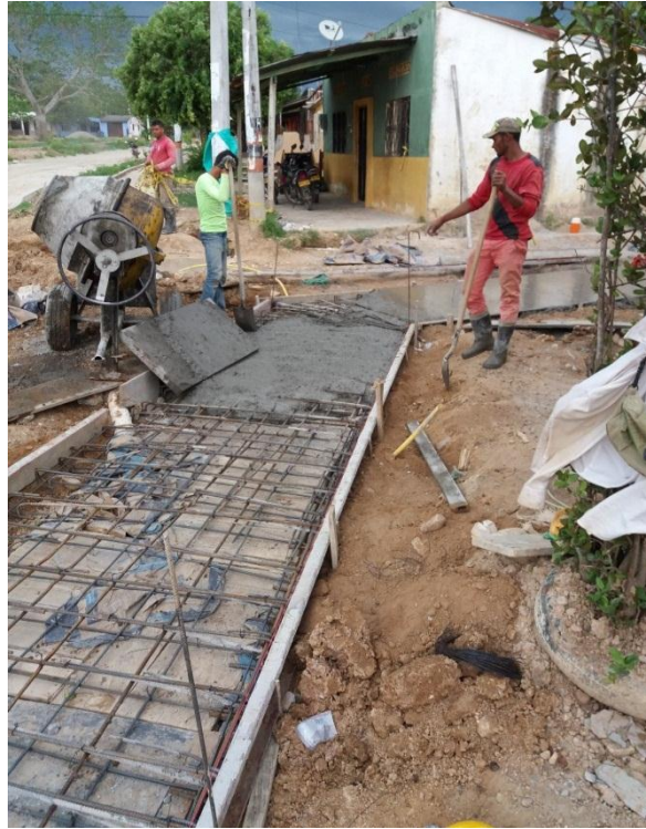
Foto 10. Fundida de losa superior del tramo final. Fuente: Autor
