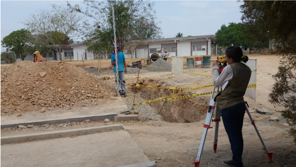
Foto 2. Toma de niveles. Fuente: Autor
