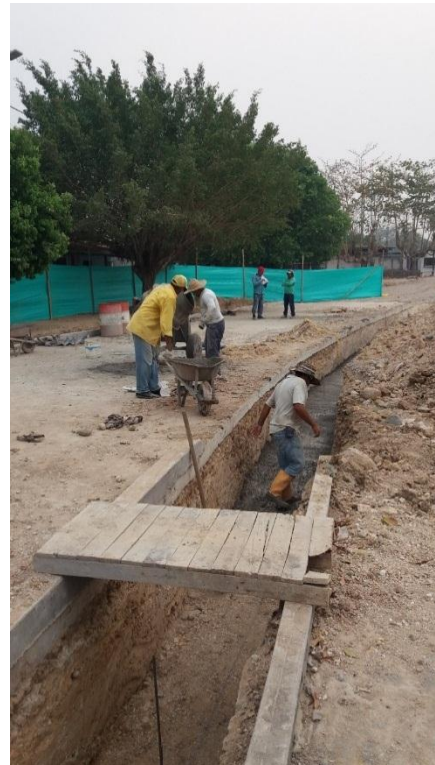
Foto 3. Solado de limpieza para losa inferior. Fuente: Autor
