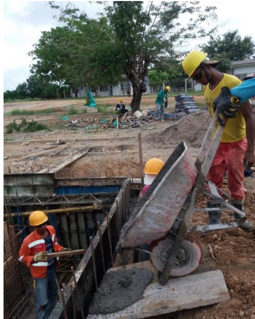
Foto 11. Fundida de losas superiores. Fuente: Autor
