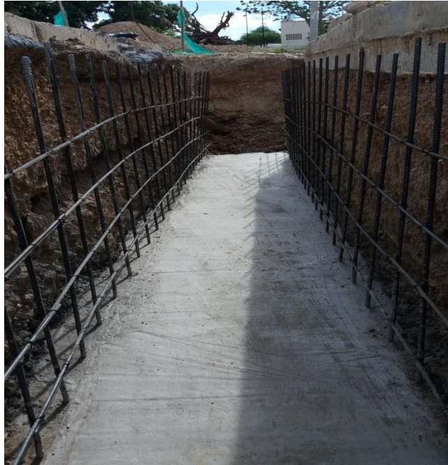
Foto 6. Losa inferior del box lateral. Fuente: Autor
