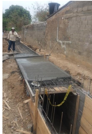
Foto 5. Fundida de losa inferior y superior. Fuente: Autor
