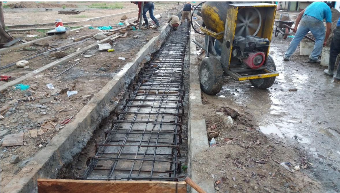
Foto 7. Encofrado y acero superior para el box coulvert lateral. Fuente: Autor
