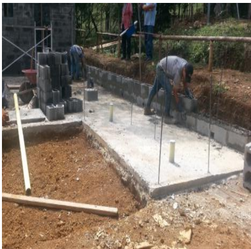
Fotografía 3. Elevación muro perimetral
