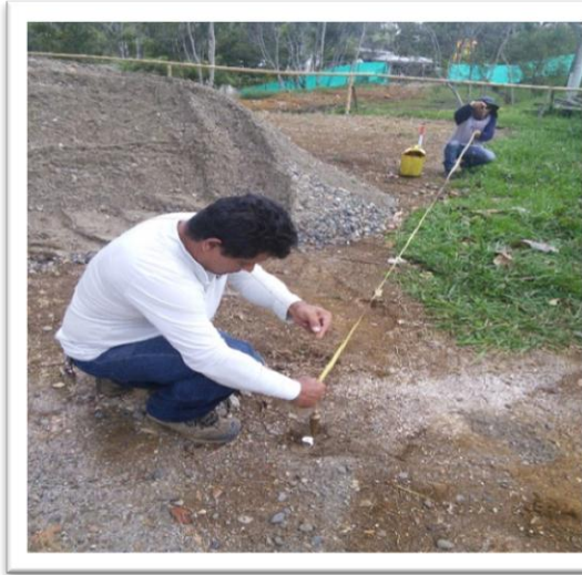
Fotografía 9. Localización y replanteo
