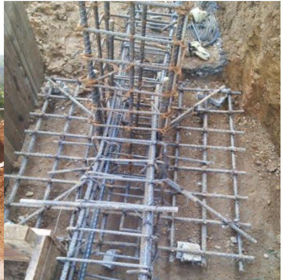
Fotografía 12. Acero zapatas y vigas
