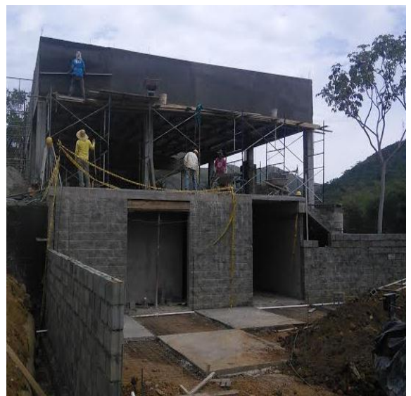
Fotografía 24. Fachada lateral piscina
