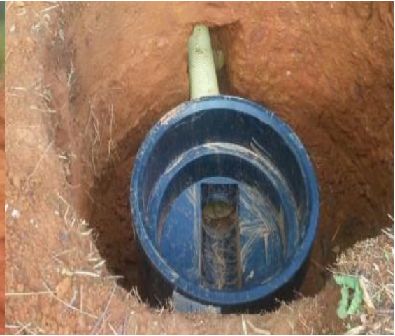
Fotografía 42. Cámaras inspección PVC
