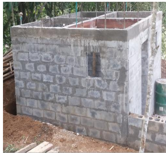
Fotografía 4. Mampostería cocineta y baños
