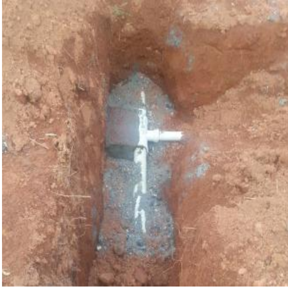
Fotografía 37. Anclajes de tubería
