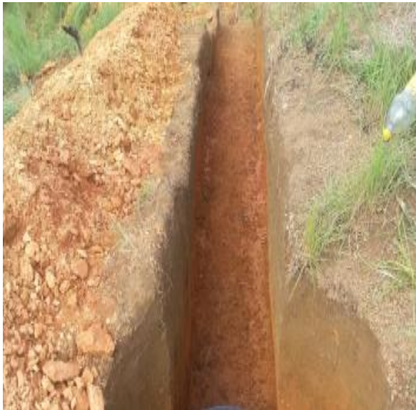
Fotografía 39. Excavación tubería 8"
