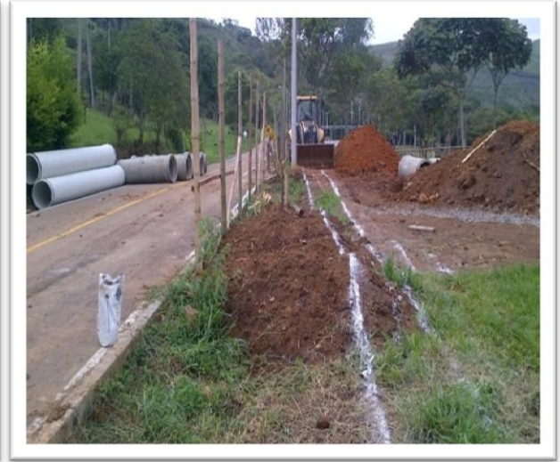
Fotografía 10. Localización y replanteo
