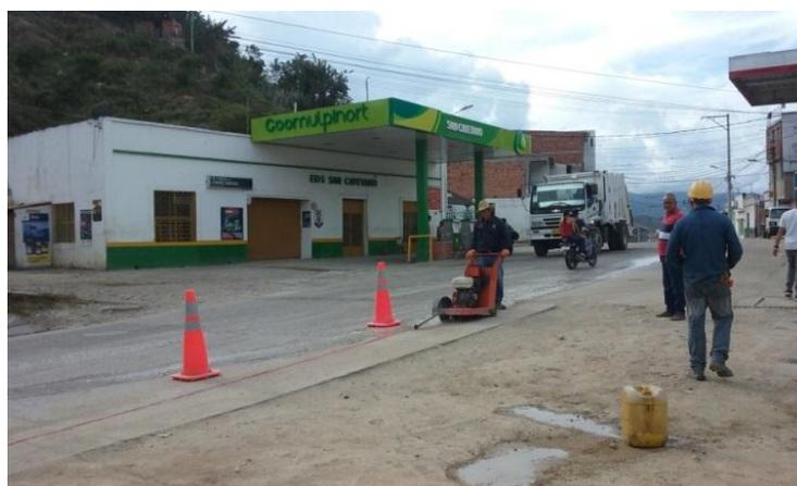
**Figura 16.** Corte de pavimento rígido existente,
