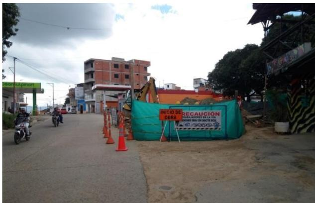
**Figura 11.** Elementos utilizados para la señalización de la obra.
