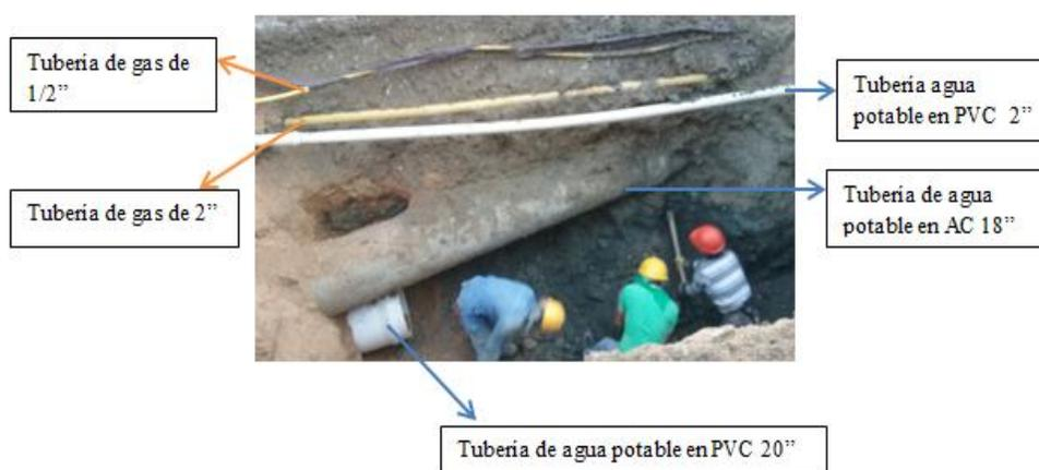
**Figura 19.** Excavación manual
