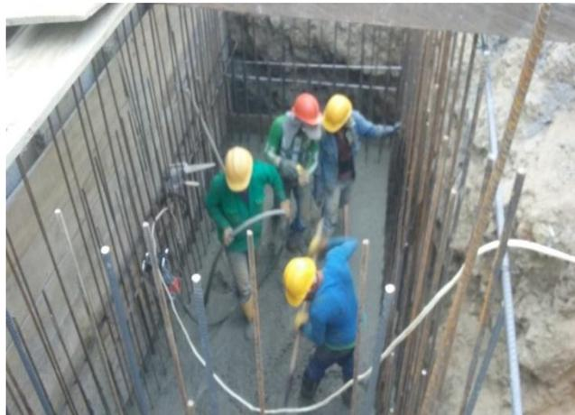
**Figura 10.** Vibrado del concreto para la losa inferior de una de las cajas.
