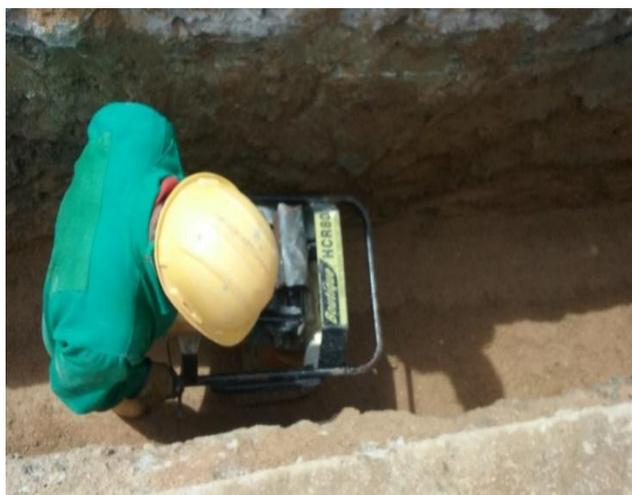
**Figura 22.** Compactación Cama en recebo para apoyo de tubería
