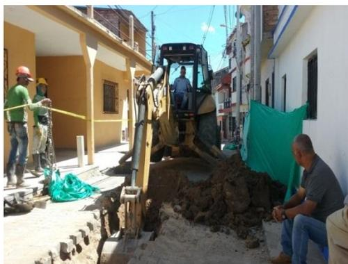
**Figura 18.** Excavación para la instalación de la red matriz en el Barrio la Palmita
