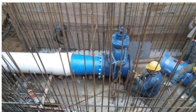
**Figura 27.** Instalación de la válvula de 18”.
