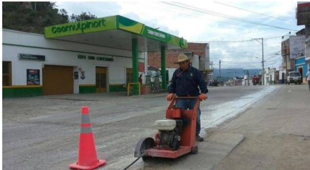
**Figura 7.** Cortadora de pavimento
