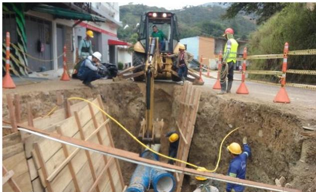
**Figura 4.** Retro excavadora realizando el movimiento de la Yee de 20” a 16”
