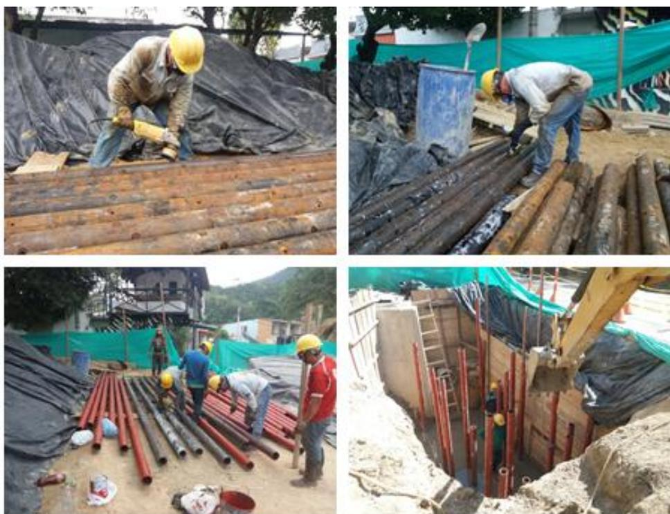
**Figura 43** .Limpieza, desoxidación, cubrimiento con anticorrosivo e hincado de Micro pilotes.
