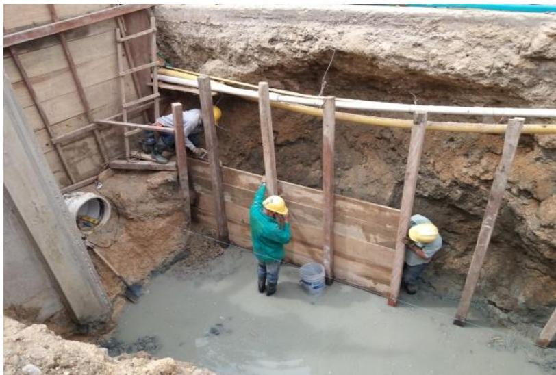
Figura 42. Entibado para estabilización de talud lateral
