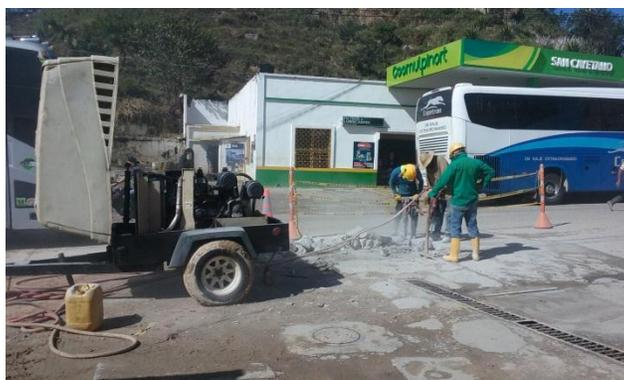
**Figura 17.** Demolición de pavimento rígido
