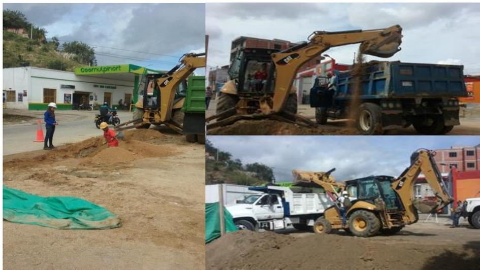
Figura 25. Cargue y retiro de material de excavación
