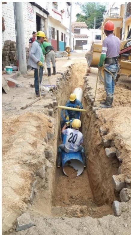
**Figura 36.** Instalación accesorio de 8°
