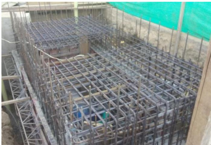
**Figura 41.** Acero de refuerzo de la caja N° 2
