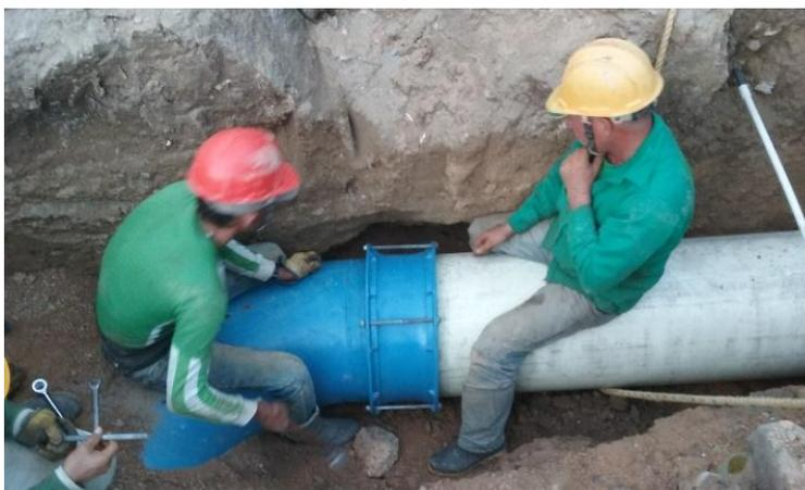
**Figura 35.** Instalación Unión dresser.
