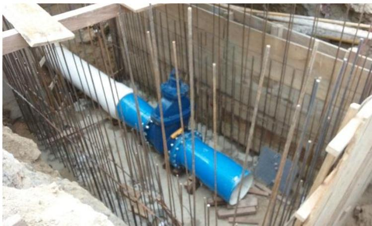
**Figura 32.** Válvula y reducciones de 20" a 18".
