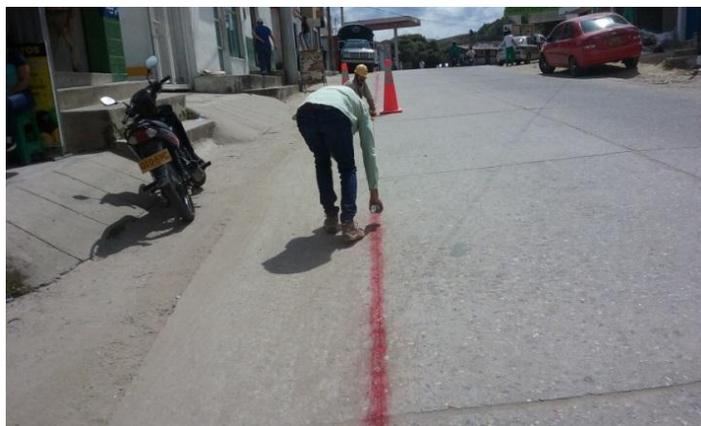
**Figura 15.** Demarcación de la línea de corte del pavimento
