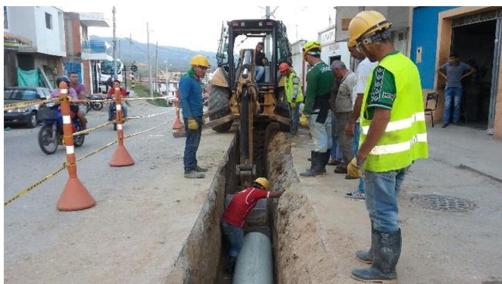
Figura 26. Instalación de tubería de acueducto PVC 20”
