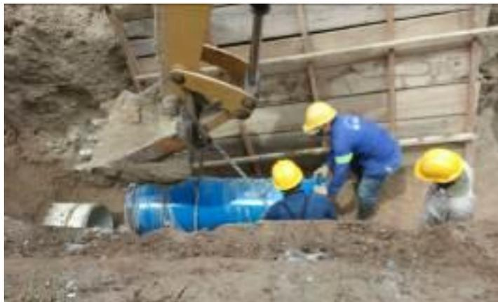
**Figura 29.** Instalación accesoria con ángulo de 5°.
