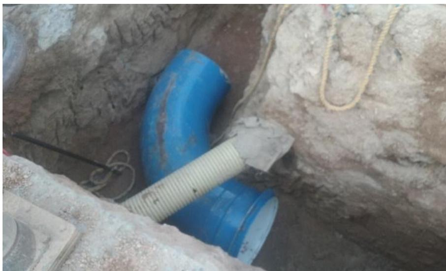
**Figura 31.** Instalación de codo de 90°
