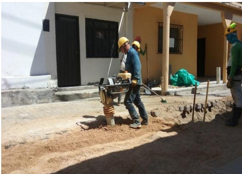
**Figura 23.** Relleno y compactación de excavaciones.
