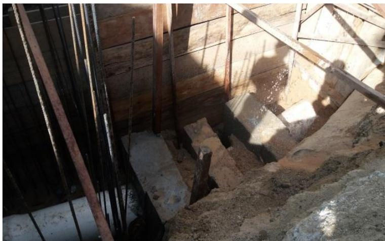
**Figura 37.** Atraques para tubería de PVC 20" y accesorio de 11,25°
