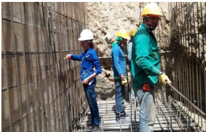
**Figura 40** .Medida de la separación del refuerzo longitudinal.
