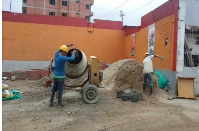
**Figura 9.** Preparación de la mezcla de concreto en obra.
