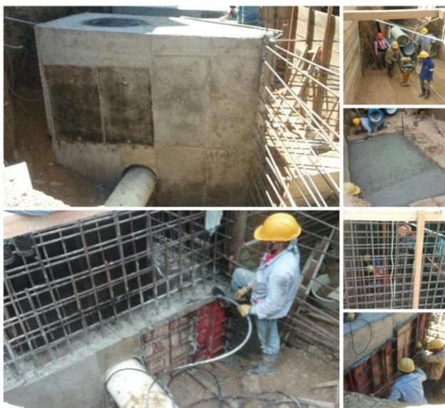
**Figura 39** Proceso constructivo de la caja para válvula de 16"
