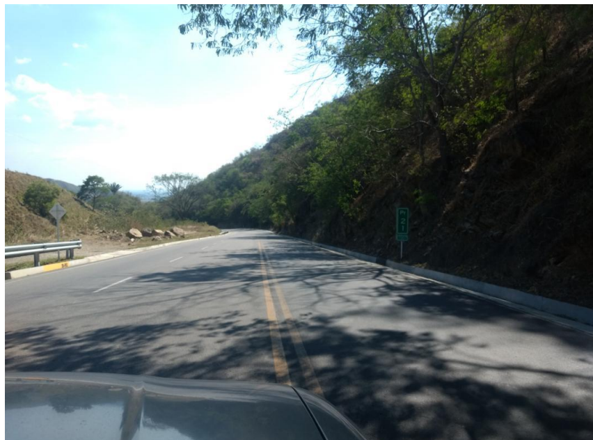
Figura 22. Reconocimiento en la ruta 7007, PR 21+000.
