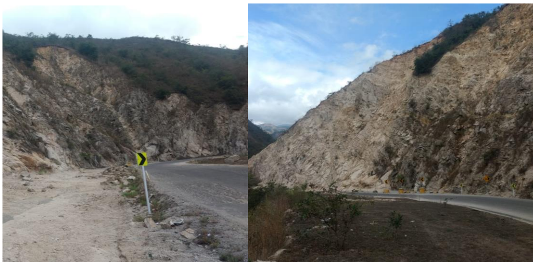
Figura 23. Reconocimiento en la ruta 7008, PR 11+500.
