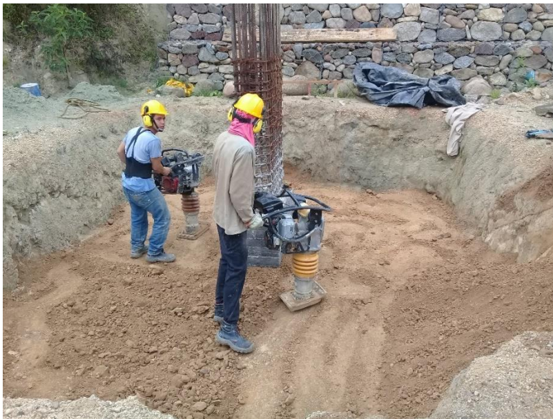
Figura 47. Uso de vibro-compactador tipo canguro.
