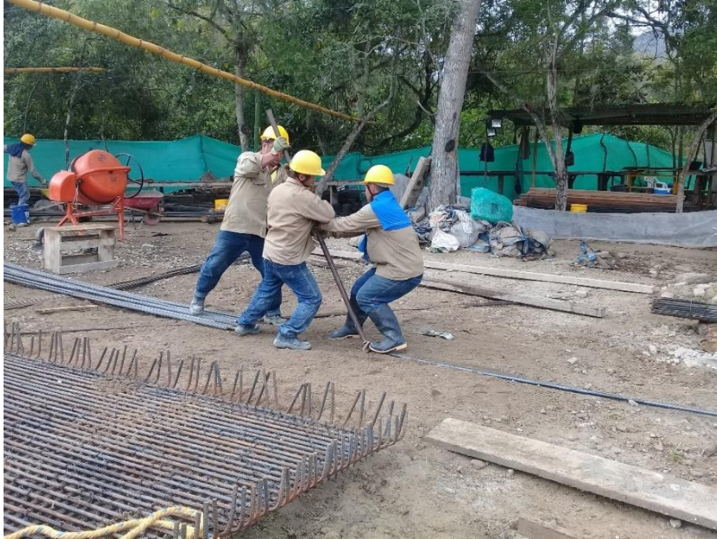
Figura 36. Doblado de acero de refuerzo.
