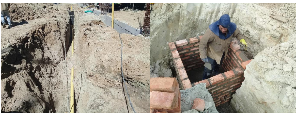
Figura 15. Instalación de tubería y caja de inspección.
