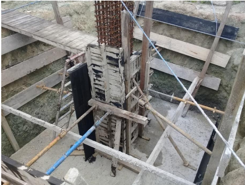
Figura 34. Encofrado de pedestal.
