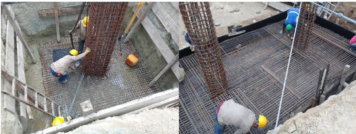
Figura 6. Colocación acero de zapata.
