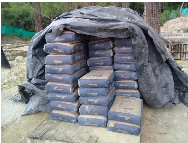
Figura 27. Almacenamiento del cemento.
