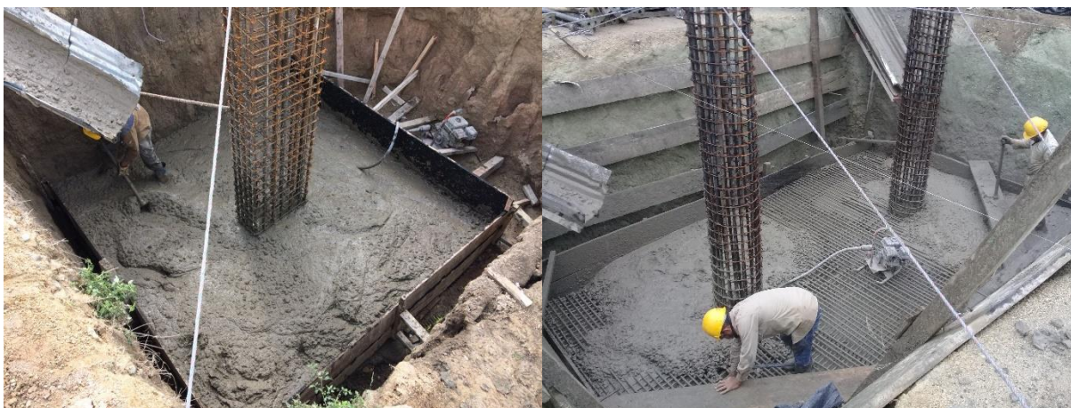
Figura 8. Fundición de zapatas.
