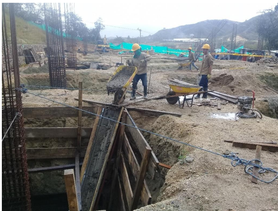
Figura 31. Transporte del concreto con carretillas.
