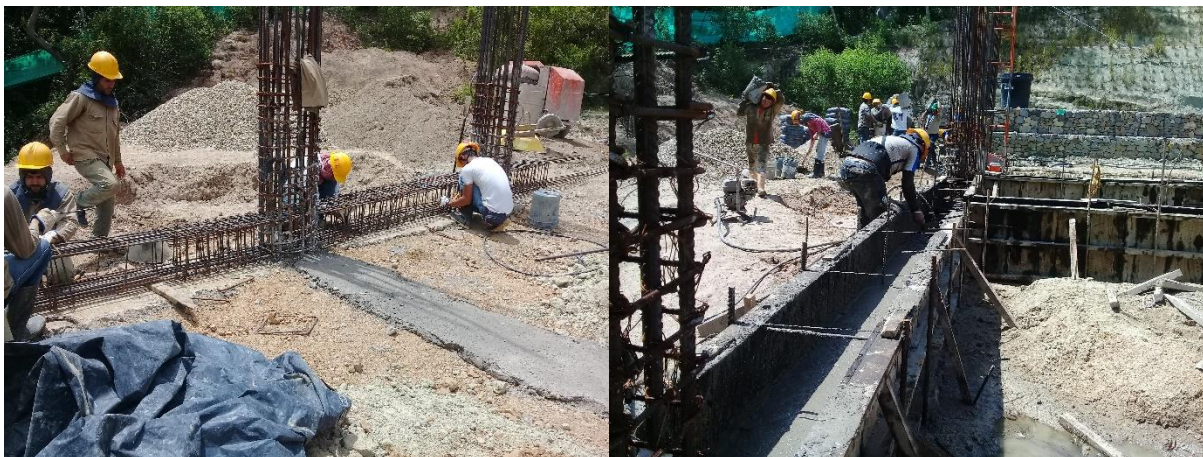
Figura 18. Armado de acero, encofrado y fundición de viga de amarre.
