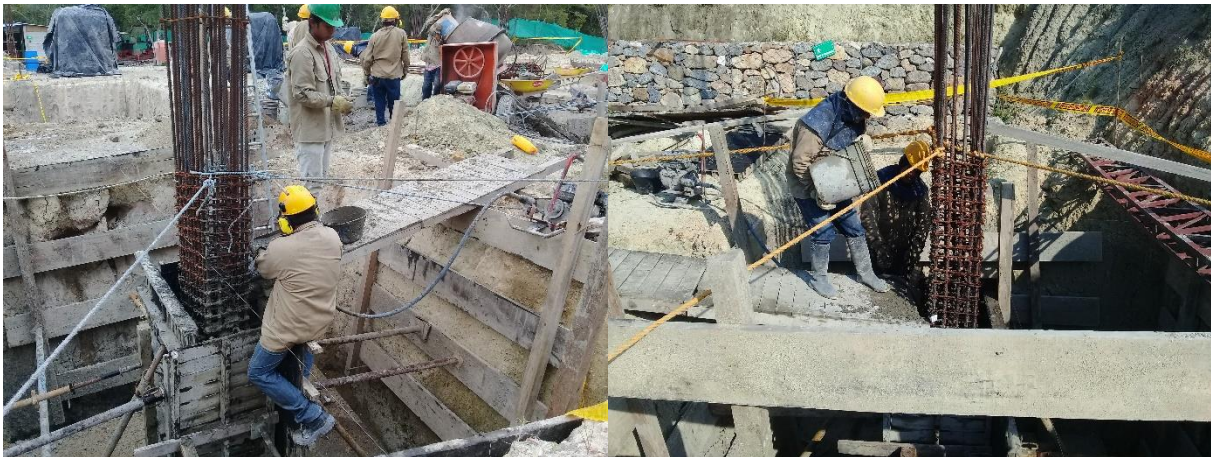
Figura 10. Fundición de pedestal.
