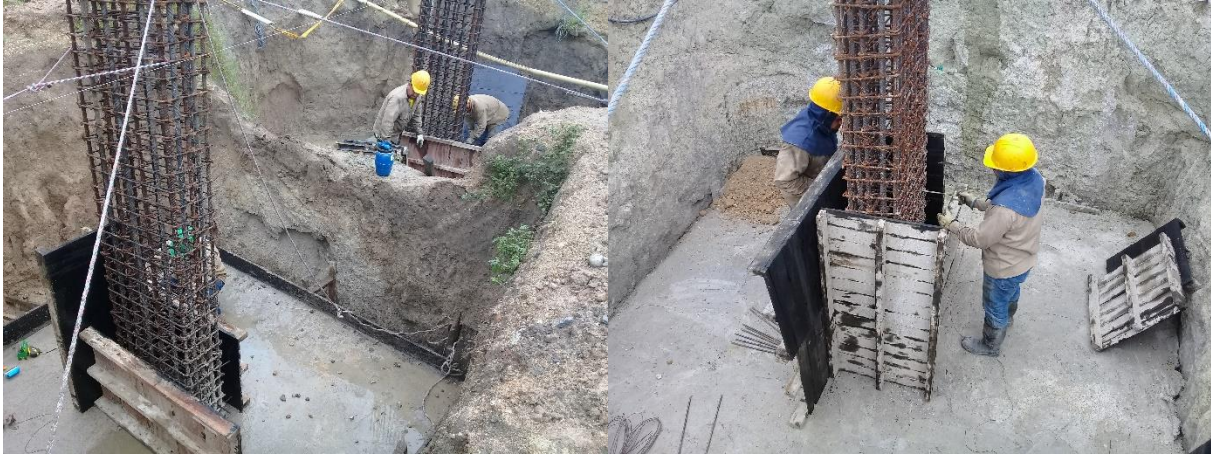
Figura 9. Encofrado de pedestal.
