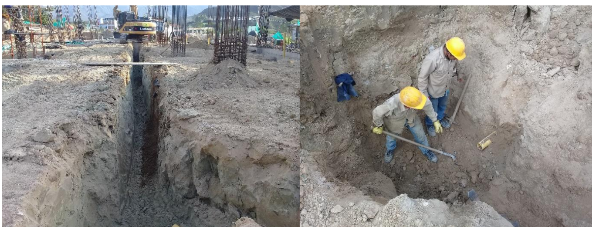
Figura 14. Excavación para tubería y cajas de inspección.
