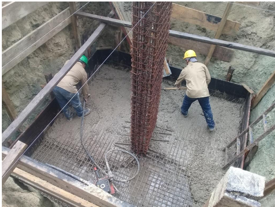
Figura 32. Uso de vibrador en colocación del concreto.
