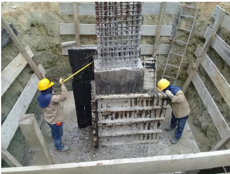
Figura 35. Retiro de paneles de madera.
