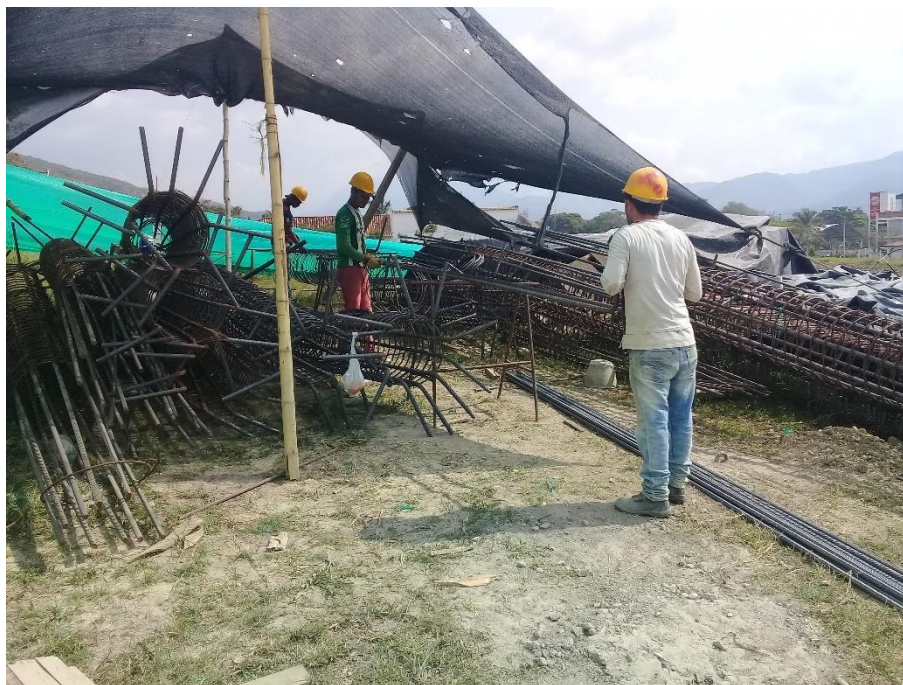
Figura 38. Amarre de acero en zona de acopio.
