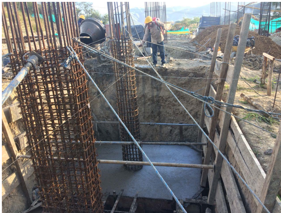
Figura 33. Aplicación de Antisol para curado del concreto.
