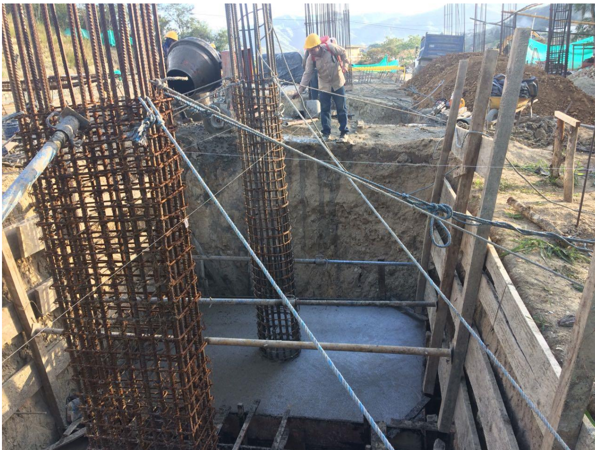
Figura 11. Aplicación de Antisol.
