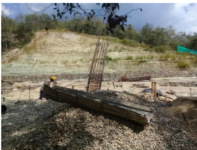
Figura 28. Almacenamiento de agregados.
