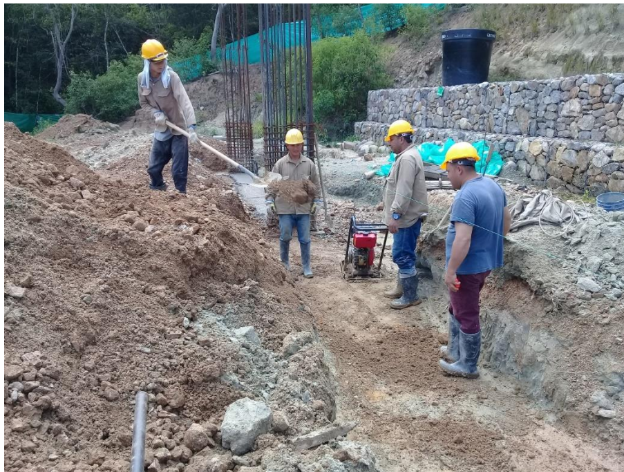
Figura 13. Preparación de terreno para viga de amarre.
