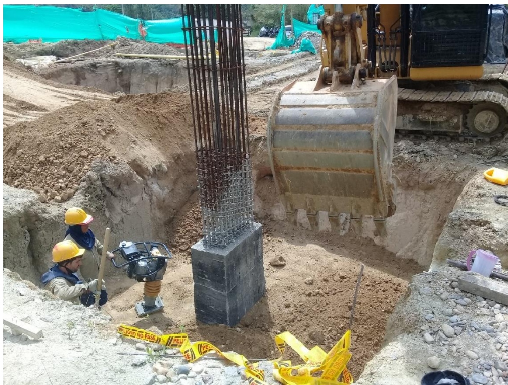
Figura 12. Relleno y compactación de excavaciones.
