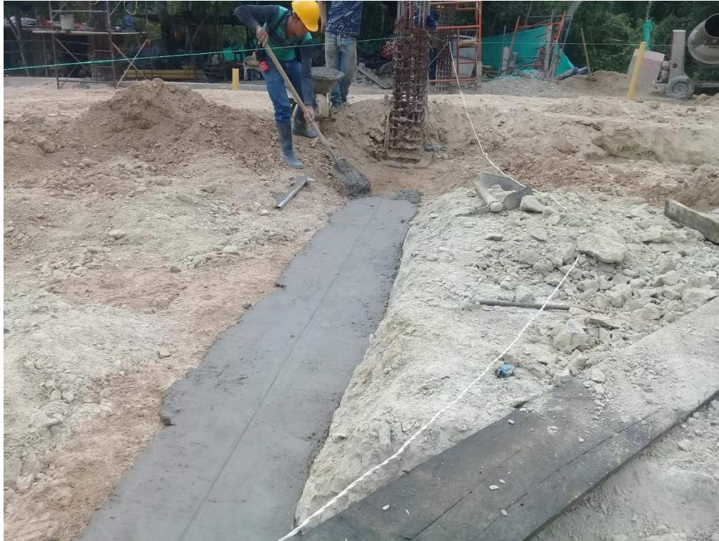
Figura 17. Colocación de base de concreto simple.
