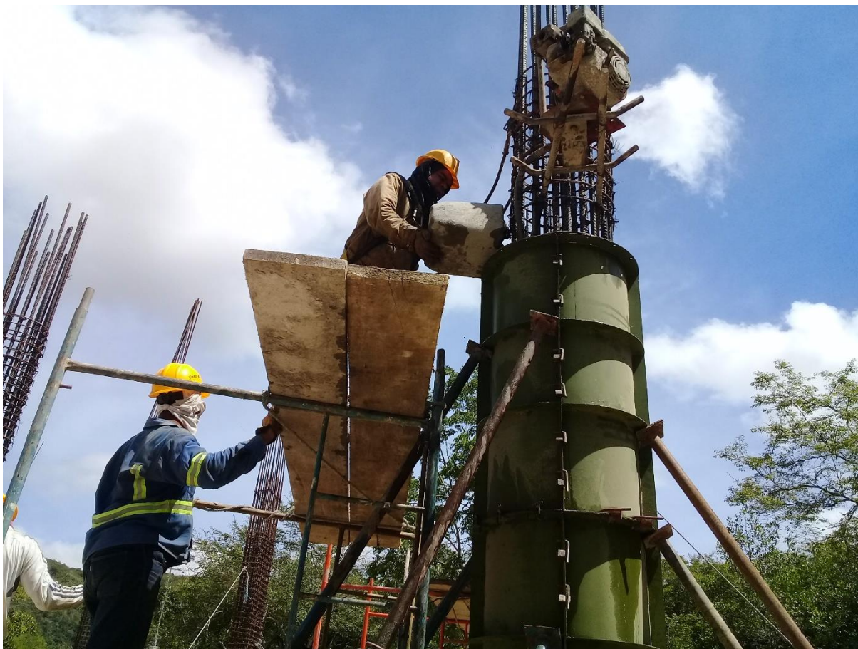
Figura 21. Fundición de columna.
