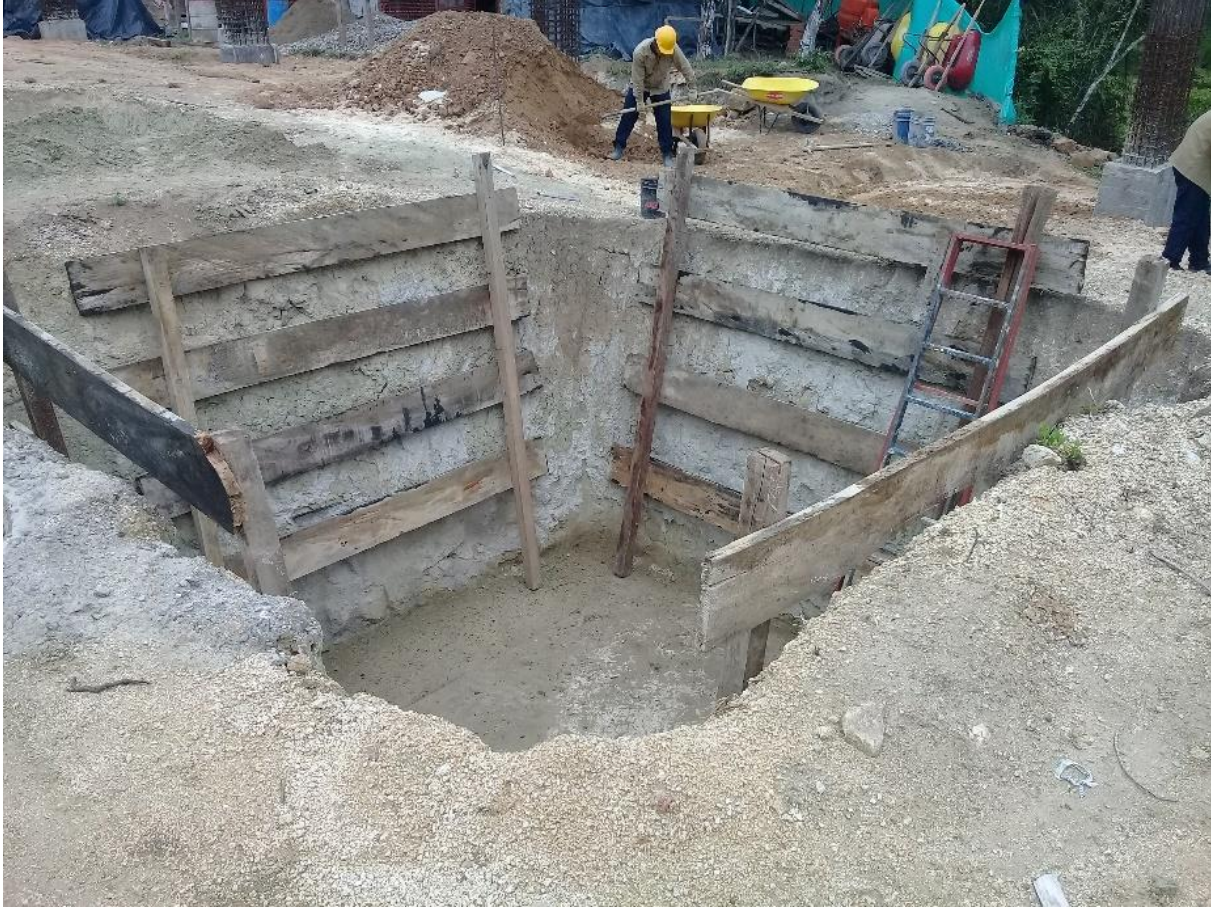
Figura 2. Entibado de excavación.
