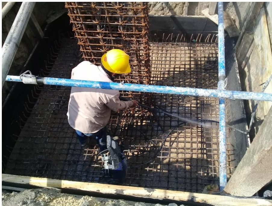
Figura 37. Limpieza de acero con Hidrolavadora.
