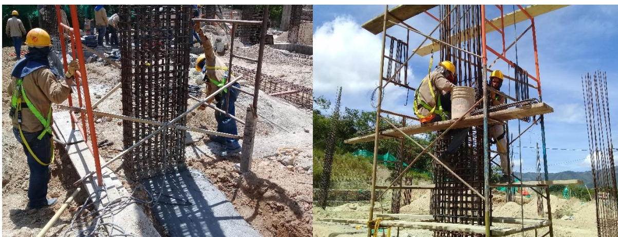
Figura 20. Armado de acero de columna sobre andamios.
