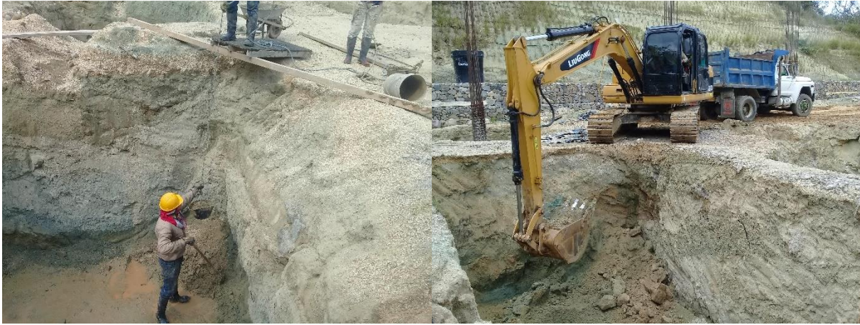
Figura 3. Retiro de material de la excavación.
