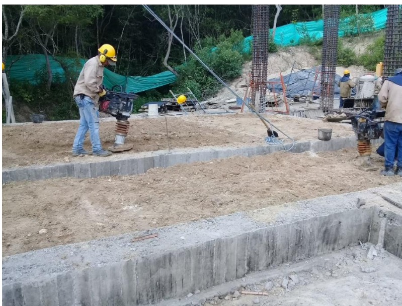
Figura 19. Nivelación del terreno a nivel de viga.
