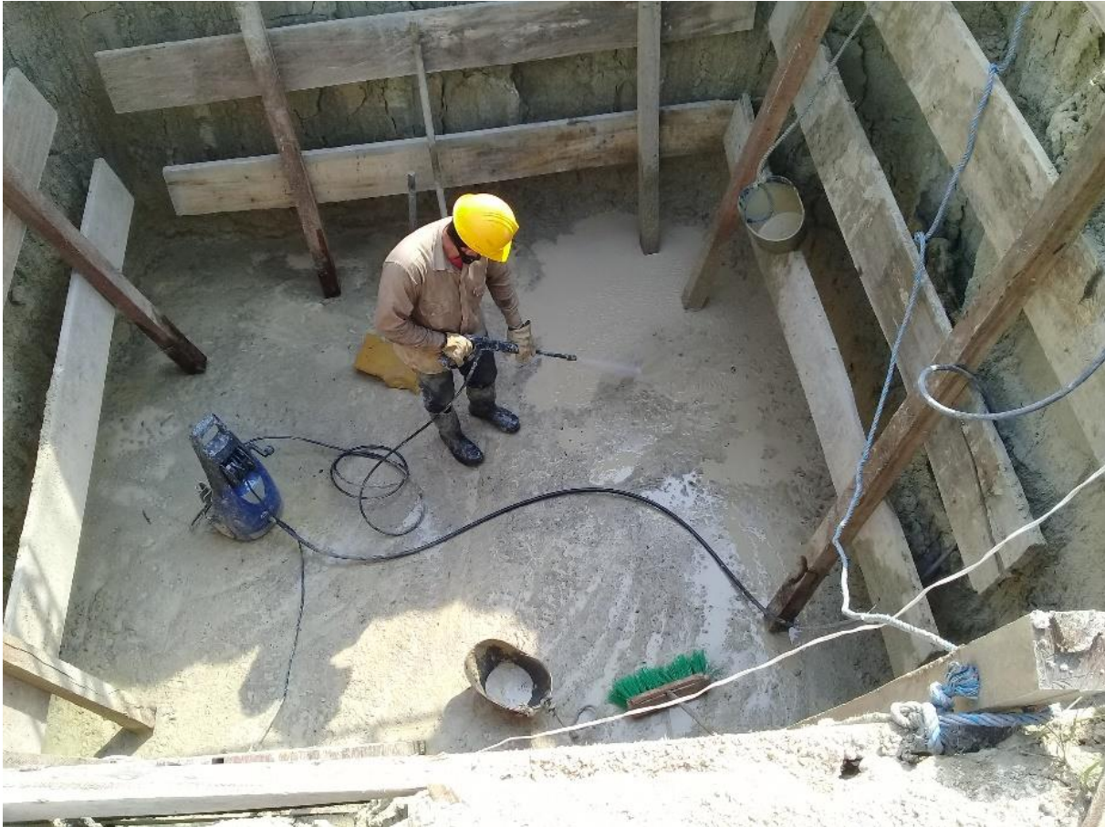
Figura 5. Limpieza con Hidrolavadora.
