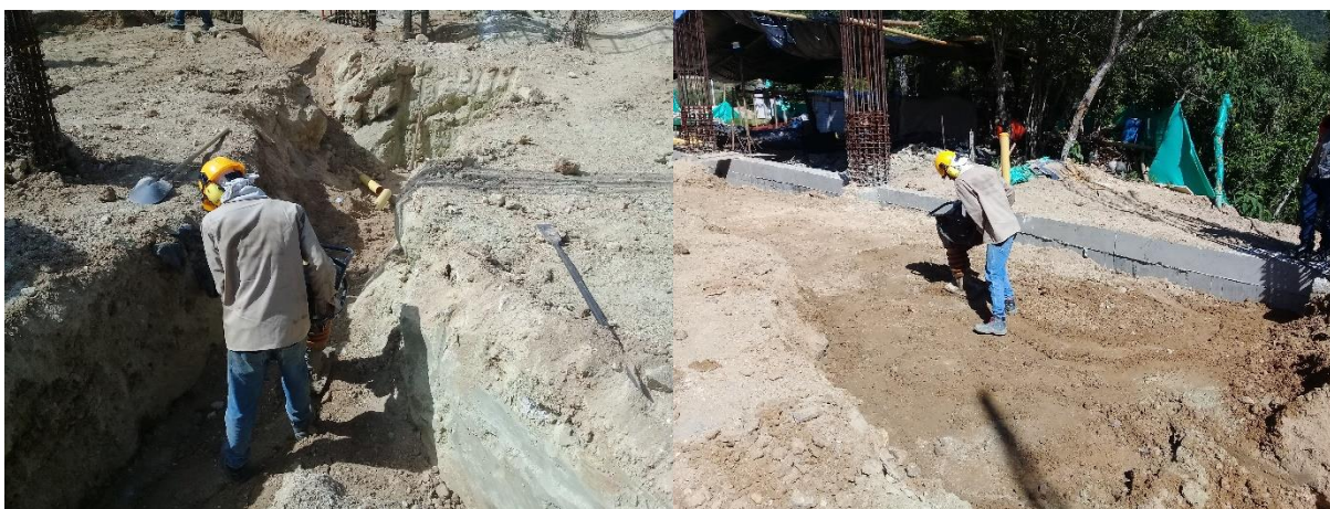
Figura 16. Relleno excavaciones de tubería y caja de inspección.
