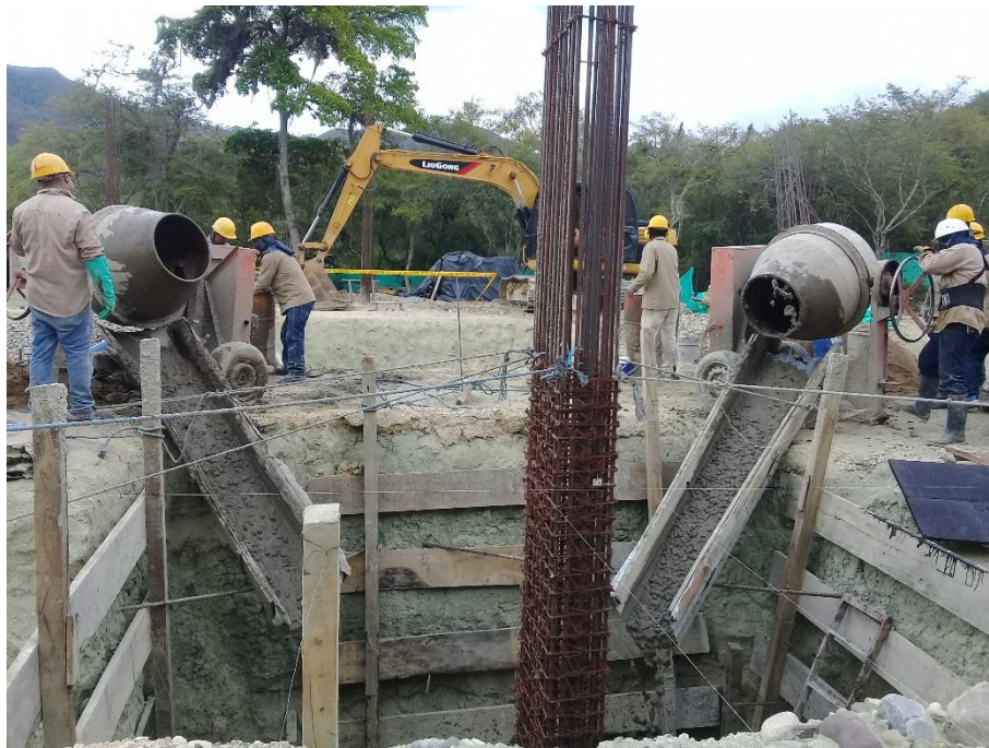
Figura 30. Vaciado de concreto utilizando dos mezcladoras.
