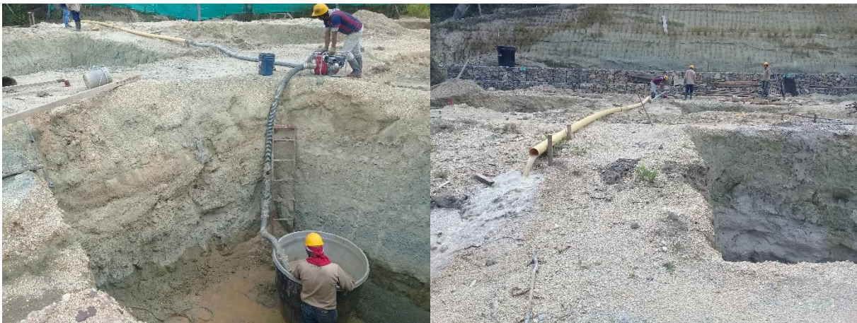
Figura 4. Extracción de agua de la excavación.
