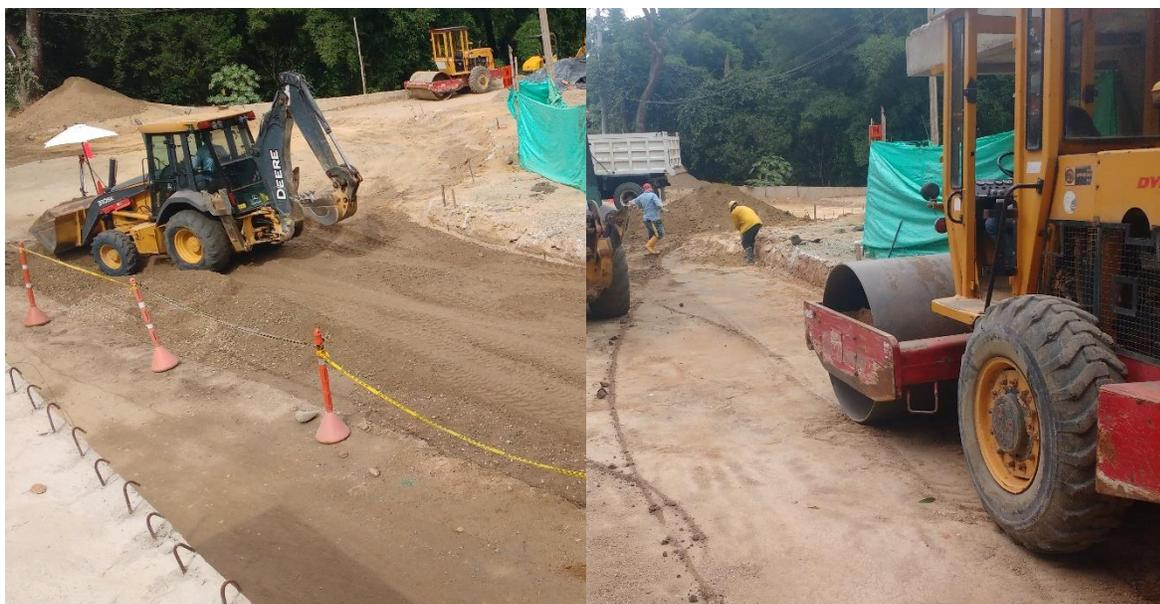
Figura 8. Colocación de material granular y compactación.
