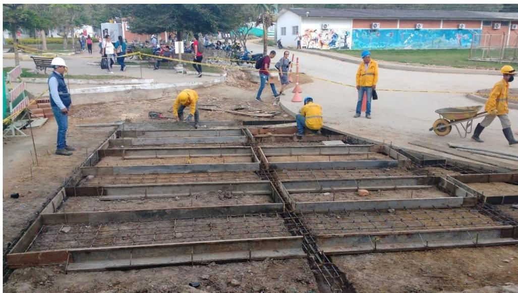
Figura 6. Construcción placa huella de empalme redoma interna.
