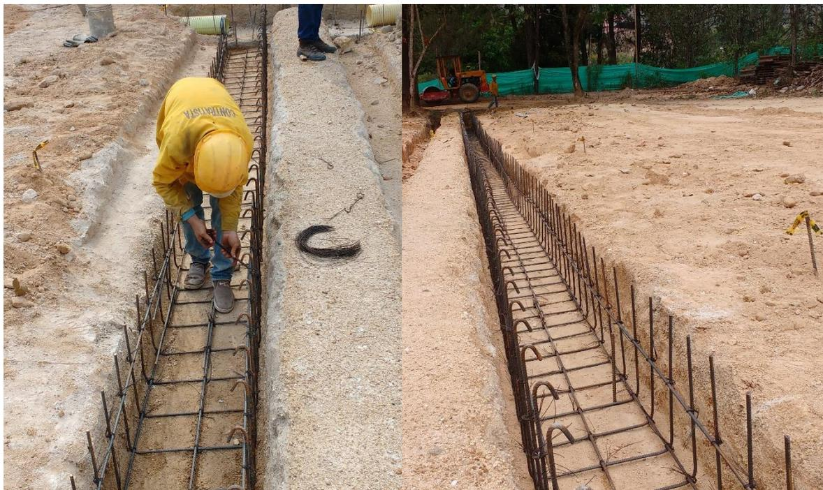
Figura 13. Detalle del armado de acero, y refuerzo ya terminado.
