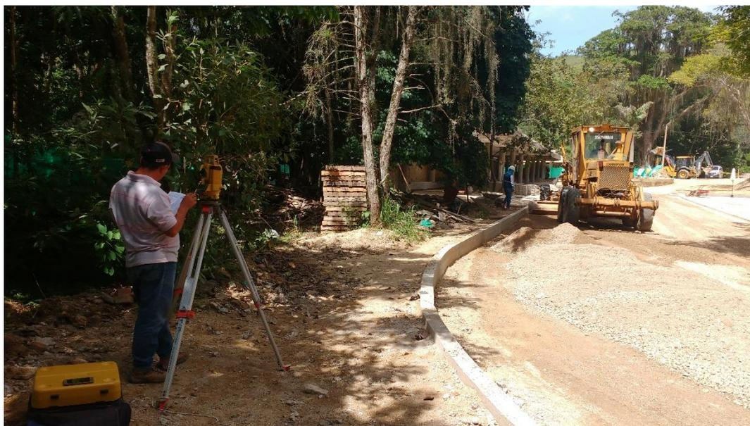
Figura 7. Colocación de base granular en vía de retorno.
