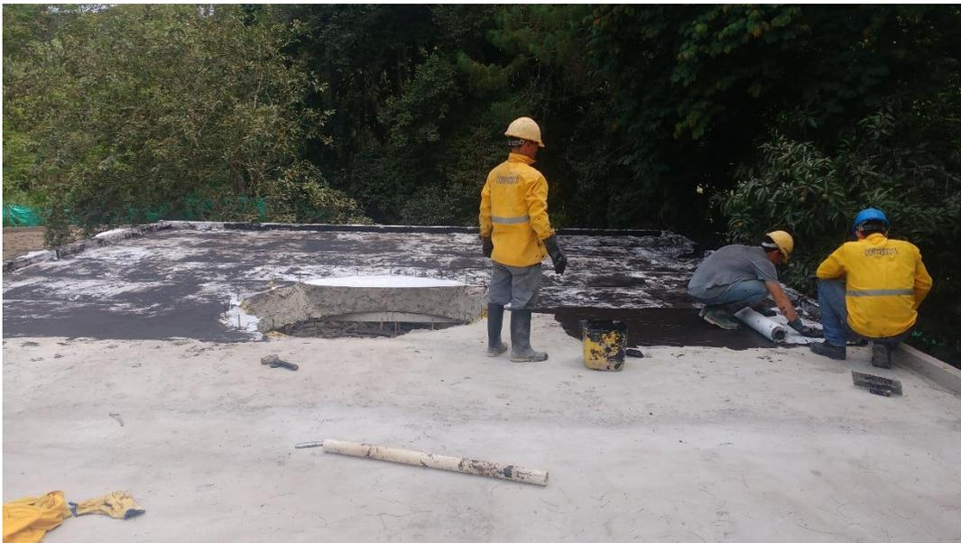
Figura 20. Impermeabilización con aditivo bituminoso.
