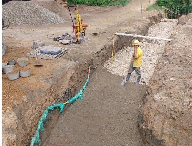
Figura 9. Secciones excavadas para cimentación de muro "Mi Bohío"
