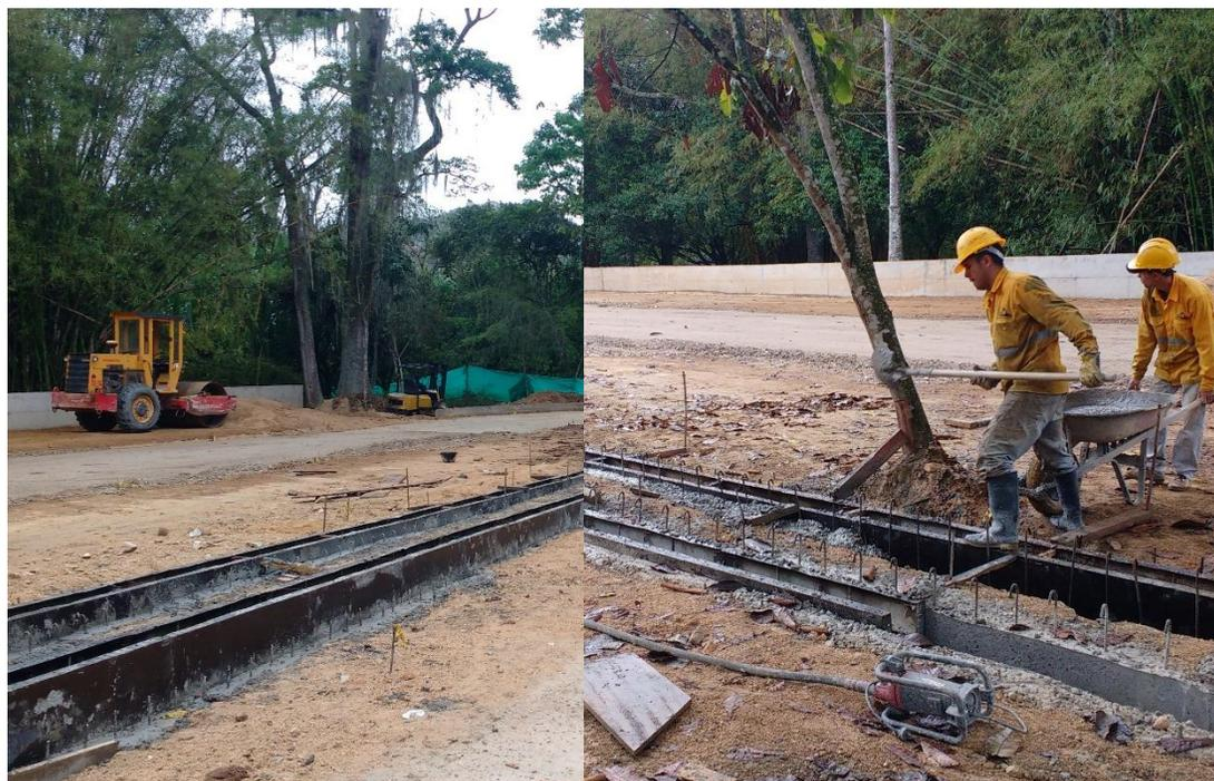
Figura 14. Colocación de formaleta y vaciado de concreto.
