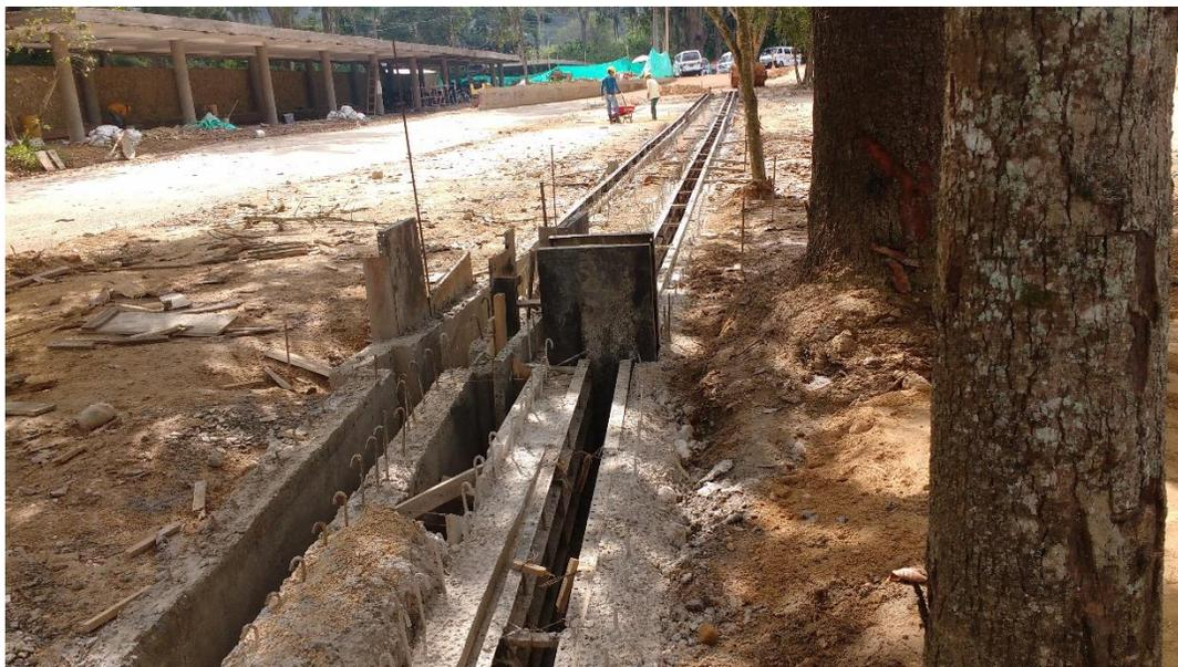
Figura 15. Desencofrado y curado del concreto.
