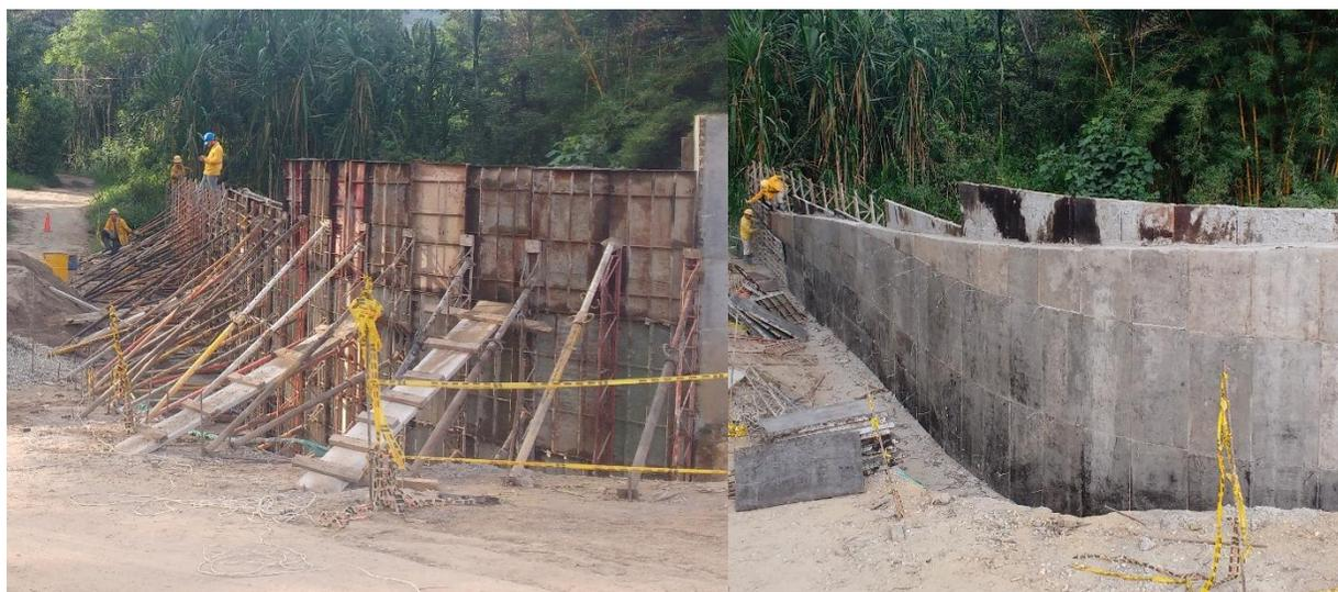
Figura 11. Formaleta armada y muro terminado.
