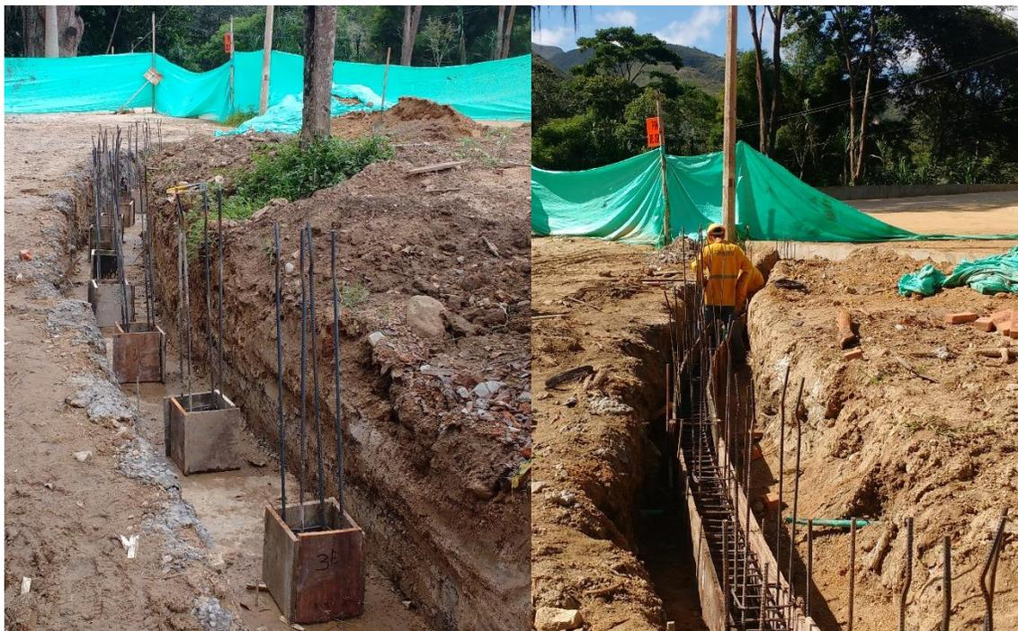
Figura 16. Cimentación del muro.
