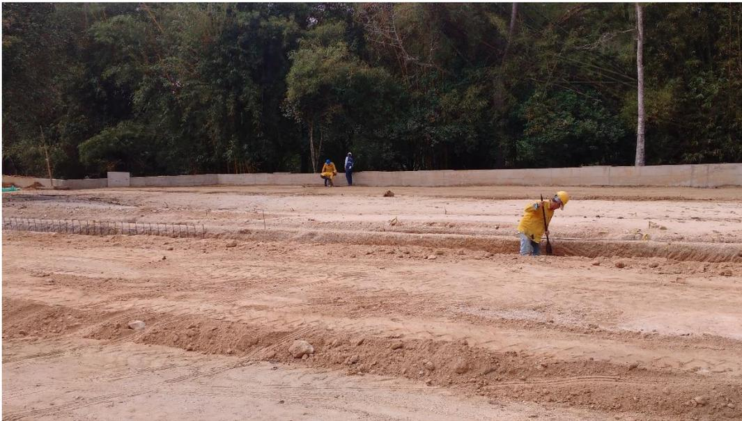
Figura 12. Excavación manual para construcción de canales.
