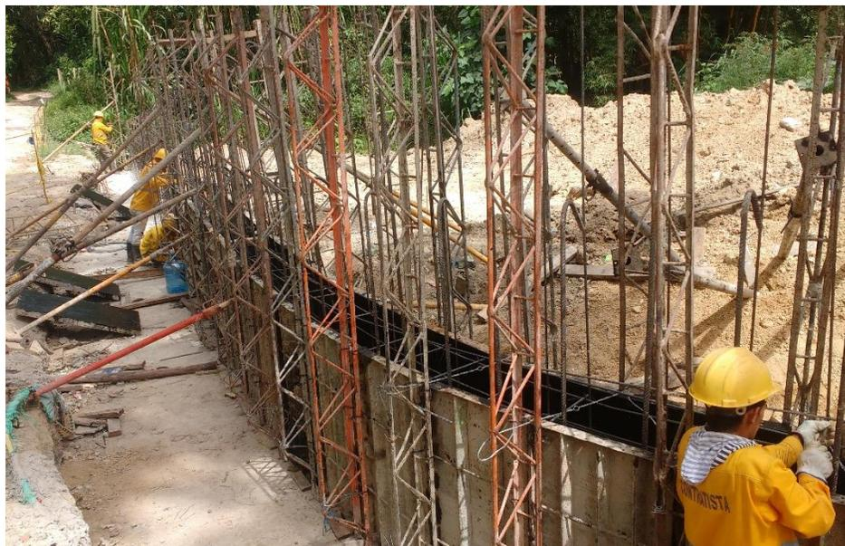
Figura 10. Armadura de acero y formaleteado.
