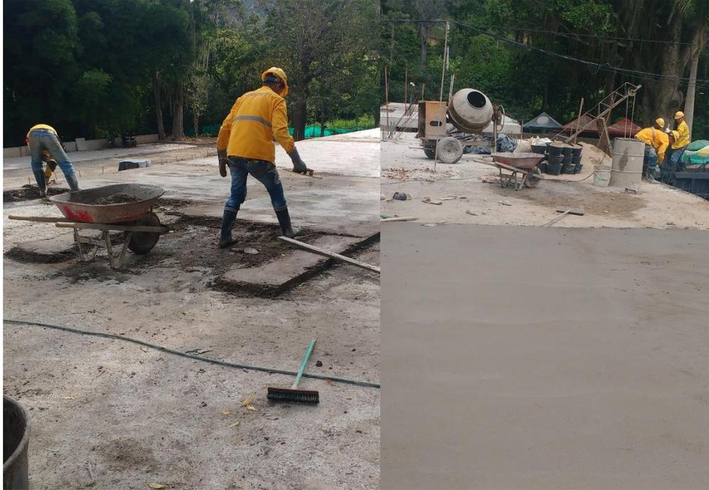
Figura 19. Mortero impermeabilizado sobre losas.
