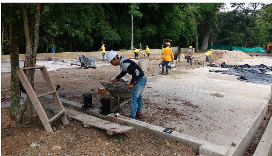
Figura 23. Toma de muestras de concreto por parte de la supervisión.
