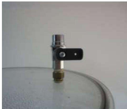
Figura 106. Válvula para el paso de aire del tanque de agua
