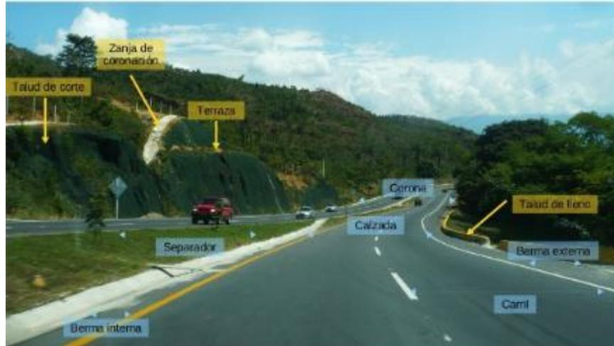
Figura 2. Sección típica de un pavimento flexible
