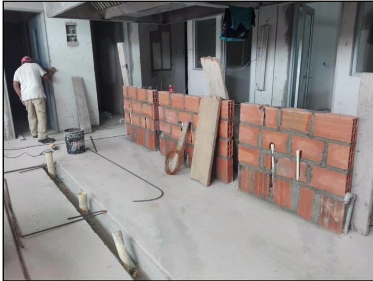
Figura 27. Construcción de carcamos en el area de cocina, y muro de soporte para meson de cocina. Fuente: Autor de la pasantía.
