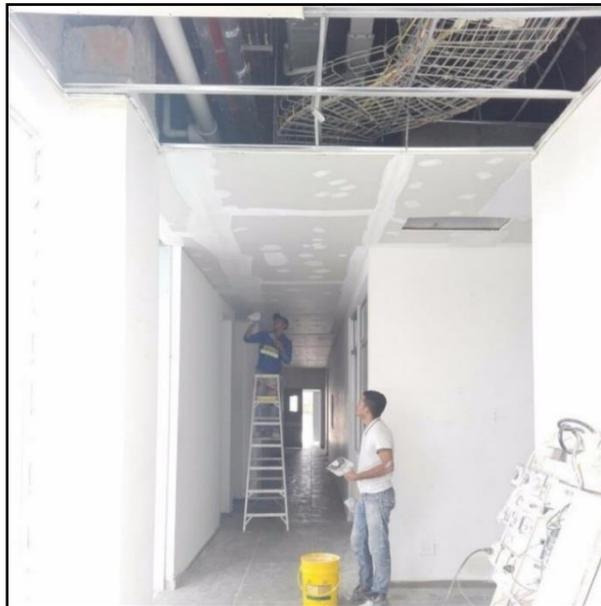
Figura 6. Instalación de drawall y pintura. Fuente: Autor de la pasatia.
