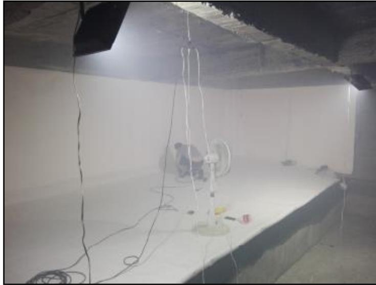
Figura 3. Impermeabilización de tanque de agua potable. Fuente: Autor de la pasantía.
