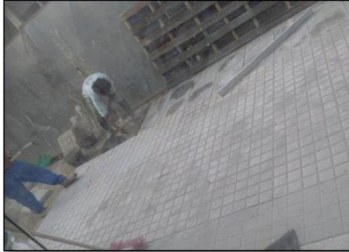
Figura 5. Colocacion de adoquin peatonal en las zonas exteriores. Fuente: Autor de la pasantía.
