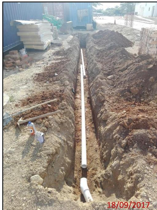
Figura 35. Instalación de tubería para suministro de agua potable. Fuente: Autor del informe.
