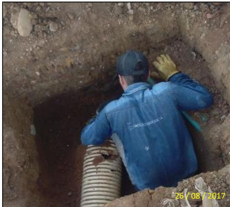
Figura 26. Instalacion de tubería de alcantarillado de 12 doble pared corrugado espiral de plástico”. Fuente: Autor de la pasantía.
