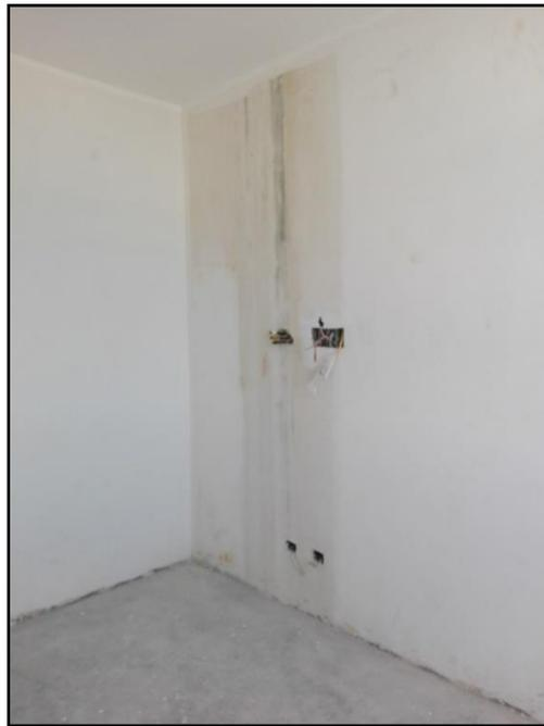
Figura 30. Detección de humedad en muro. Fuente: Autor del informe.
