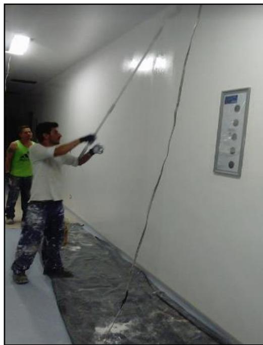
Figura 4. Aplicación de pintura epoxica con sikaguard 62. Fuente: Autor de la pasantía.
