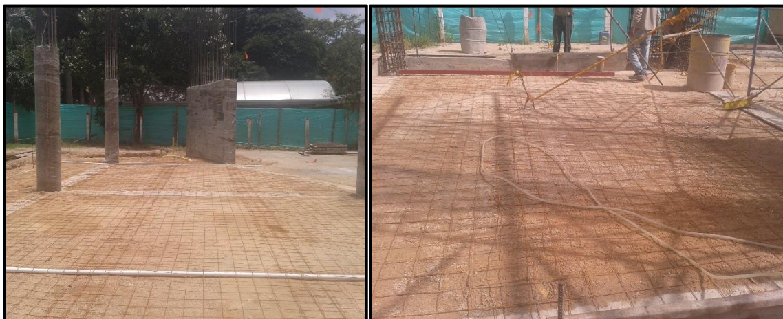
Fotografía 44. Malla electrosoldada instalada.
