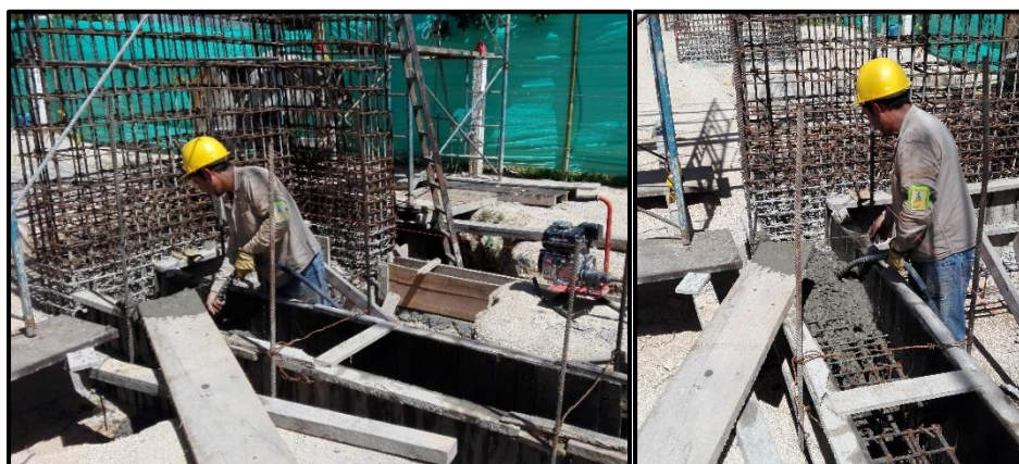
Fotografía 8. Vibrado de concreto.
