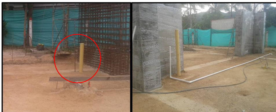
Fotografía 37. Puntos de conexión sanitaria e instalación de redes hidrosanitairas.
