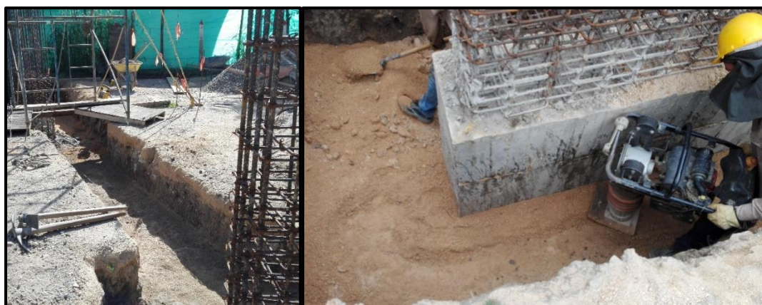
Fotografía 1. Excavación y nivelación para viga de cimentación.
