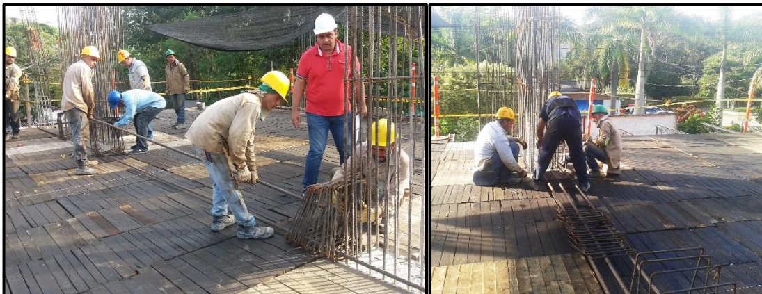
Fotografía 59. Armado de acero en las vigas de entrepiso.
