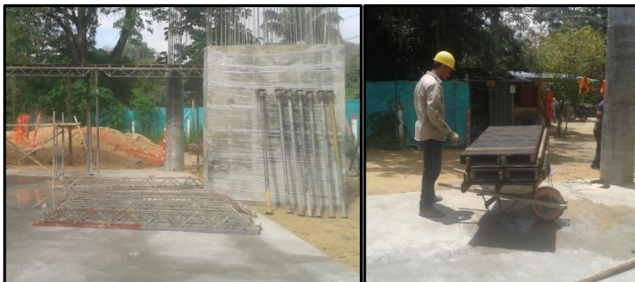
Fotografía 52. Alistado de materiales para entarimado, placa de entrepiso.
