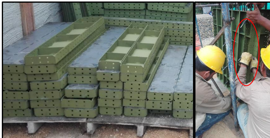
Fotografía 19. Formaletas metálicas tipo tablero.
