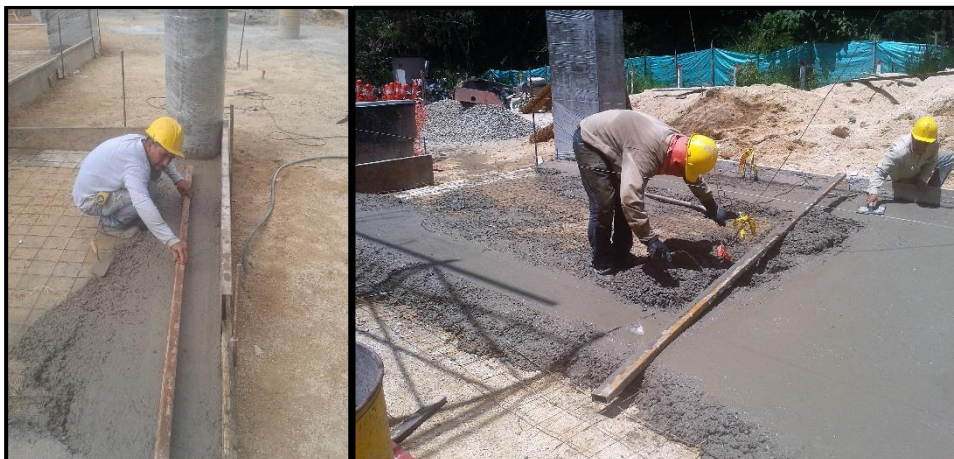
Fotografía 51. Extendido del concreto.
