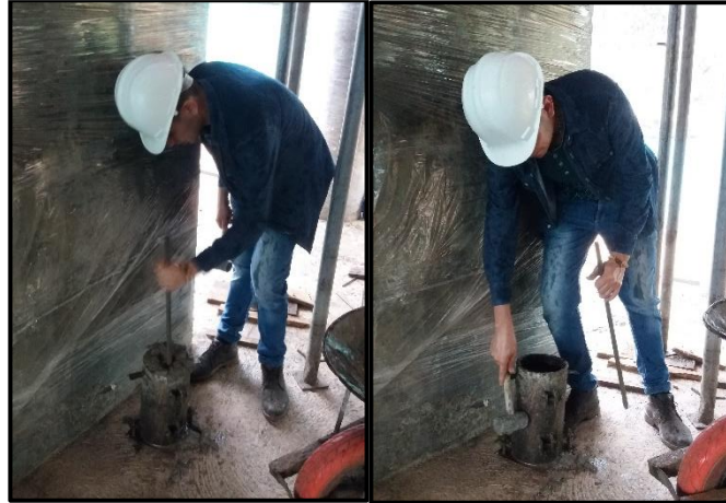
Fotografía 74. Apisonamiento y liberación de aire atrapado.
