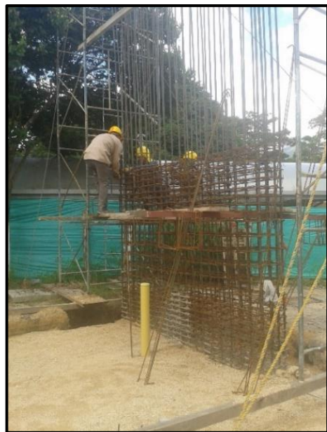
Fotografía 12. Armado del acero de la pantalla B16.
