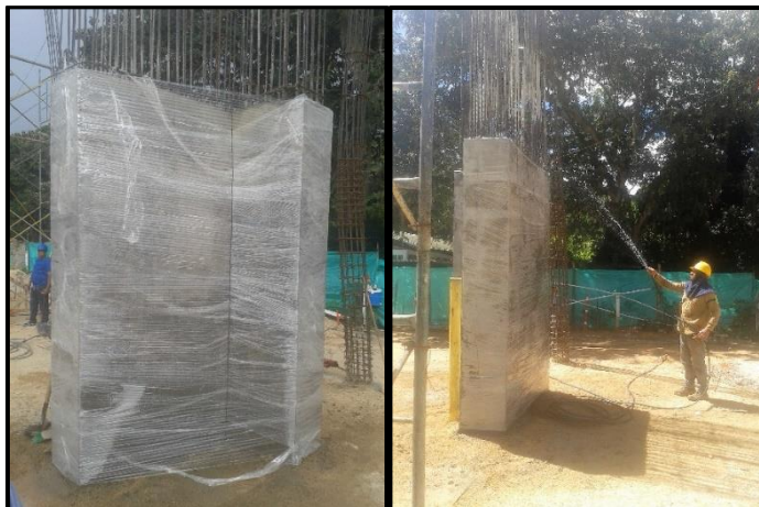
Fotografía 31. Columna envuelta en papel impermeable.
