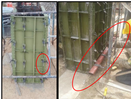
Fotografía 20. Instalación de chapetas y alineadores.
