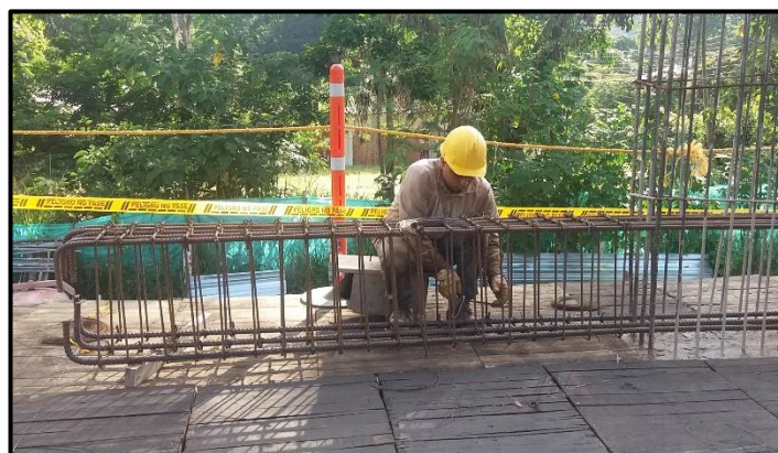
Fotografía 61. Amarre de estribos en las vigas de entrepiso.
