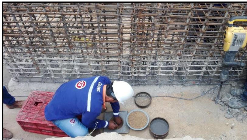
Fotografía 2. Ensayo de densidades.
