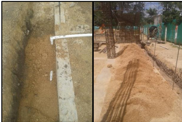
Fotografía 36. Relleno de excavaciones para tuberías de agua potable.
