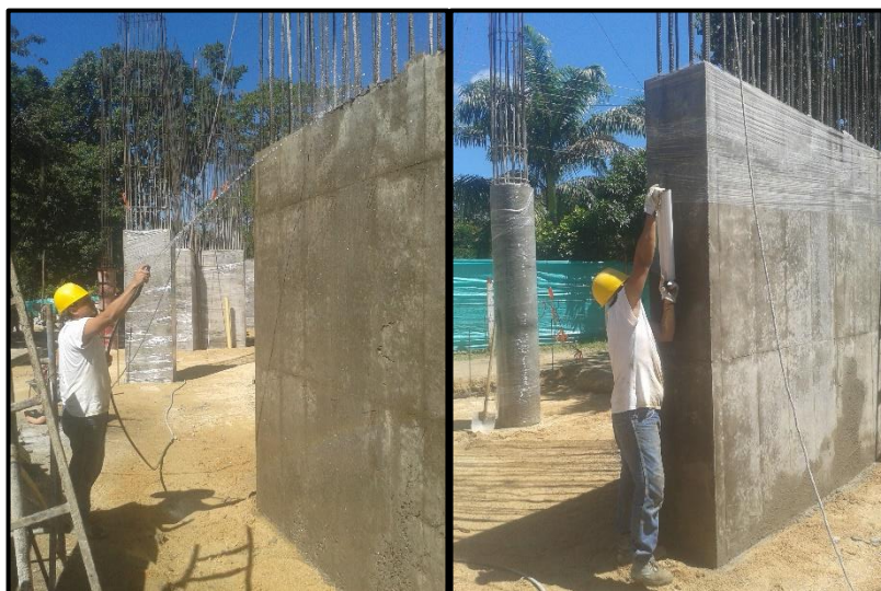
Fotografía 30. Humedecimiento y envoltura de la columna.
