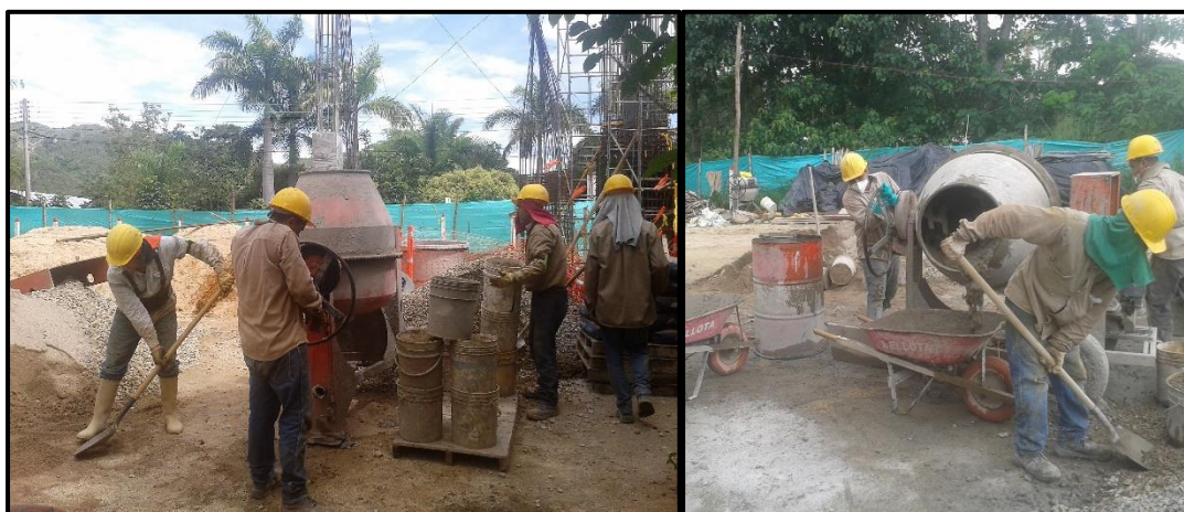
Fotografía 48. Mezclado del concreto.
