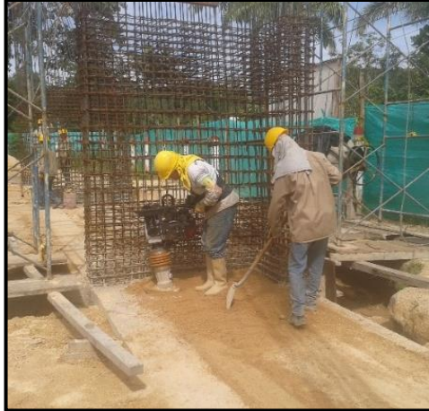
Fotografía 38. Compactación de material seleccionado con canguro.
