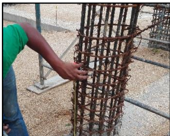
Fotografía 16. Verificación de separación del acero transversal.
