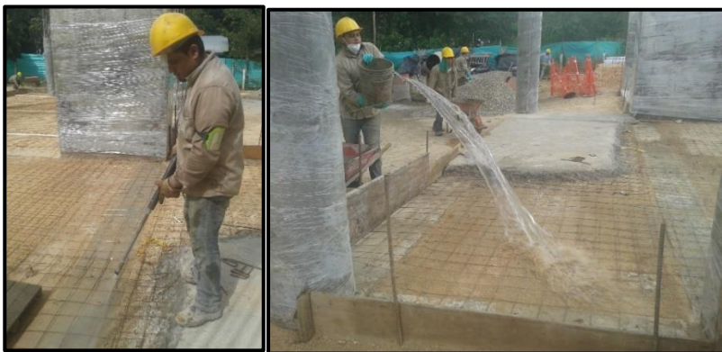
Fotografía 46. Limpieza de vigas de cimentación y humedecimiento del terreno.
