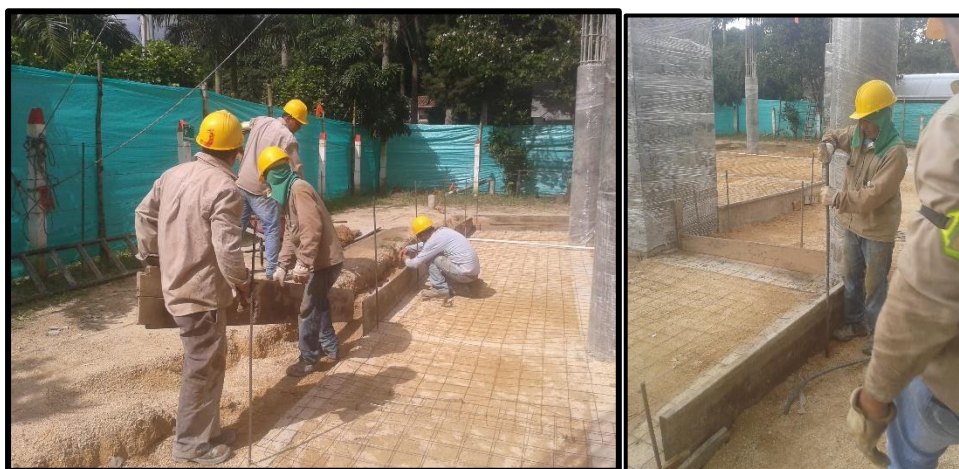
Fotografía 45. Instalación de la formaleta.
