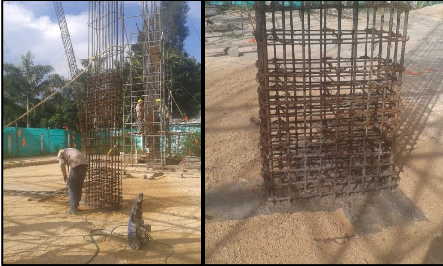
Fotografía 17. Limpieza del acero de las columnas.
