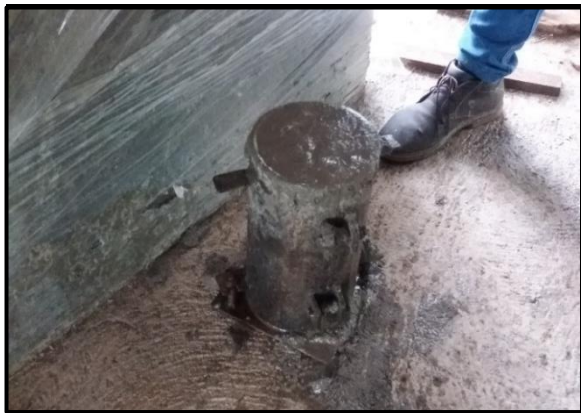
Fotografía 75. Molde de concreto lleno.
