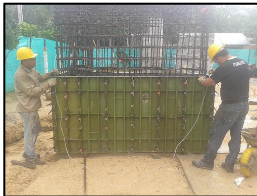
Fotografía 23. Nivelación de la formaleta con manguera.
