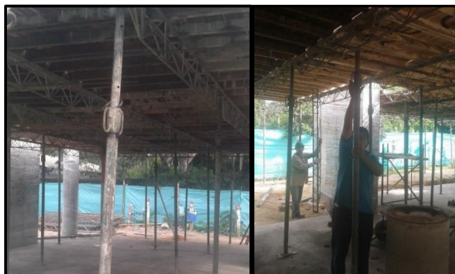
Fotografía 53. Ajuste de parales en obra.
