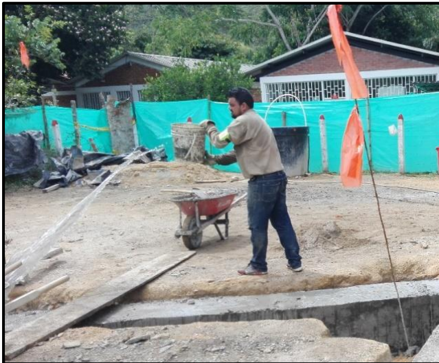
Fotografía 10. Curado vigas de cimentación.
