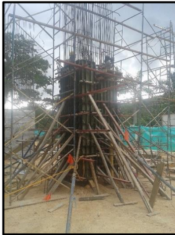
Fotografía 25. Formaleta totalmente instalada.
