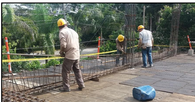
Fotografía 60. Instalación de refuerzo superior de las vigas.
