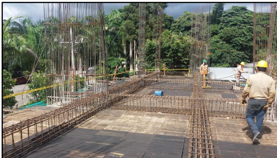
Fotografía 64. Acero de refuerzo de vigas principales de la placa de entrepiso.
