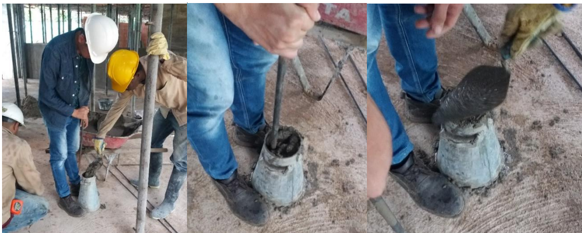
Fotografía 70. Procedimiento para obtención de asentamiento: llenado del molde.
