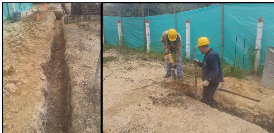
Fotografía 33. Excavación para instalación de tubería.
