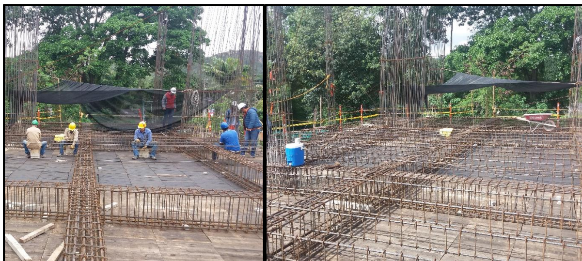
Fotografía 65. Instalación del refuerzo para viguetas.
