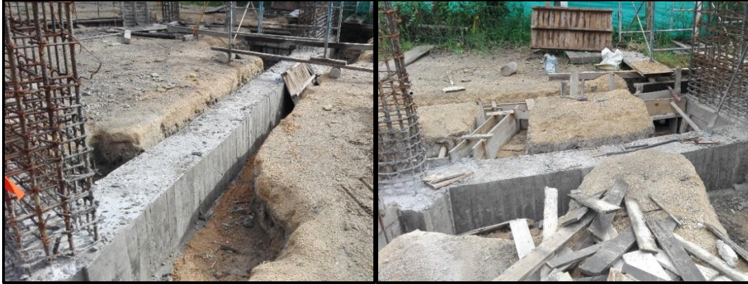
Fotografía 9. Desencofrado vigas de cimentación.
