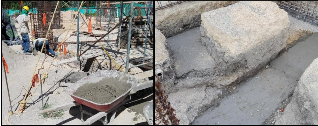
Fotografía 3. Instalación de concreto pobre.
