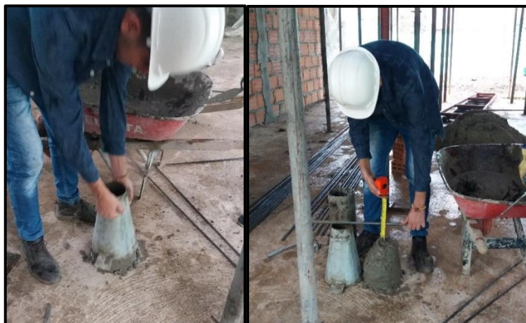
Fotografía 71. Procedimiento para obtención de asentamiento: retiro de molde y medición.
