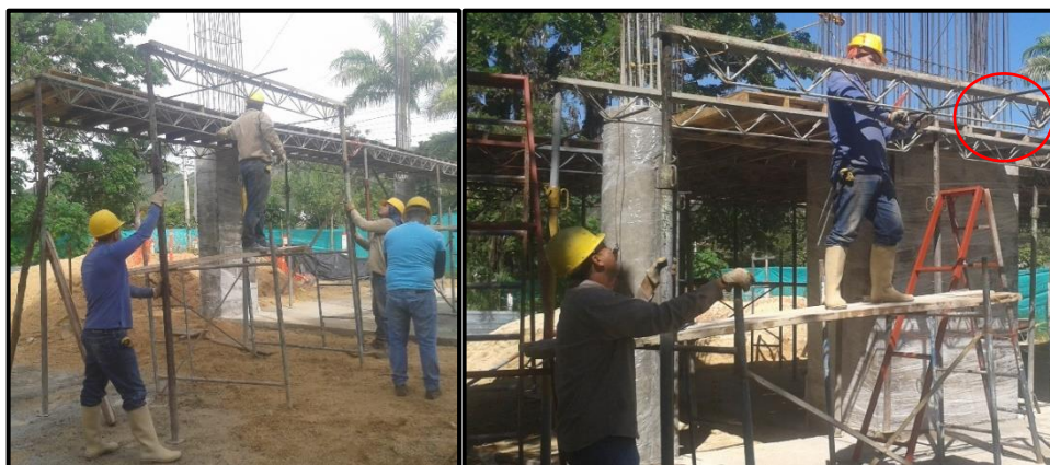
Fotografía 54. Inicio de entarimado para placa de entrepiso.
