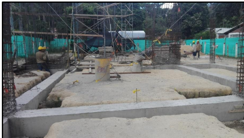
Fotografía 11. Vista general del proyecto al iniciar la pasantía.
