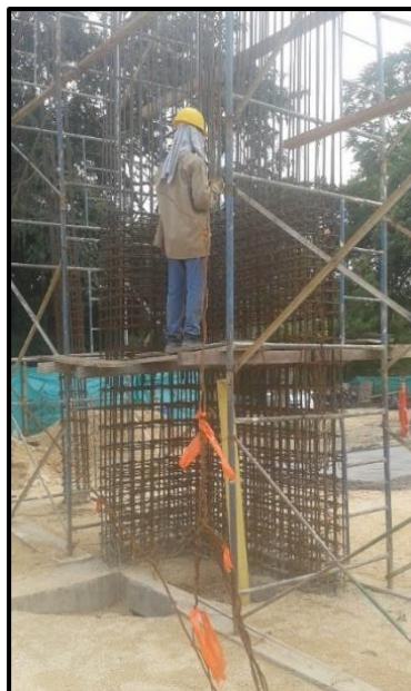
Fotografía 15. Armado del acero de la columna C12.
