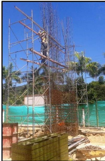
Fotografía 14. Preparación de la columna A12 para instalación de formaleta.
