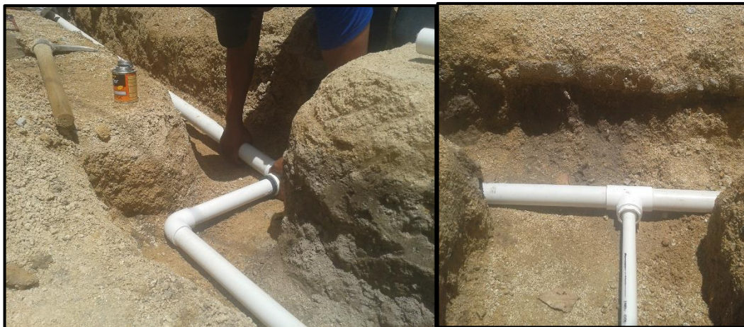
Fotografía 34. Continuidad de la red de agua potable.
