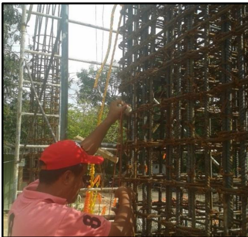
Fotografía 18. Nivelación vertical de la columna.
