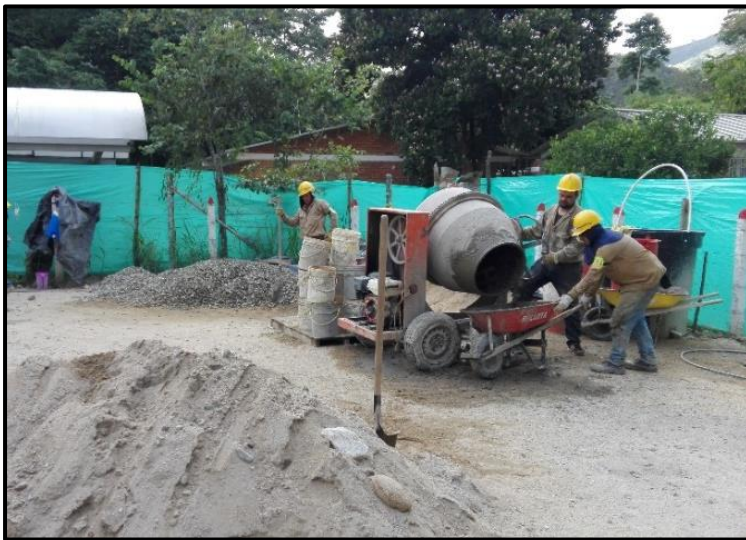
Fotografía 7. Mezclado de concreto en obra.
