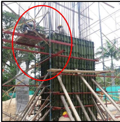
Fotografía 27. Tarima para el vibrador.
