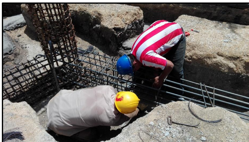
Fotografía 5. Amarrado de acero en vigas de cimentación.
