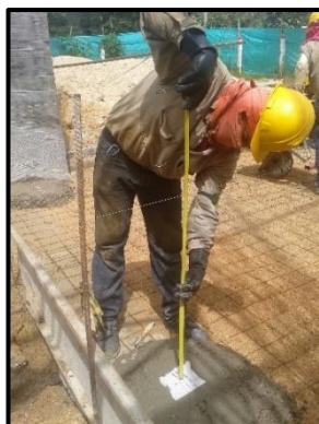
Fotografía 50. Verificación de la altura de la placa.
