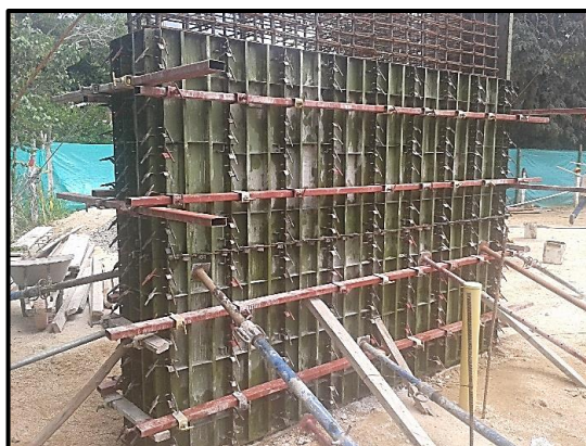
Fotografía 21. Formaleta instalada con alineadores y chapetas.
