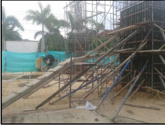
Fotografía 26. Rampa de acceso.
