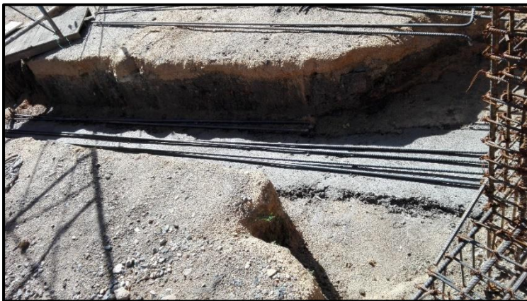
Fotografía 4. Extendido del acero longitudinal, vigas de cimentación.
