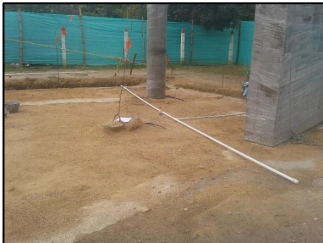
Fotografía 40. Instalación de red hidráulica sobre terreno nivelado.
