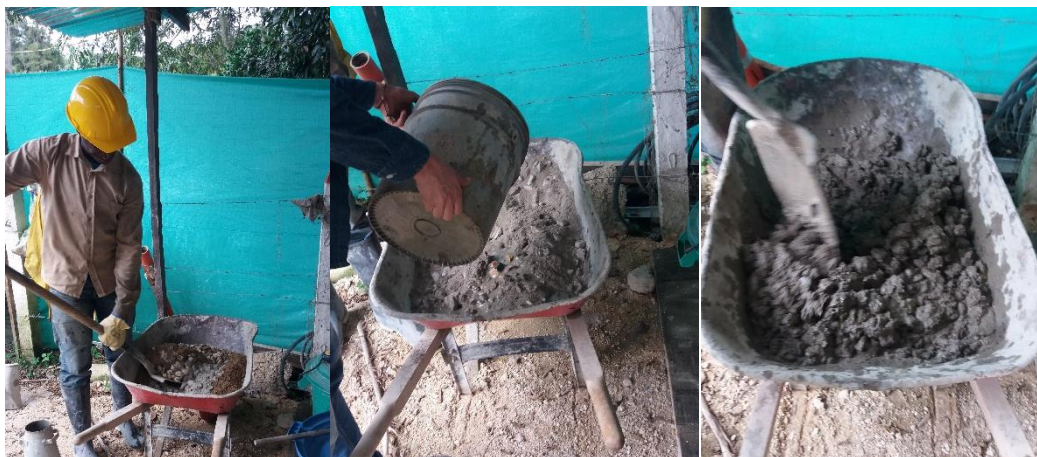
Fotografía 69. Mezclado y adición de agua.
