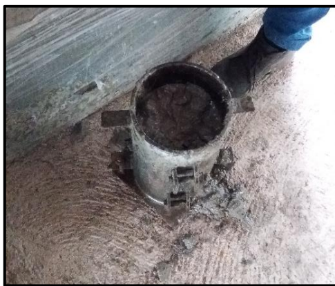
Fotografía 73. Molde cilíndrico llenado hasta la segunda capa.
