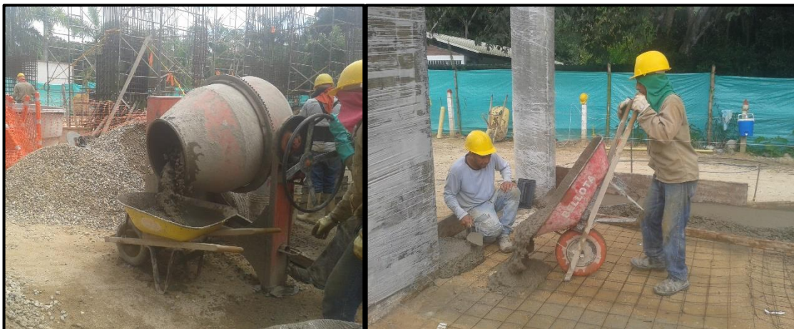
Fotografía 47. Transporte y vaciado del concreto.
