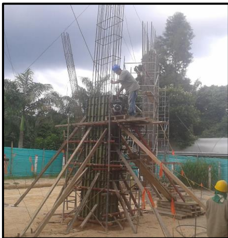
Fotografía 29. Vibrado del concreto.
