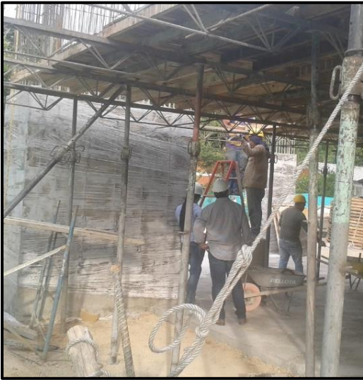
Fotografía 55. Inspección de instalación de entramado.
