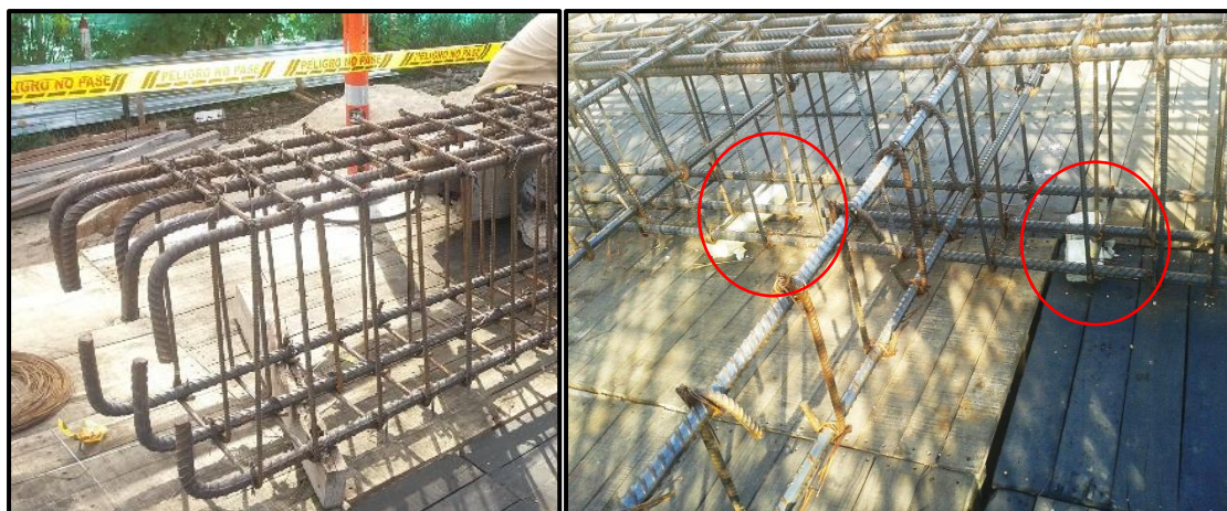
Fotografía 63. Ganchos y separadores en concreto.
