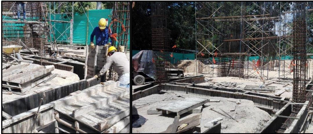
Fotografía 6. Formaleteado de vigas de cimentación.
