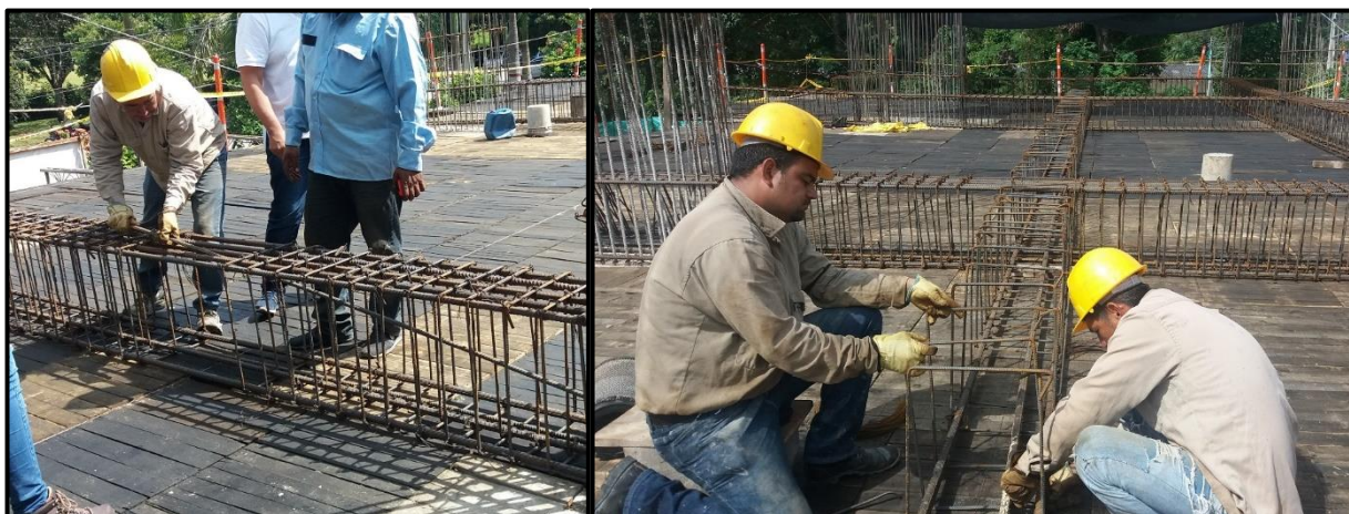
Fotografía 62. Traslapos y amarres de estribos.
