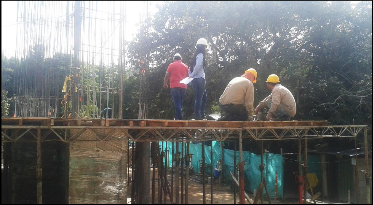
Fotografía 57. Cimbrado de la placa de entrepiso.
