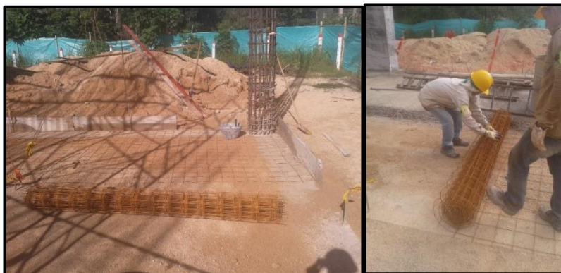
Fotografía 42. Extendido de malla electro-soldada.
