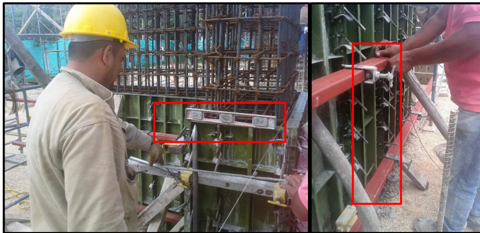
Fotografía 22. Nivelación y aplomado de la formaleta.
