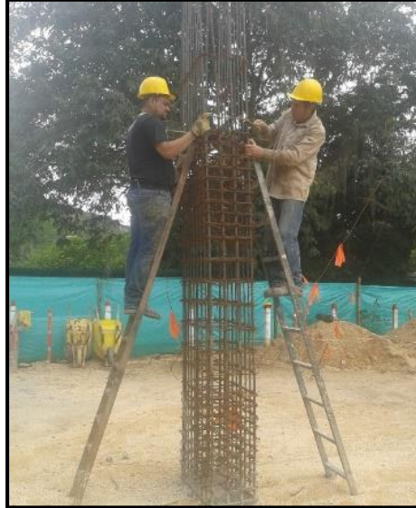
Fotografía 13. Armado del acero de la columna C13.
