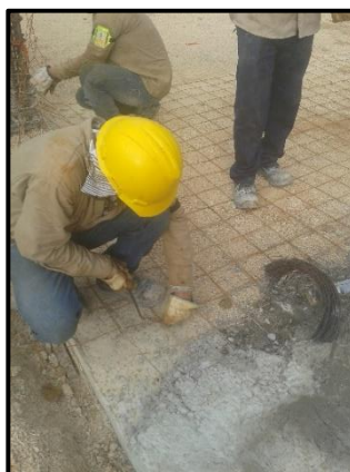
Fotografía 43. Amarre de traslape en malla electrosoldada.
