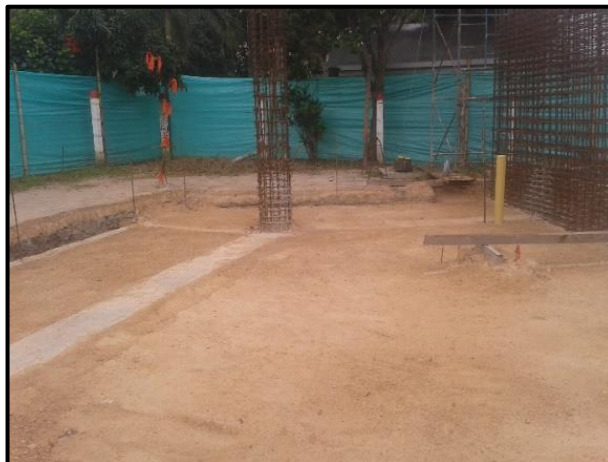
Fotografía 39. Terreno nivelado, previo a la instalación de malla electro-soldada.
