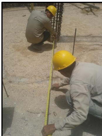
Fotografía 32. Trazado red de agua potable.
