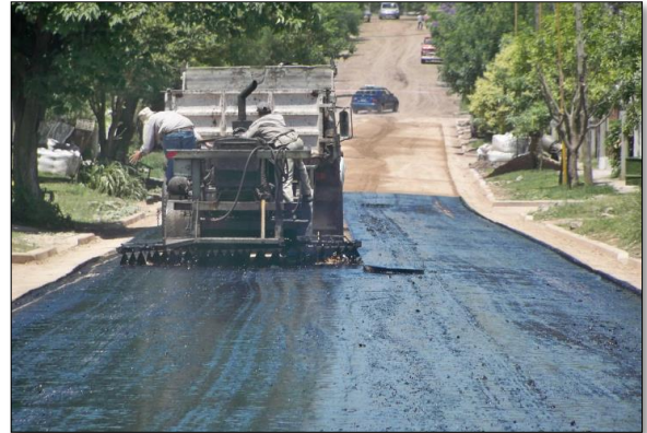
Figura 9. Riego de imprimación. Fuente: pettygchu (2011).
