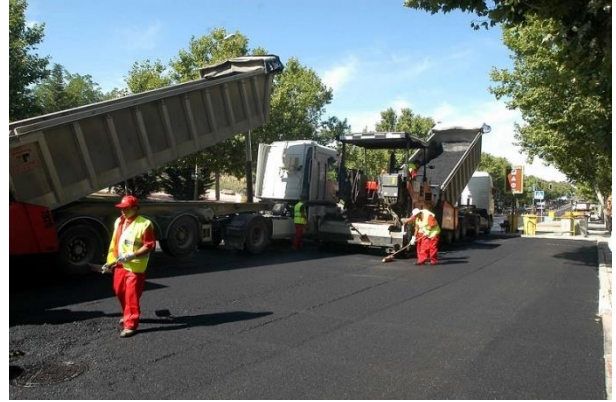
Figura 10. Descarga de la mezcla en obra. Fuente: COSLADA (2017).
