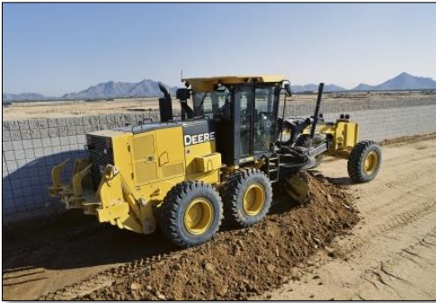
Figura 7. aireación del suelo de subrasante. Fuente: Caterpillar (2018).
