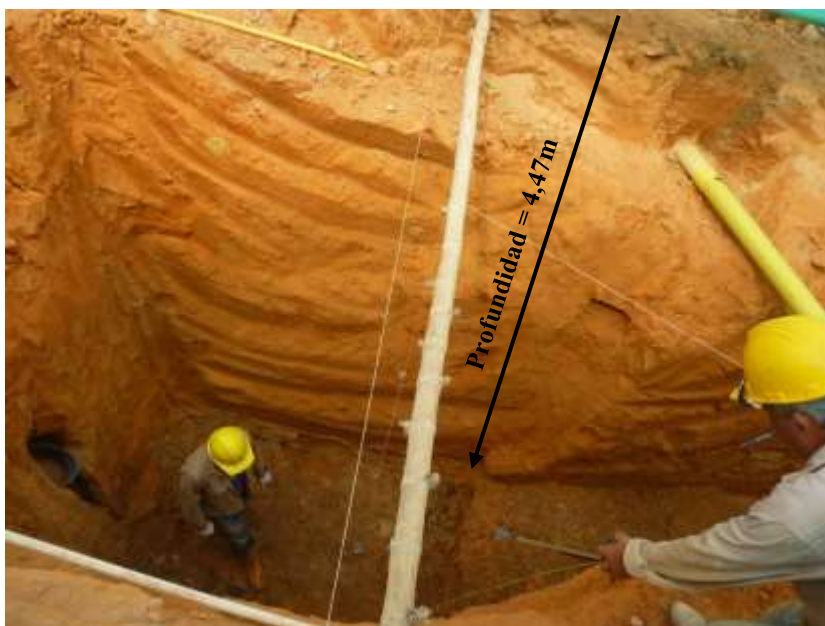
Figura 10. Preparación de terreno para solado de pozo alcantarillado Brisas del Polaco
