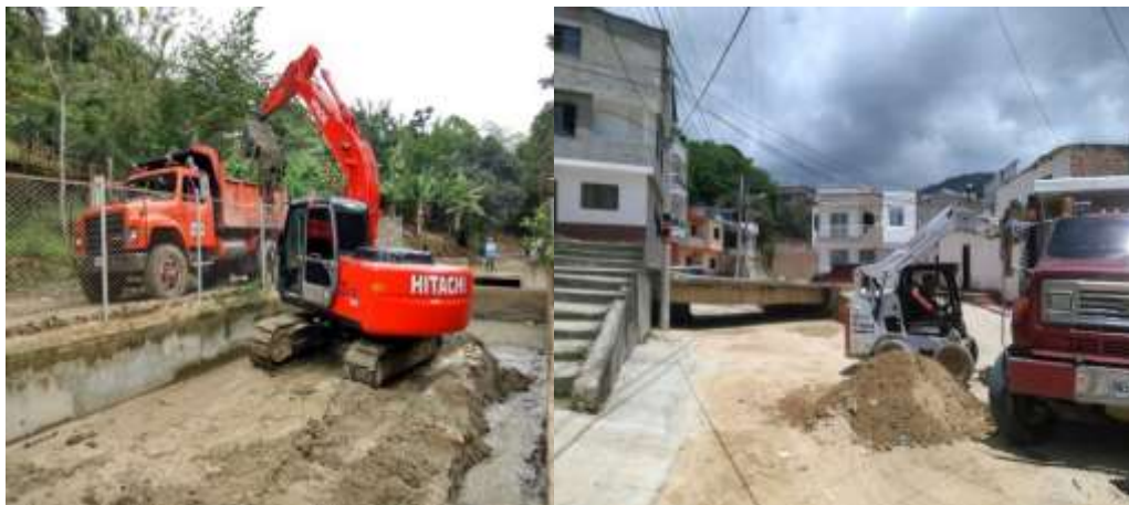
Figura 118. Retiro de escombros.
