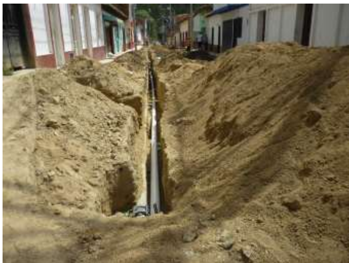
Figura 95. Instalación de tubería de 6" tramos 6 y 7, acueducto Tejarito.
