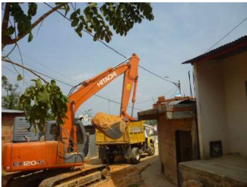
Figura 16. Retiro de material de excavación alcantarillado Brisas del Polaco.
