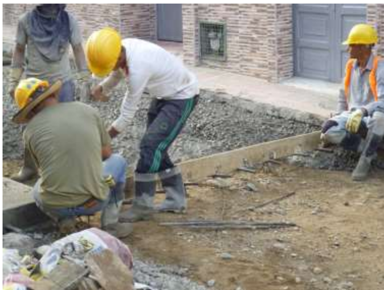
Figura 87. Colocación de refuerzo transversal, pavimentación Brisas del Polaco.
