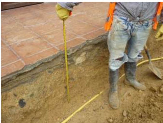
Figura 78. Verificación de cotas de excavación, pavimentación Tejarito.
