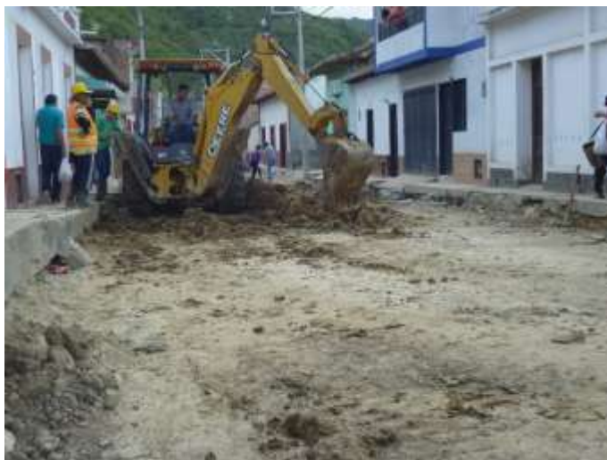
Figura 101. Excavación mecánica, alcantarillado Tejarito.
