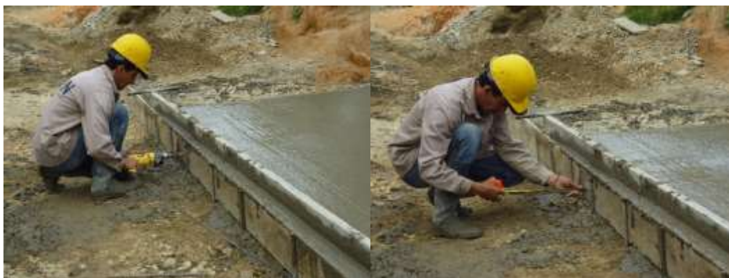
Figura 47. Colocación de barras de amarre, pavimentación Brisas del Polaco.
