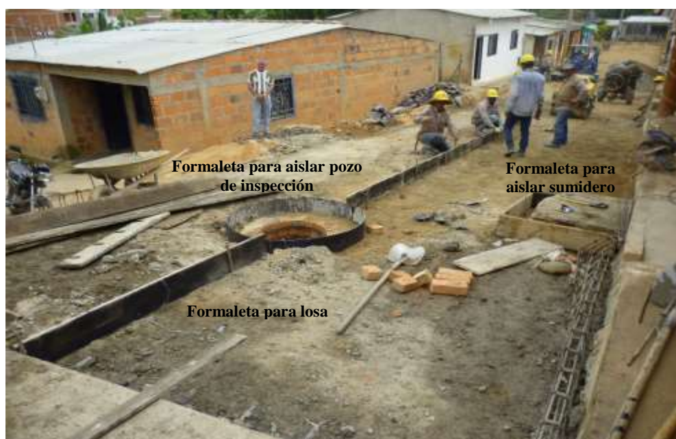
Figura 44. Formaleteado, pavimentación Brisas del Polaco.
