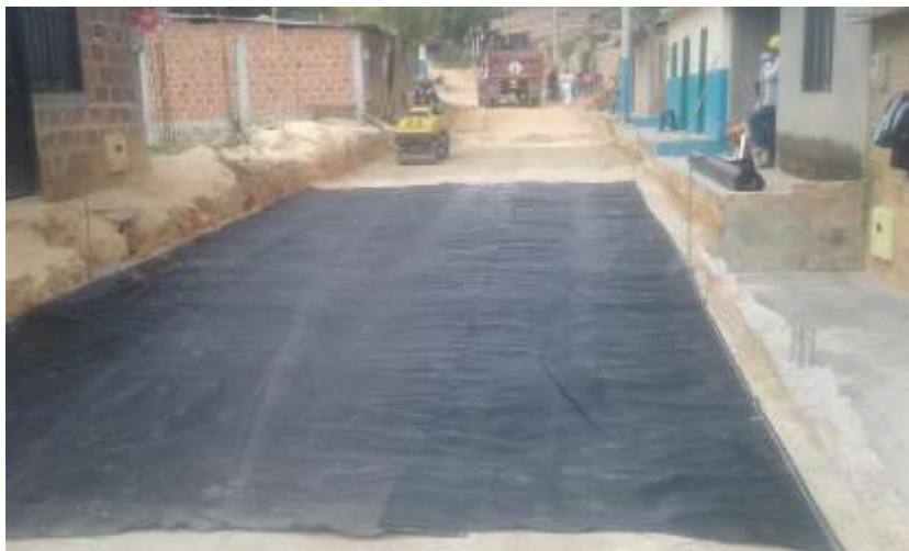
Figura 40. Instalación de geotextil, pavimentación Brisas del Polaco.
