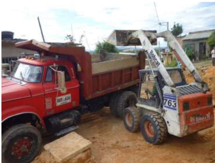
Figura 57. Retiro de sobrantes, pavimentación Brisas del Polaco.
