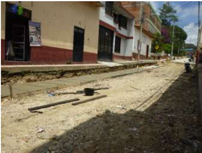
Figura 71. Construcción de cárcamo tramo 2, Tejarito.
