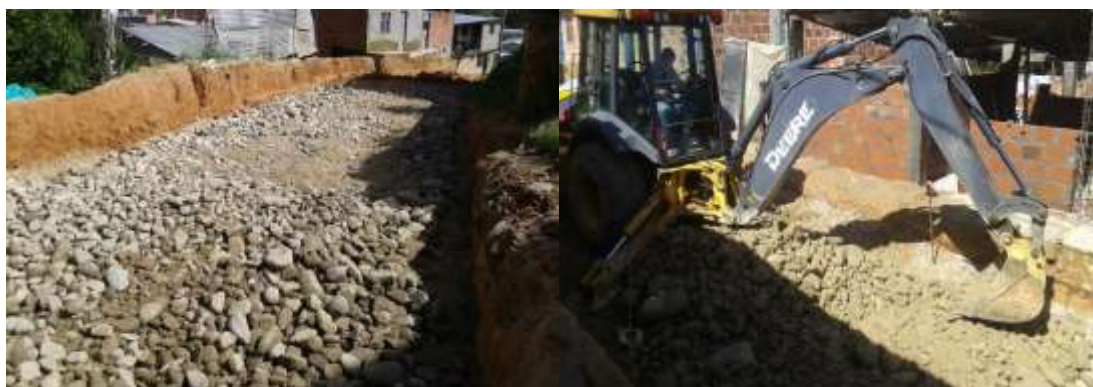
Figura 34. Pedraplén suelto, pavimentación Brisas del Polaco.
