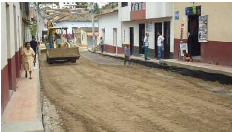
Figura 73. Base granular tramo 2, Tejarito.
