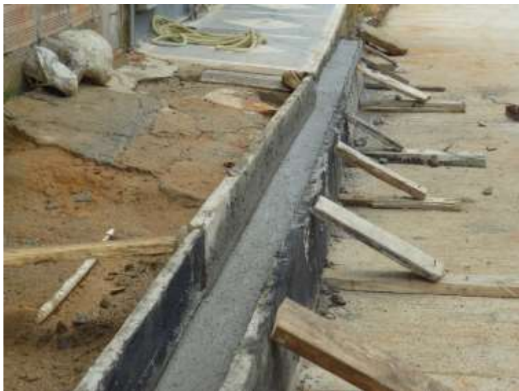
Figura 53. Construcción de bordillo, pavimentación Brisas del Polaco.
