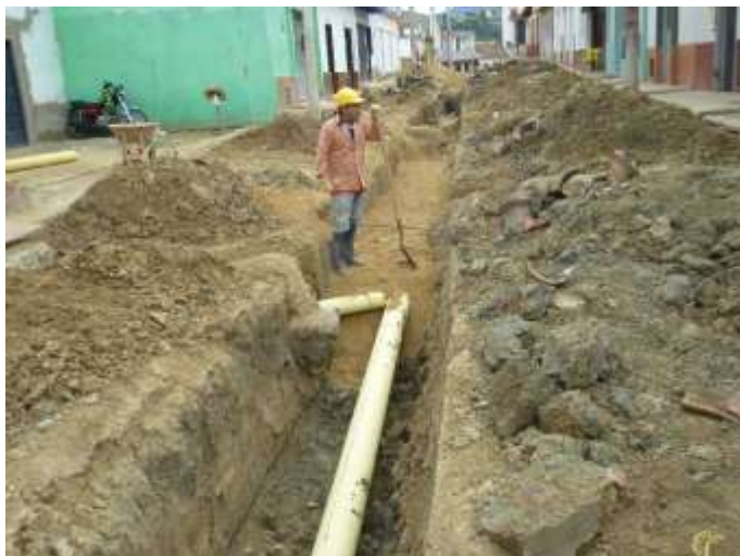
Figura 106. Rellenos, alcantarillado Tejarito.
