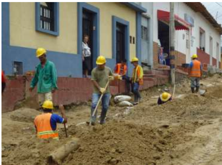
Figura 91. Excavación manual, acueducto Tejarito.
