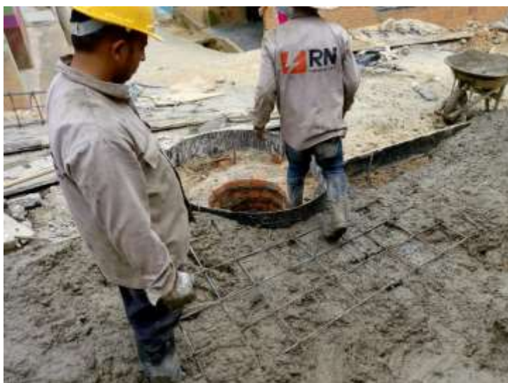
Figura 49. Refuerzo de losa adyacente a pozo de inspección, pavimentación Brisas del Polaco.
