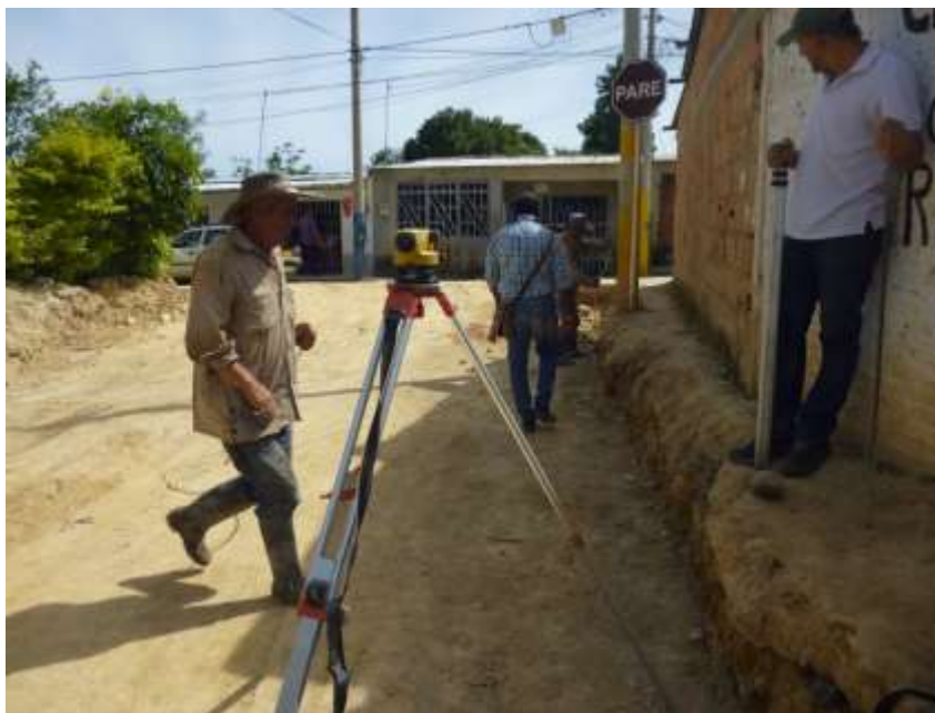
Figura 7. Localización y replanteo alcantarillado Brisas del Polaco.
