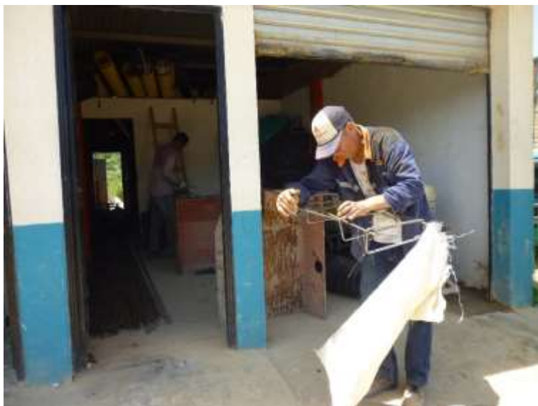
Figura 54. Armado de refuerzo para bordillo, pavimentación Brisas del Polaco.
