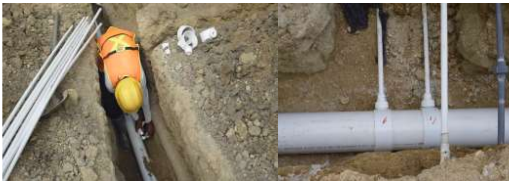
Figura 97. Instalación de acometidas, acueducto Tejarito.
