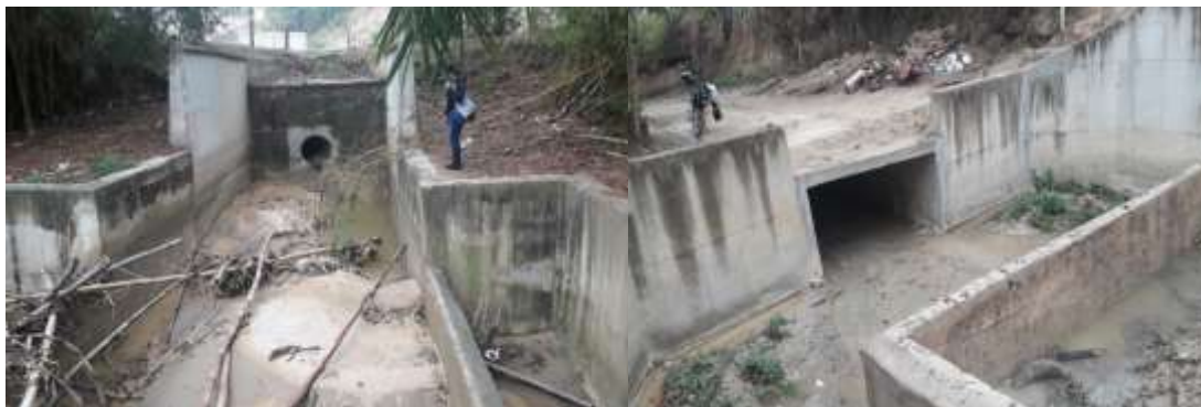
Figura 114. Estado inicial de estructura de box coulvert y desarenador.
