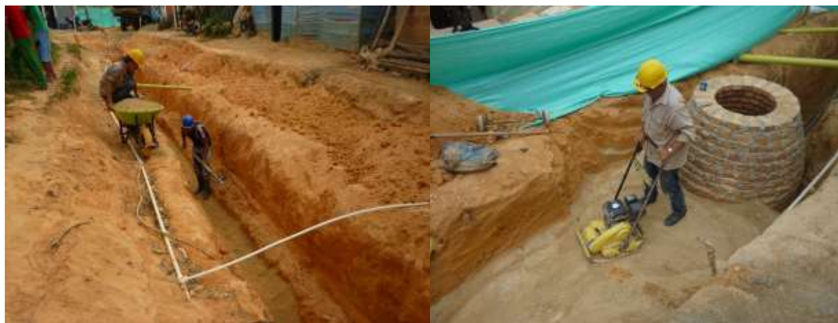
Figura 13. Relleno con material seleccionado.
