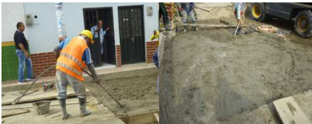
Figura 88. Extensión y vibrado del concreto, pavimentación Tejarito.
