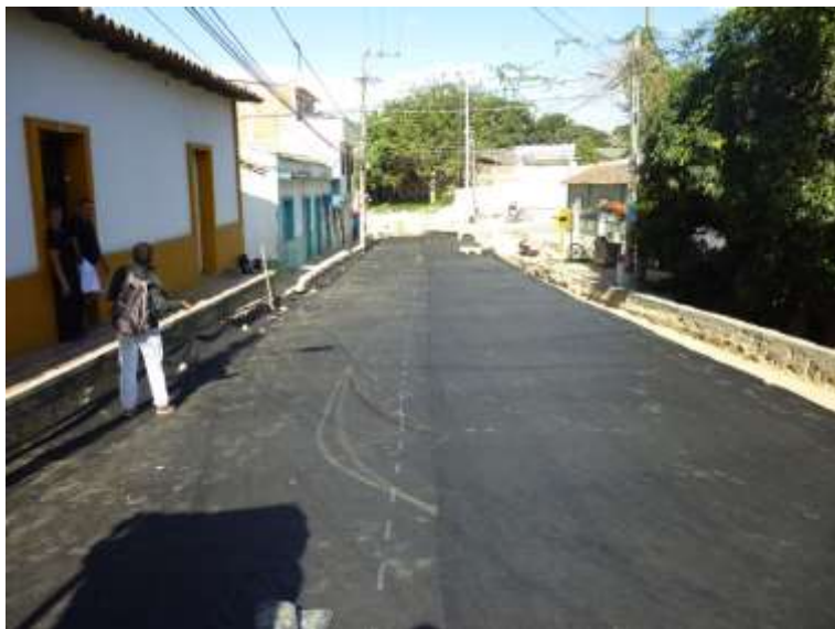
Figura 83. Instalación de geotextil, pavimentación Tejarito.
