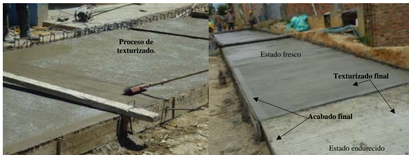
Figura 51. Texturizado y acabado final de losa, pavimentación Brisas del Polaco.
