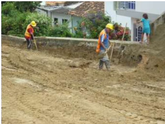
Figura 79. Excavación manual sin clasificar pavimentación Tejarito.
