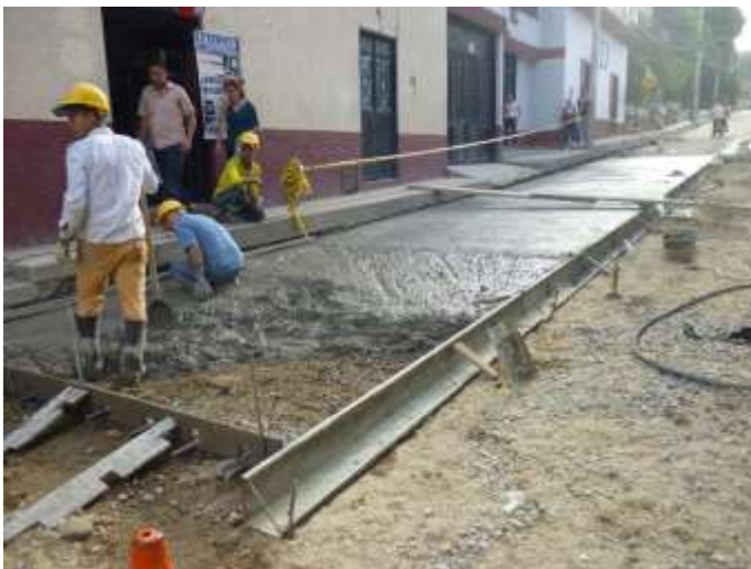
Figura 75. Pavimento rígido tramo 2, Tejarito.
