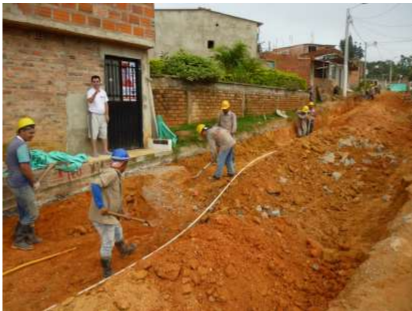
Figura 33. Excavación manual sin clasificar pavimentación Brisas del Polaco.
