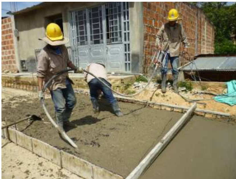
Figura 45. Extensión y vibrado del concreto, pavimentación Brisas del Polaco.
