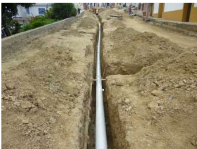
Figura 94. Instalación de tubería de 6" tramos 4 y 5, acueducto Tejarito.
