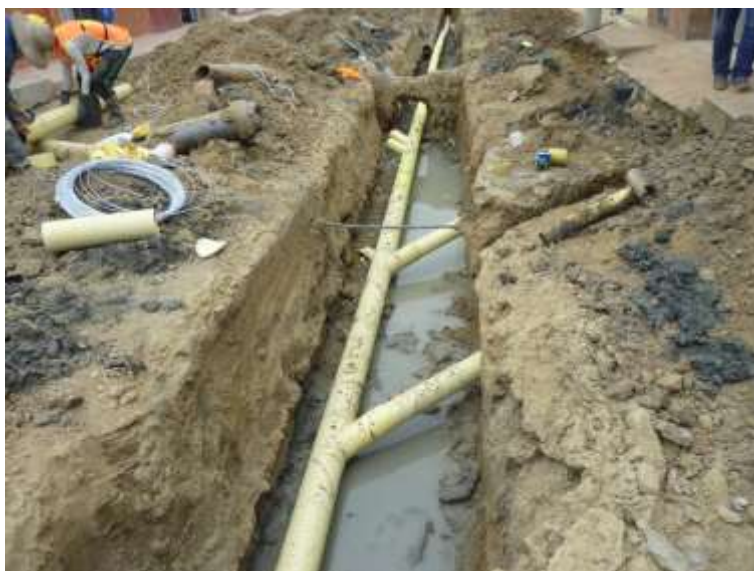
Figura 102. Instalación de tubería principal, alcantarillado Tejarito.
