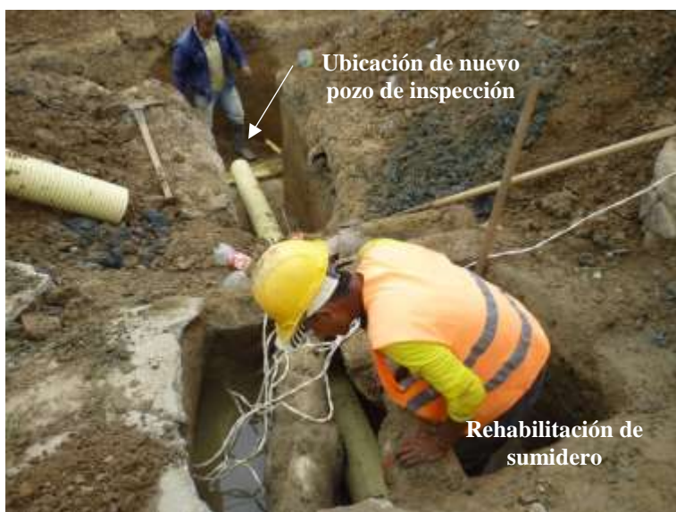
Figura 105. Rehabilitación de sumidero y construcción de pozo, alcantarillado Tejarito.
