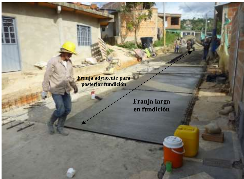
Figura 43. Fundición de losas de concreto, pavimentación Brisas del Polaco.
