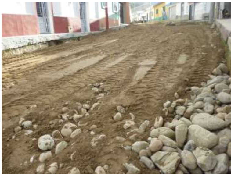
Figura 82. Instalación de sello, pavimentación Tejarito.
