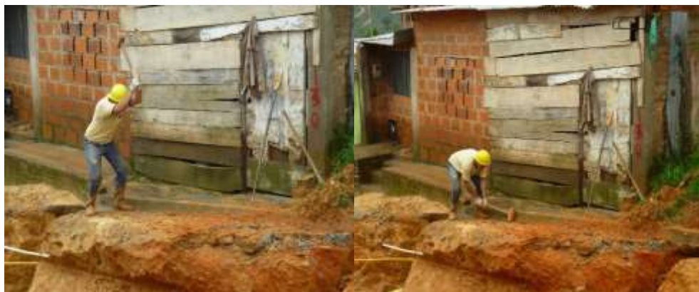
Figura 31. Demolición de cuneta existente, Brisas del Polaco.
