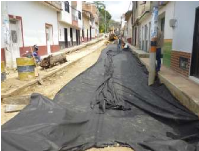
Figura 72. Geotextil de separación tramo 2, Tejarito.
