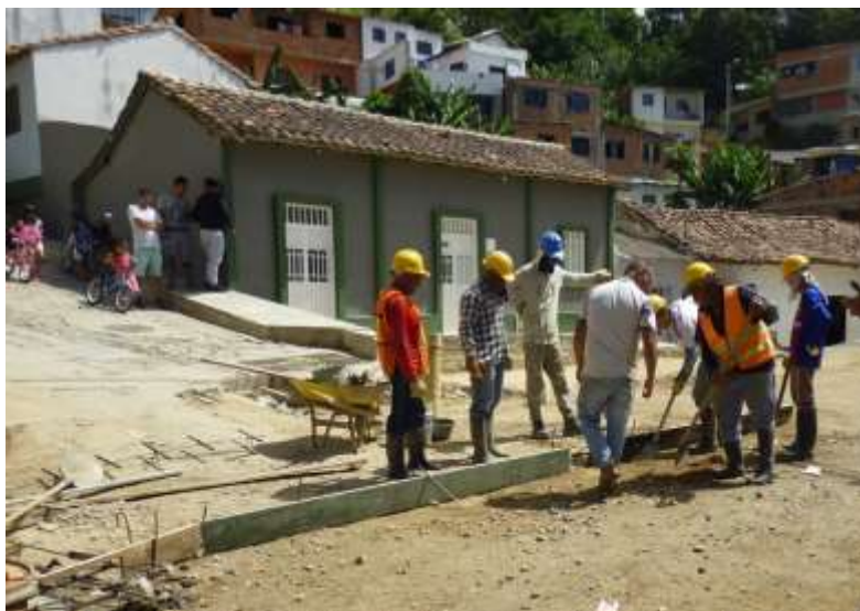
Figura 86. Formaleteado, pavimentación Tejarito.
