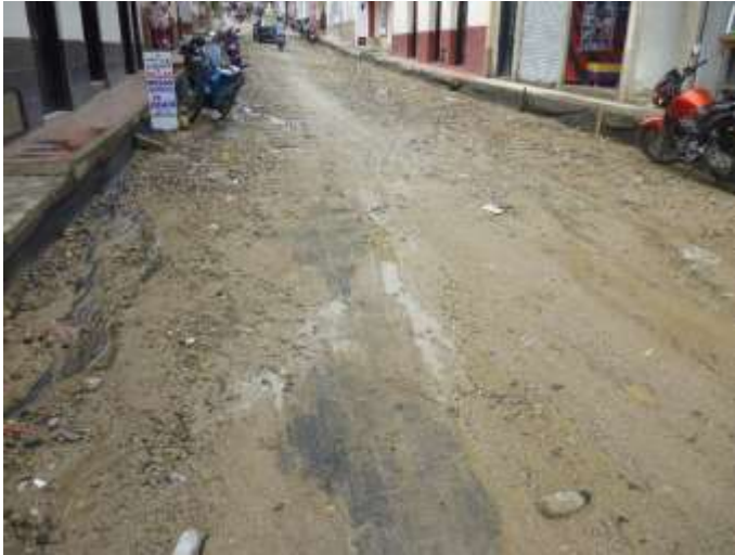
Figura 74. Base granular expuesta tramo 2, Tejarito.
