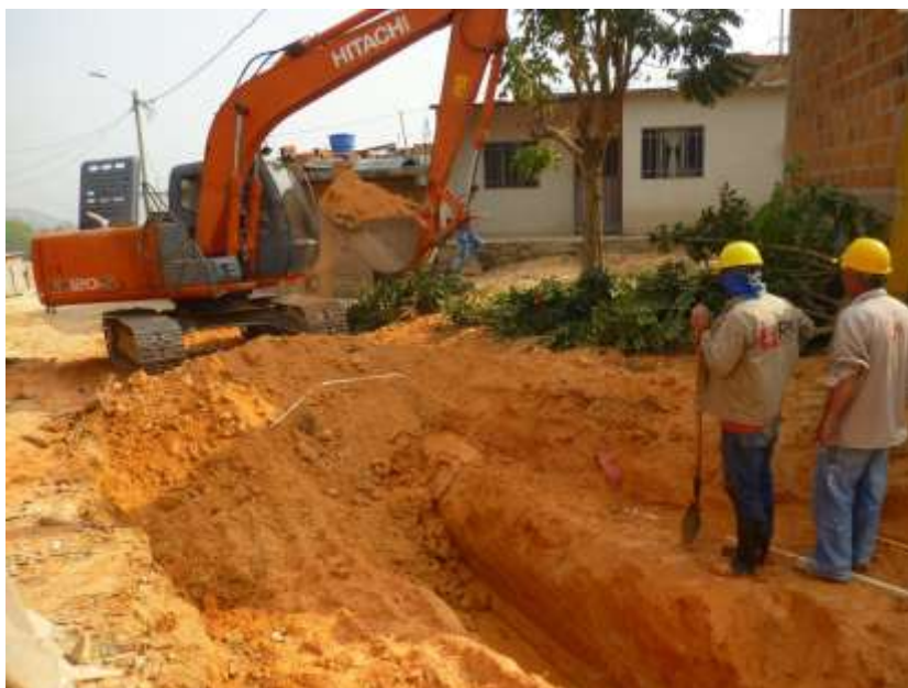
Figura 9. Excavación mecánica alcantarillado Brisas del Polaco.
