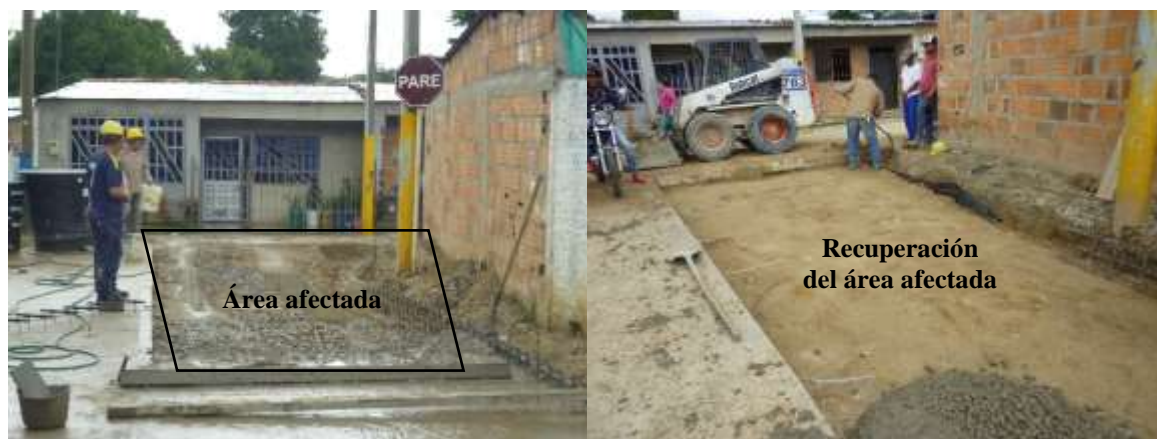
Figura 42. Retiro de material de excavación alcantarillado Brisas del Polaco.
