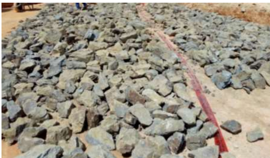
Figura 36. Piedra rajón para pedraplén, pavimentación Brisas del Polaco
