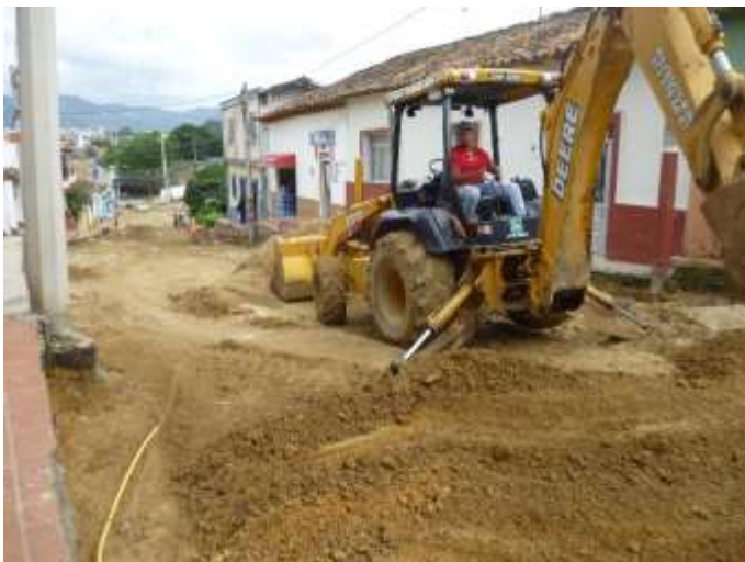
Figura 77. Excavación mecánica sin clasificar, pavimentación Tejarito.
