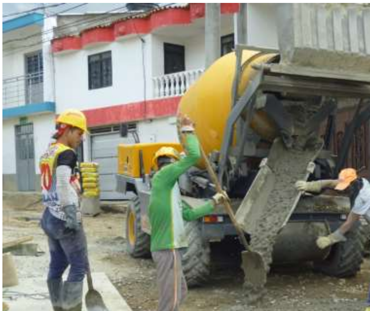
Figura 85. Vaciado de concreto, pavimentación Tejarito.
