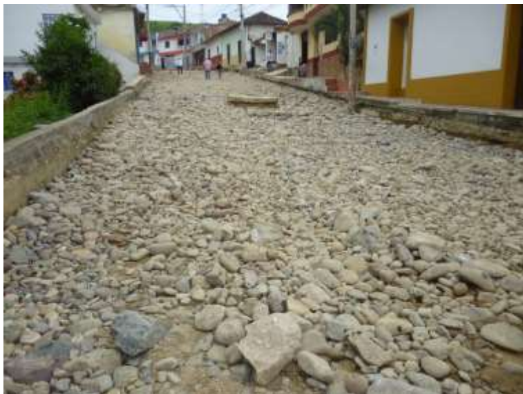
Figura 80. Pedraplén suelto, pavimentación Tejarito.
