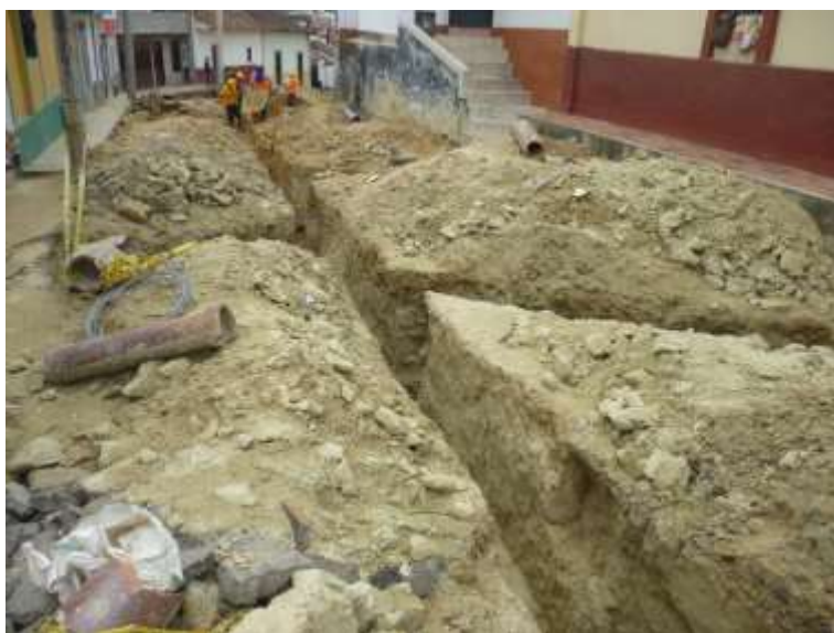
Figura 99. Excavación manual, alcantarillado Tejarito.
