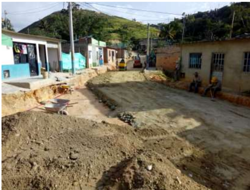
Figura 38. Instalación de sello B-400, pavimentación Brisas del Polaco.
