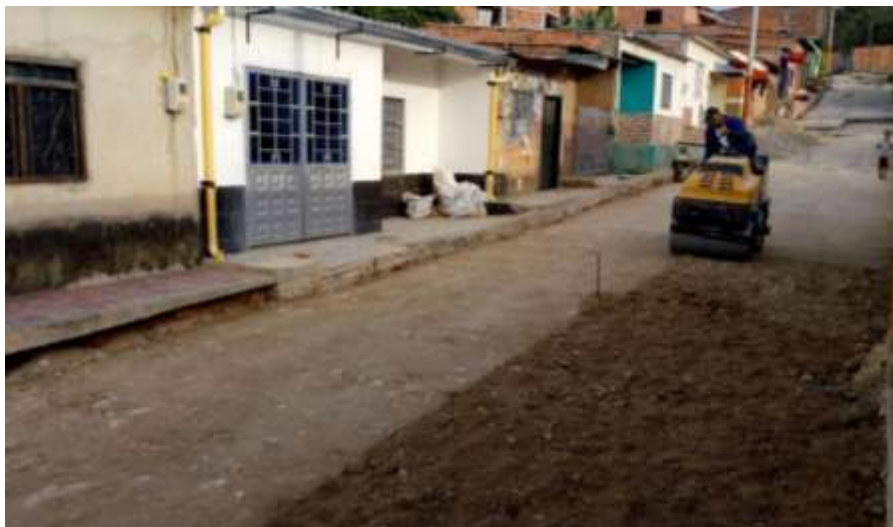
Figura 41. Instalación y compactación de sub base, pavimentación Brisas del Polaco.
