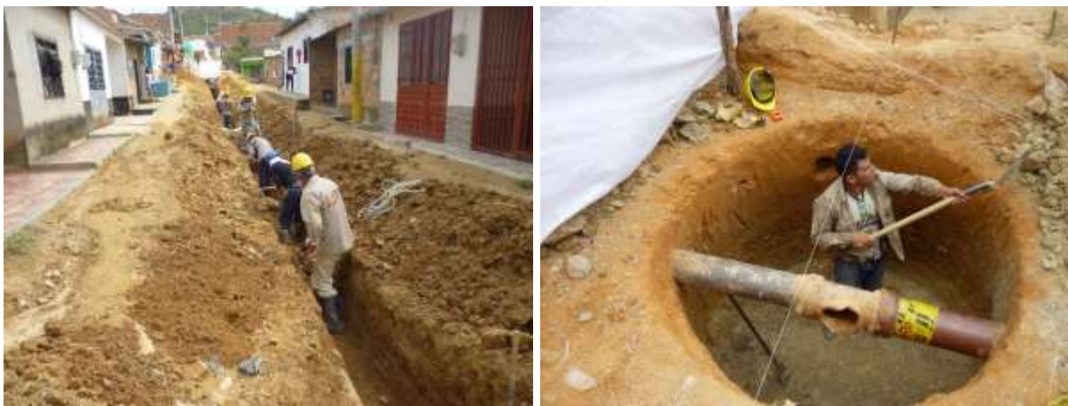
Figura 8. Excavación manual sin clasificar alcantarillado Brisas del Polaco.
