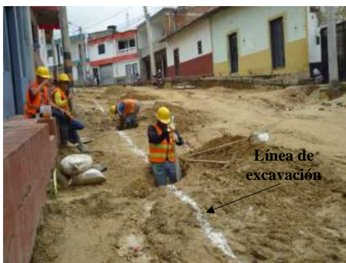
Figura 90. Replanteo, acueducto Tejarito.
