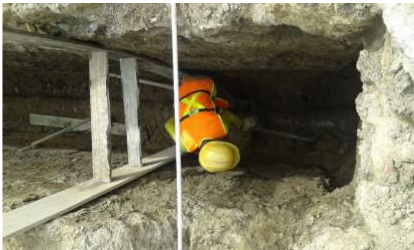
Figura 100. Entibación para excavación manual, alcantarillado Tejarito.
