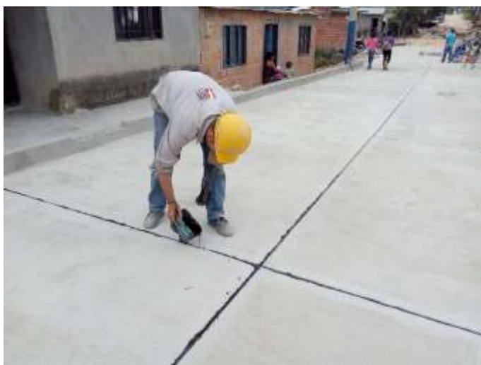
Figura 52. Sellado de juntas, pavimentación Brisas del Polaco.
