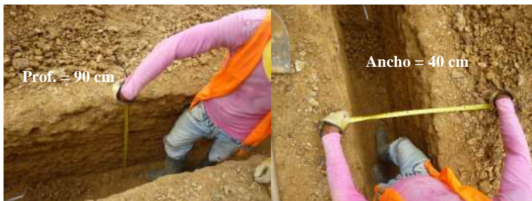
Figura 93. Verificación de dimensiones en excavación manual, acueducto Tejarito.
