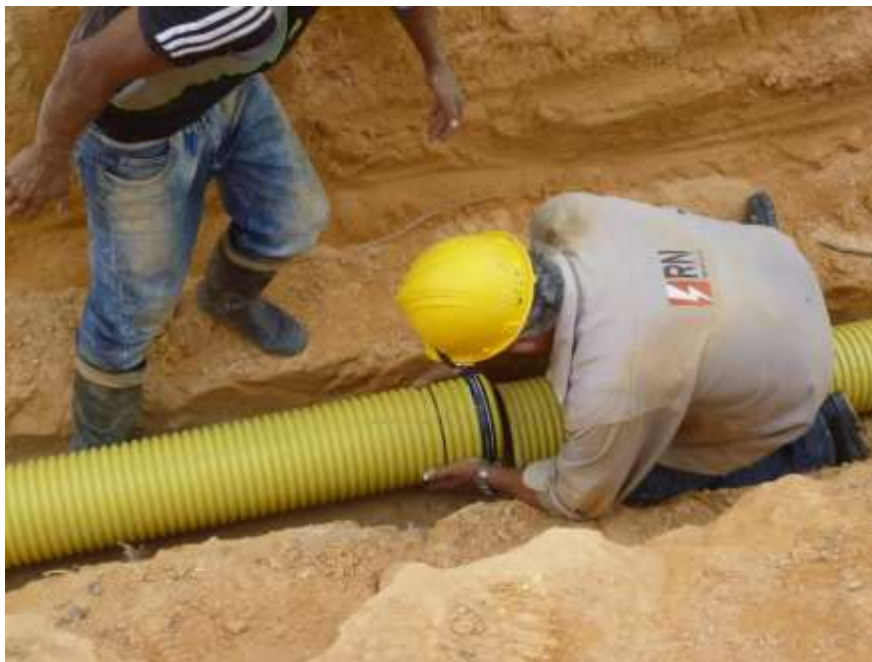
Figura 12. Instalación de tubería 8" PVC alcantarillado Brisas del Polaco.
