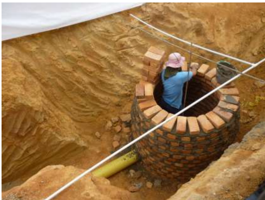
Figura 14. Construcción de pozo de inspección alcantarillado Brisas del Polaco.
