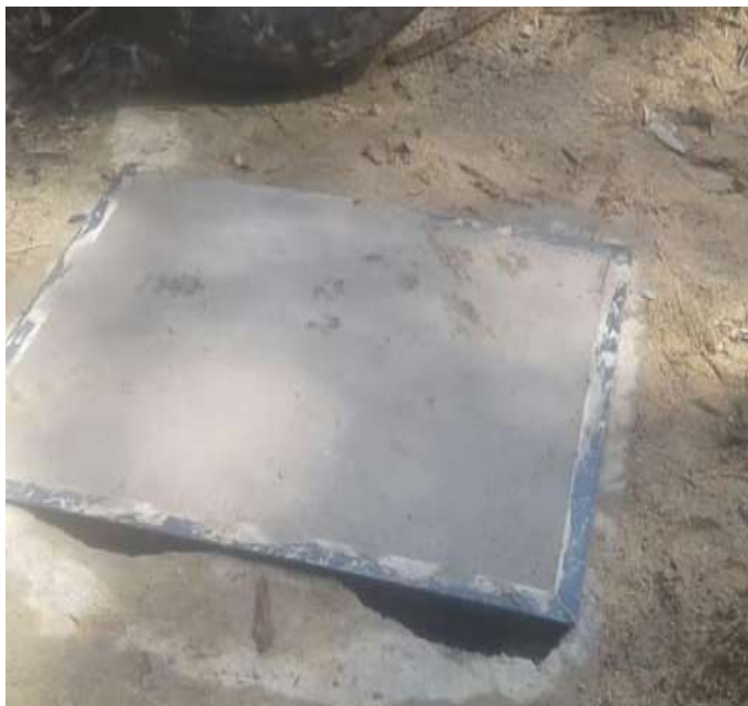
Figura 119. Reconstrucción de tapa en concreto.
