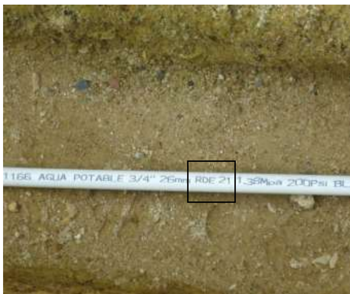
Figura 96. Verificación RDE, acueducto Tejarito.
