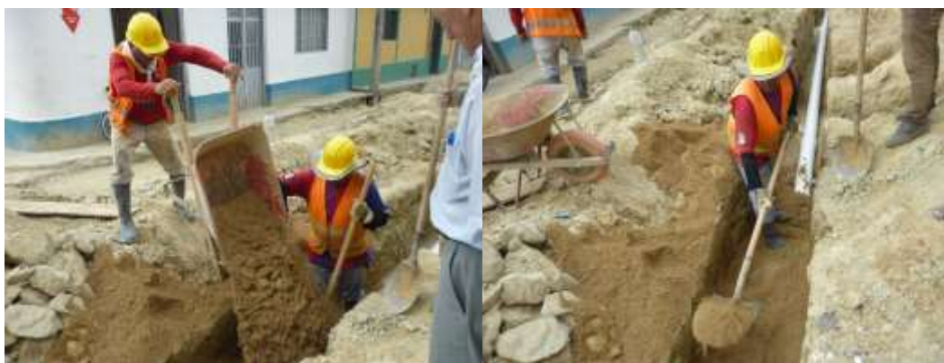
Figura 98. Rellenos, acueducto Tejarito.
