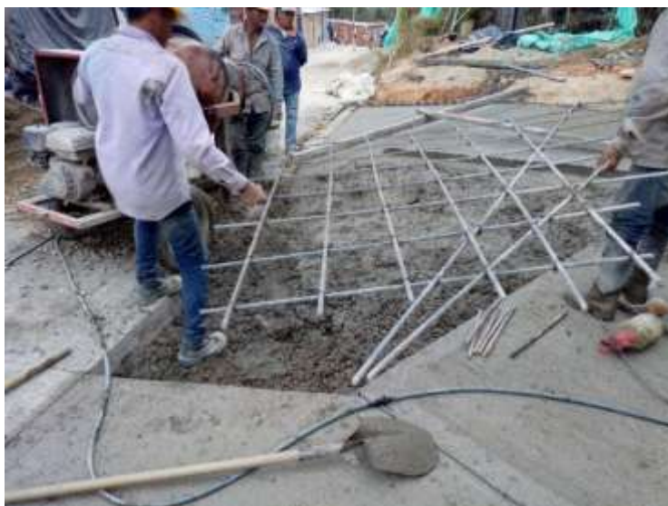
Figura 48. Refuerzo de losa irregular, pavimentación Brisas del Polaco.
