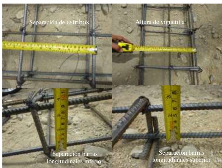
Figura 55. Verificación del refuerzo para construcción de bordillo, pavimentación Brisas del Polaco.
