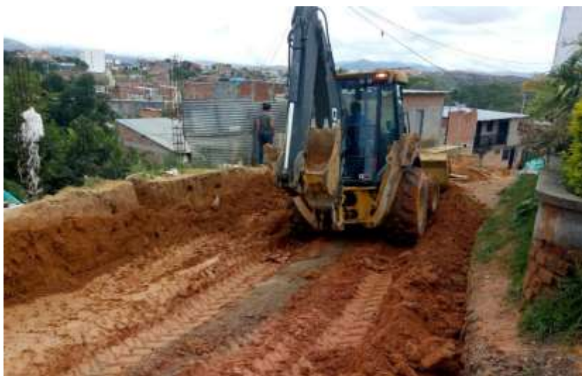
Figura 32. Excavación mecánica sin clasificar, pavimentación Brisas del Polaco
