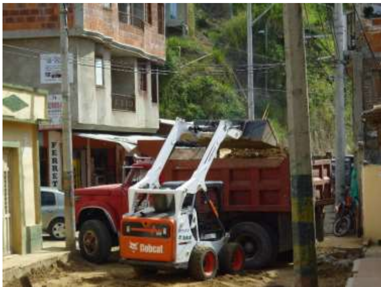
Figura 108. Retiro de sobrantes, pavimentación Brisas del Polaco.
