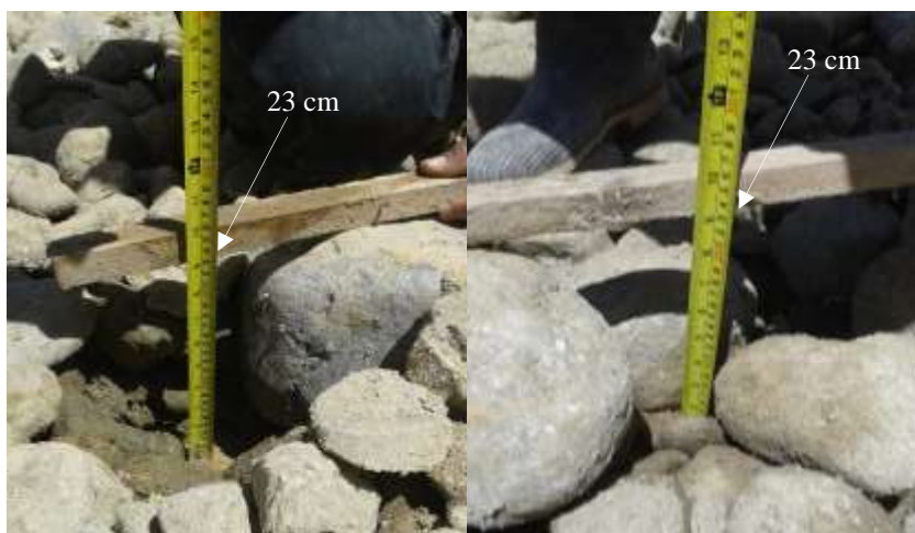
Figura 35. Verificación de material, pavimentación Brisas del Polaco
