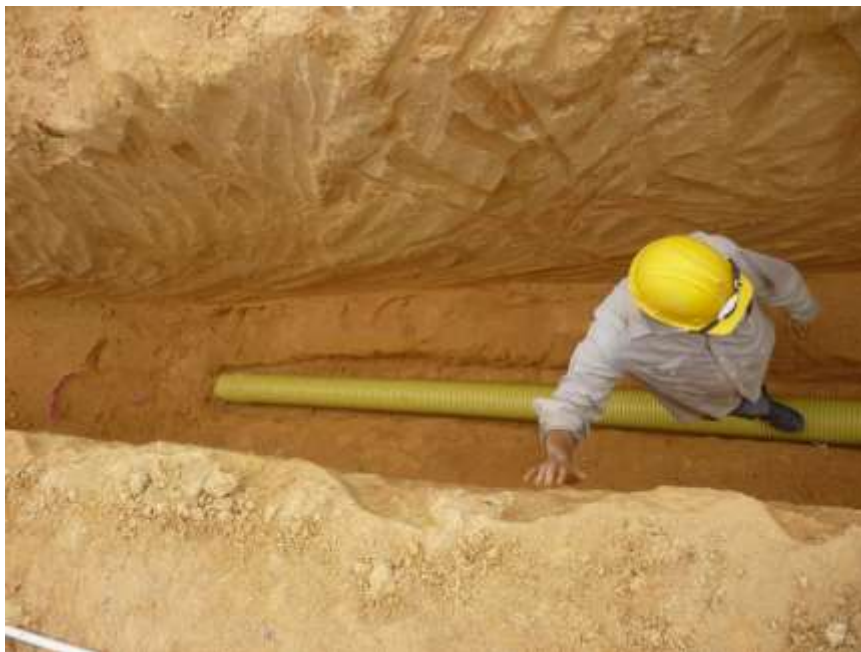
Figura 15. Colchón para tubería alcantarillado Brisas del Polaco.
