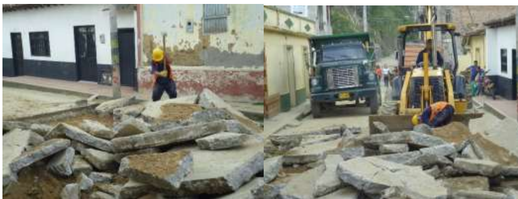
Figura 76. Demolición de pavimentos, Tejarito.
