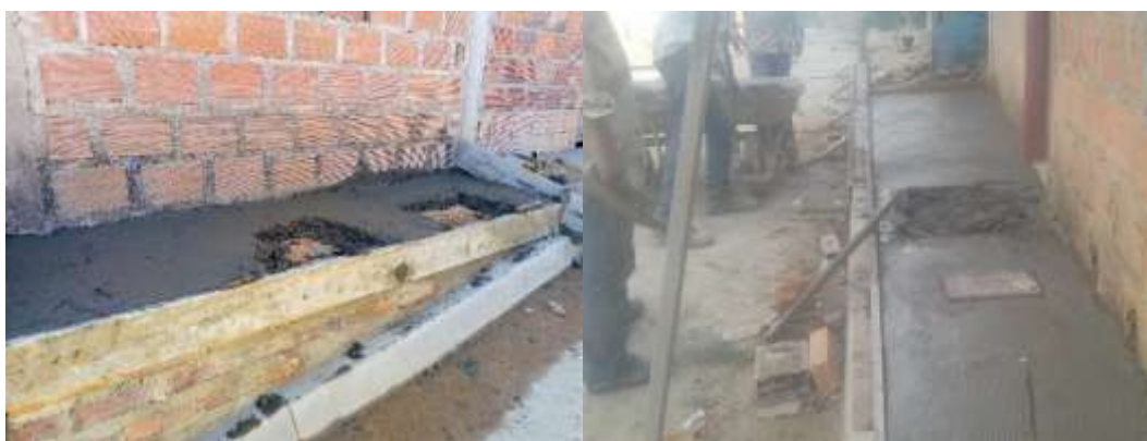
Figura 56. Andenes, pavimentación Brisas del Polaco.
