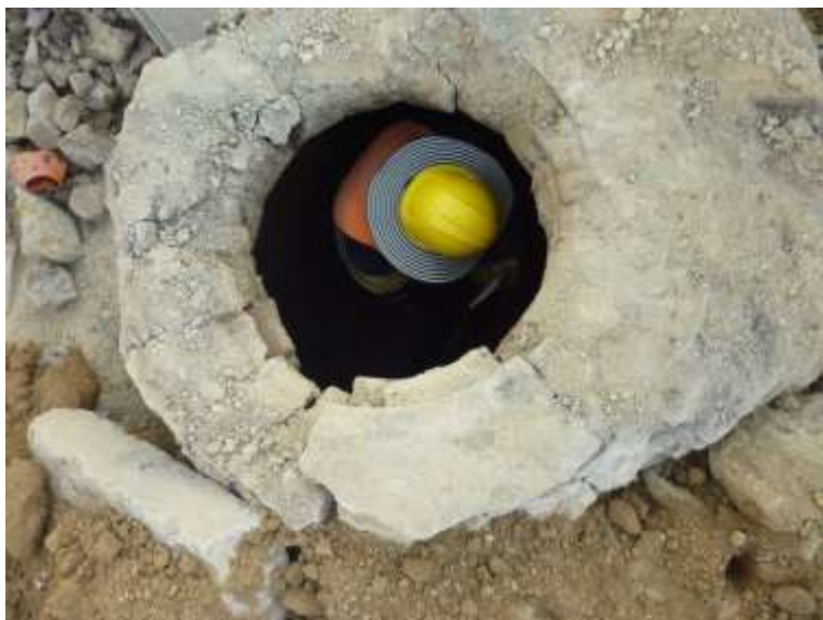
Figura 104. Mantenimiento de pozo de inspección, alcantarillado Tejarito.
