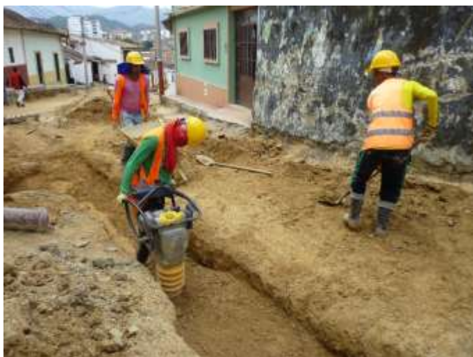
Figura 107. Compactación manual con canguro, alcantarillado Tejarito.
