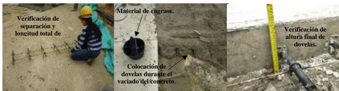
Figura 46. Verificación de pasa juntas, pavimentación Brisas del Polaco.
