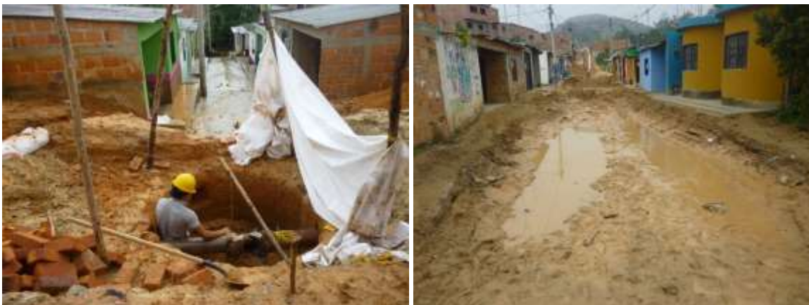
Figura 11. Condiciones climáticas de lluvia durante excavación alcantarillado Brisas del Polaco.
