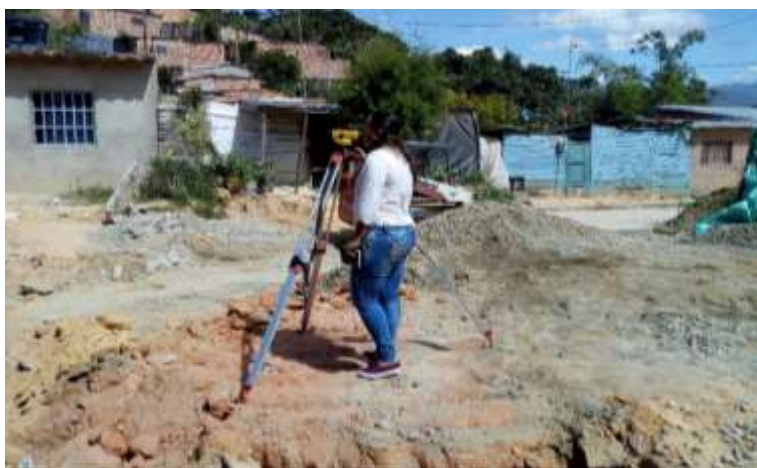
Figura 30. Localización y replanteo pavimentación Brisas del Polaco.
