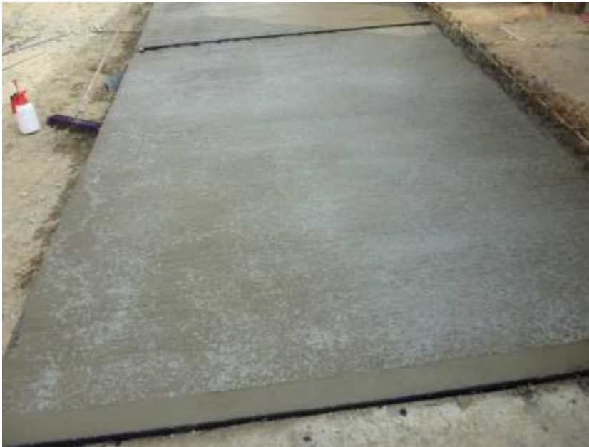
Figura 50. Aplicación de curador Sika Antisol blanco sobre losa, pavimentación Brisas del Polaco.
