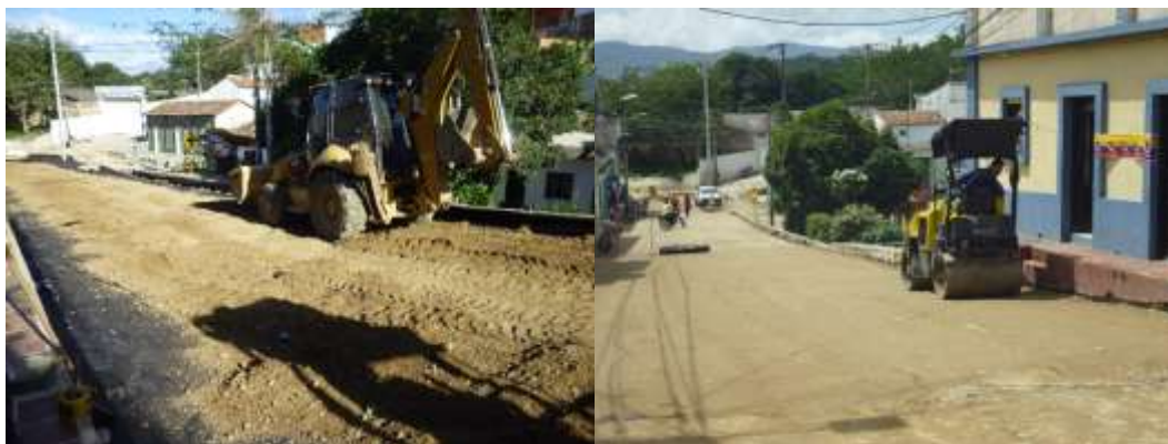
Figura 84. Instalación y compactación de base, pavimentación Tejarito.
