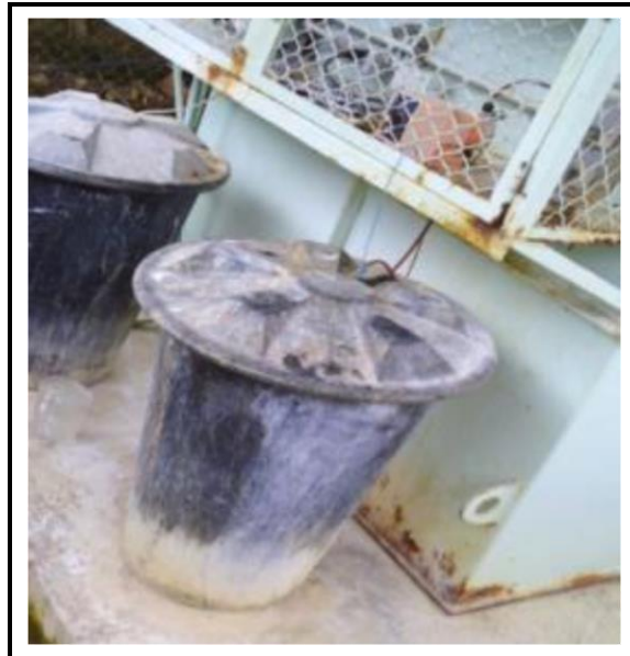
Fotografía 10. Tanque donde se diluye el sulfato de aluminio.
