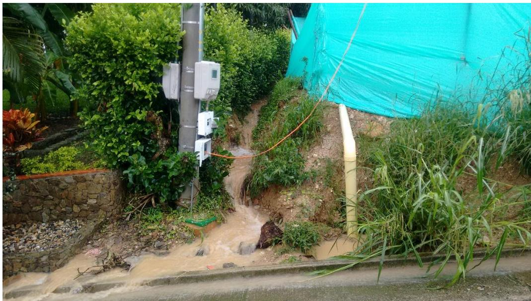
**Figura 49. Condiciones de disposición final del caudal a la vía.**
