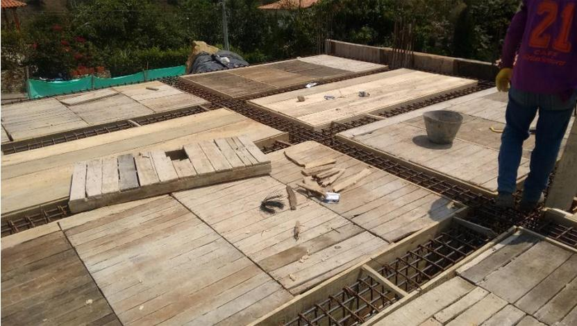
**Figura 35. Adecuado encofrado de losas de entrepiso.**
