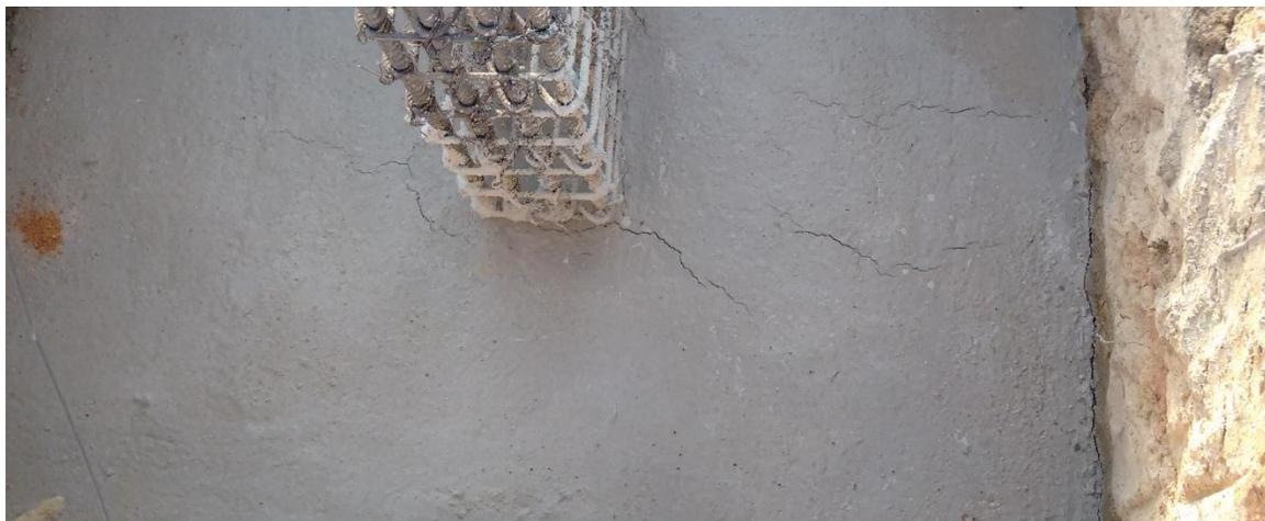
**Figura 25. Fisuras en el concreto zapatas.**
