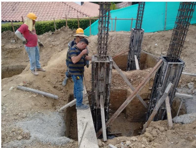
**Figura 33. Verificación de aplome de columnas.**
