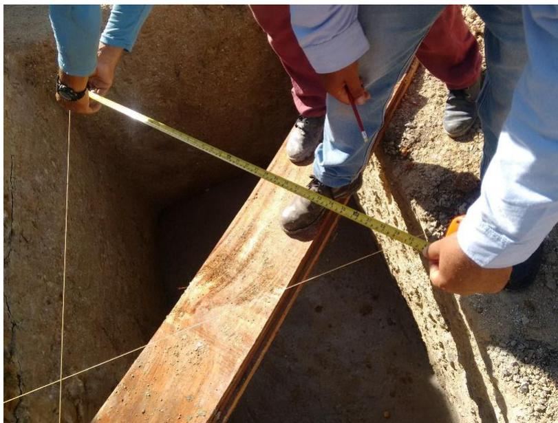
**Figura 32. Verificación pitagórica de la escuadra de los ejes de columnas.**
