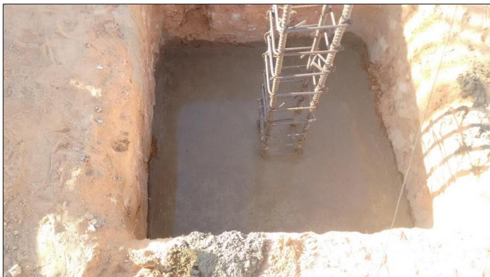
**Figura 26. Proceso de curado implementado para el concreto de zapatas.**
