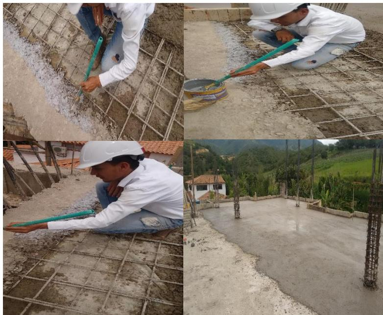
**Figura 24. Proceso de instalación de productos sika en las juntas frías.**
