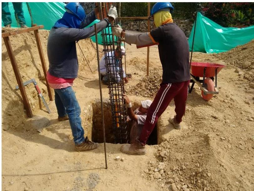
**Figura 31. Verificación del nivel del acero de columnas para garantizar un adecuado recubrimiento lateral.**
