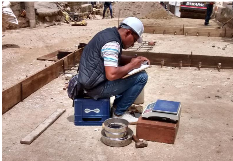
Figura 8. Ensayo de densidad para subbase granular Tramo Santa Ana
