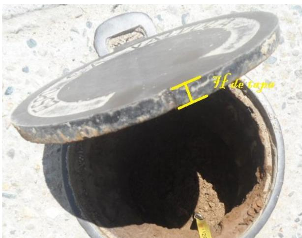
Foto 3. H Tapa (Espesor de la Tapa).
