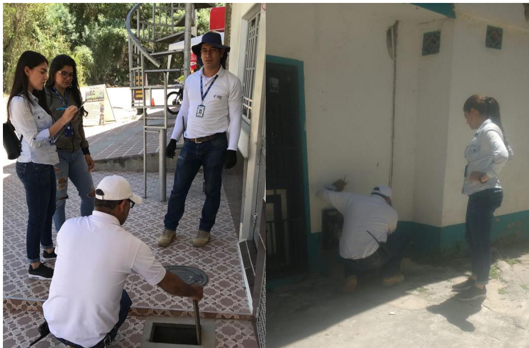
Figura 8. Revisión de acometidas en compañía de inspectores.
