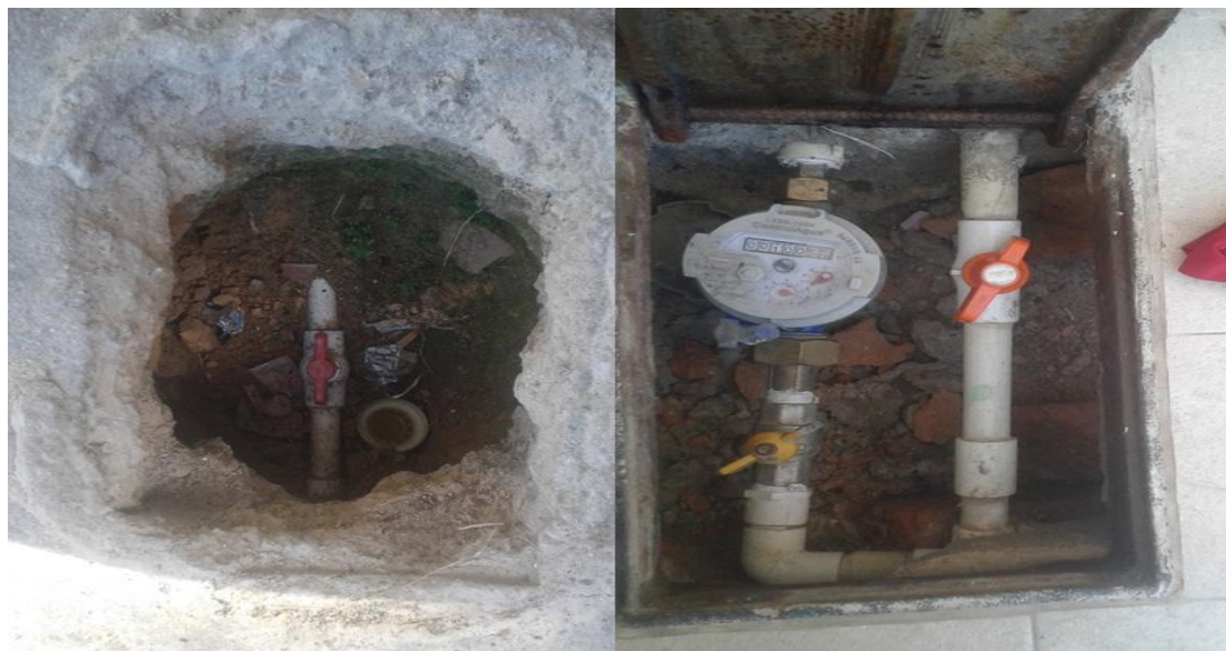
Figura 20. Conexiones de tipo directa.
