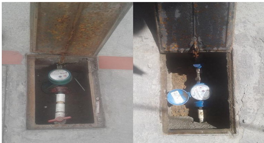
Figura 17. Acometidas en suspensión.
