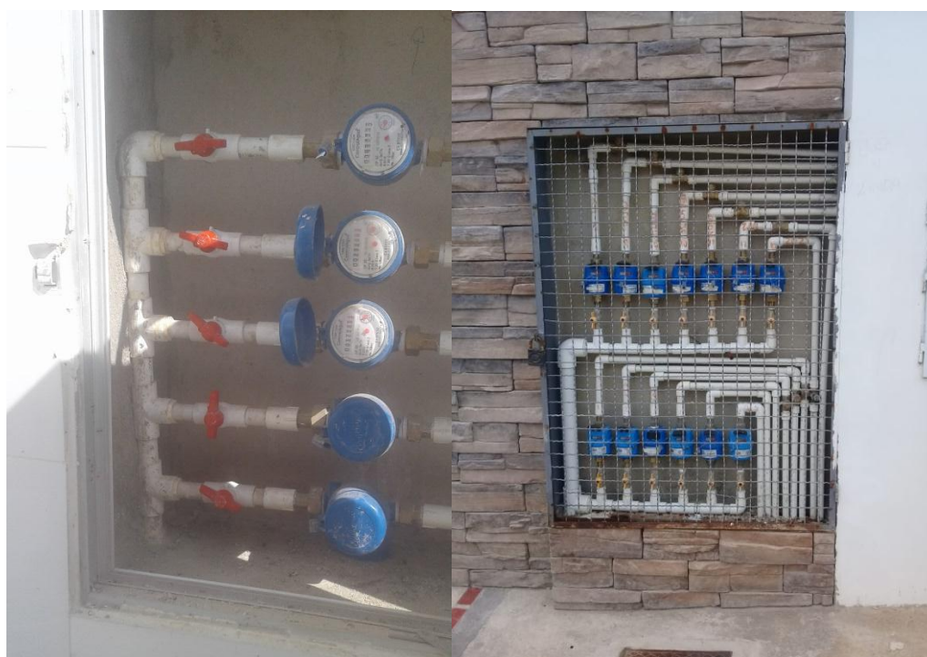
Figura 18. Conexiones de tipo derivadas.
