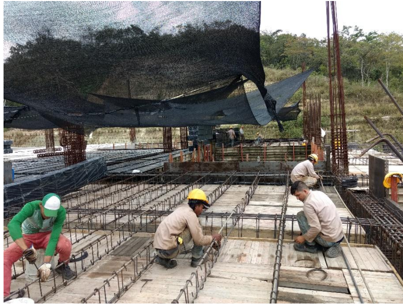
Figura 9. Armado de viguetas
