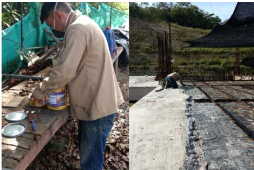
Figura 17. Preparación y aplicación del adhesivo Sikadur-32 Primer Fuente. Autor,2019.
