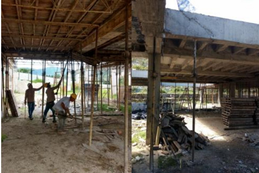
Figura 22. Descimbrado de la placa
