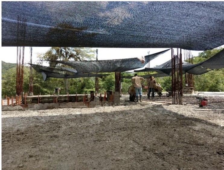
Figura 16. Fundición placa de entrepiso
