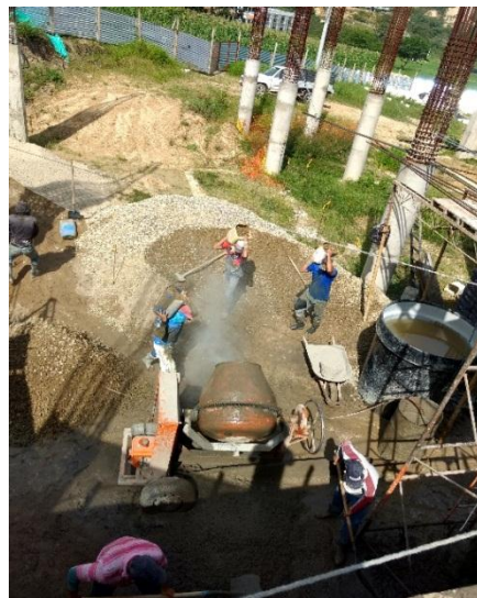
Figura 14. Preparación del concreto para placa
