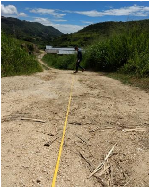
Figura 41. Inspección visual tramo de vía bodega- proyecto avícola
