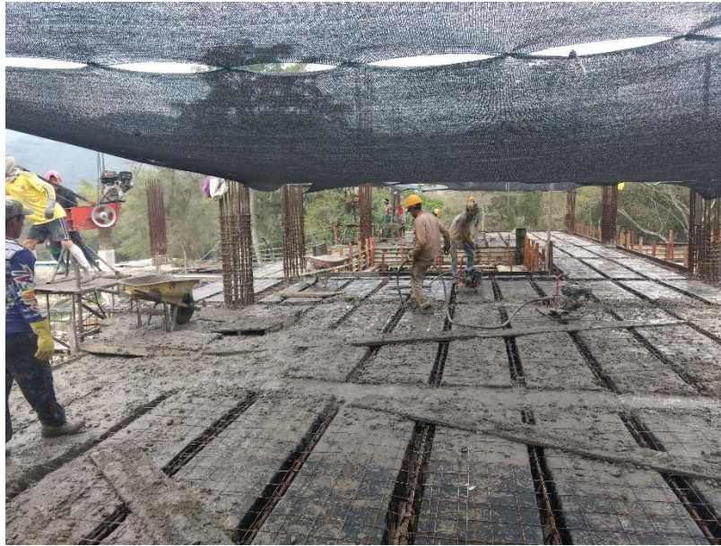
Figura 15. Vaciado y vibrado de concreto en vigas principales
