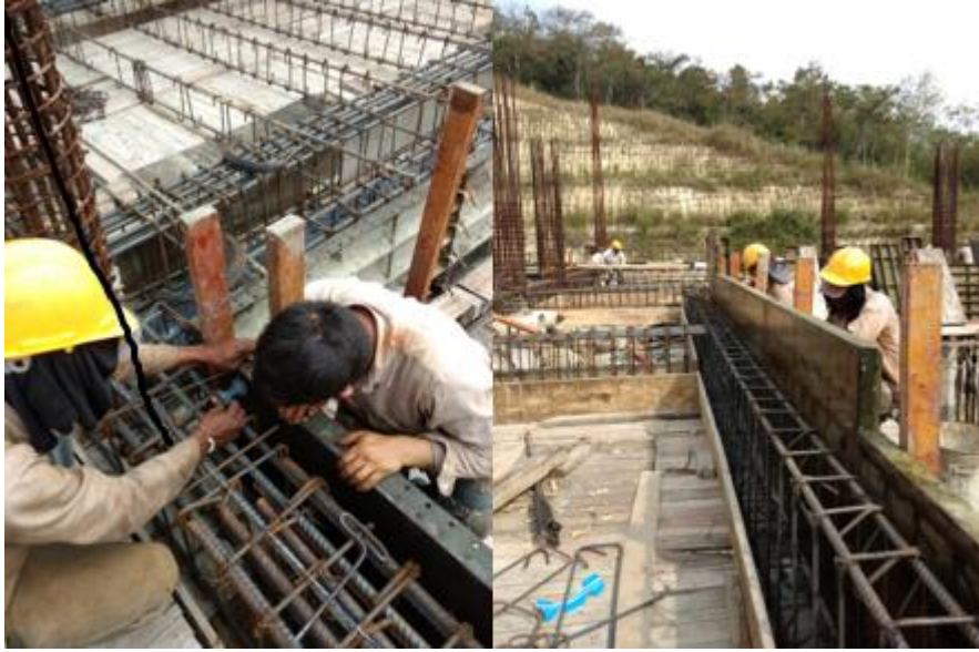
Figura 8. Fijación y aplomado de formaleta metálica
