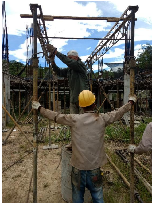
Figura 4. Armado de cimbra de placa
