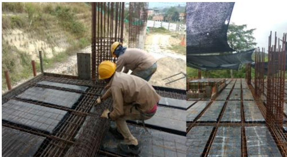
Figura 12. Tendido y amarrado de malla electrosoldada
