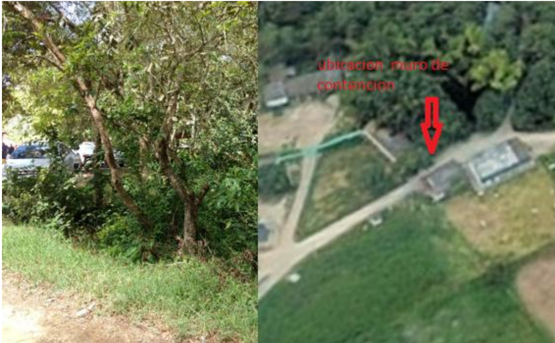
Figura 39. Localización de muro de contención
