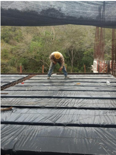
Figura 11. Adecuación y ajuste de casetones con alambre de amarre
