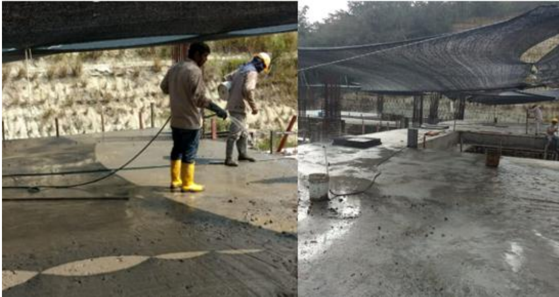
Figura 20. Curado de la placa
