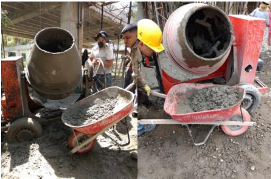
Figura 19. Extracción de muestras de concreto
