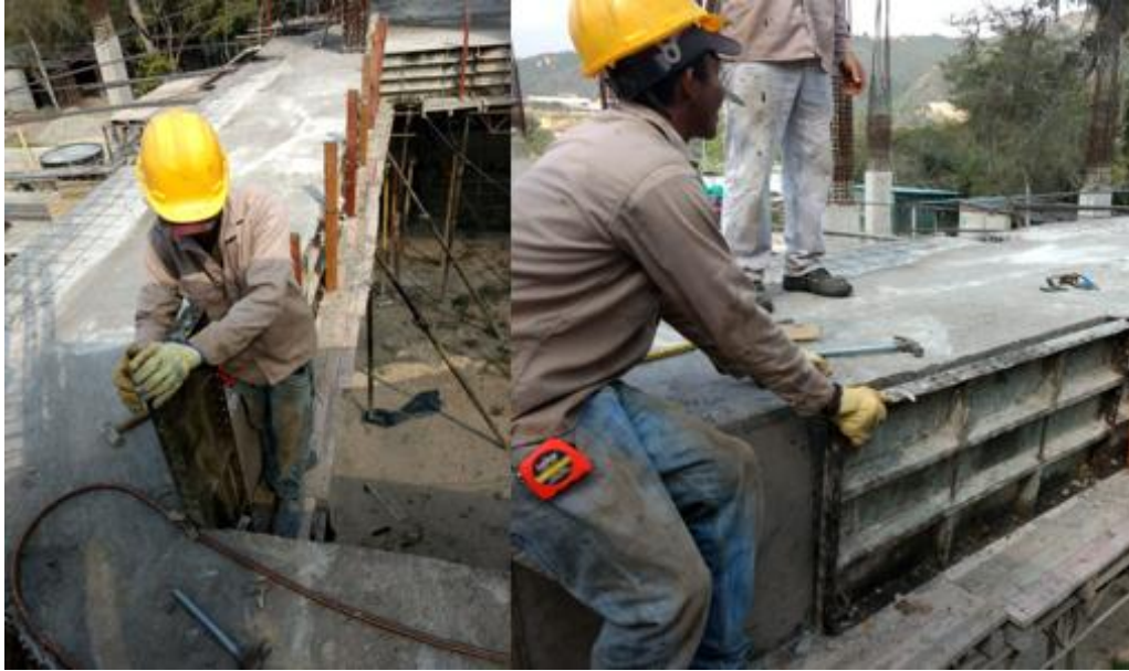
Figura 21. Retiro de formaleta metálica en vigas
