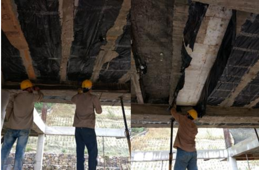
Figura 23. Retiro de casetones de la placa
