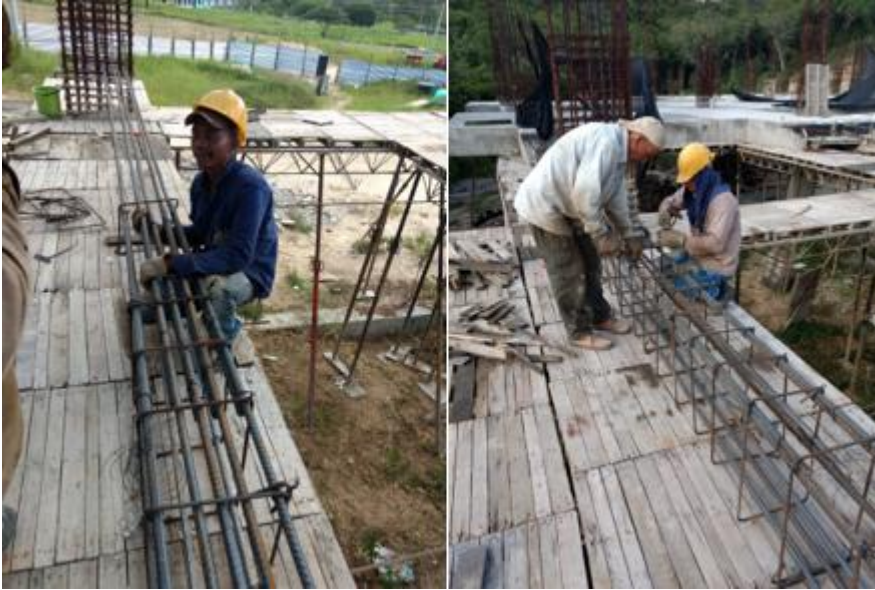
Figura 6. Armado de vigas principales
