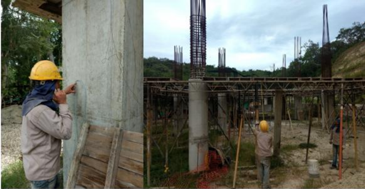
Figura 5. Nivelación de cimbrado mediante manguera de nivel
