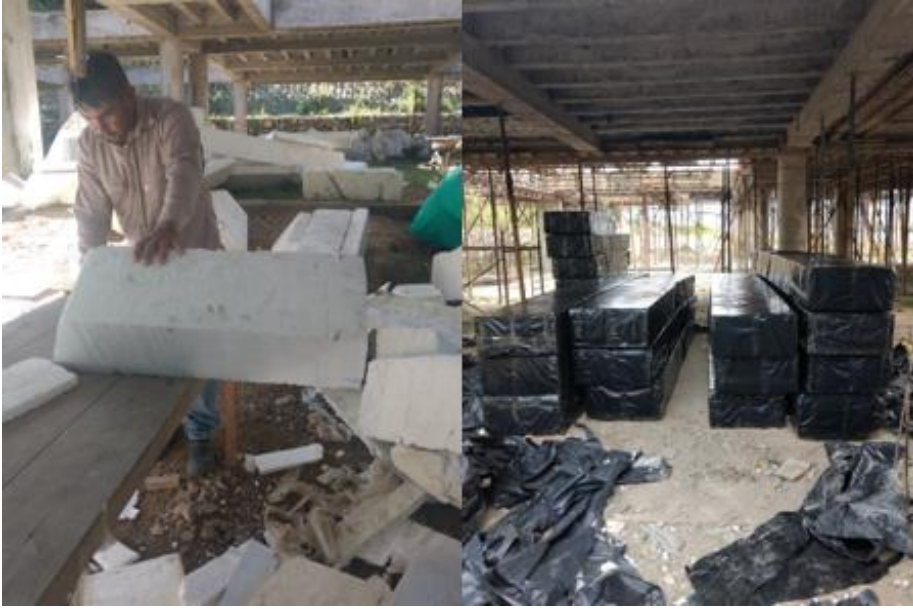
Figura 10. Elaboración de casetones en obra
