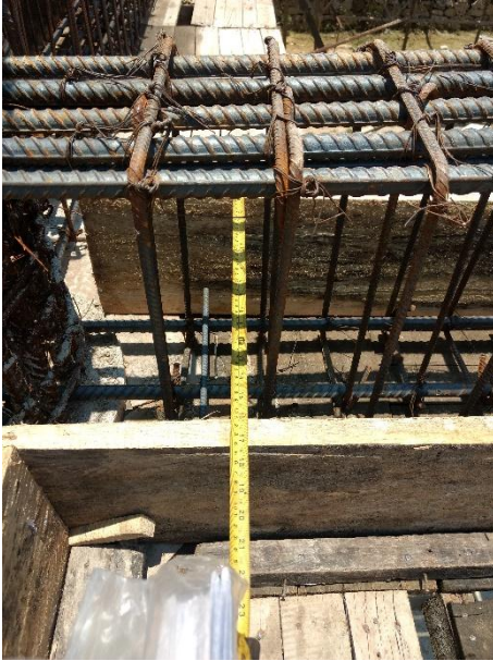
Figura 7. Formaleta de madera en vigas principales interiores
