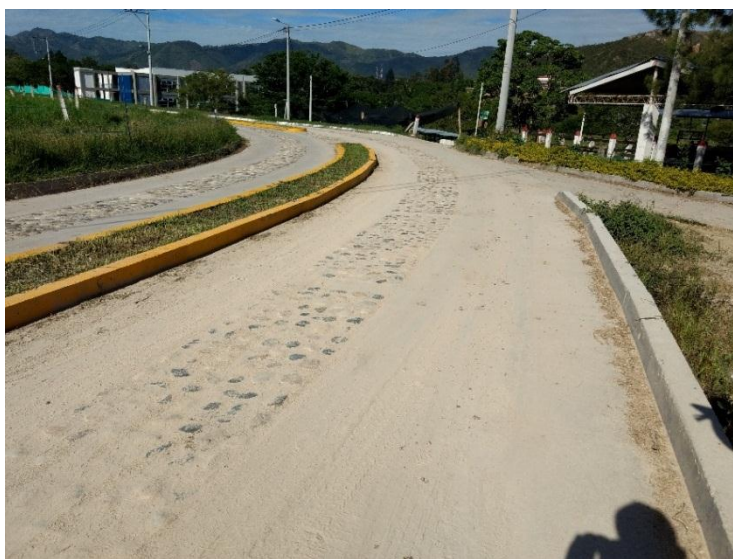
Figura 40. Tramo de placa huella existente
