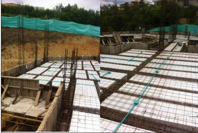
Figura 91. Instalación malla electrosoldada.
