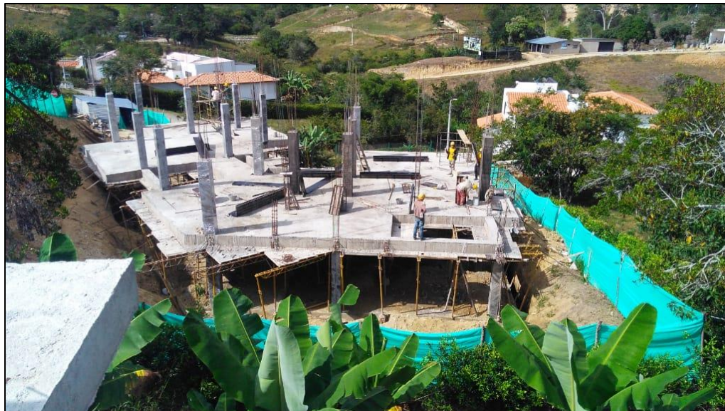
Figura 101. Vista general del proyecto.
