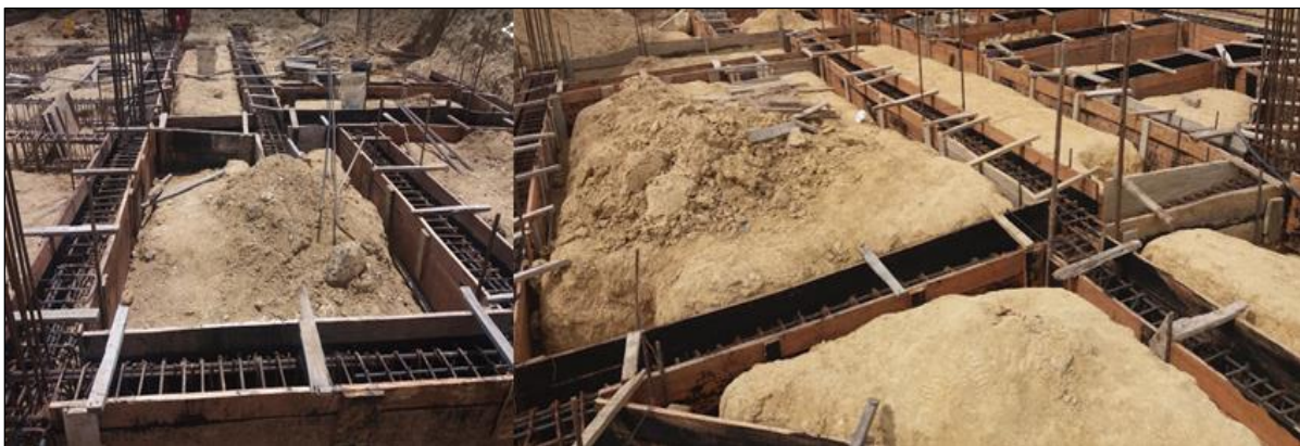
Figura 58. Formateado vigas de cimentación.
