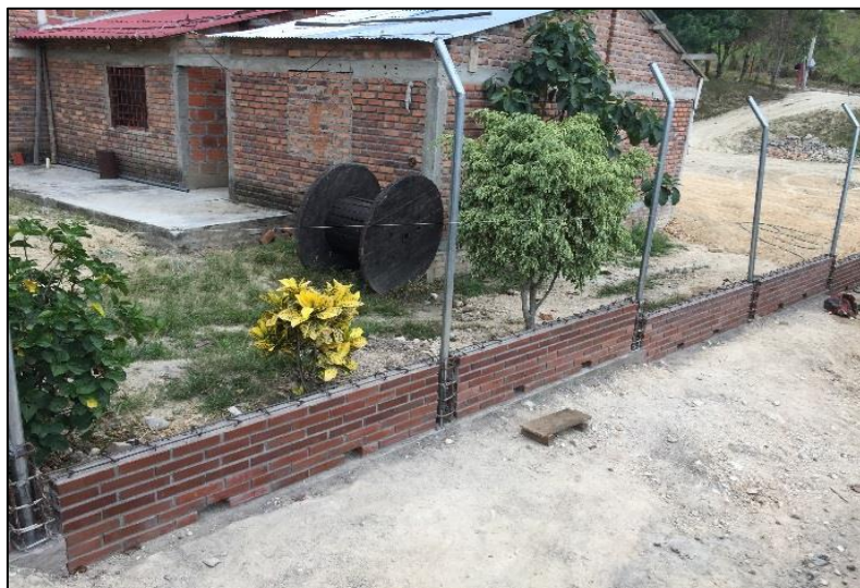
Figura 144. Instalación tubo galvanizado.
