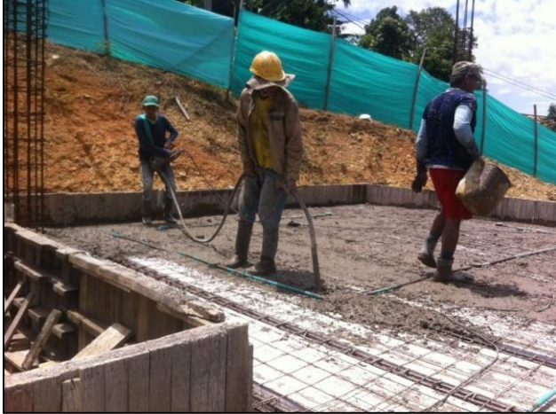
Figura 95. Vaciado de vigas durante el vaciado.
