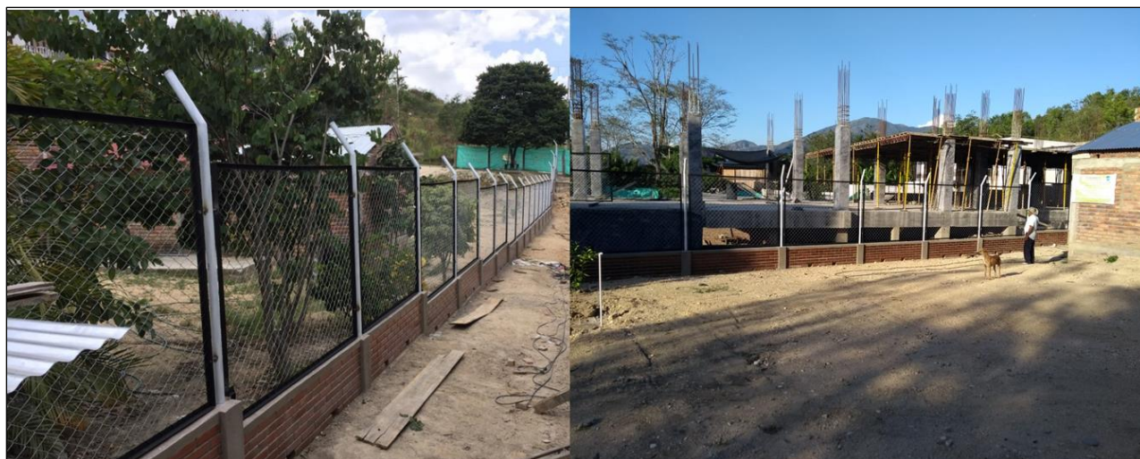
Figura 147. Muro de cerramiento culminado.
