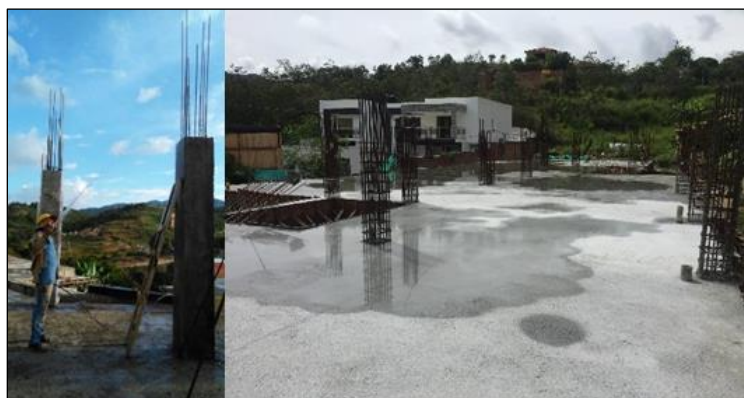
Figura 39. Curado del concreto.
