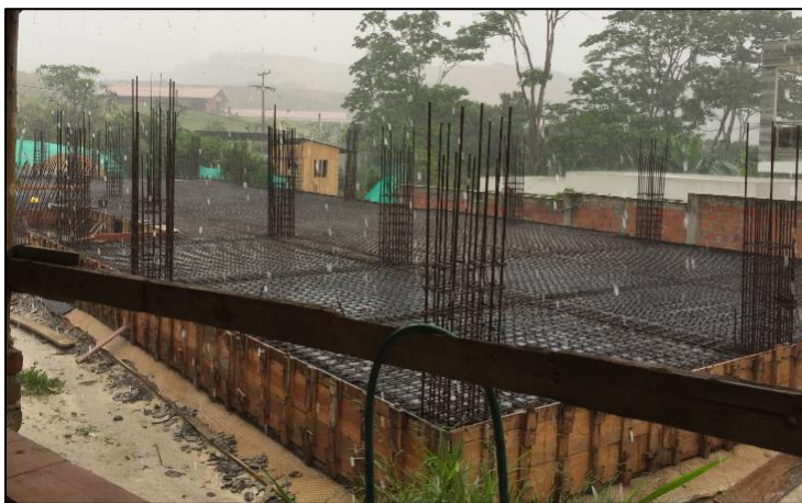
Figura 118. Culminación armado de acero del proyecto.
