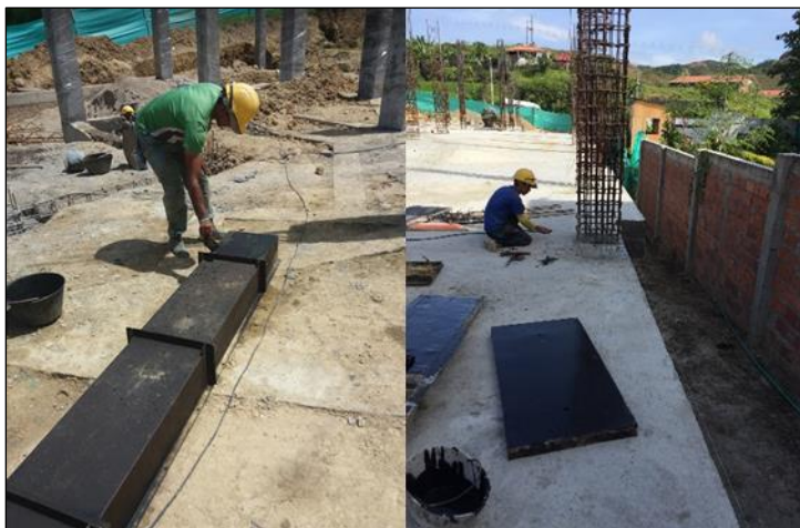
Figura 35. Aplicación de A.C.P.M a formaletas.
