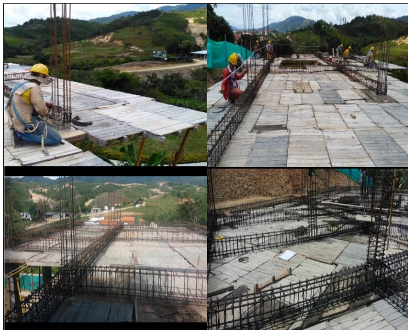
Figura 86. Armado de acero de entrepisos del proyecto.
