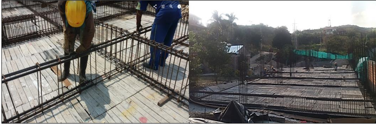
Figura 106. Armado de acero placa 1.
