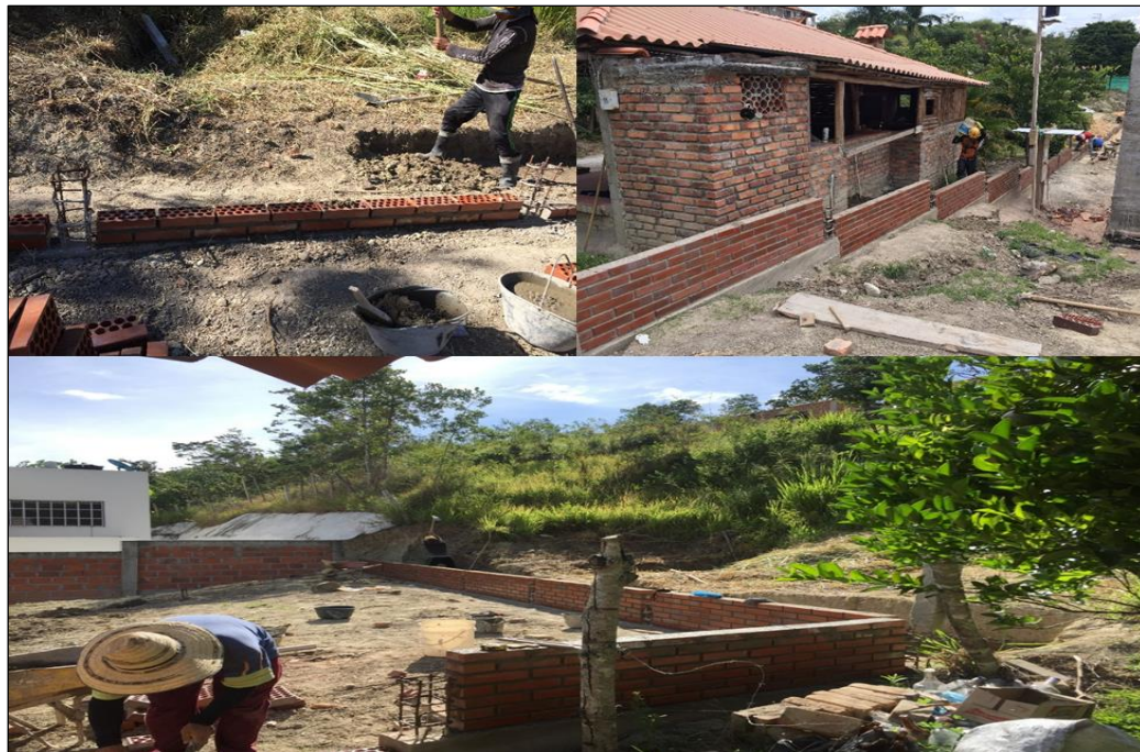
Figura 143. Levantamiento de muro en ladrillo a la vista.
