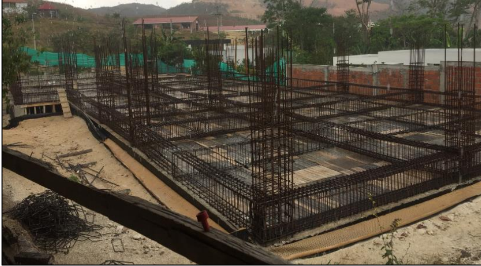
Figura 109. Culminación armado de acero placa 1.
