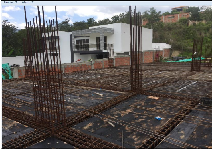
Figura 115. Aplicación aceite quemado.
