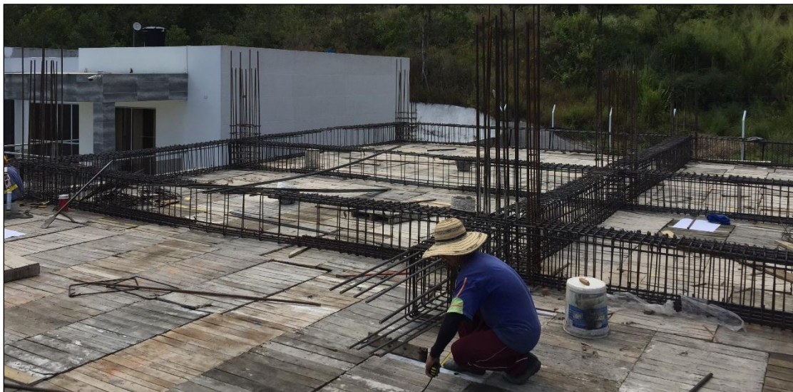
Figura 135. Armado de acero placa 2 de escuela de enfermería.
