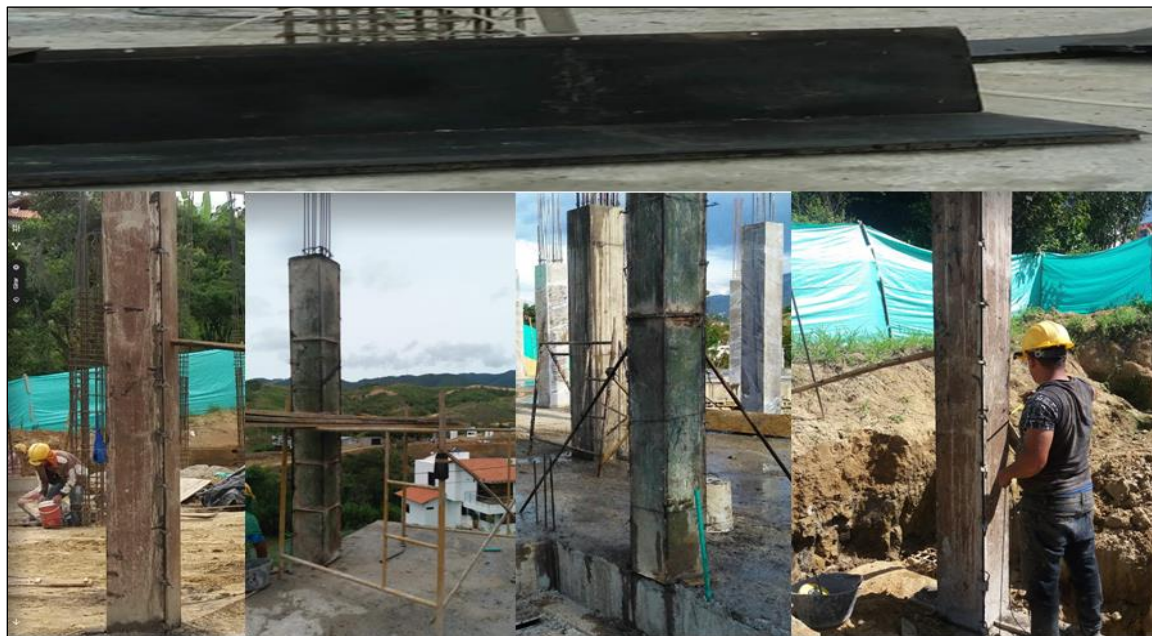
Figura 79. Encofrado de columnas.
