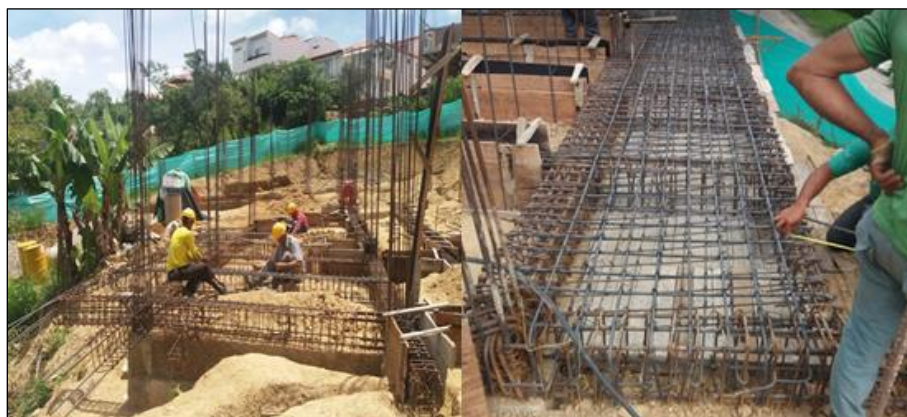
Figura 56. Armado de acero de vigas de cimentación.
