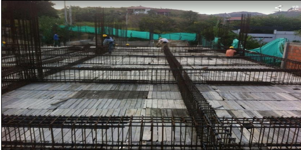
Figura 107. Avance de armado de acero.
