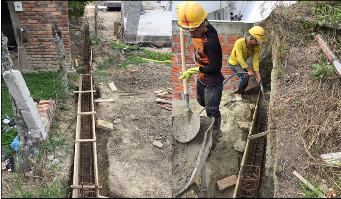
Figura 142. Encofrado y vaciado de vigas de muro de cerramiento.
