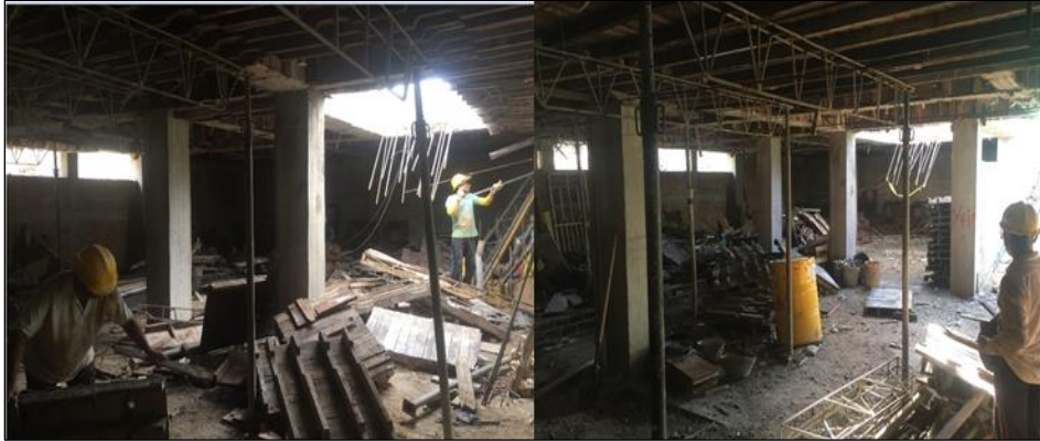
Figura 124. Desencofrado de la placa.
