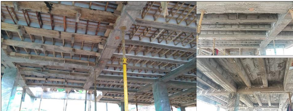
Figura 100. Retiro de encofrado.
