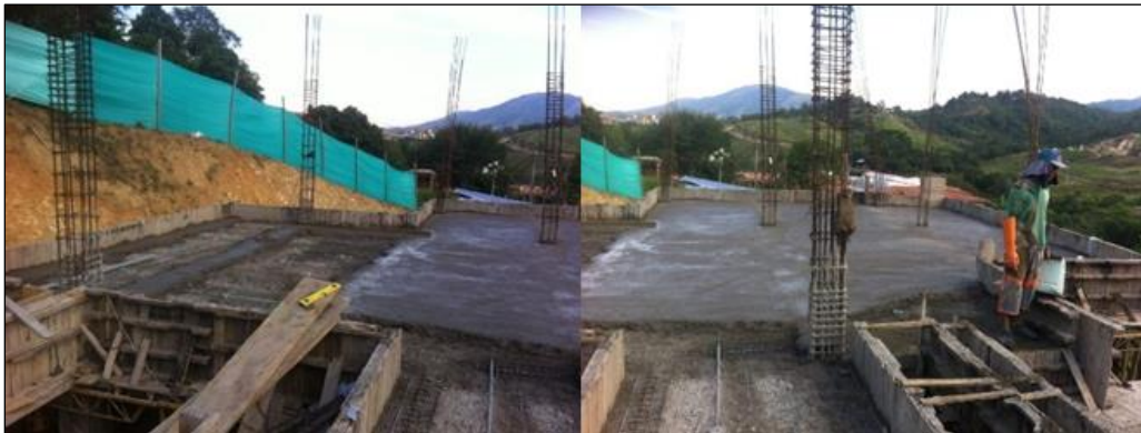
Figura 98. Vaciados loseta.
