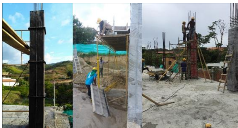
Figura 40. Encofrados.
