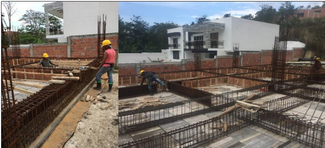
Figura 111. Encofrado vigas.
