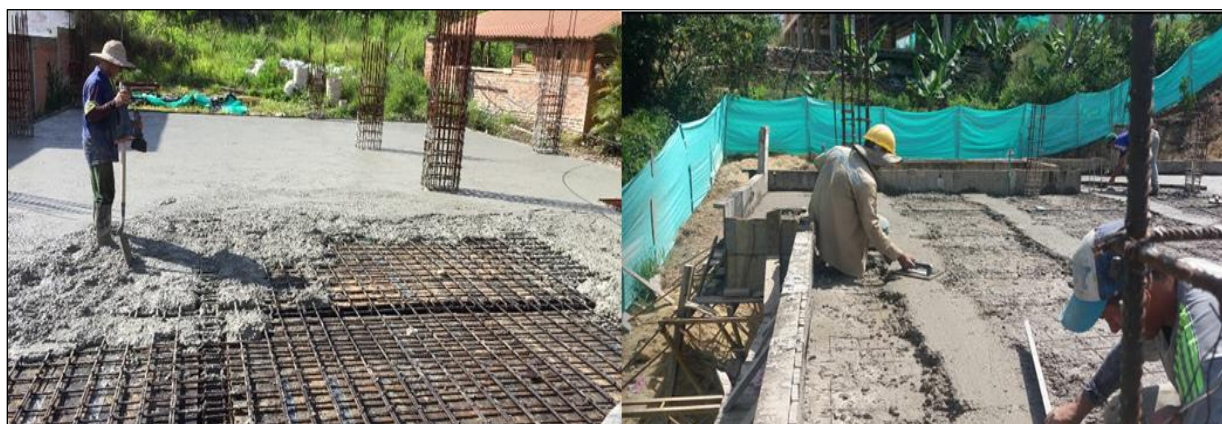
Figura 38. Colocación del concreto.
