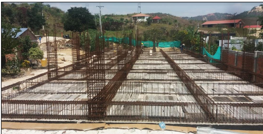
Figura 108. Avance de armado de acero placa 1.
