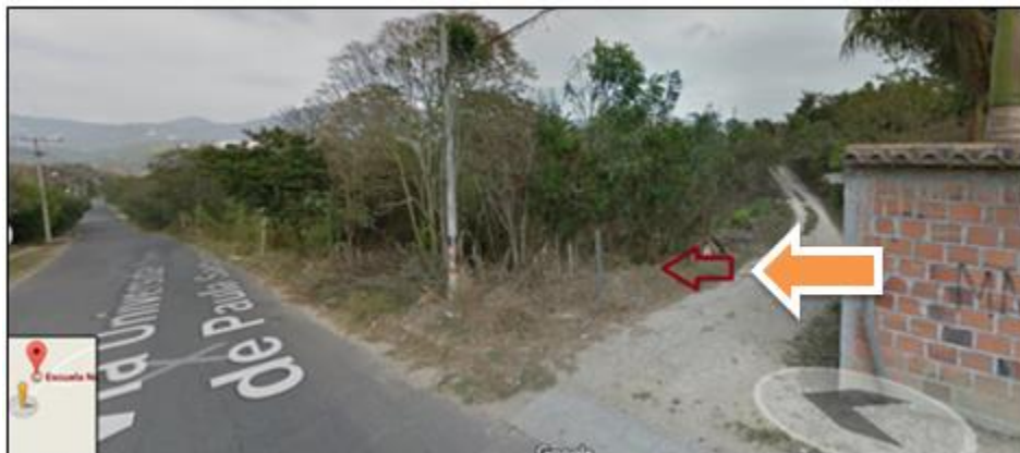
Figura 4. Ubicación específica del proyecto antes de dar inicio a su construcción.
