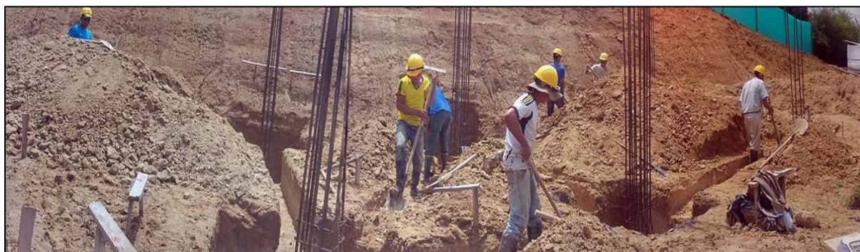
Figura 46. Excavación vigas de cimentación.
