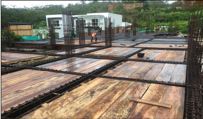
Figura 113. Parte superior de aligerante en tabla.
