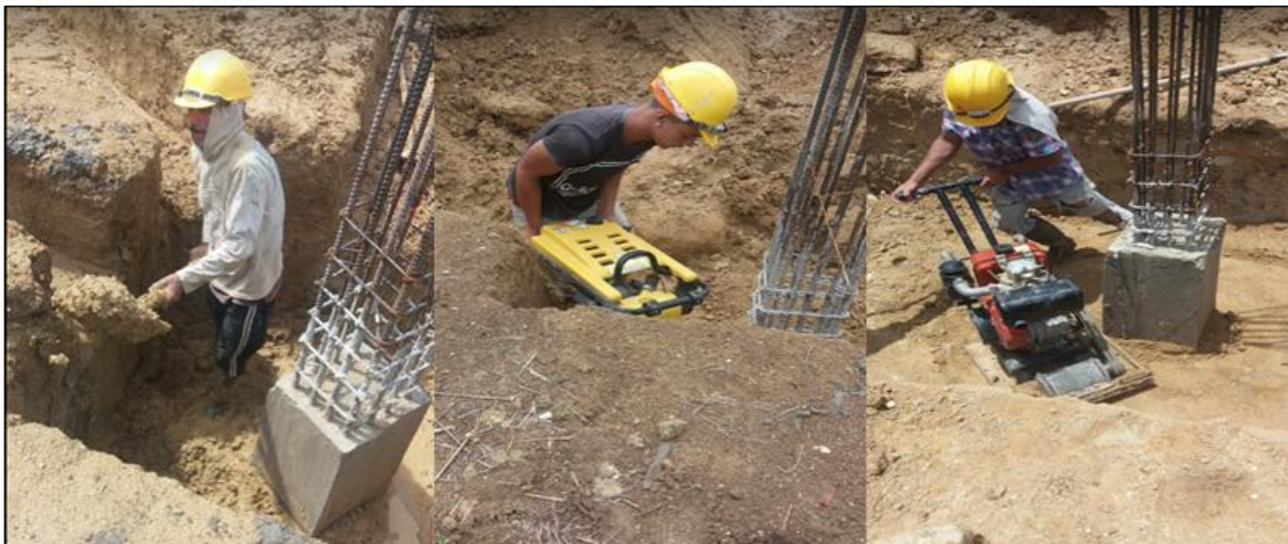
Figura 53. Compactación de zanja de zapatas.
