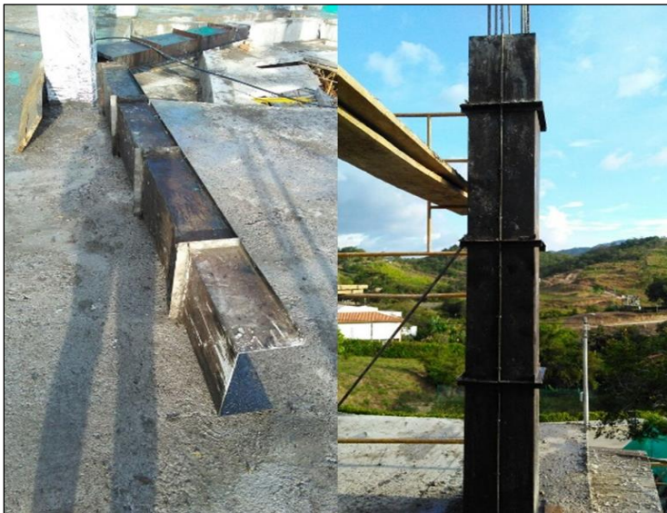
Figura 78. Encofrado columnas.
