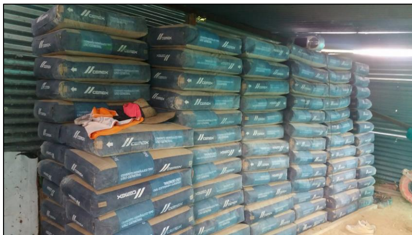
Figura 30. Almacenamiento bultos de cemento.
