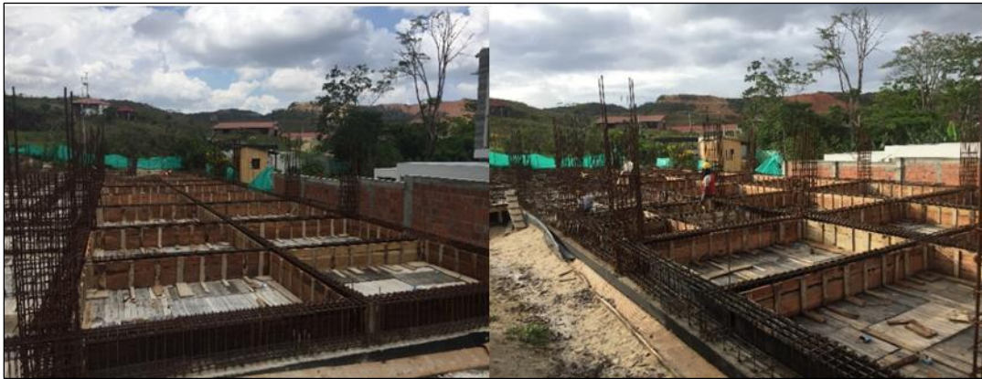
Figura 112. Avance de encofrado de vigas.
