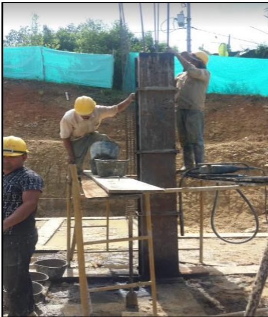
Figura 81. Vaciado de Columna.
