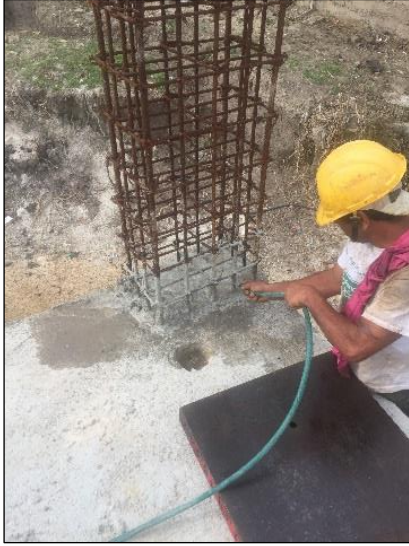
Figura 42. Juntas de construcción.
