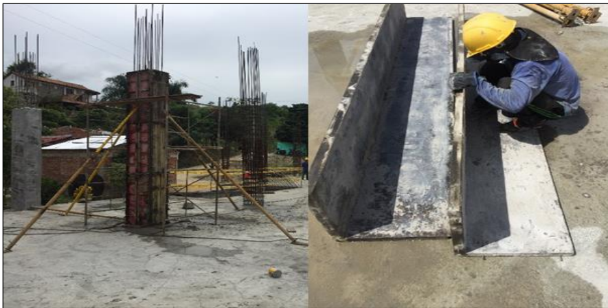
Figura 129. Formaleteado de columnas.
