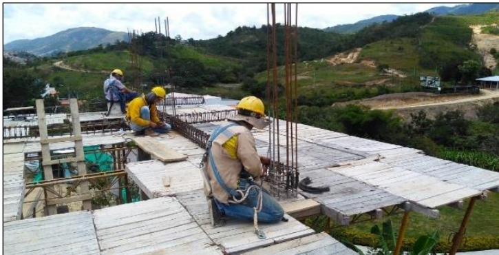
Figura 45. Colocación del acero de refuerzo.
