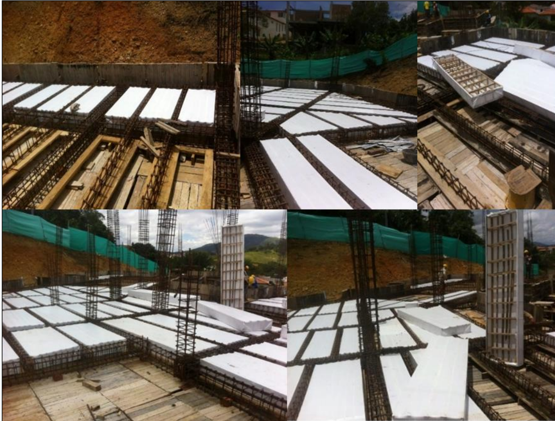
Figura 89. Colocación de casetones.
