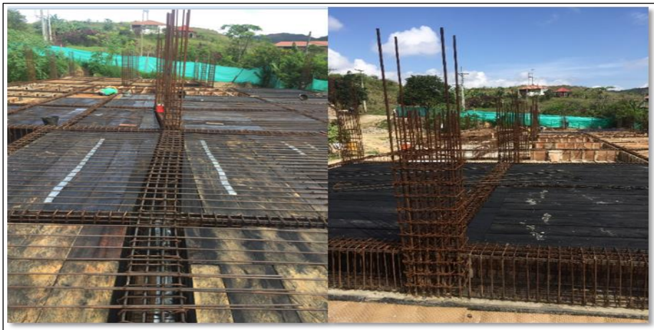
Figura 114. Aplicación de aceite quemado y A.C.P.M.
