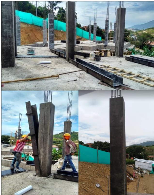
Figura 82. Retiro de encofrado de Columnas.
