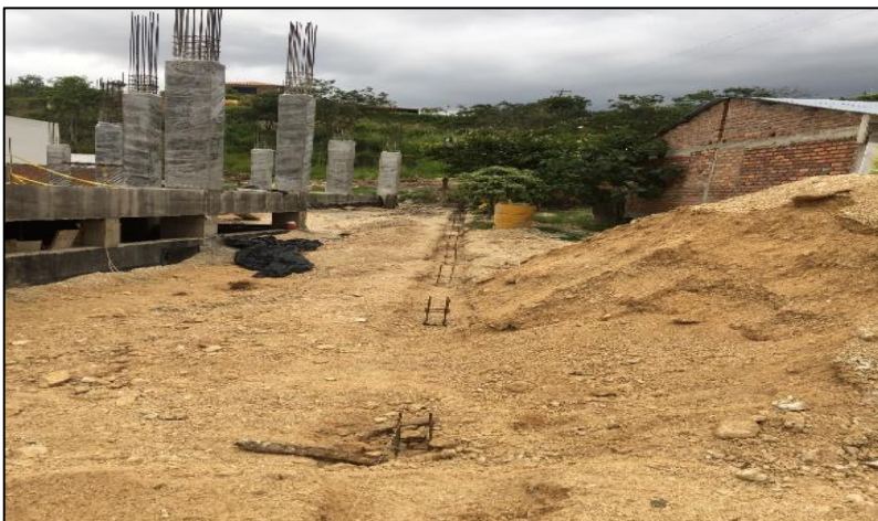
Figura 140. Relleno de zanja de zapatas.
