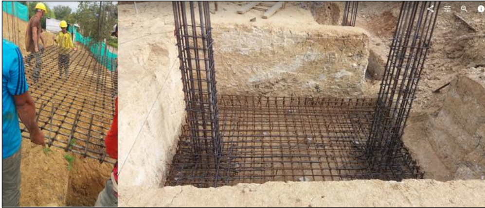
Figura 47. Colocación de parrilla.
