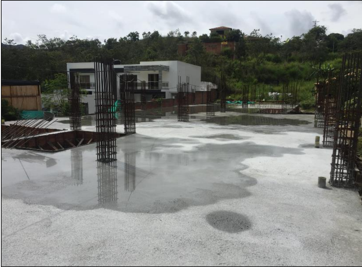
Figura 126. Placa desencofrada totalmente vista general.
