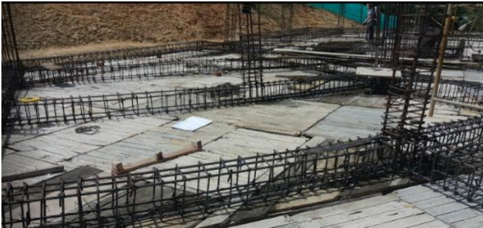
Figura 43. Acero de placa de entrepiso en cabaña 63.
