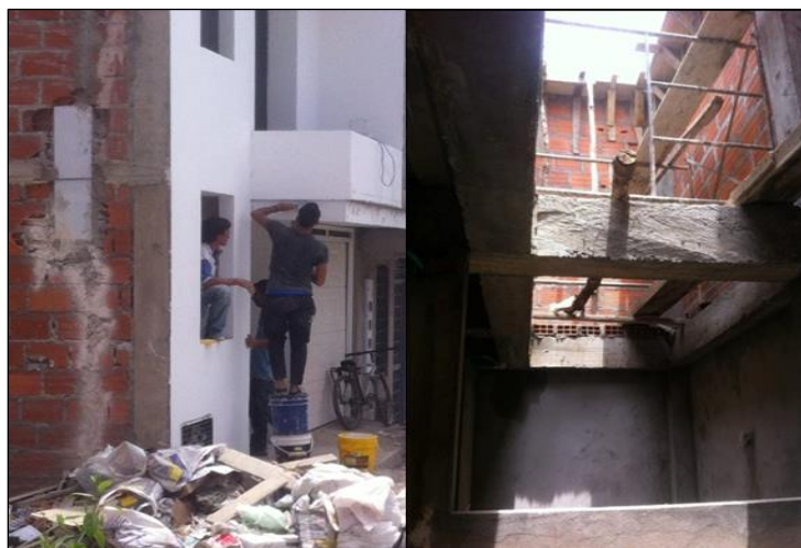
Figura 214. Inestabilidad en el trabajo.
