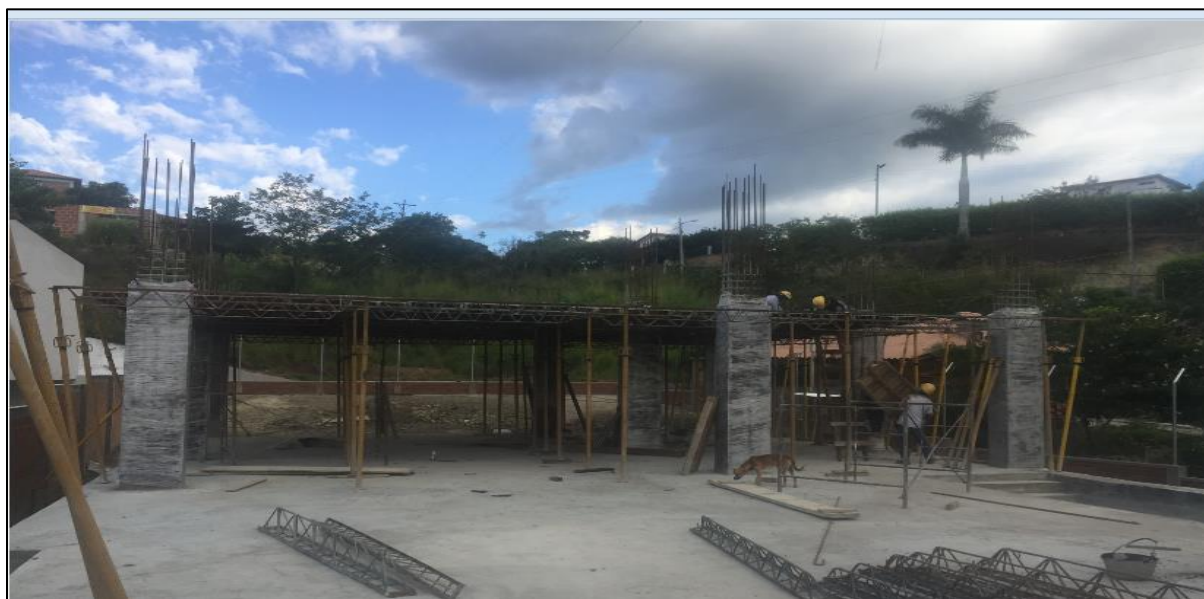
Figura 134. Encofrado placa 2.
