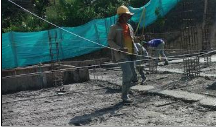
Figura 93. Vaciado de la placa.
