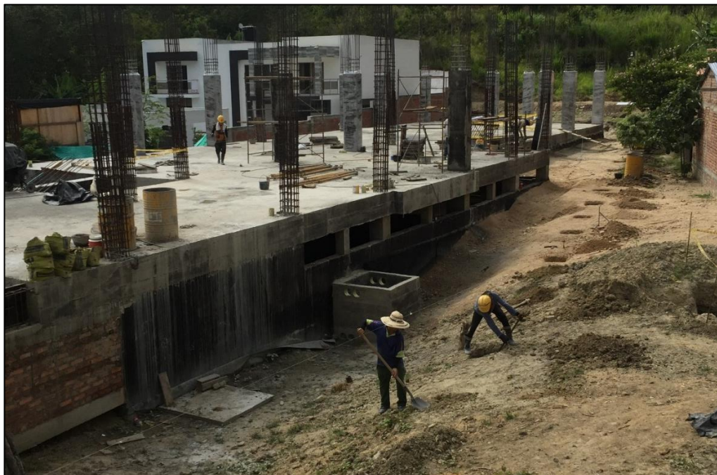
Figura 136. Excavación de zapatas para muro de cerramiento.
