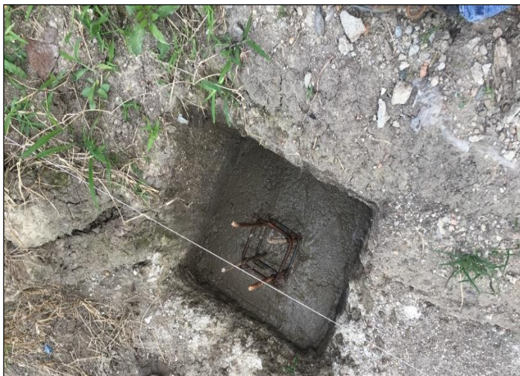
Figura 138. Vaciado de zapatas muro de cerramiento.
