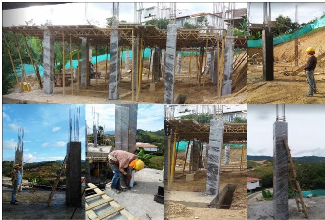
Figura 83. Curado de columnas.
