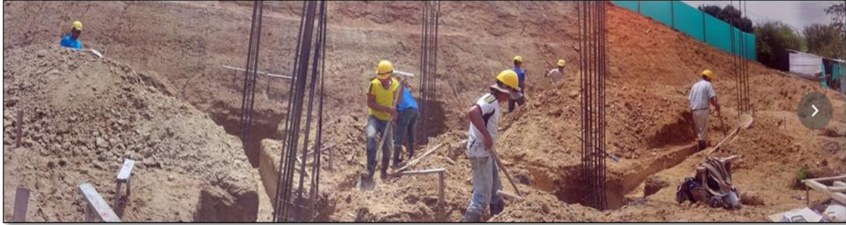
Figura 18. Estado actual del proyecto.
