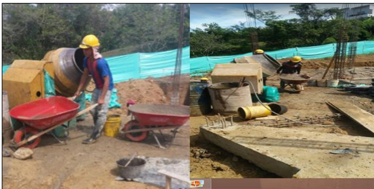
Figura 37. Transporte del concreto.
