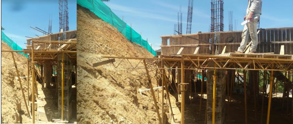
Figura 90. Instalación de Guardas.
