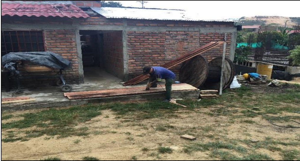
Figura 110. Demarcación y cortado de tablas.
