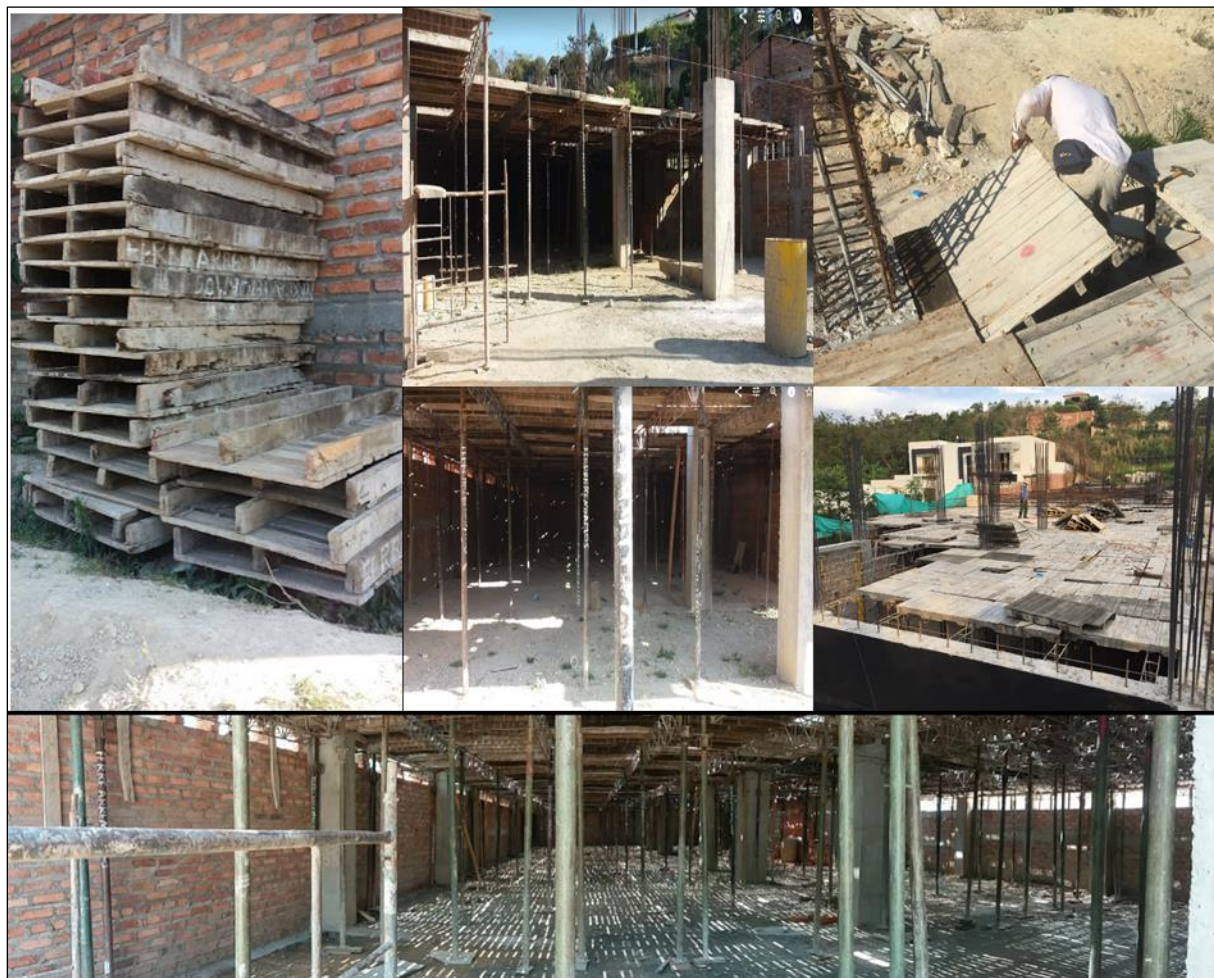
Figura 104. Encofrado de placa1 del proyecto.
