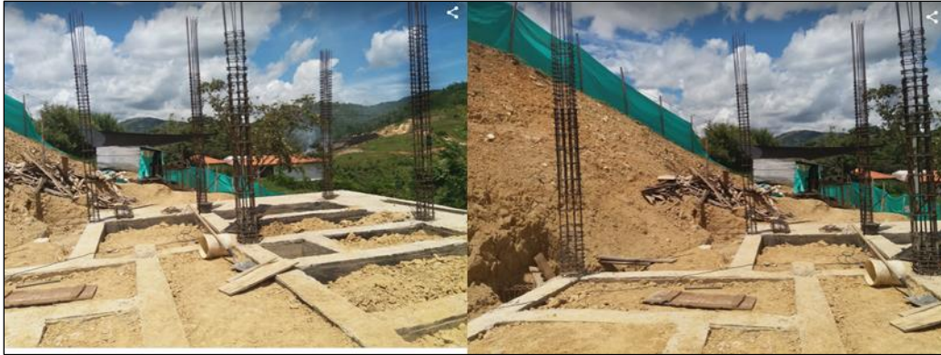
Figura 60. Retiro de encofrado vigas de cimentación.
