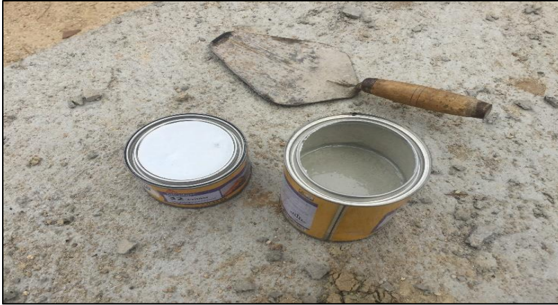
Figura 130. Aplicación de producto Sikadur-32.
