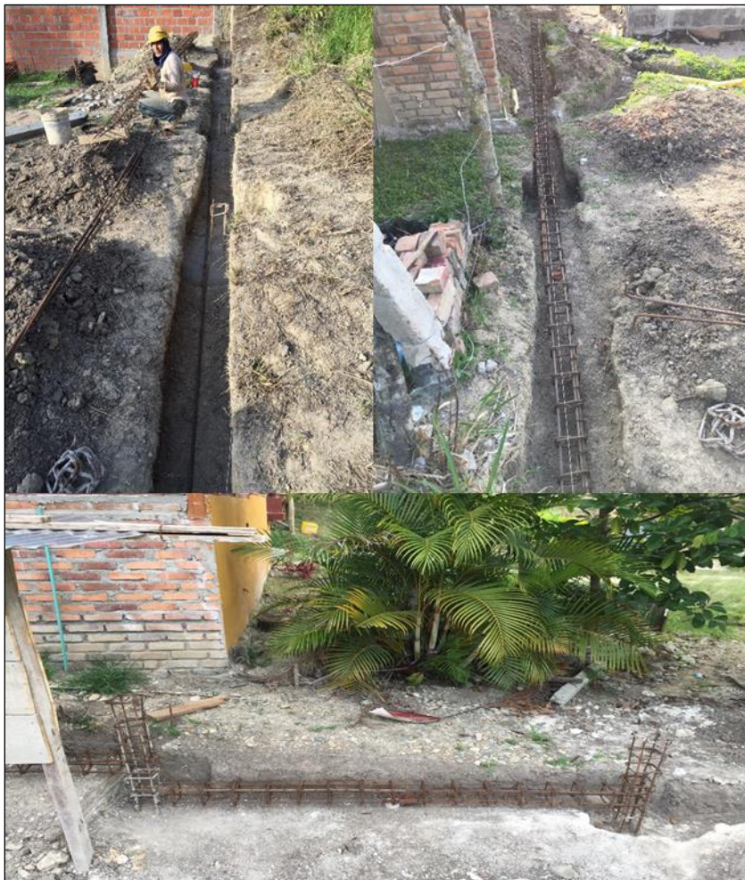
Figura 141. Armado de vigas de muro de cerramiento.
