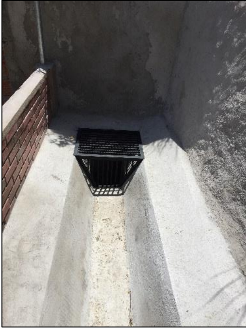
Figura 151. Instalación de rejilla en canal terminado.
