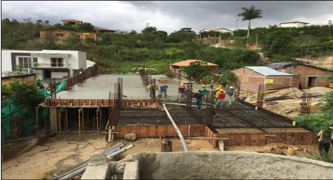
Figura 122. Vaciado de placa vista general.
