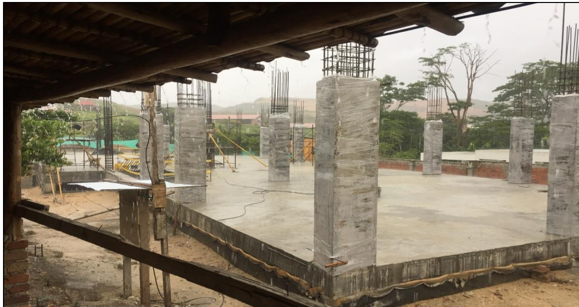
Figura 132. Avance de columnas en la escuela de enfermería.
