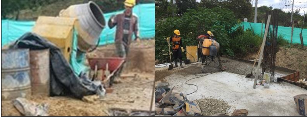
Figura 36. Mezclado del concreto.
