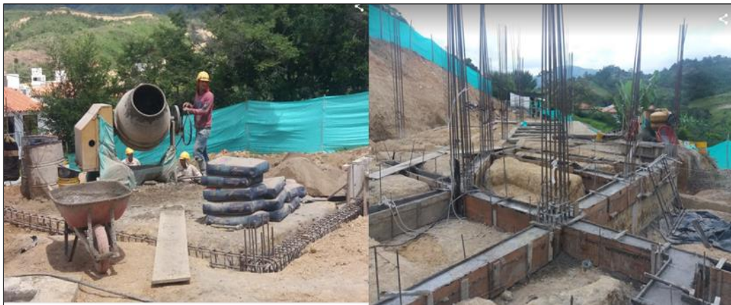
Figura 59. Vaciado vigas de cimentación.
