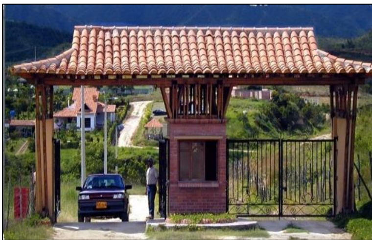
Figura 15. Portal de acceso al Condominio Campestre Torres del Cable.
