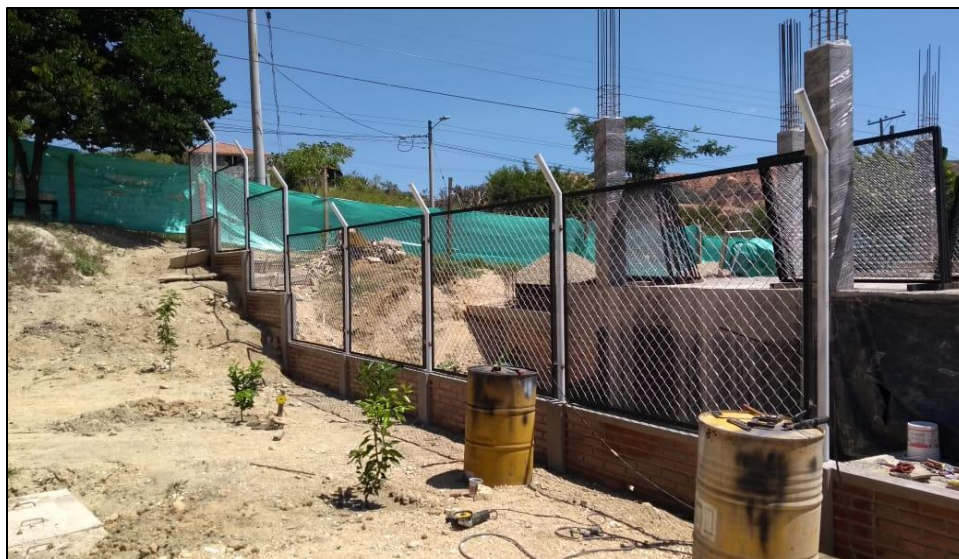
Figura 146. Instalación de la malla sobre el muro.
