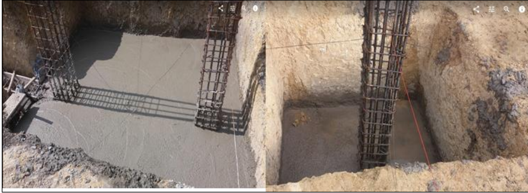
Figura 51. Vaciado zapatas Cabaña 63.
