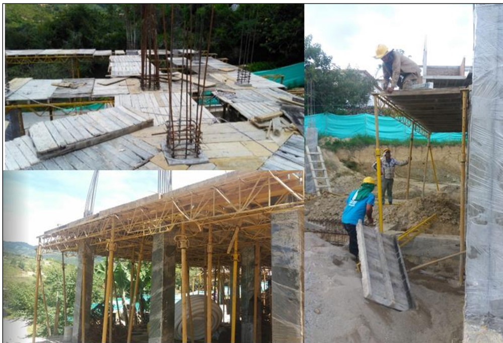
Figura 84. Encofrado de losa.
