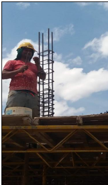
Figura 74. Armado de Columnetas.
