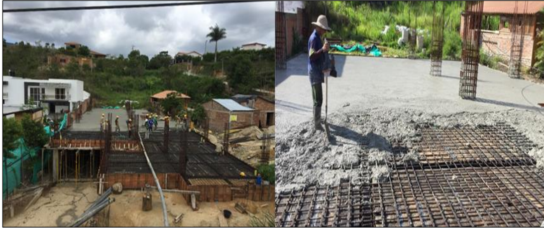
Figura 121. Vaciado de placa.
