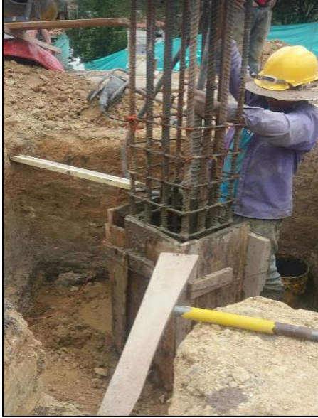
Figura 52. Vibrado durante vaciado de pedestales.
