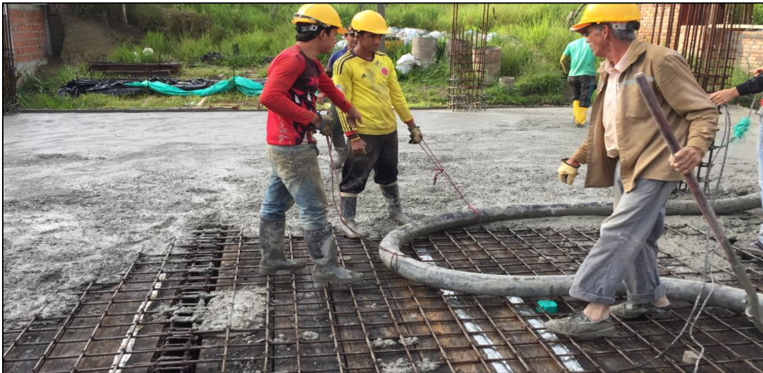
Figura 123. Trabajadores durante el vaciado de la placa.
