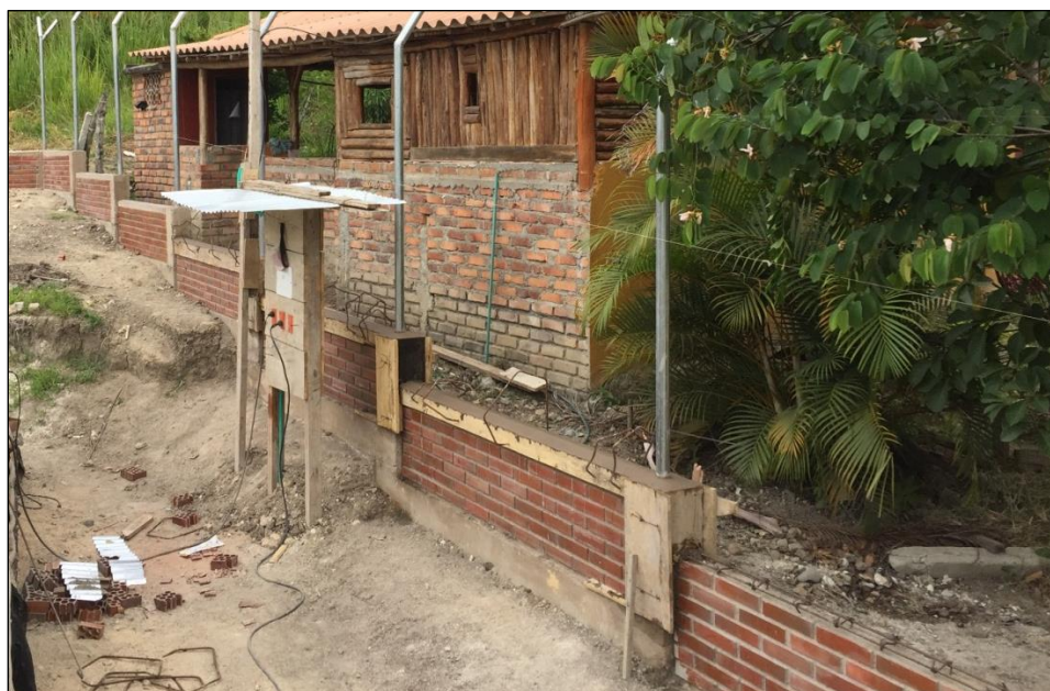
Figura 145. Vaciado viga superior y columnetas.
