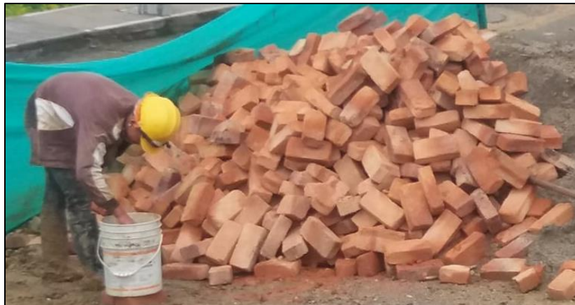
Figura 31. Almacenamiento de la mampostería inicialmente.
