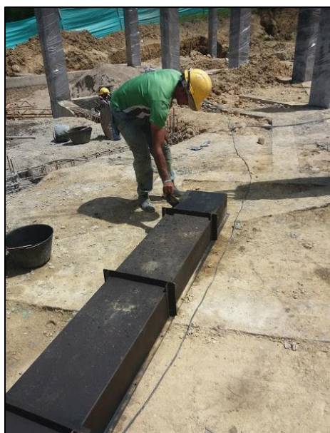
Figura 75. Instalación de la formaleta.
