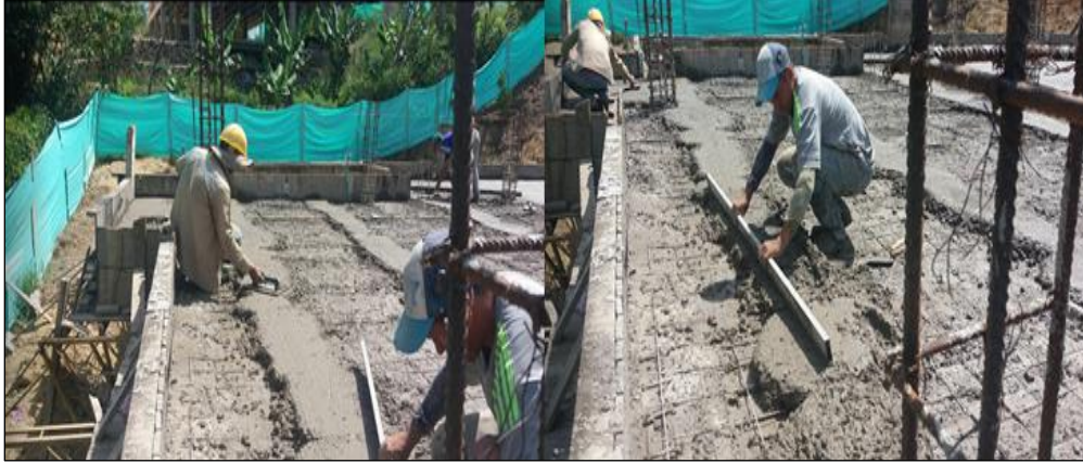
Figura 97. Vaciado Loseta.
