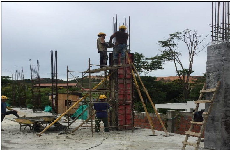
Figura 131. Vaciado columnas segundo piso en escuela de enfermería.
