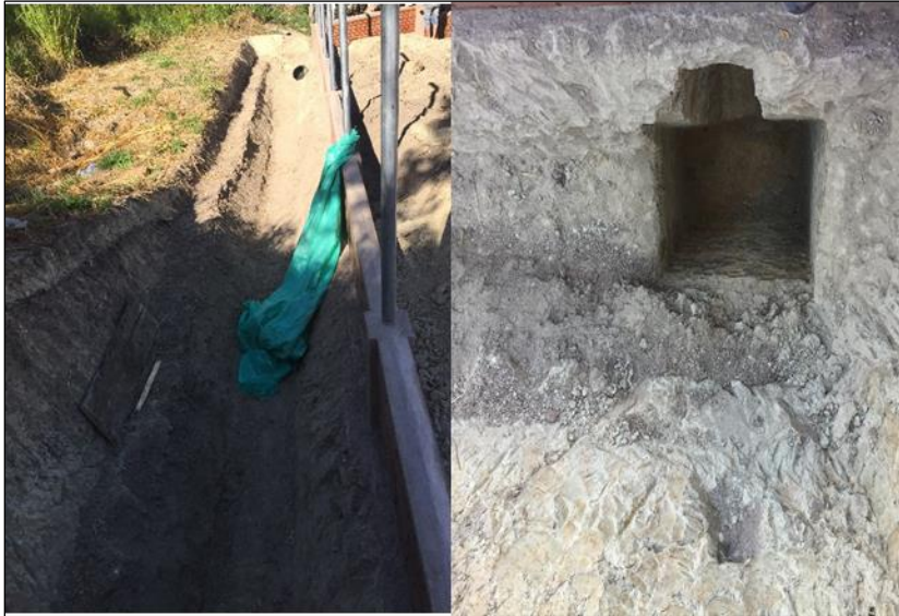
Figura 148. Excavaciones para el canal y caja para recibir aguas.
