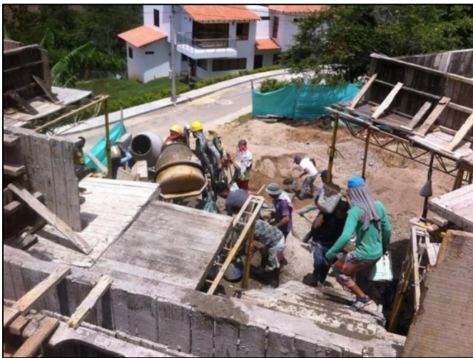
Figura 94. Vaciado de la placa.
