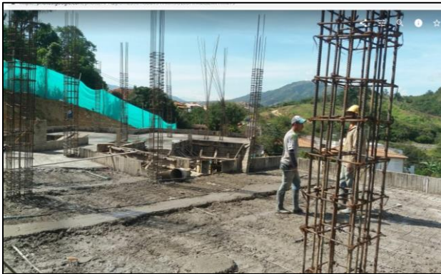
Figura 96. Hilos de referencia durante el vaciado.
