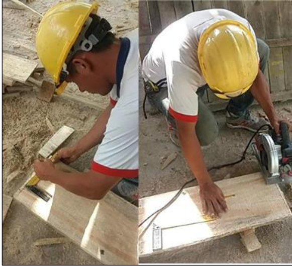
Figura 57. Demarcación y cortado de tablas.
