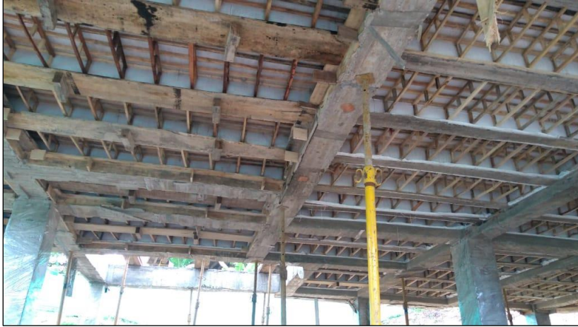
Figura 41. Descimbrado.
