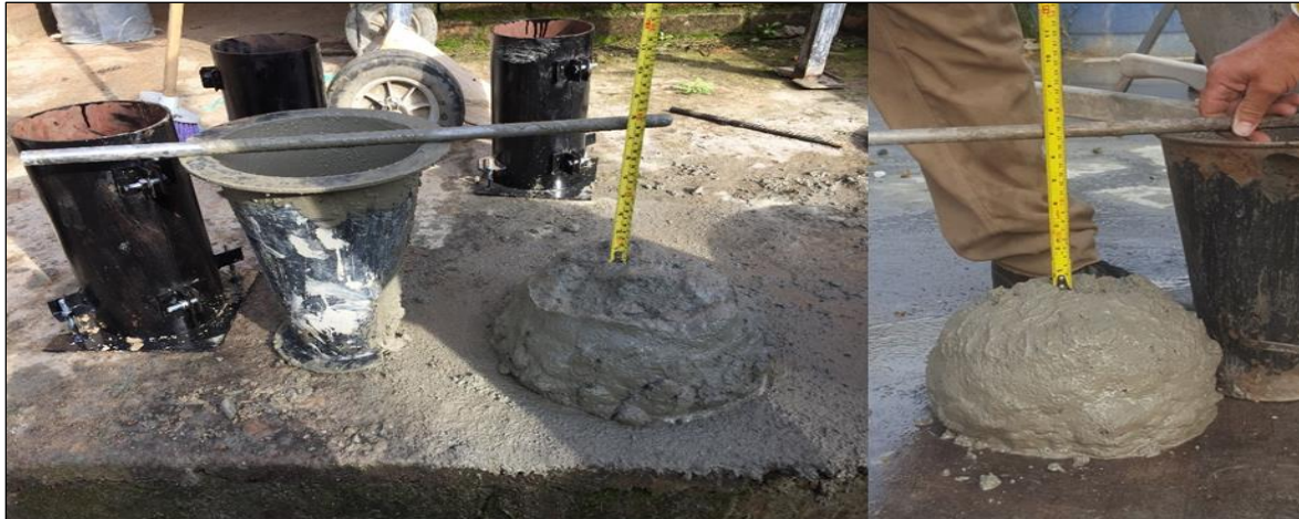
Figura 163. Ensayo de asentamiento en escuela de enfermería.
