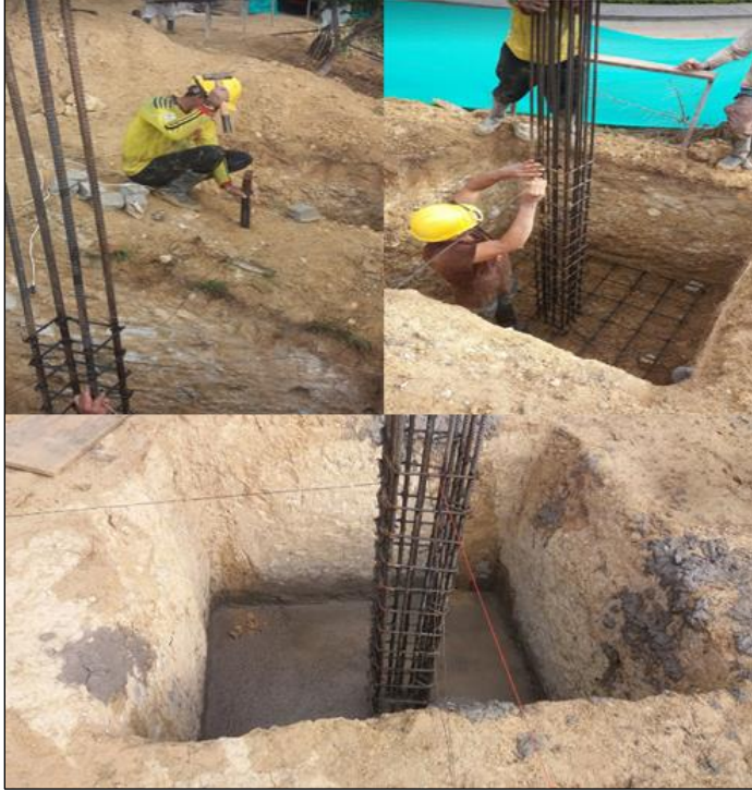
Figura 48. Verificación de verticalidad.
