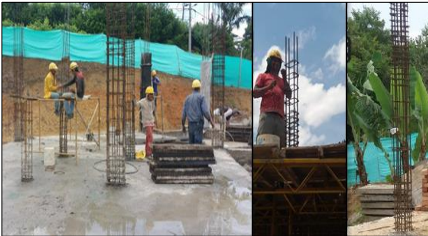
Figura 61. Armado de acero columnas.
