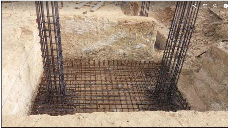
Figura 44. Acero en condiciones óptimas antes del vaciado.
