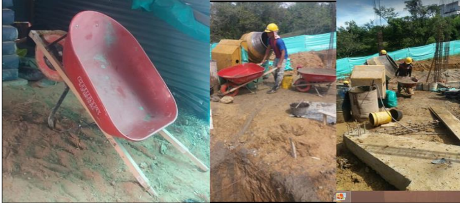
Figura 80. Vaciado de Columnas.
