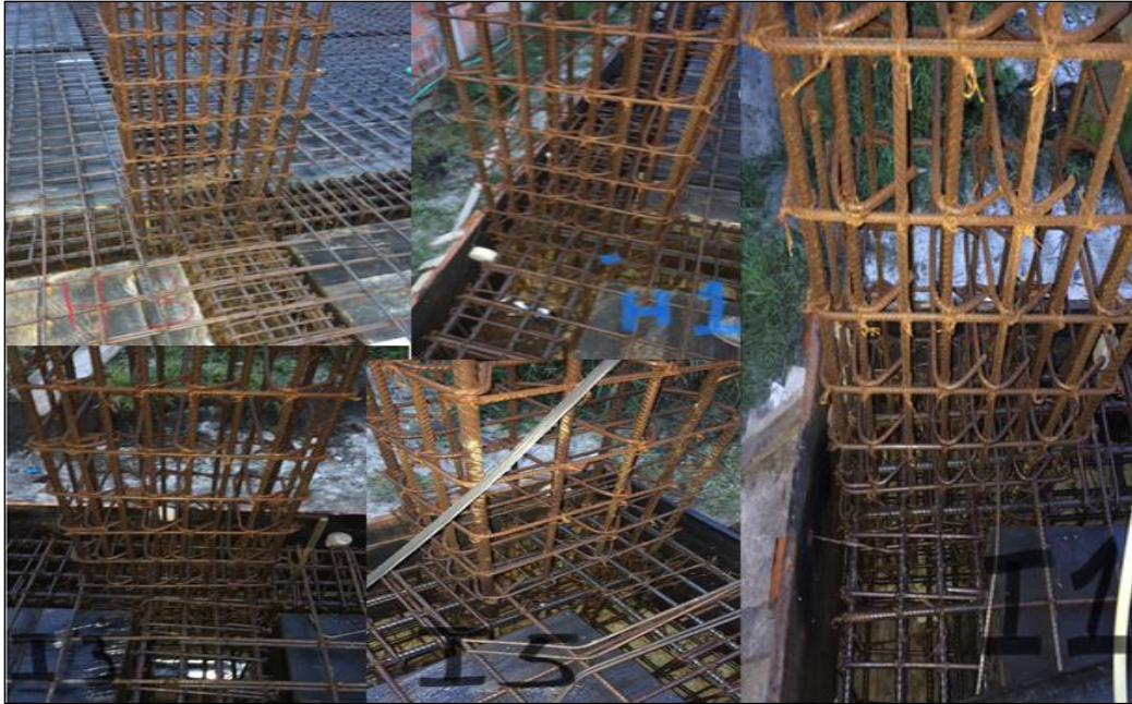
Figura 128. Armado de acero de columna H3-H1-I1-I3-I5.
