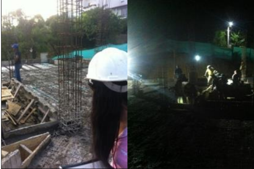
Figura 99. Instalación de reflectores al anochecer.
