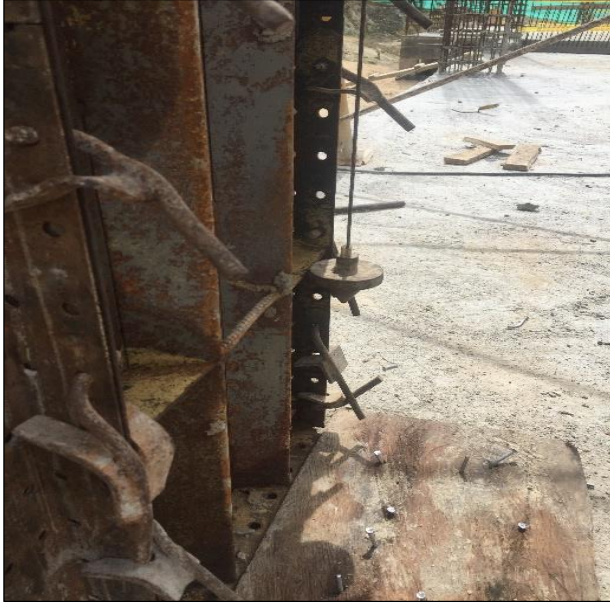
Figura 127. Plomado de columnas.
