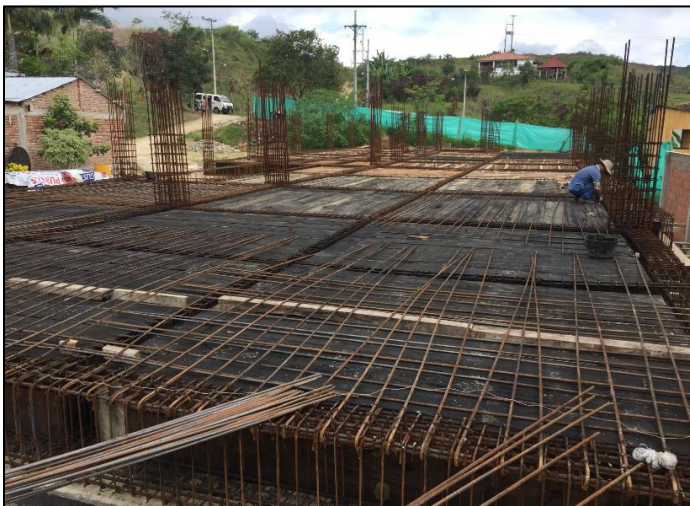
Figura 116. Inicio de armado de parrilla del proyecto.
