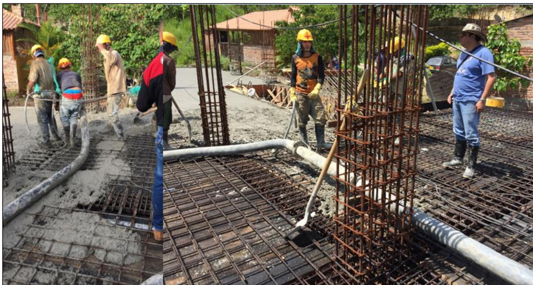
Figura 119. Vaciado de placa.
