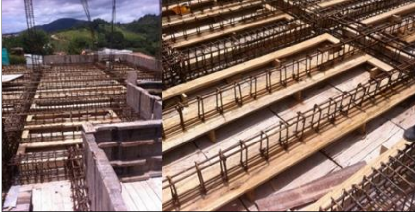
Figura 88. Colocación de plataforma en madera.
