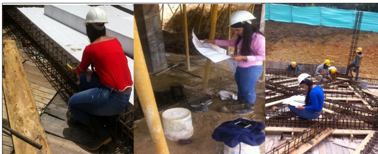
Figura 87. Armado de acero de viguetas.
