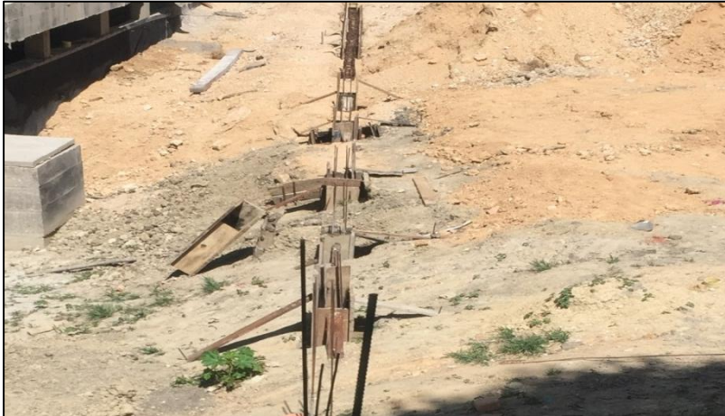
Figura 139. Formaleteado y vaciado de pedestales.
