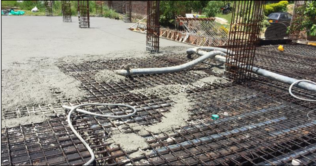
Figura 120. Vaciado de placa.
