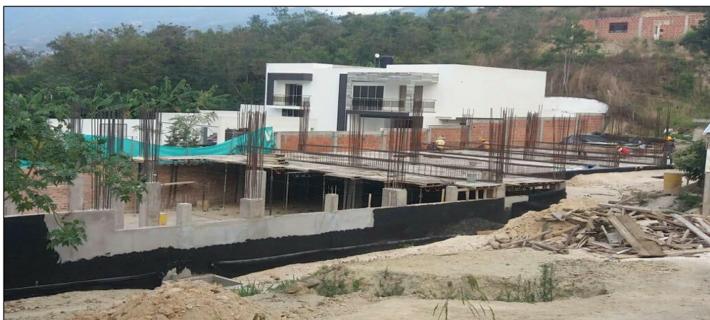
Figura 7. Estado actual del proyecto.
