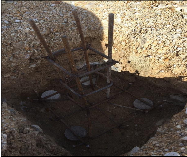
Figura 137. Armado de acero de parrilla de zapatas y pedestales.
