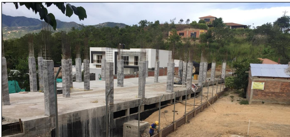
Figura 133. Culminación vaciado de columnas en segundo piso escuela de enfermería.
