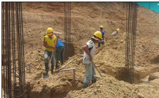
Figura 54. Excavación vigas de cimentación.
