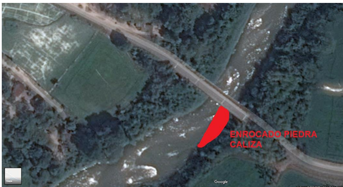
Figura 8. registro fotográfico de localización y estado actual del puente agua clara sobre el rio pamplonita
