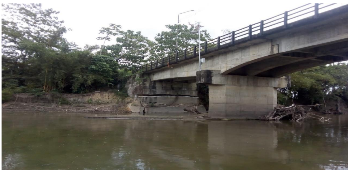
Figura 5. registro fotográfico de localización y estado actual del puente agua clara sobre el rio pamplonita
