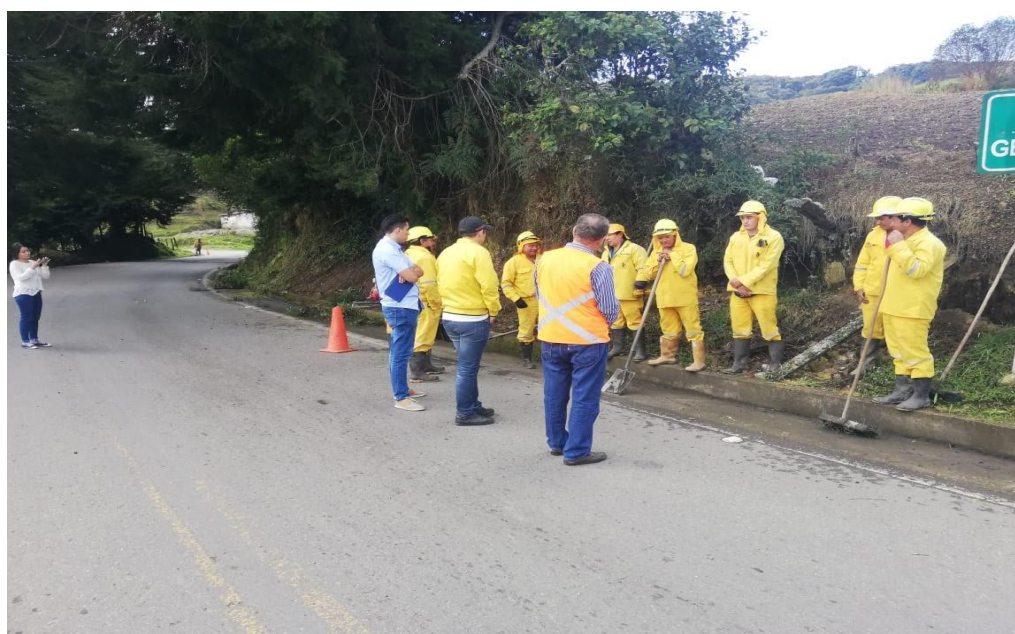
Figura 17. Registro fotográfico Ruta 5505 Chitaga-Pamplona
