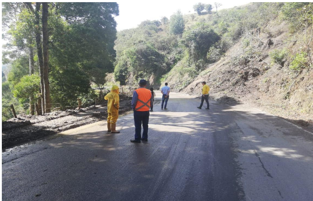
Figura 18. Registro fotográfico Ruta 5505 Chitaga-Pamplona
