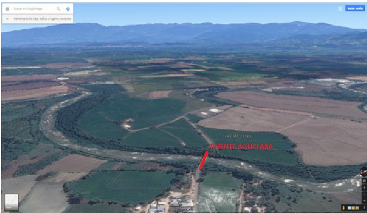
Figura 3. registro fotográfico de localización y estado actual del puente agua clara sobre el rio pamplonita
