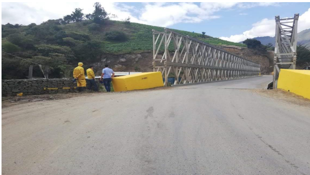
Figura 16. Registro fotográfico Ruta 5505 Chitaga-Pamplona
