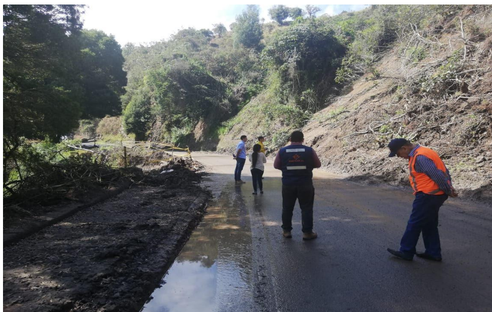
Figura 11. Registro fotográfico Ruta 5505 Chitaga-Pamplona
