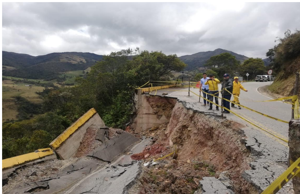
Figura 12. Registro fotográfico Ruta 5505 Chitaga-Pamplona
