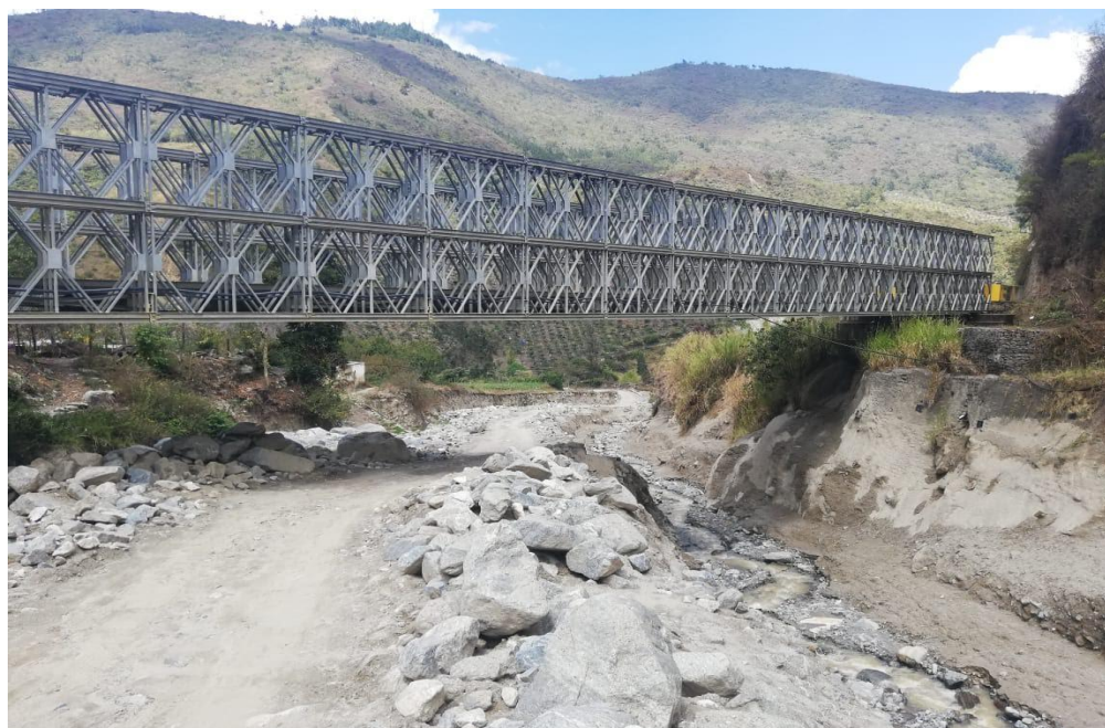
Figura 10. Registro fotográfico Ruta 5505 Chitaga-Pamplona
