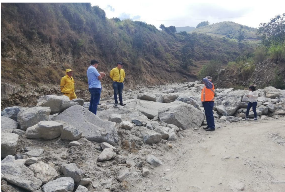
Figura 13. Registro fotográfico Ruta 5505 Chitaga-Pamplona
