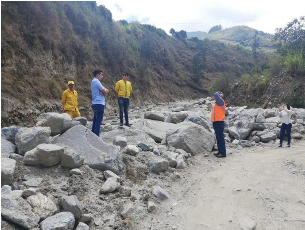
Figura 9. Registro fotográfico Ruta 5505 Chitaga-Pamplona
