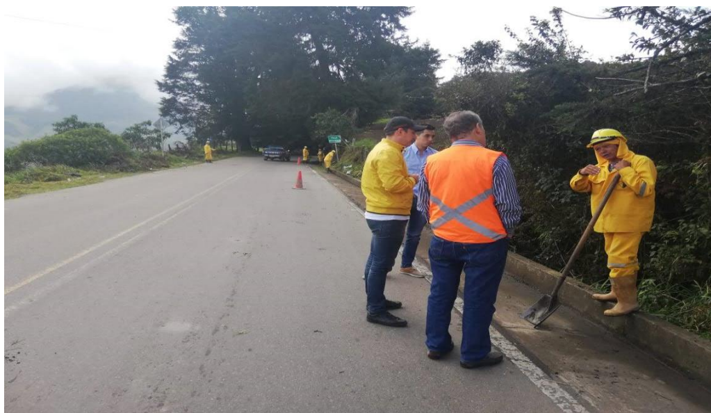
Figura 19. Registro fotográfico Ruta 5505 Chitaga-Pamplona
