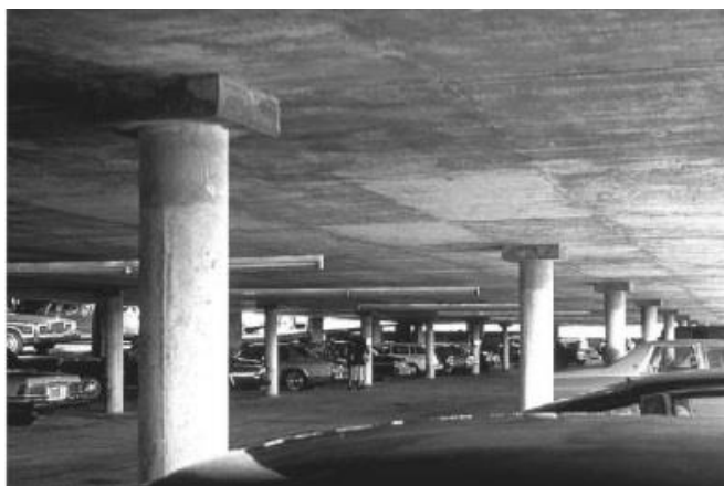
Figura 8. Losa plana con ábacos.
