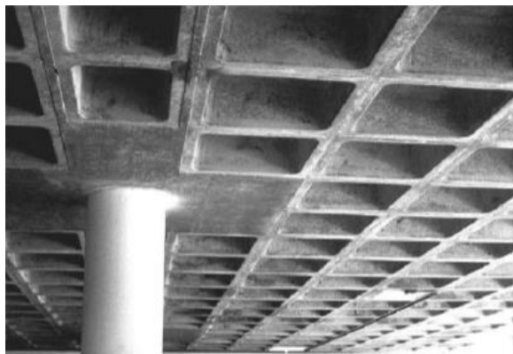
Figura 7. Losa plana sin vigas apoyadas sobre Capiteles.
