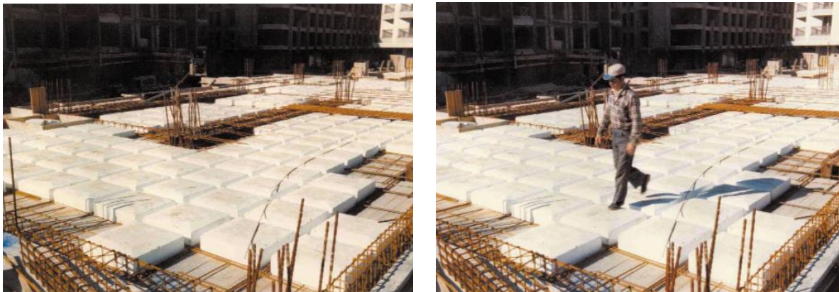
Figura 18. Estructura aligerada con bloques de poliestireno.
