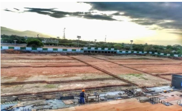
Figura 51. Excavación e instalación de tubería de riego.
