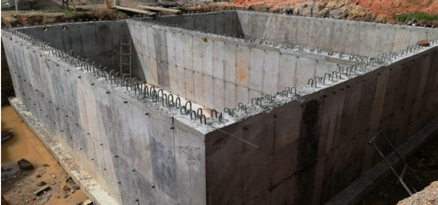
Figura 38. Desenfofrado de tanque subterráneo.
