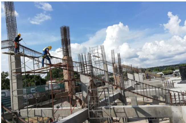
Figura 19. Armado de acero de refuerzo para vigas inclinadas.
