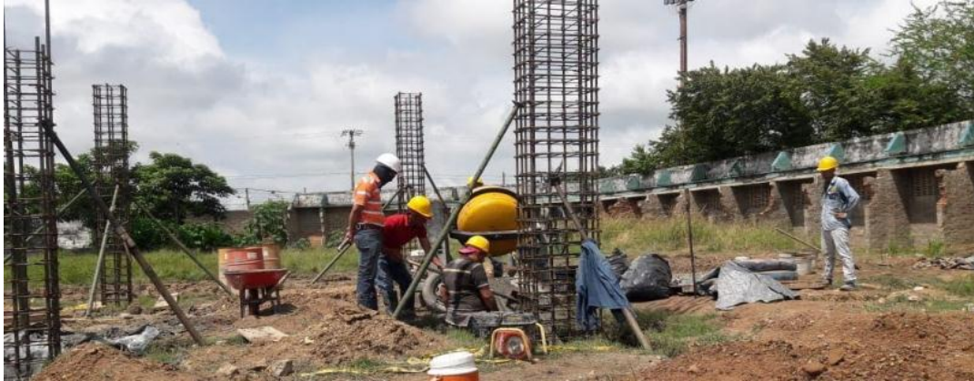
Figura 5. Fundida de pedestales laterales.
