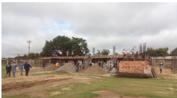
Figura 12. Supervisión de fundida de placa M.2 central.
