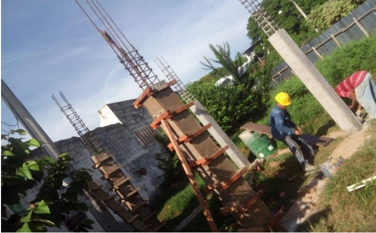
Figura 27. Desencofrado de columnas de taquilla norte.
