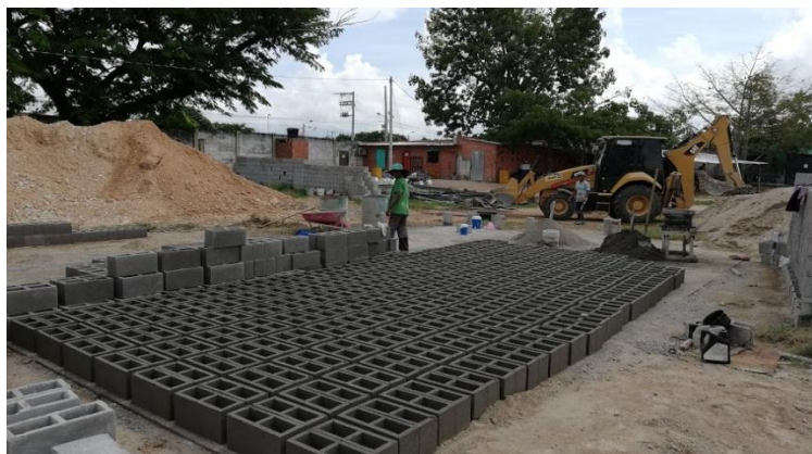
Figura 88. Elaboración de bloques para mampostería.
