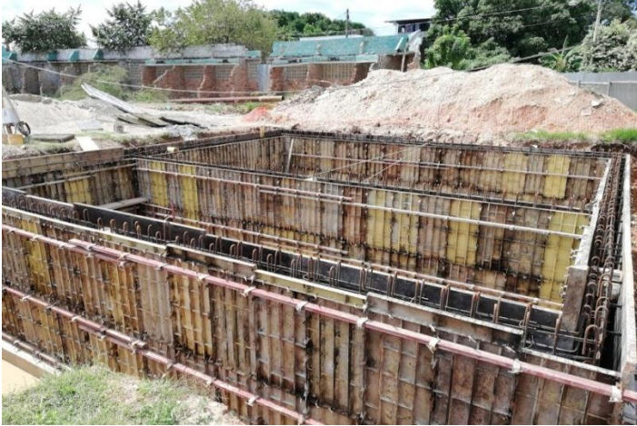
Figura 35. Instalación de formaletas para muros de tanque.
