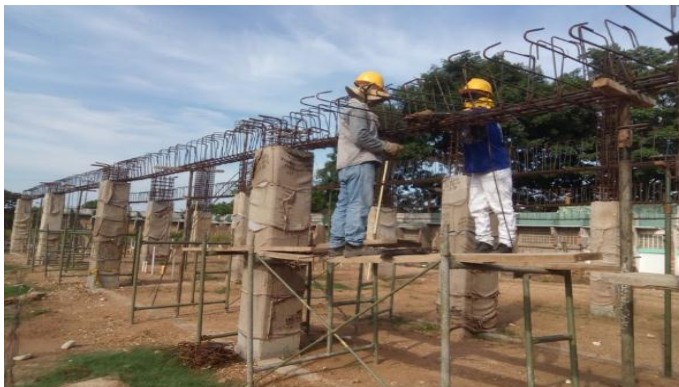
Figura 7. Armado de acero de voladizo M.1 central.
