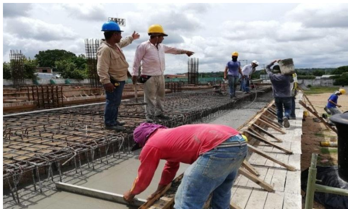
Figura 10. Fundida de voladizo.
