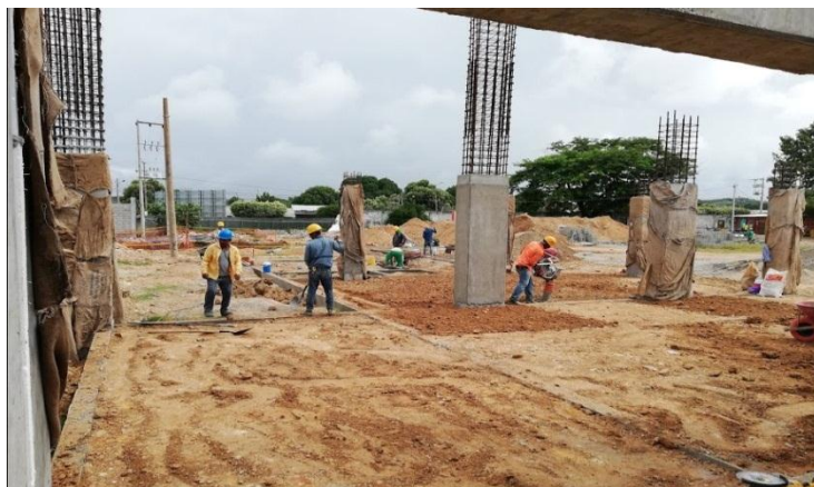
Figura 13. Relleno y compactación M.2 lateral norte.
