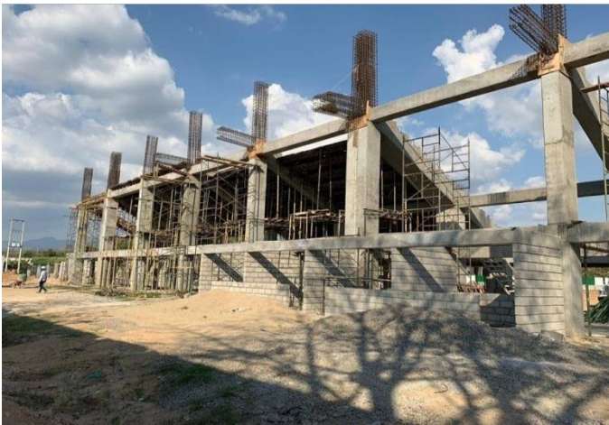
Figura 42. Vigas longitudinales del M.2 central y lateral.
