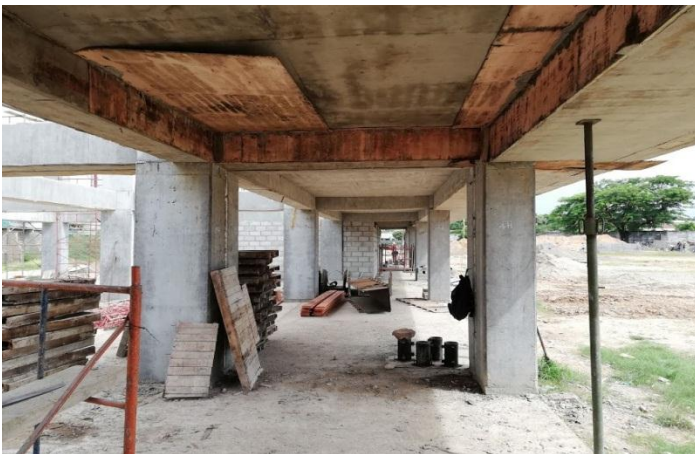
Figura 31. Desencofre de placa M.2 central.
