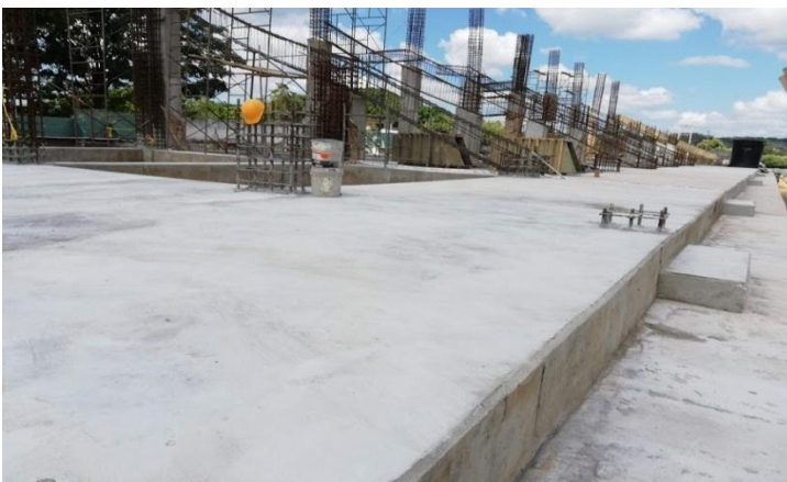
Figura 37. Acabado de placa de los módulos 1 y 2.
