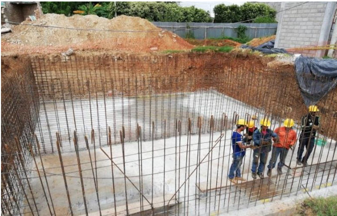
Figura 47. Armado de acero de refuerzo para tanque subterráneo.
