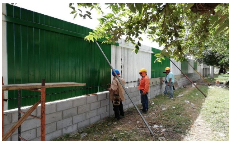
Figura 16. Instalación de acero de refuerzo para viga cinta de cerramiento oriental.
