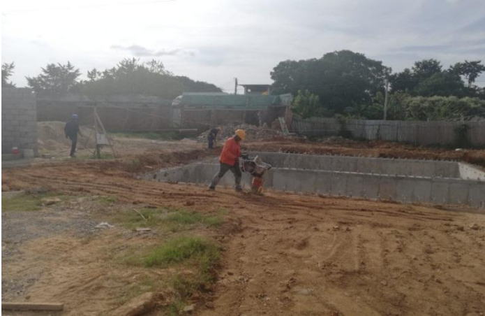
Figura 49. Relleno y compactación hasta nivel 0.
