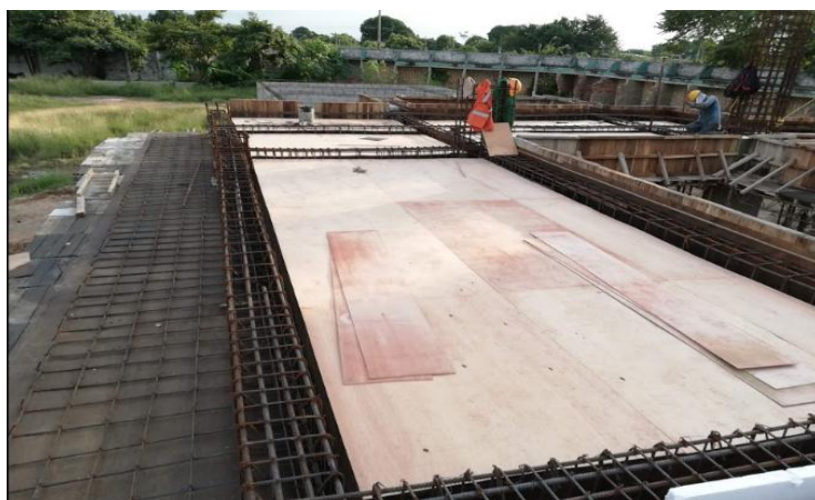
Figura 22. Instalación de triple, para placa del M.1 lateral sur.
