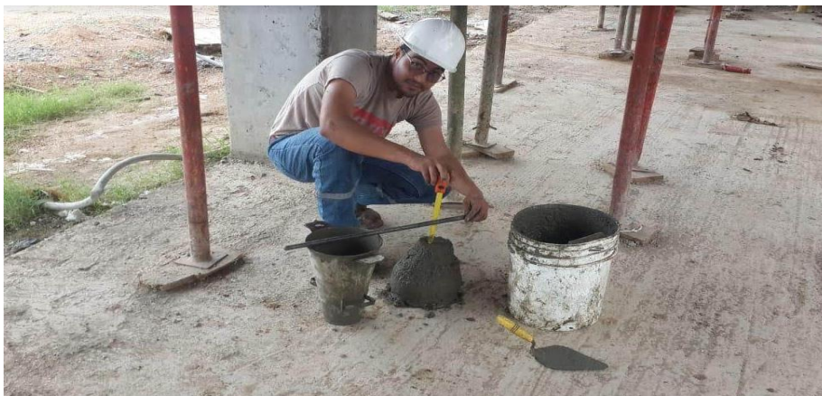
Figura 56. Prueba de slump para toma de muestras de cilindros.
