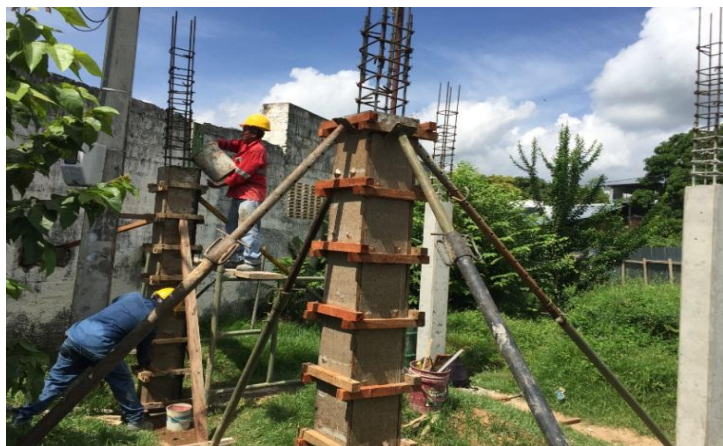
Figura 21. Fundida de columnas de taquilla norte.
