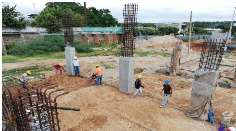
Figura 15. Relleno y compactación con material seleccionado M.2 lateral norte.
