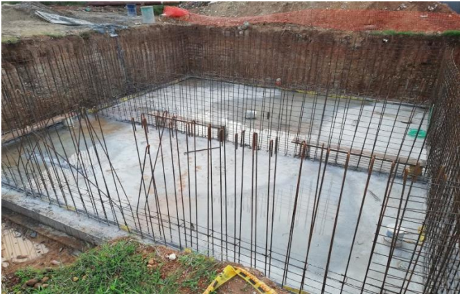
Figura 33. Placa inferior de tanque fundida.
