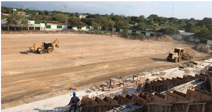
Figura 53. Corte, nivelación y conformación de cancha.
