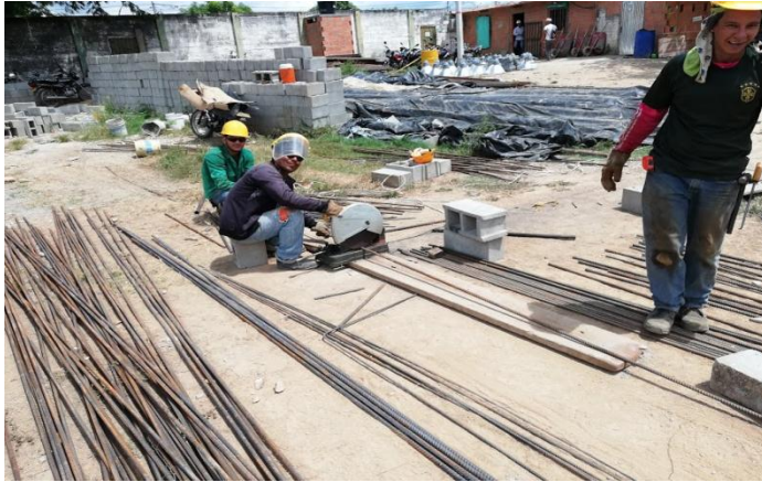
Figura 89. Corte y figurado de acero de refuerzo.
