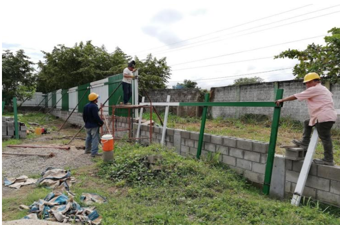
Figura 90. Instalación y soldado de tubería para cerramiento.
