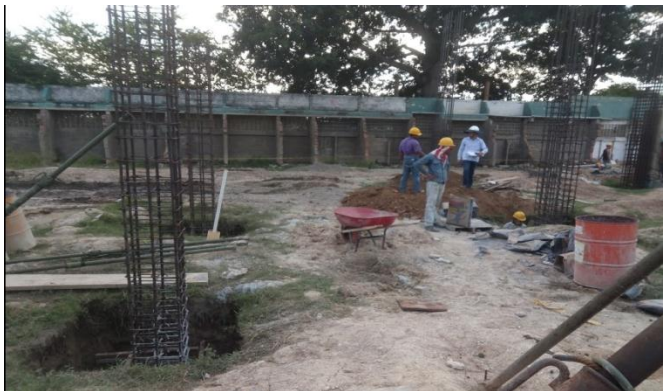
Figura 6. Relleno y compactación.
