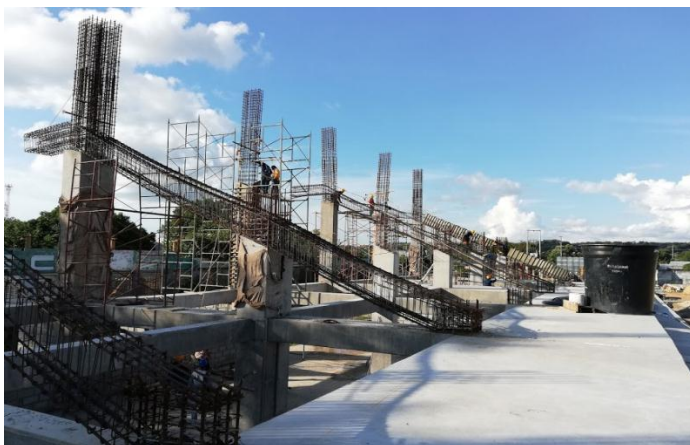
Figura 91. Armado de acero de vigas aéreas.
