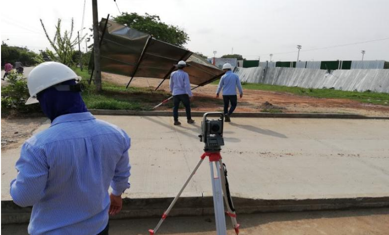
Figura 101. Levantamiento topográfico de zona exterior.
