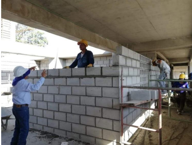
Figura 95. Levante de mampostería módulos centrales y laterales.
