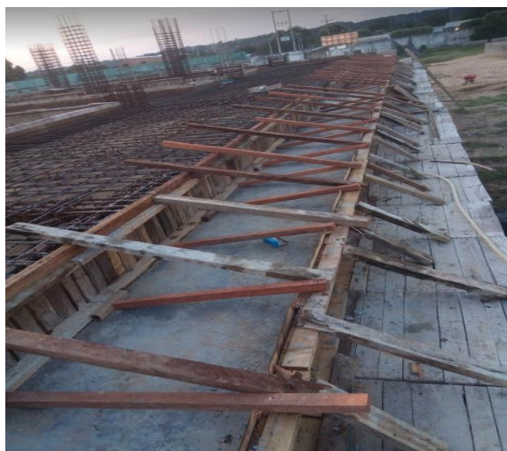
Figura 11. Instalación de formaletas para placa M.2 central.
