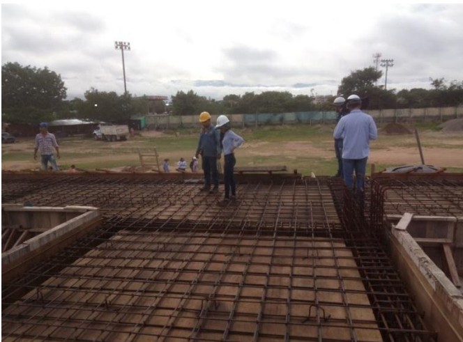
Figura 28. Inspección de instalación de acero de placa M.2 central.
