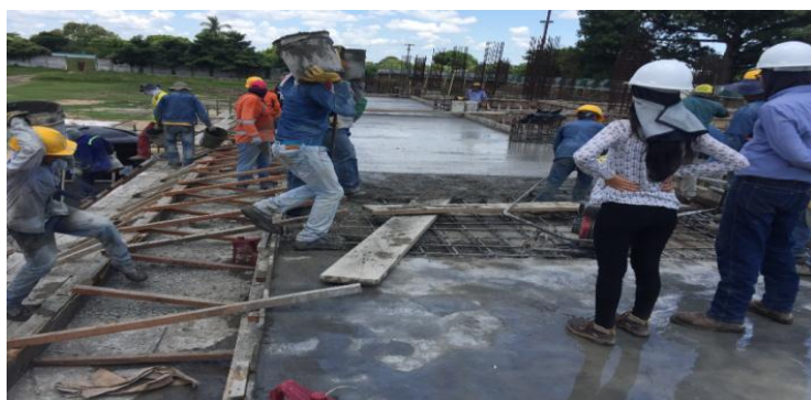
Figura 44. Fundida de placa M.2 central.
