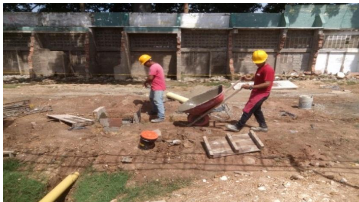
Figura 8. Fundida de caja de inspecciones.
