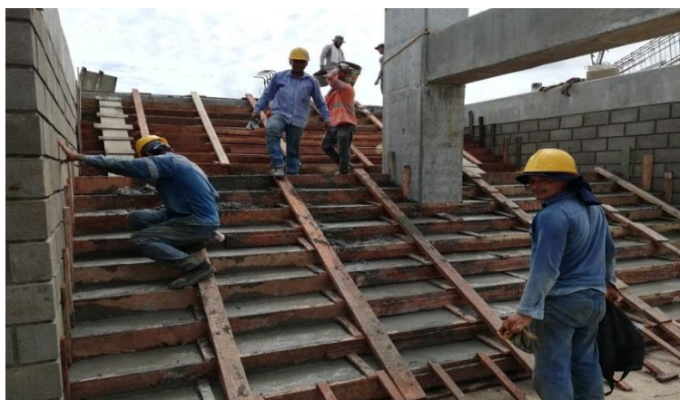
Figura 23. Fundida de escalera doble M.2 central.
