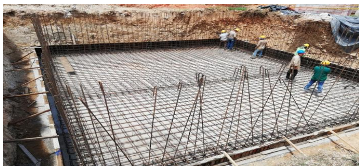
Figura 45. Armado del acero de refuerzo de tanque subterráneo.
