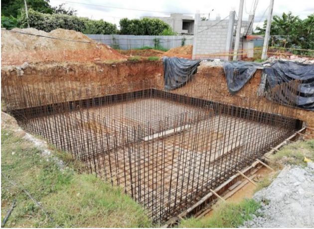
Figura 32. Armado de acero de refuerzo de tanque subterráneo.
