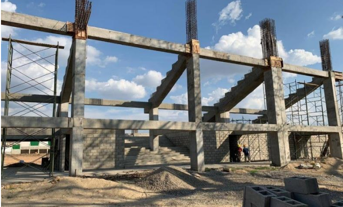
Figura 41. Vigas longitudinales del M.1 central y lateral.
