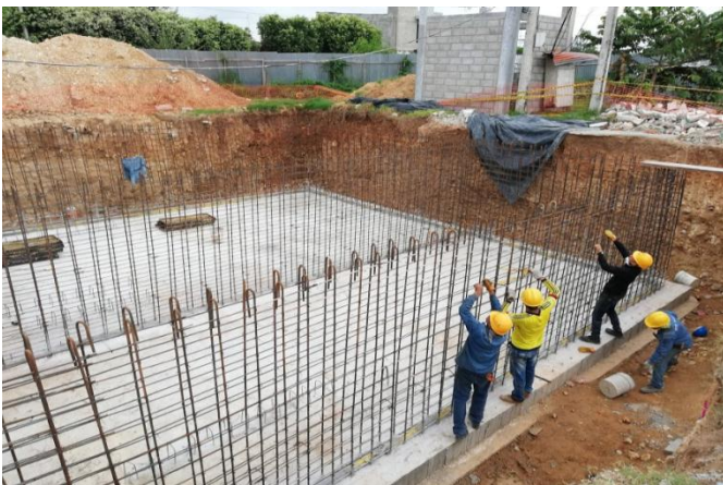
Figura 34. Acero de refuerzo para muros del tanque subterráneo.
