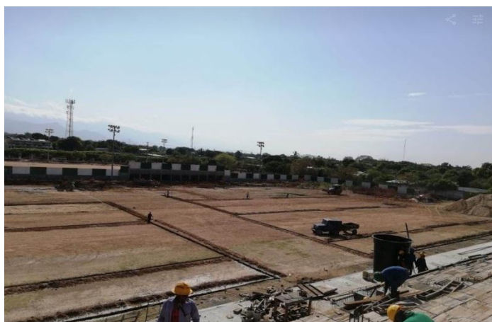
Figura 94. Excavación e instalación de tubería de riego.
