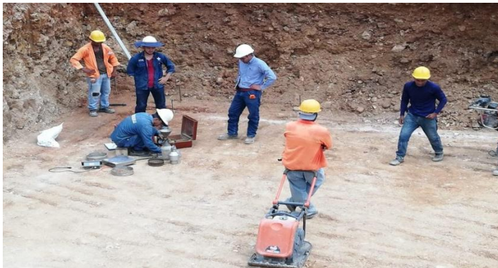
Figura 64. 2 Ensayo de densidad de arena para tanque.
