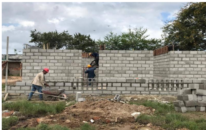
Figura 92. Levante de mampostería del M.1 lateral sur.
