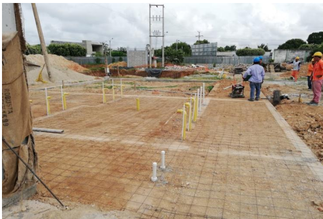
Figura 20. Instalación de malla electro soldada de 5mm para contrapiso.
