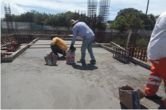
Figura 29. Pulida de placa del M.2 central.
