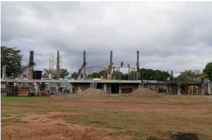
Figura 50. Armado de acero de vigas aéreas 2 nivel.
