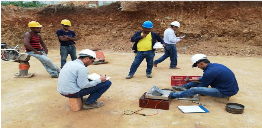
Figura 63. Ensayo de densidad de arena para tanque.
