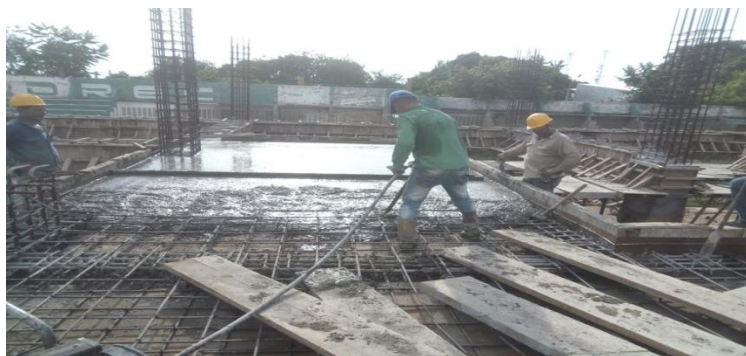
Figura 43. Vibrado de concreto hecho en sitio.
