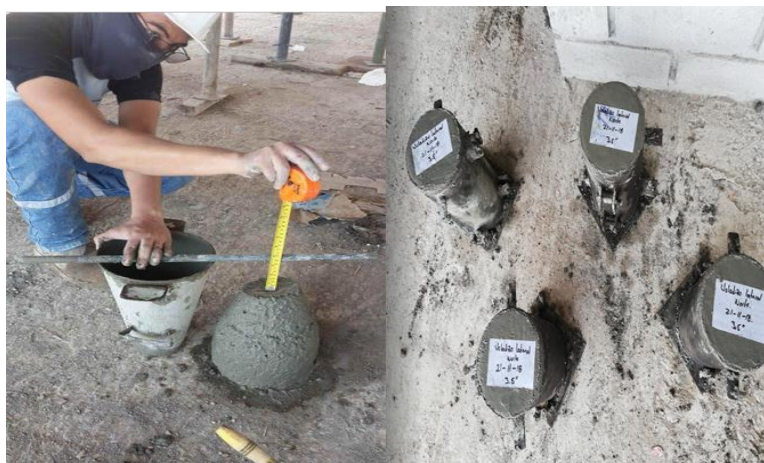
Figura 67. Ensayo de Slump y toma de muestras de cilindros.
