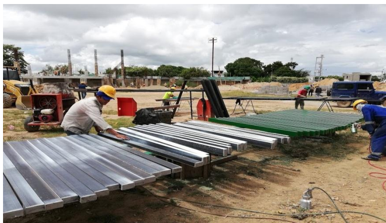
Figura 87. Corte, lavado y pintado de tubería para cerramiento.
