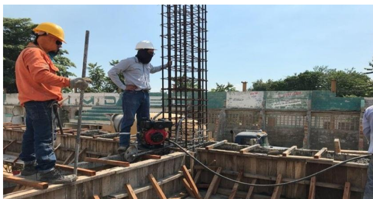
Figura 9. Fundida de vigas aéreas M.2 central.
