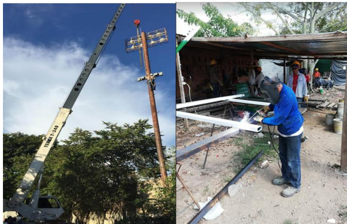
Figura 86. Desmonte de postes de luz y soldado de pórticos para tuberías de cerramiento.
