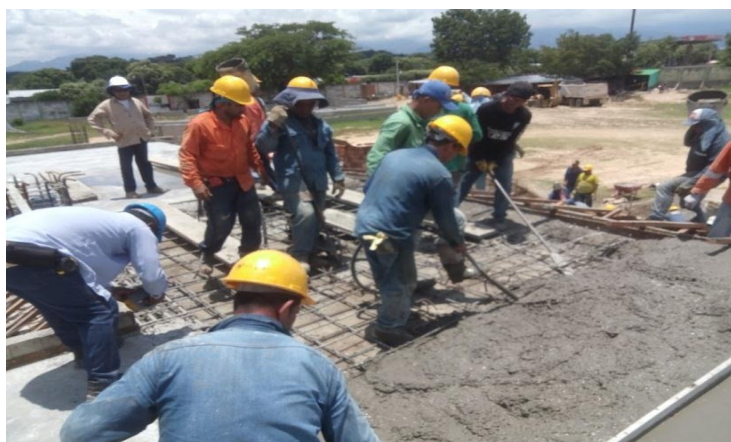
Figura 14. Inspección de fundida de placa M.2 central.
