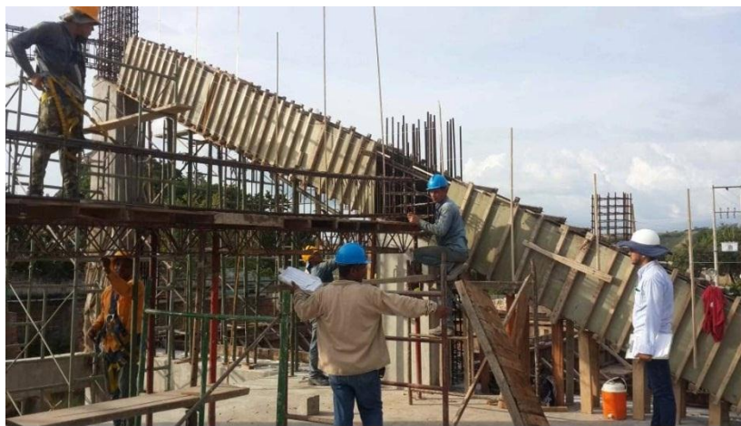
Figura 24. Instalación de encofrados y acero de refuerzo de vigas transversales.
