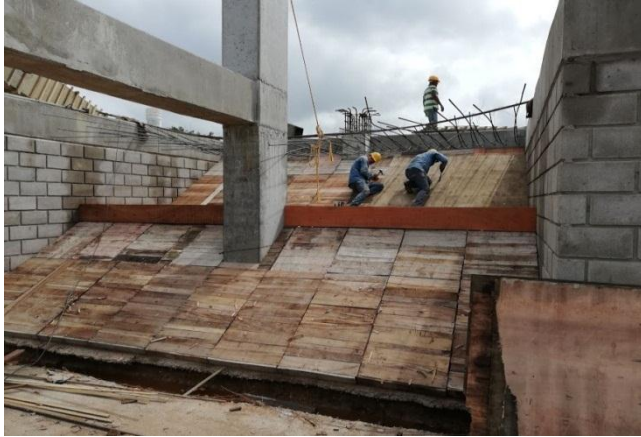
Figura 18. Instalación de formaletas para encofrado de escaleras dobles.
