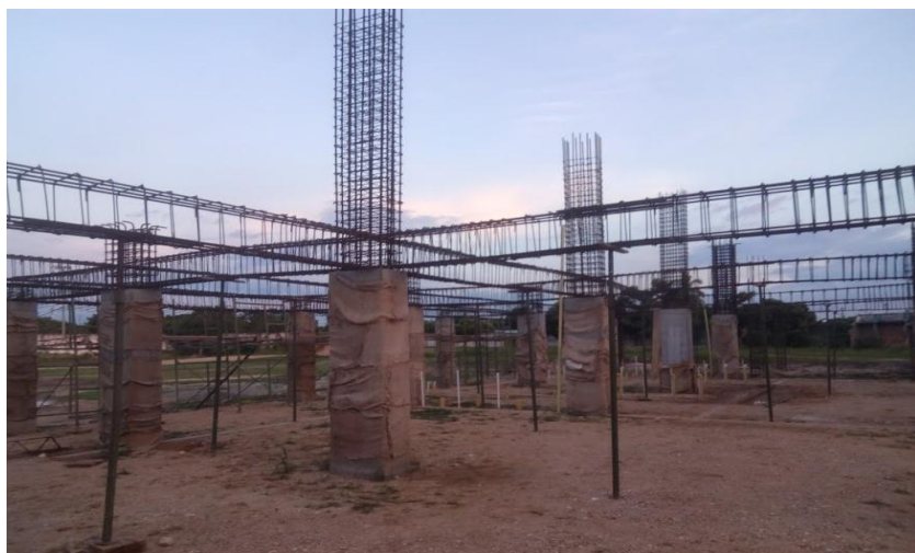
Figura 26. Armado de acero de vigas aéreas del M.1 central.
