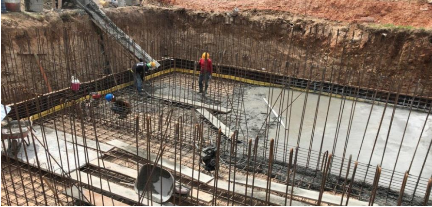
Figura 46. Fundida de placa de tanque subterráneo.
