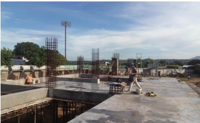
Figura 30. Inspección de acabados de la placa M.2 central.
