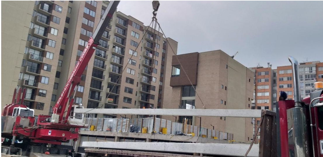
Fotografía 4 Acto Inseguro - Izaje de Cargas (Pilotes)
