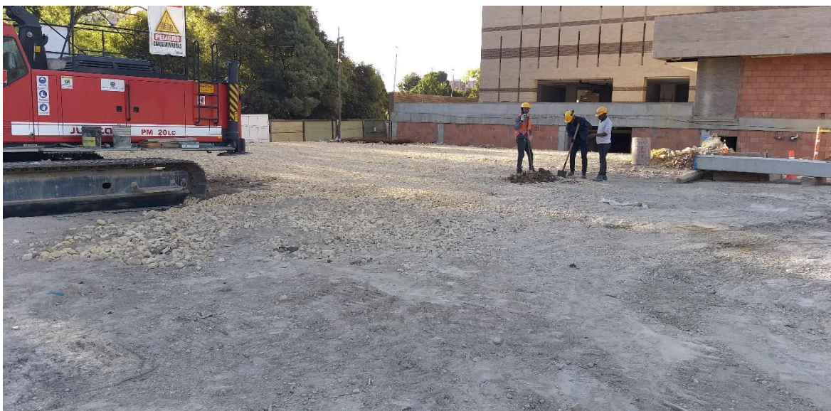
Figura 16 Plataforma Adecuada Proyecto ALAMEDA 170 II
