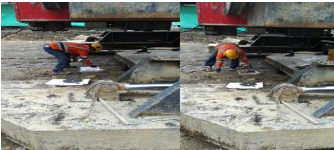
Figura 52 Hincada de Pilotes
