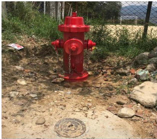
Figura 18. Mantenimiento y reparación de hidrante en zona 2. (2019). Autor.
