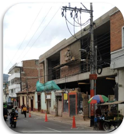
Figura 31. Inmueble con valor patrimonial demolido para construir edificio ubicado en el centro. Fuente: Autores, 2019.
