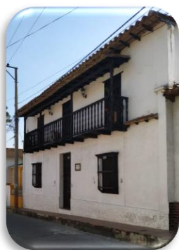
Figura 25. Vivienda del barrio Milanés con valor patrimonial en tapia pisada. Fuente: Autores, 2019.
