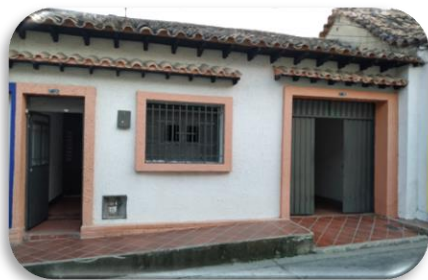
Figura 47. Fachada de la casa de Esther Sanjuan ubicada en el barrio Milanés. Fuente: Autores, 2019.
