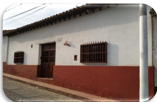
Figura 37. Fachada de la casa de Dioselina Sandoval ubicada en el barrio Villanueva. Fuente: Autores, 2019.
