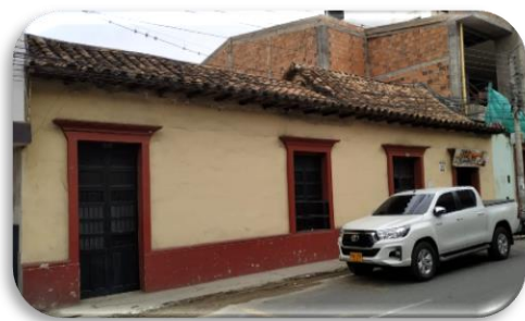
Figura 56. Fachada de la casa de Luis Eduardo Páez García ubicada en el Centro. Fuente: Autores, 2019.
