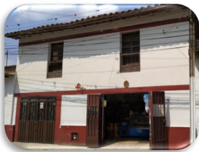
Figura 32. Fachada de la casa de Laudith Sánchez ubicada en el barrio Villanueva. Fuente: Autores, 2019.
