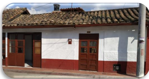
Figura 44. Fachada de la casa de Alfonso Navarro ubicada en el barrio Luz Polar. Fuente: Autores, 2019.
