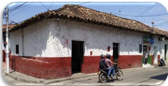
Figura 43. Fachada de la casa de José del Carmen Sánchez ubicada en el barrio Luz Polar. Fuente: Autores, 2019.
