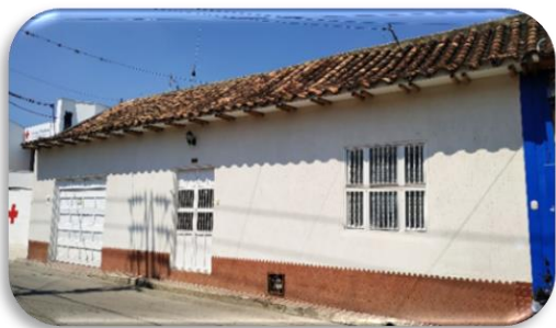
Figura 59. Fachada de la casa de Cecilia Jácome ubicada en el barrio Luz Polar. Fuente: Autores, 2019.
