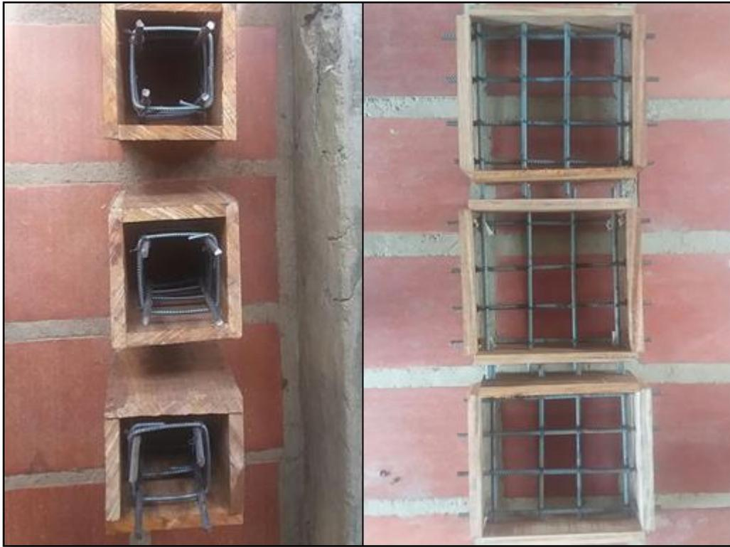
Figura 9. Formaletas con acero figurado listo para fundir. Fuente: Autores de la investigación.
