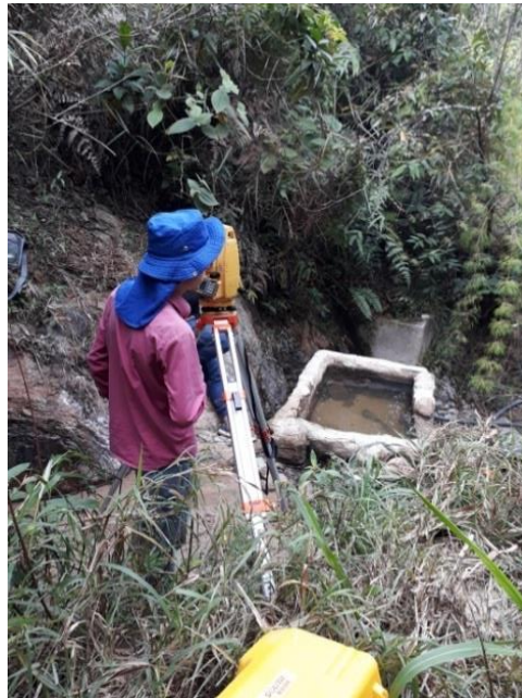
Figura 11. Realización de topografía zona involucrada en el diseño de acueducto. (2019). Autores.
