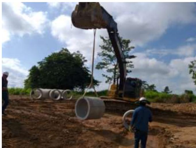
Instalación de tubería de concreto de 36"
