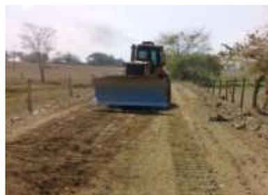
*Fig. 4. Extensión de material para estabilización.:*
