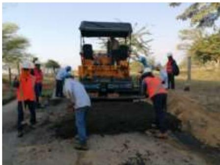
Fig. 6. Extensión de asfalto natural.: Autor
