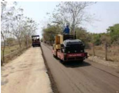
Fig. 7. Compactación con compactador doble rodillo. Autor
