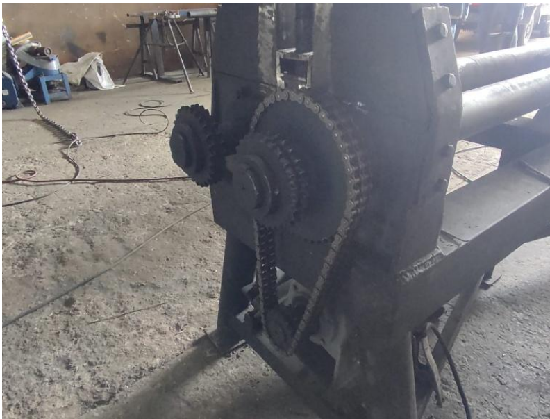
Instalación del motorreductor
