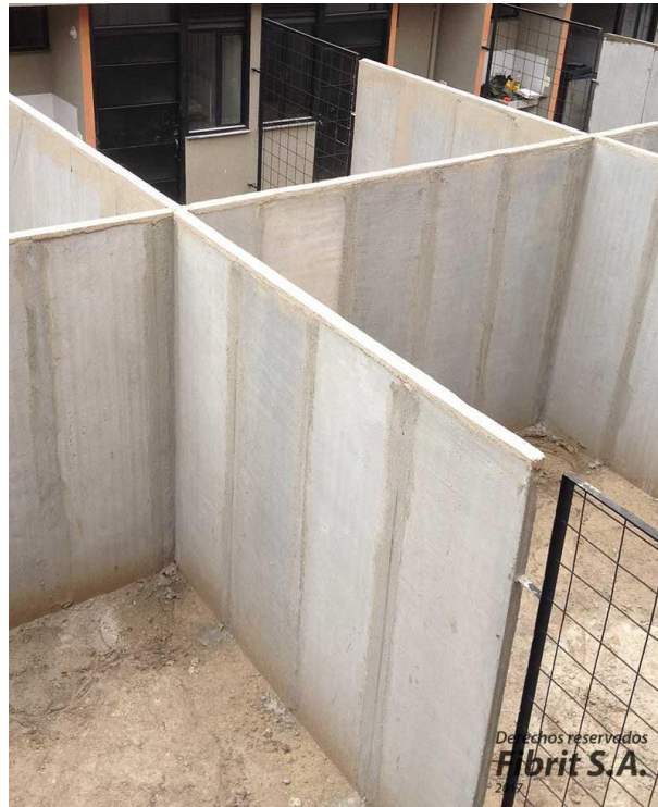
Figura 20. Muro de cerramiento prefabricado.
