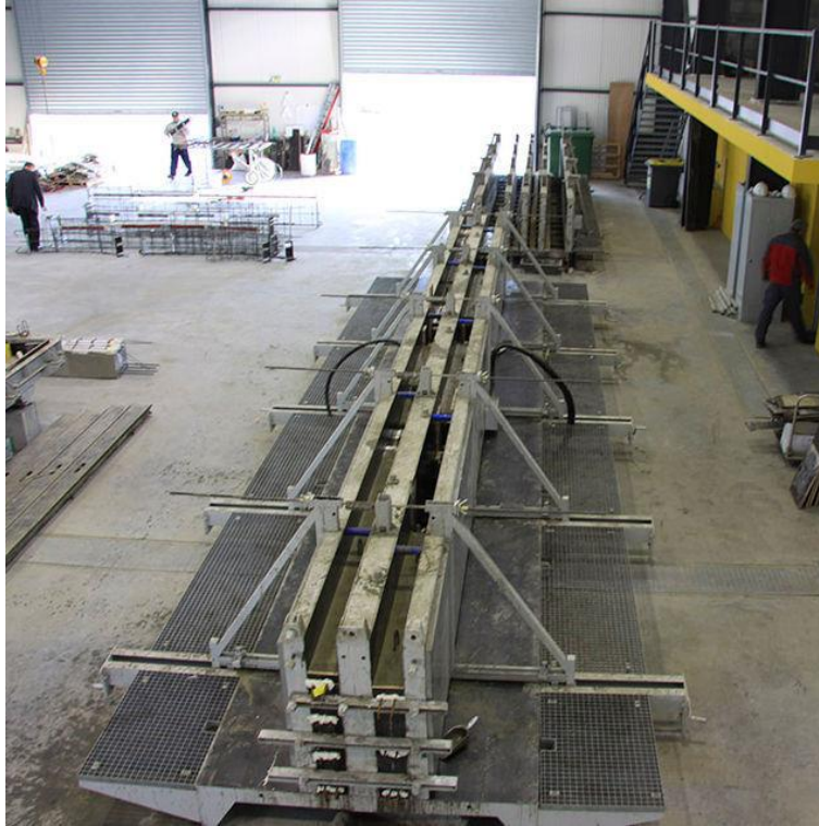
Figura 31. Molde para vigas prefabricadas en concreto.
