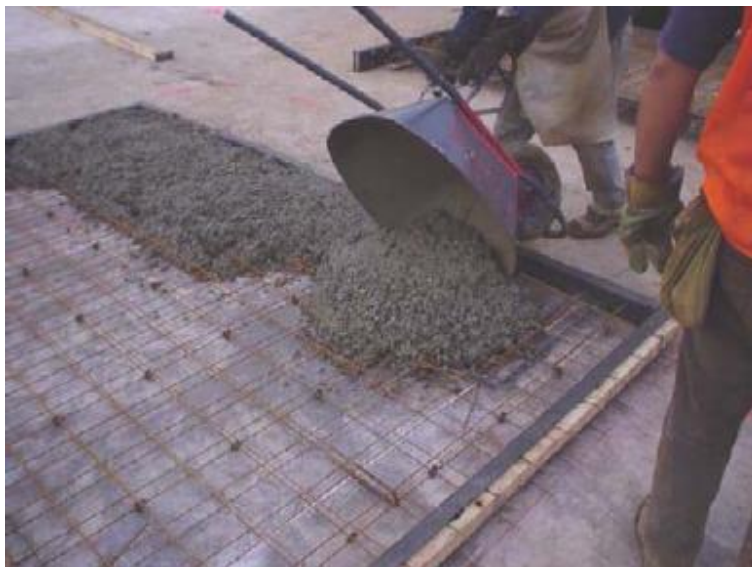
Figura 83. Vaciado del concreto con carretillas
