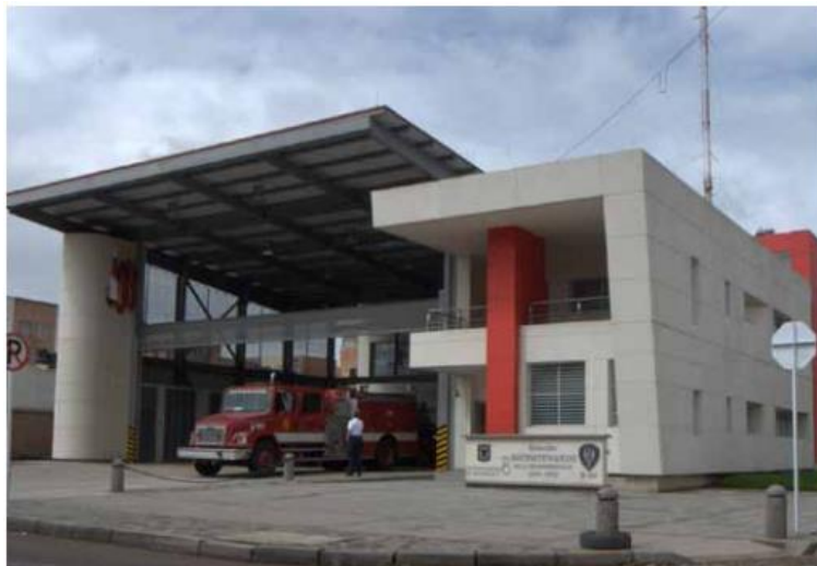
Figura 43. Estación de bomberos bicentenario, ubicado en la ciudad de Bogotá
