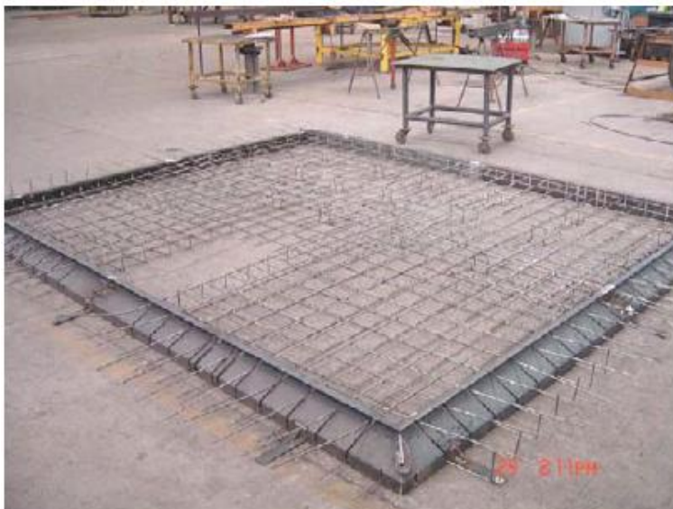
Figura 81. Armado del acero del elemento prefabricado
