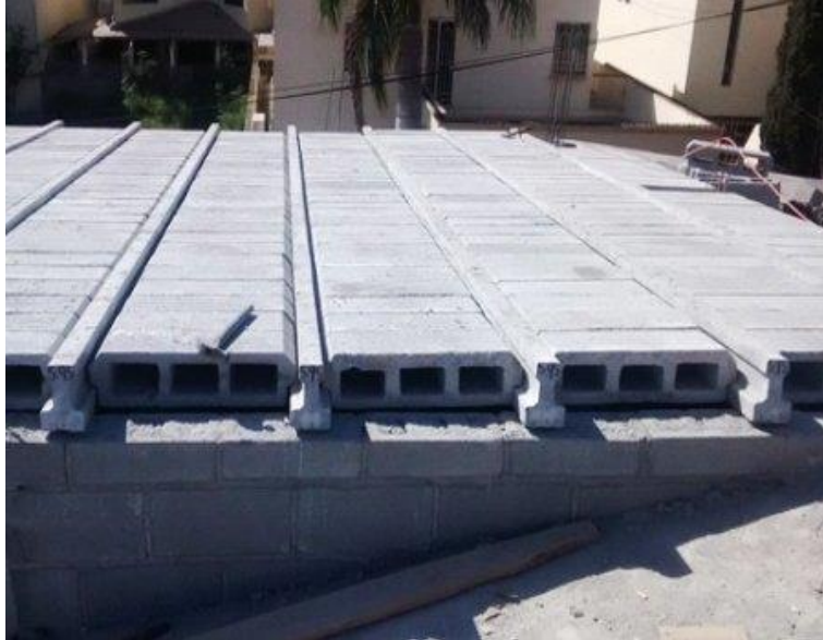
Figura 14. Losa con viguetas y bovedilla.
