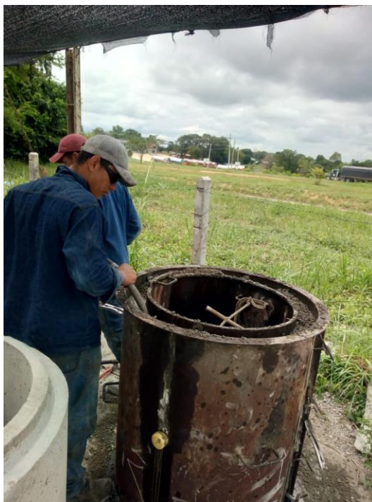
Figura 52. Fabricación y compactación de un elemento prefabricado
