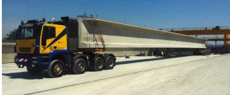
Figura 32. Transporte de vigas prefabricadas al sitio de obra.
