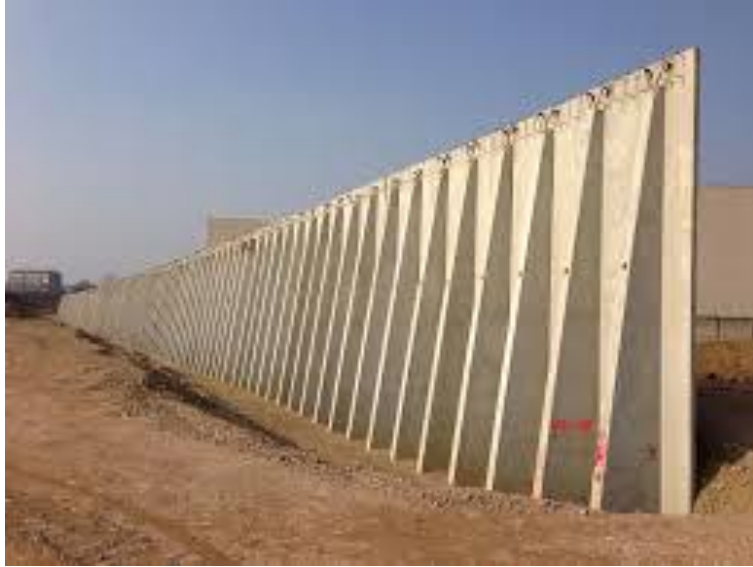
Figura 21. Muro de contención prefabricado.
