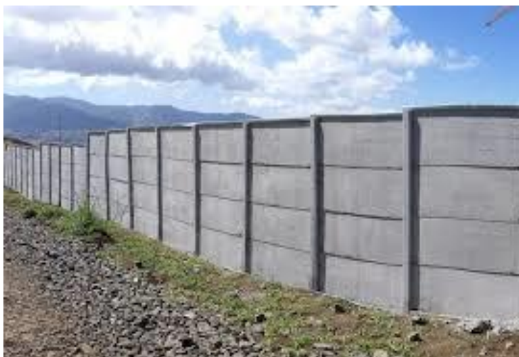
Figura 19. Muro perimetral prefabricado.
