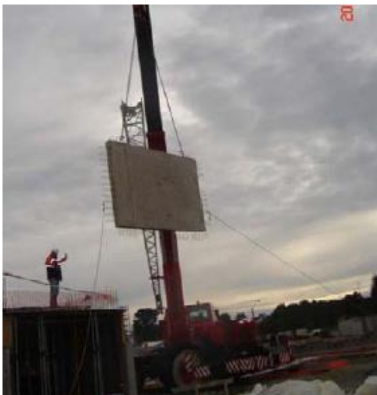
Figura 71. Montaje de los elementos prefabricados mediante grúas móviles
