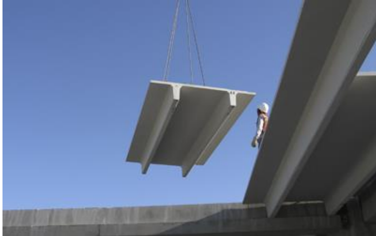
Figura 15. Losa con vigas T y doble T.
