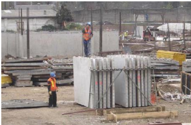
Figura 86. Acopio de los elementos prefabricados
