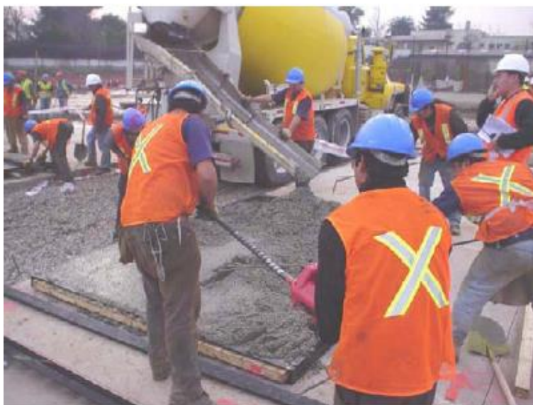
Figura 84. Vibrado del concreto
