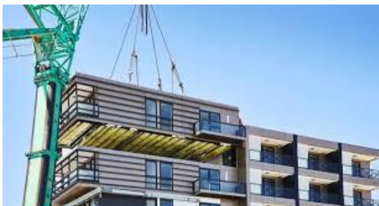
Figura 28. Edificio construido con módulos prefabricados.
