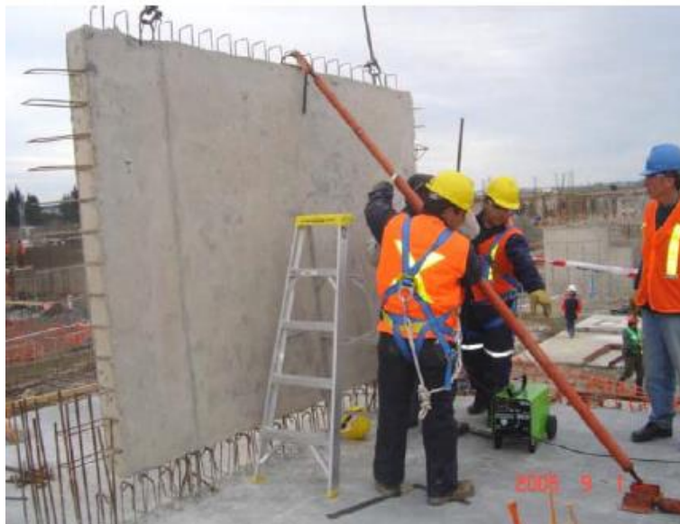
Figura 73. Aseguramiento de los elementos mediante arañas telescópicas
