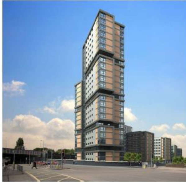
Figura 69. Edificio Wooverhampton Student Hall, localizado en Reino Unido
