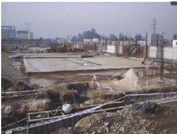
Figura 80. Superficie para la colocación del concreto
