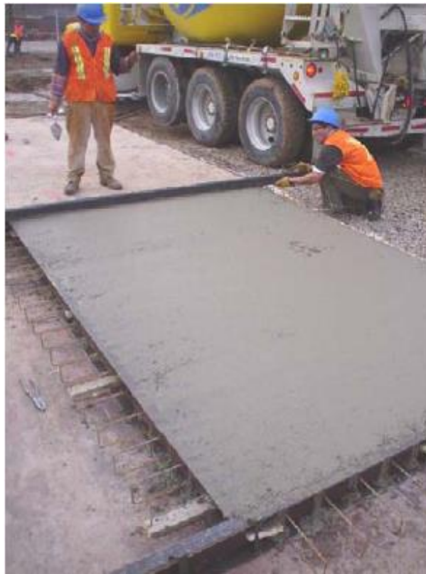
Figura 85. Acabado de la superficie del concreto
