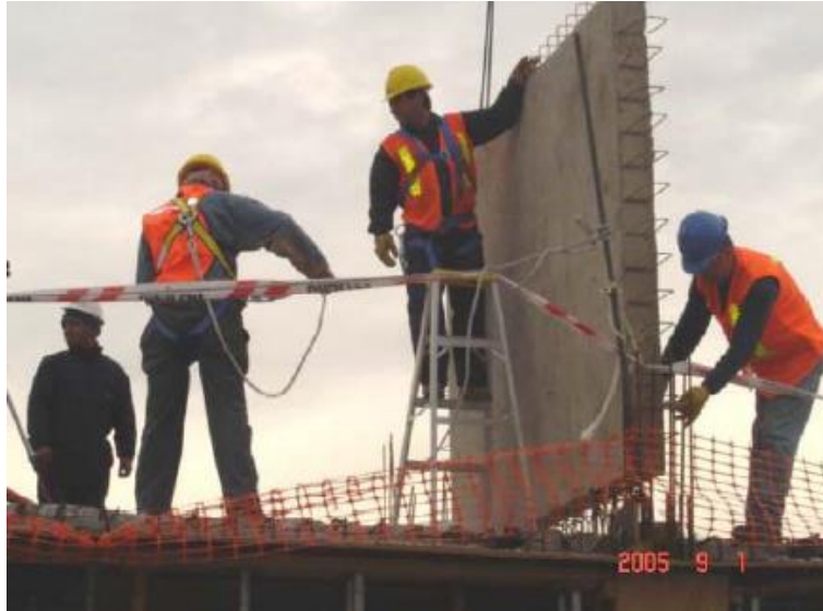
Figura 72. Colocación de los elementos prefabricados en su lugar definitivo
