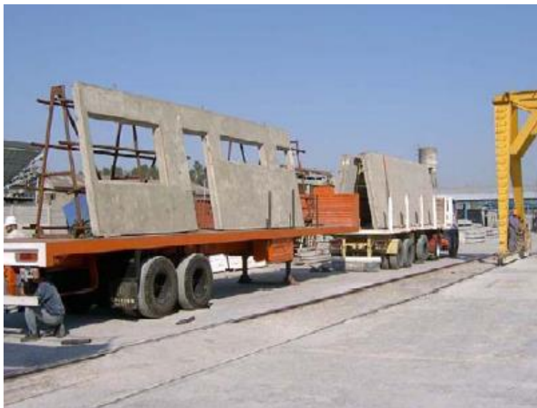
Figura 70. Transporte de los elementos prefabricados
