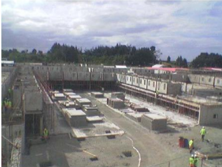
Figura 74. Vista de la obra con los elementos prefabricados
