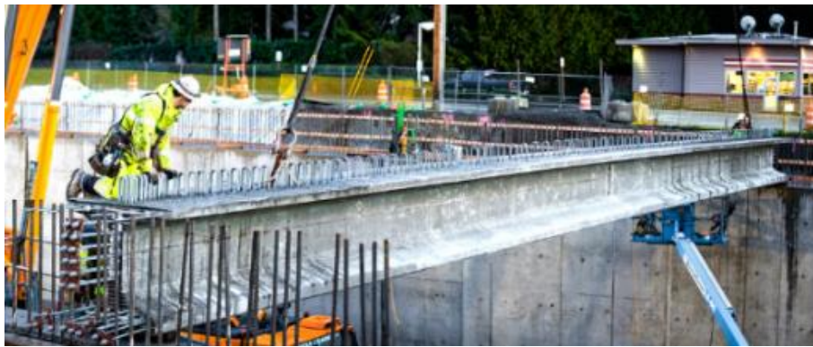
Figura 76. Construcción del puente prefabricado en la ciudad de Richmond
