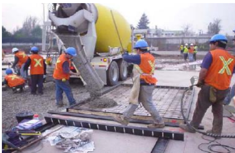
Figura 82. Vaciado del concreto con camión mixer
