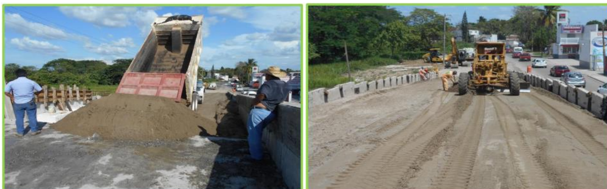
Figura 28. Terraplen sobre tierra armada y EPS. Fuente: Molina, 2015
