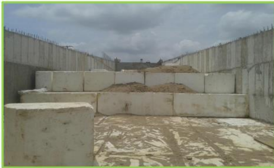
Figura 23. Instalación de bloques escalonados. Fuente: Molina, 2015
