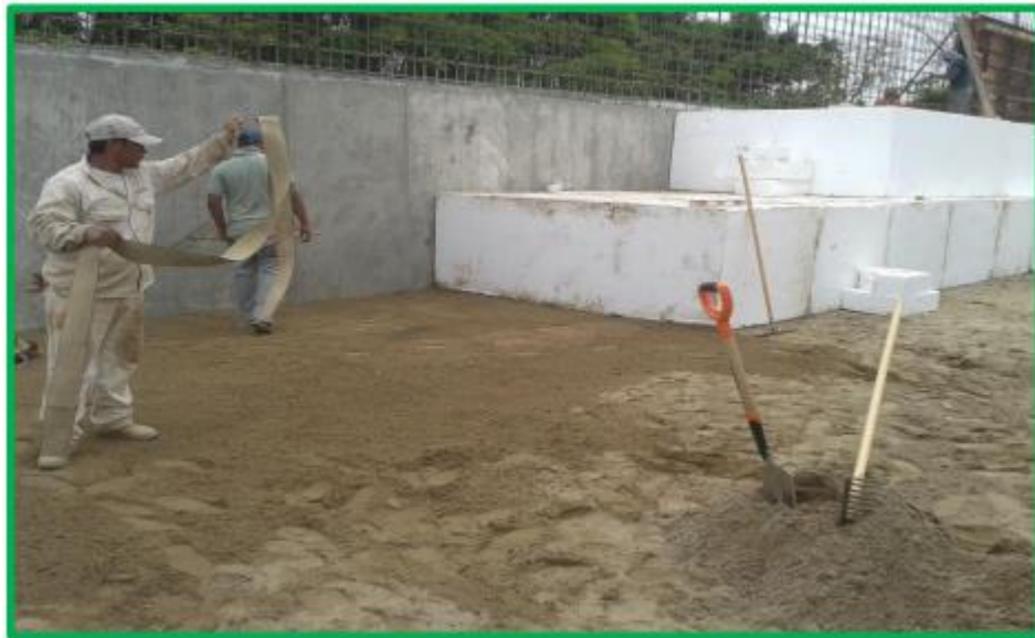
Figura 21. Instalación de correas de amarre. Fuente: Molina, 2015
