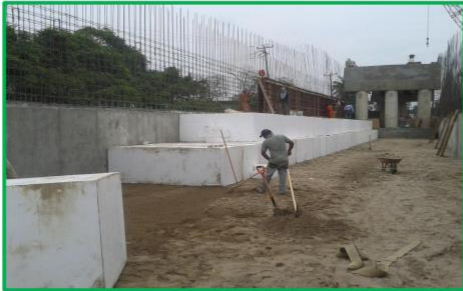
Figura 20. Nivelación del terreno natural. Fuente: Molina, 2015
