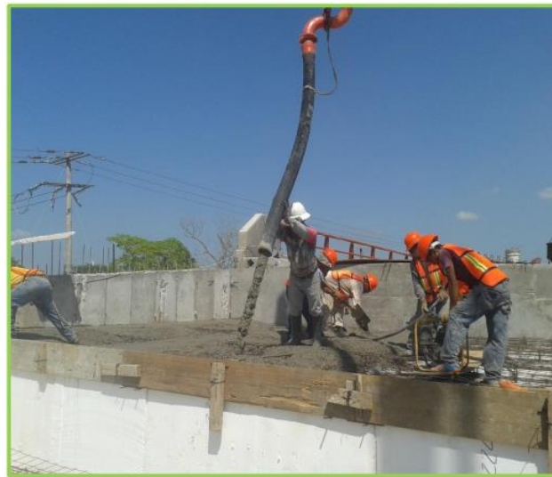
Figura 26. Colado de concreto y vibrado. Fuente: Molina, 2015
