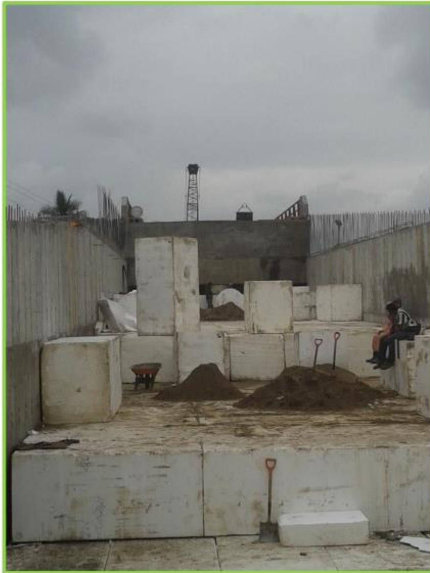
Figura 24. Arena de sello entre bloques y juntas. Fuente: Molina, 2015
