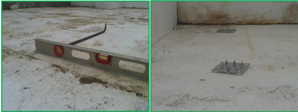
Figura 22. Anclajes metálicos y nivelación de bloques. Fuente: Molina, 2015
