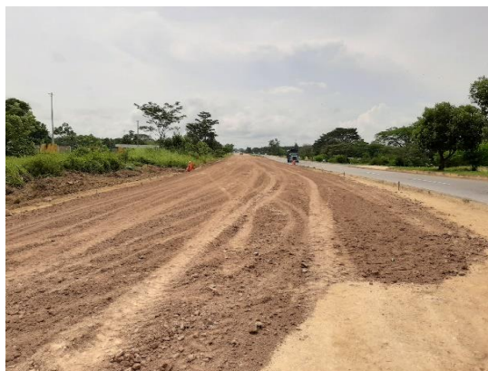
Figura 40. Tramo de empalme pr 89, Autor, 2019.
