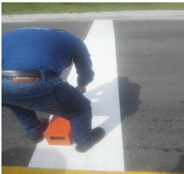
Figura 19. Toma de reflectividad de demarcación vial. Autor, 2019.
