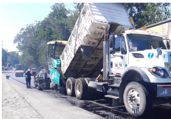
Figura 69. Suministro de concreto asfáltico para mantenimiento. Fuente: autor, 2019.
