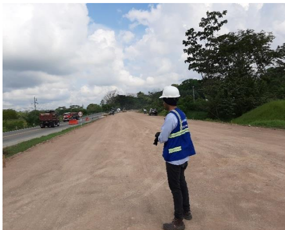
Figura 55. Verificación visual de capa instalada entre el pr 88 y pr 89, Autor, 2019.
