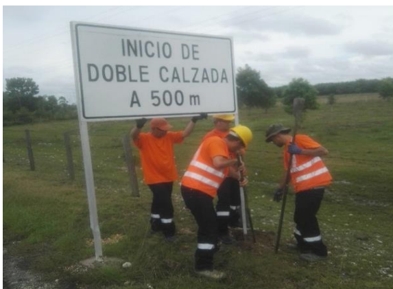
Figura 33. Nivelación de la señal. Autor, 2019.
