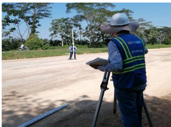
Figura 54. Toma de niveles para liberación de capa, Autor, 2019.
