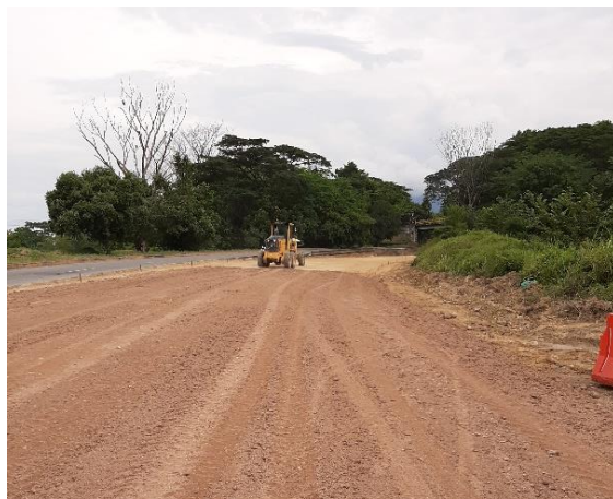
Figura 38. Nivelación y distribución de material con motoniveladora pr 90, Autor, 2019.
