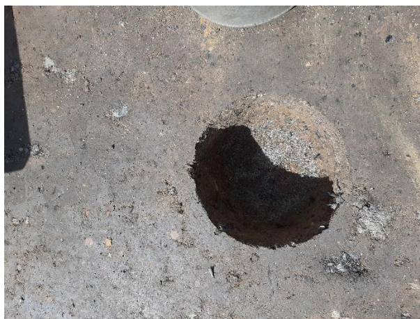
Figura 57. Excavación manual para verificar la densidad de la capa, Autor, 2019.
