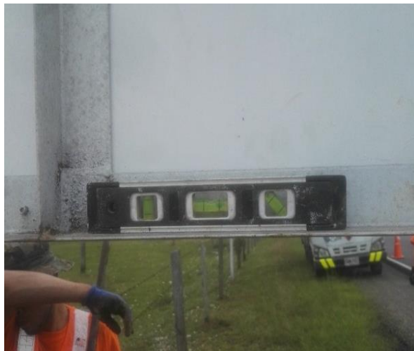
Figura 28. Verificación horizontal con nivel de mano, Autor, 2019.
