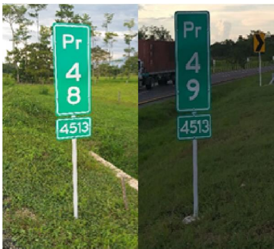
Figura 8. Registro fotográfico de señal si-04. Autor, 2019.
