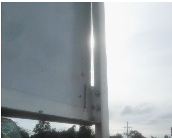
Figura 31. Verificación de superficie en contacto de la lámina con el ángulo. Autor, 2019.
