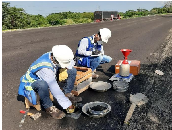
Figura 56. Toma de densidad con el cono y arena, autor, 2019.
