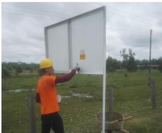
Figura 30. Recubrimiento con pintura, esmalte blanco, autor, 2019.
