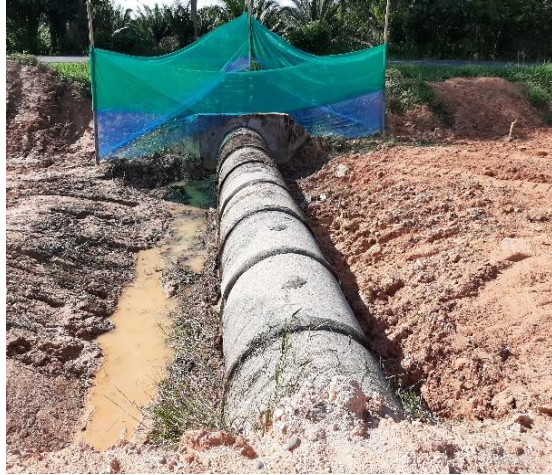
Figura 35. Obra de drenaje pr 64. Autor, 2019.
