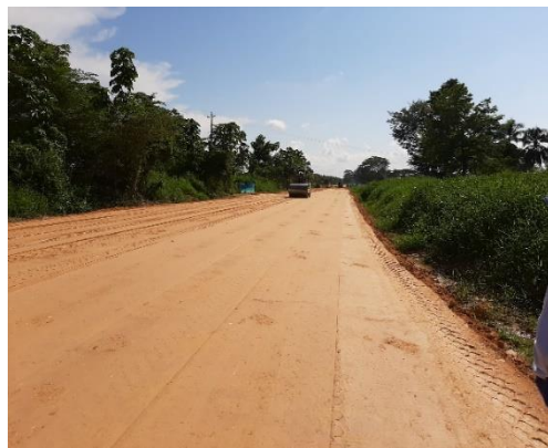
Figura 37. Vibración de capa de terraplén con vibro compactador. Autor, 2019.
