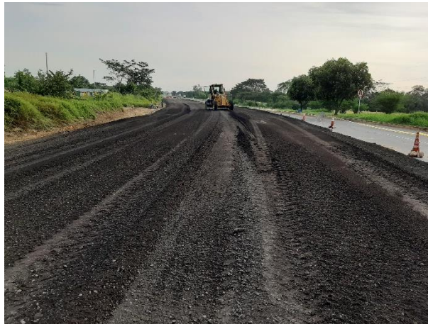
Figura 61. Suministro y nivelación de capa de fresado pr 89- pr 90, Autor, 2019.
