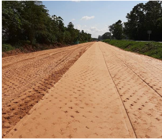
Figura 36. Material de terraplén compactado con vibrador pata de cabra. Autor, 2019.
