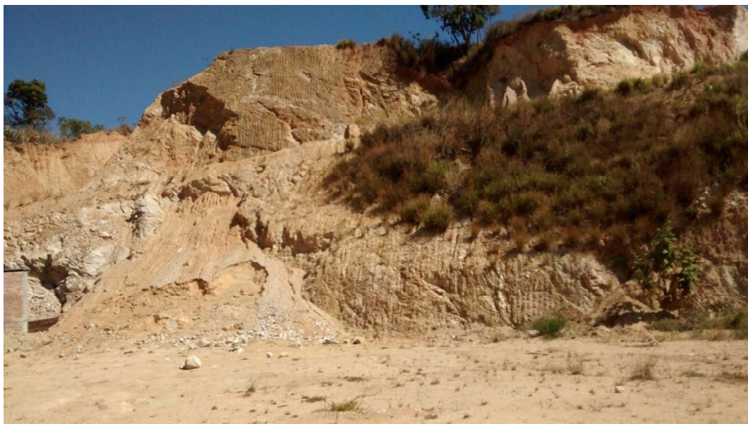
Figura 11. Talud en la formación Ígnea Extrusiva Intrusiva sector Travesías. Autores (2020).
