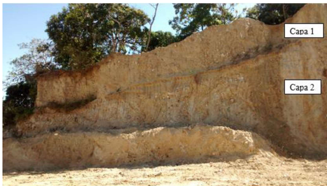
Figura 10. Talud en formación Algodonal (Tpa) sector de Sol y Sombra. Autores (2020).
