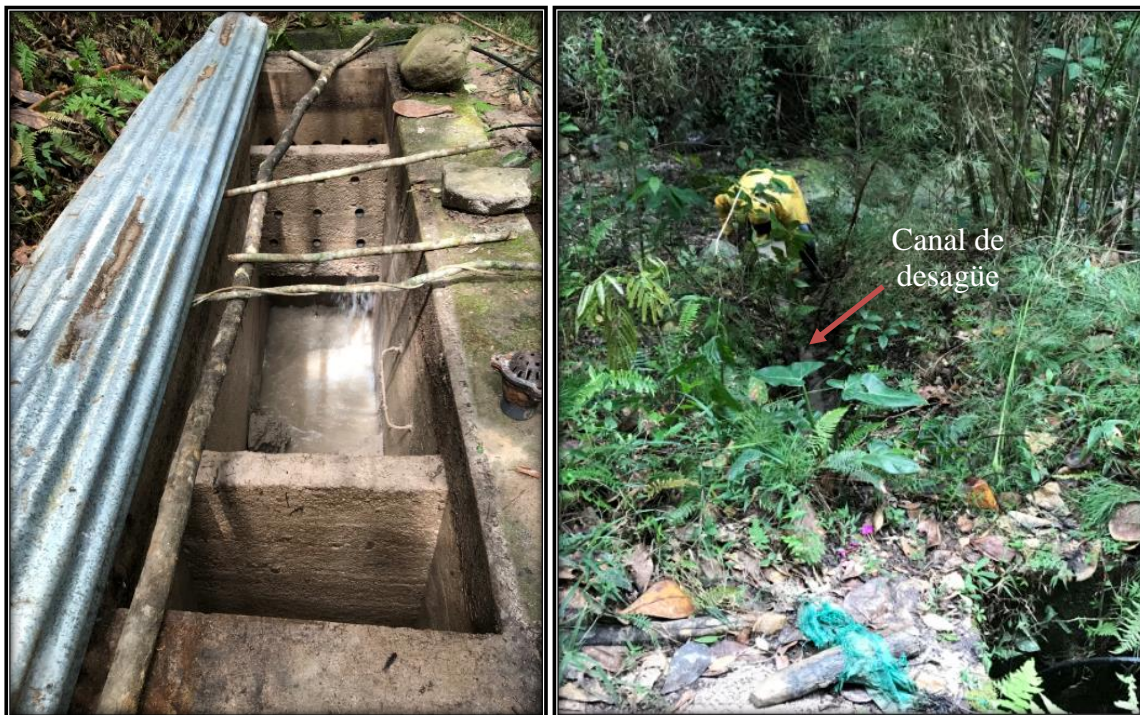
Figura 15. Desarenador en tareas de mantenimiento. (2019) Obtenido de Autor.
