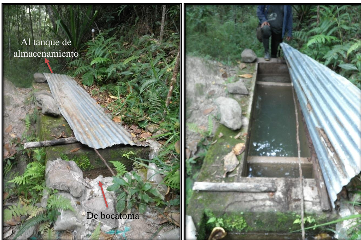
Figura 13. Desarenador. (2019) Obtenido de Autor.
