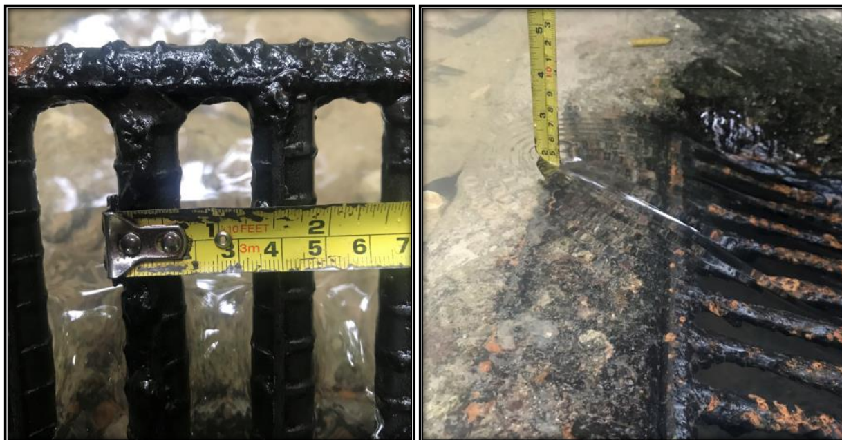
Figura 10. Separación de barras y altura de lámina de agua. (2019) Obtenido de Autor.
