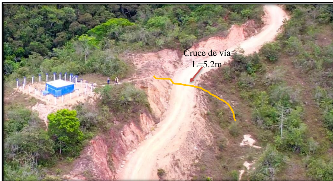
Figura 21. Cruce de vía. (2019) Obtenido de Autor.
