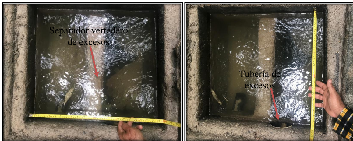
Figura 11. Cámara de recolección. (2019) Obtenido de Autor.
