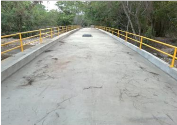
Baranda para box-culvert tipo 2.
