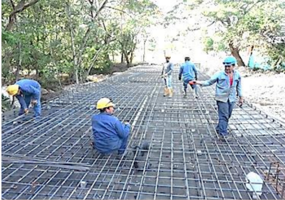
Acero de refuerzo (amarre y figurado) 60.000 PSI.
