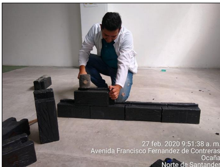
Figura 73. Colocación y nivelación de la primea hilada. Autores del proyecto, 2020.
