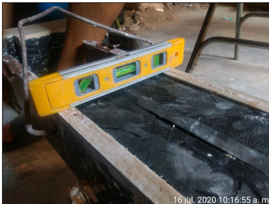
Figura 49. Nivelación e instalación de perfiles para refrentado. Autores, (2020)
