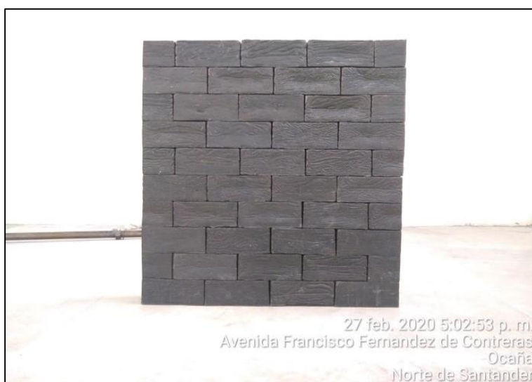
Figura 74. Muro terminado y nivelado. Autores del proyecto, 2020.
