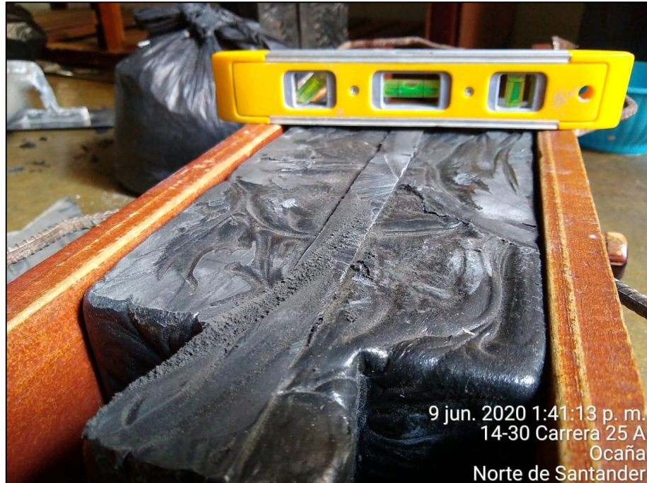
Figura 35. Instalación y nivelación de reglas y soportes. Autores del proyecto, 2020.
