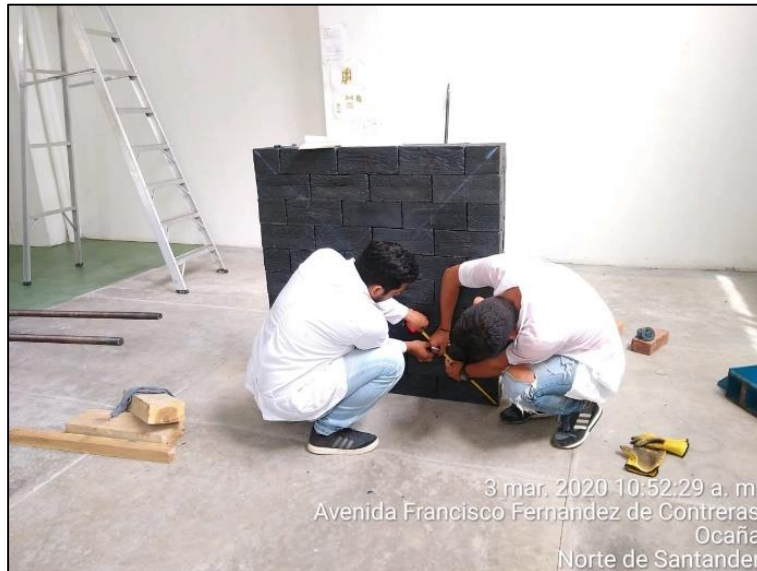
Figura 75. Trazado y medición de diagonales en el muro. Autores del proyecto, 2020.
