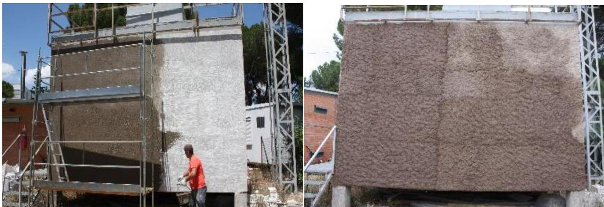
*Figura 76.* Aplicación del mortero base y aspecto final del enfoscado con mortero MorRCDmix.
