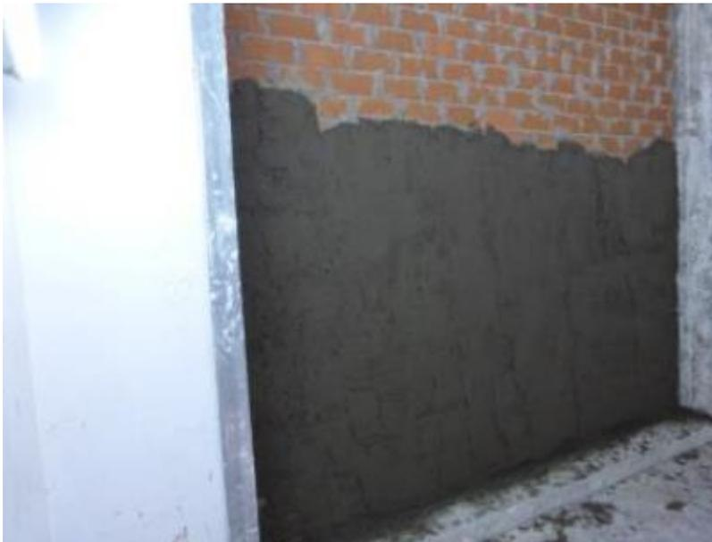
*Figura 81.* Enfoscado con mortero MorRCDmix de la pared en emisión.
