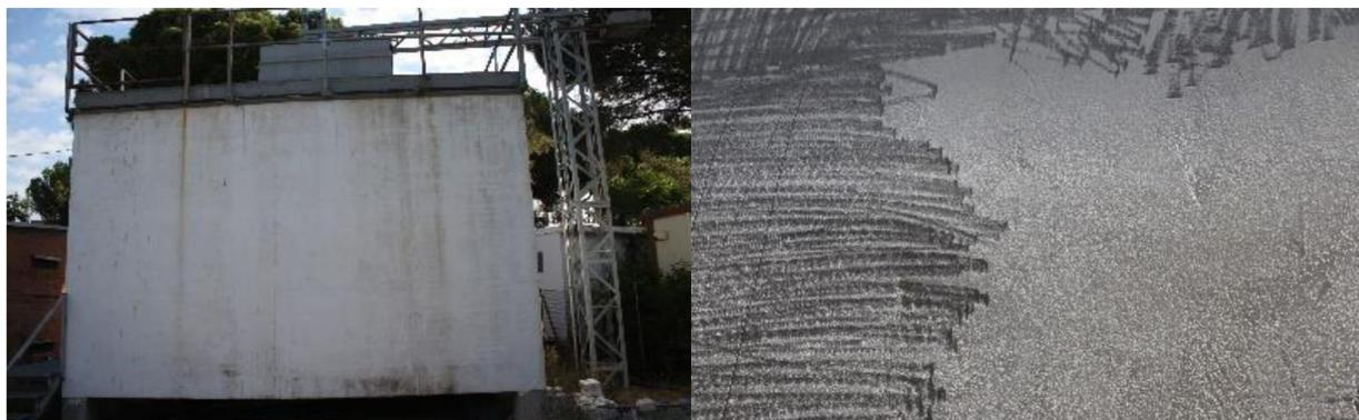
*Figura 75.* Aspecto inicial de la pared y preparación de la pared: Lijado.
