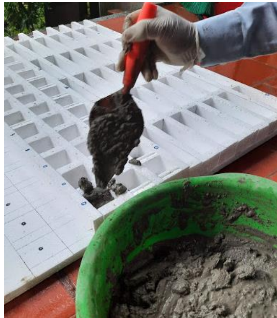
Figura 16. Colocación del mortero en los moldes. Autores, 2021.
