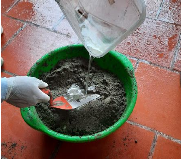
Figura 35. Adición de agua en las mezclas de mortero. Autores, 2021.
