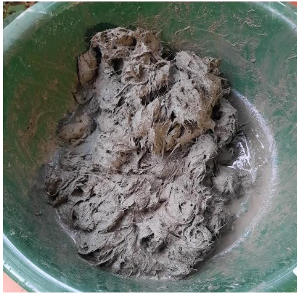
Figura 12. Mezcla de mortero con adición de 5% de fibra. Autores, 2021.
