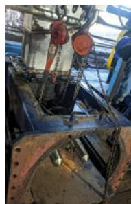
b. Desmontaje de canasta y tornillo
