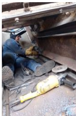
a. Corte platinas INOX
