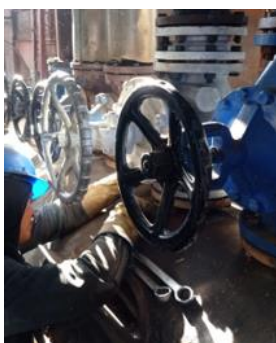
a. Desmontaje de válvula.
