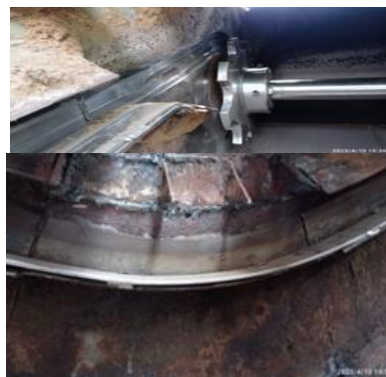
b. Montaje de platinas AC y curvas.
