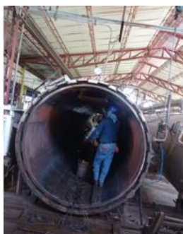
a. Desmontaje de bandejas.
