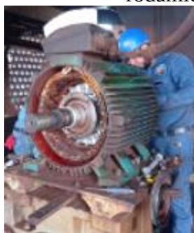
b. Desmontaje de rodamiento lado ventilador.
