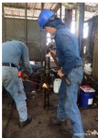
b. Desmontaje de eje conductor.
