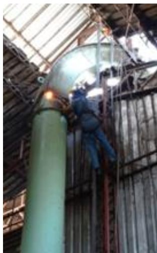
a. Corte de transición a cambiar
