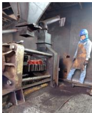
b. Mantenimiento de prensa.
