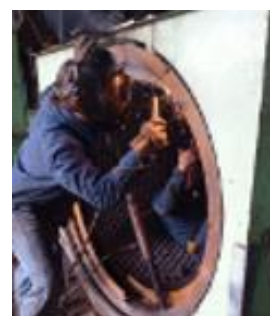
c. Aplicación de soldadura 7018.
