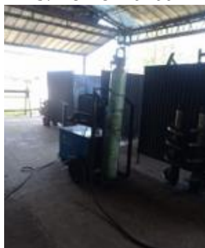
e. Equipo de soldadura
