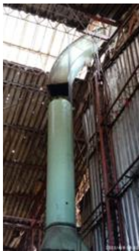
b. Desmontaje de transición
