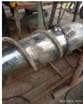
b. Proceso de reconstrucción.
