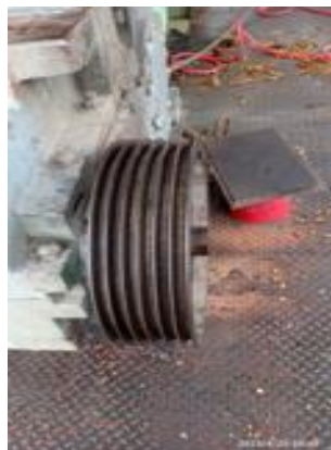
a. Desmontaje de polea de tren de entrada.
