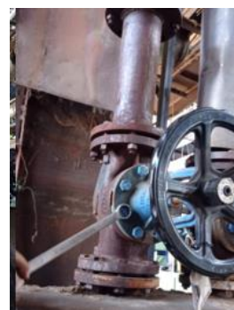
c. Cambio de válvula.
