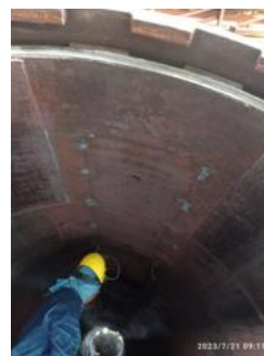
c. Instalación de bandejas perforadas.
