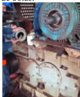
c. Montaje de polea luego de revisión y cabio de rodamientos.
