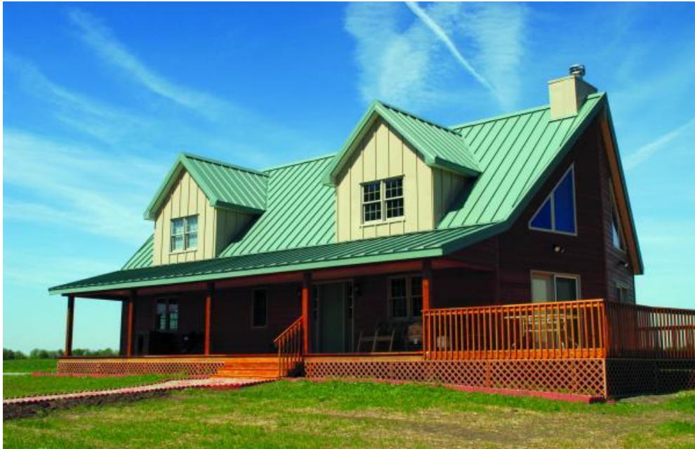
Figura 18. Techo de metal.
