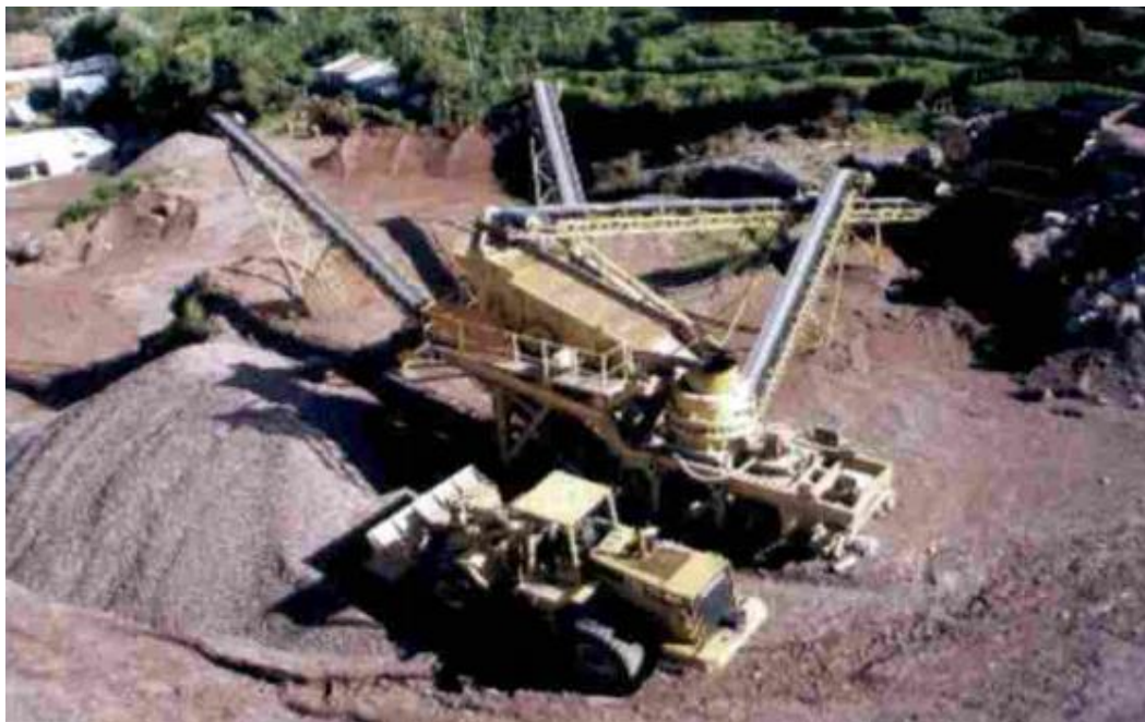
Figura 2. Montaje para producir gravilla.
