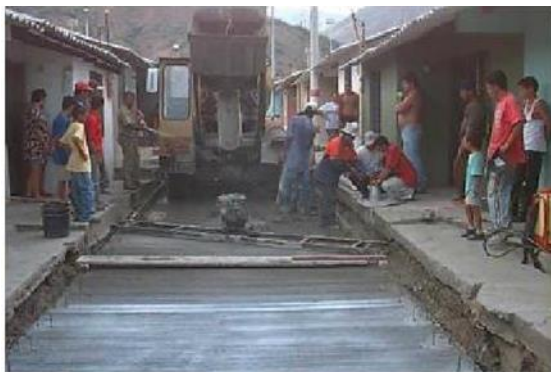
Figura 15. El concreto verde en la calle.
