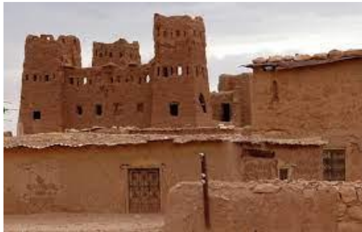
Figura 8. Construcción en tierra.
