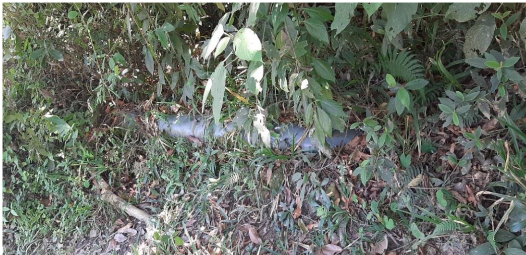
Ilustración 25. Conductos del desarenador.
