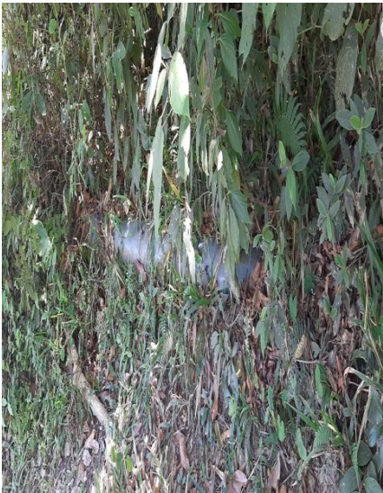
Nota. Tubería de aducción.
